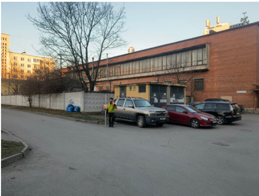
Рис. 26. Общий вид ОАН «Центральная часть города Ниена (Охта 2): культурный слой» на земельном участке, выделенном под реконструкцию наружного освещения по объекту: Квартал 15А Б. Охты (Красногвардейская пл. - Большеохтинский пр. - Конторская ул. - Среднеохтинский пр.) Точка съемки № 5. Вид с ЮВ
