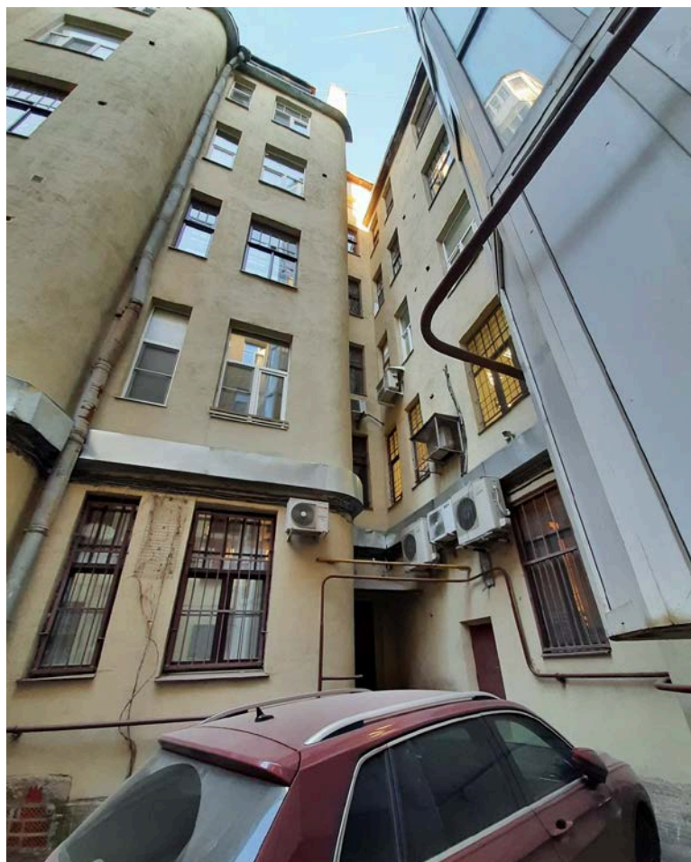
Фото 8 Фрагмент дворового фасада выявленного объекта культурного наследия «Дом Т.Н. Путиловой» расположенного по адресу: Санкт-Петербург, Большой пр. П.С., д. 44, лит. А
