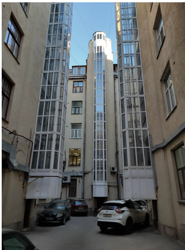
Фото 6 Фрагмент дворового фасада выявленного объекта культурного наследия «Дом Т.Н. Путиловой» расположенного по адресу: Санкт-Петербург, Большой пр. П.С., д. 44, лит. А
