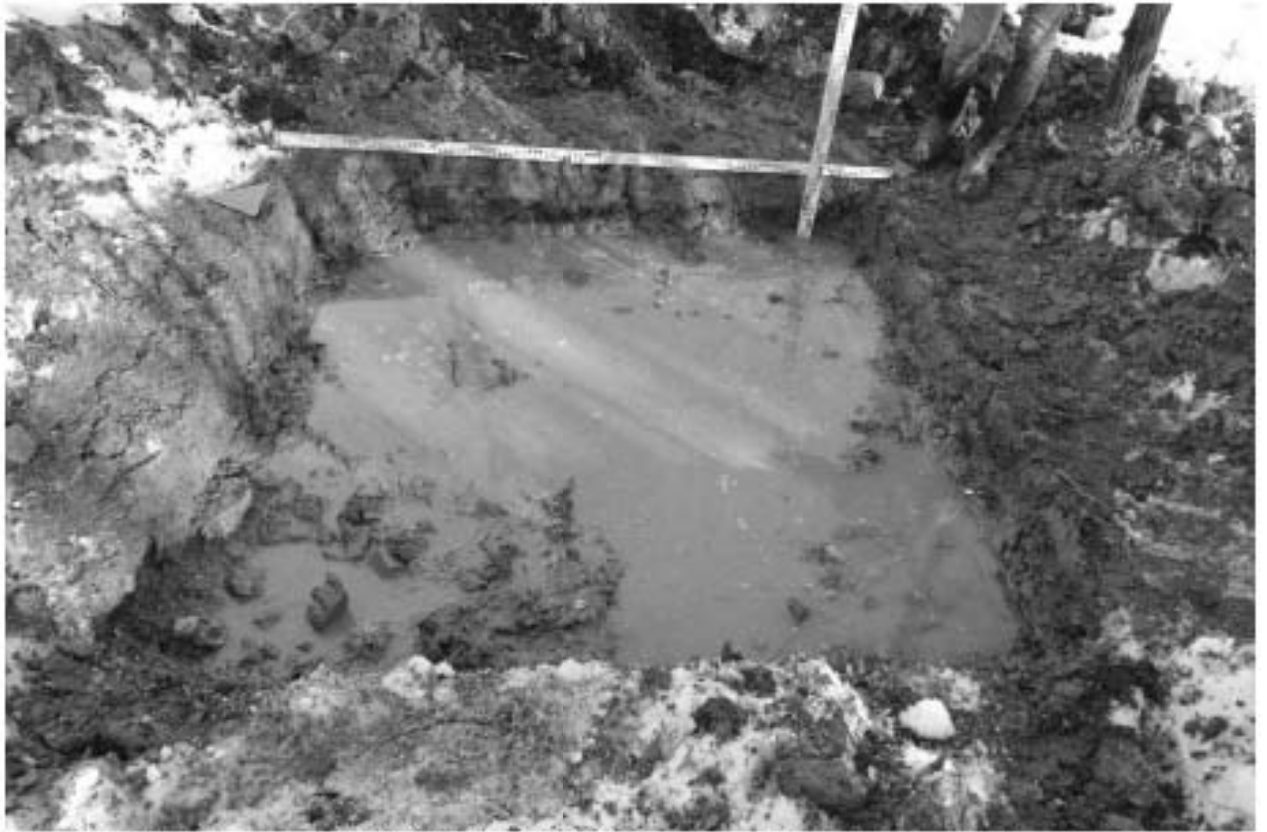
Рис. 56. Шушары, участок 692-2022. Шурф 2, фиксация по уровню окончания работ, вид на восток.
