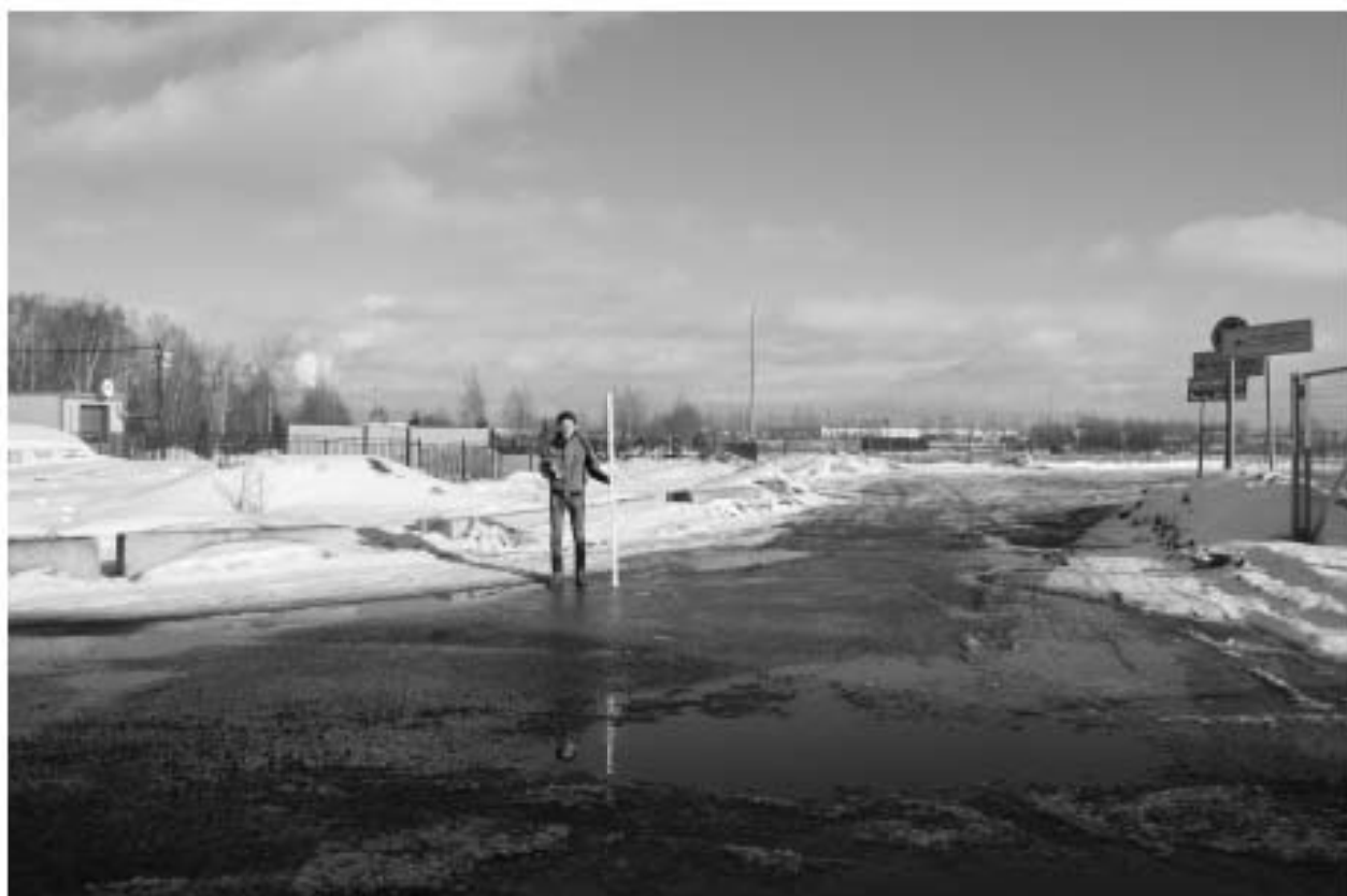
Рис. 37. Шушары, участок 692-2022. Точка фотофиксации 12, вид на восток.
