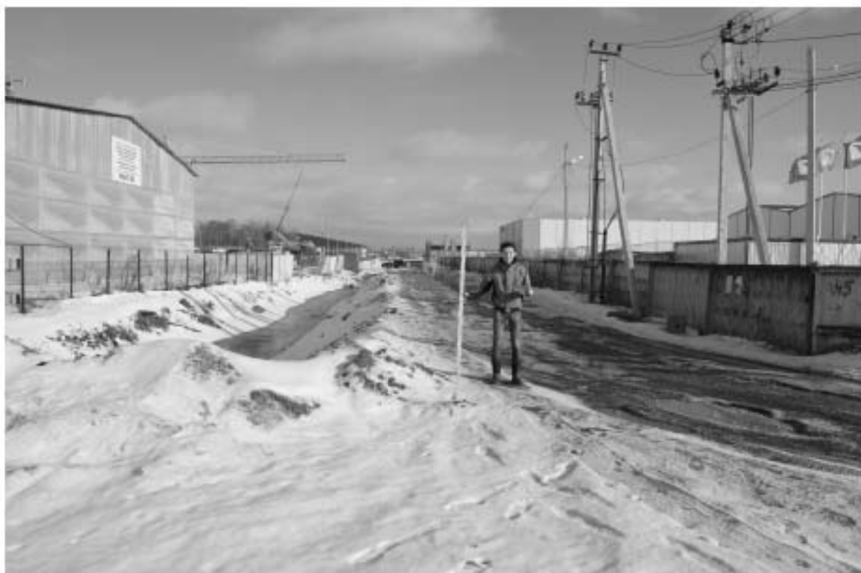
Рис. 31. Шушары, участок 692-2022. Точка фотофиксации 10, вид на восток.
