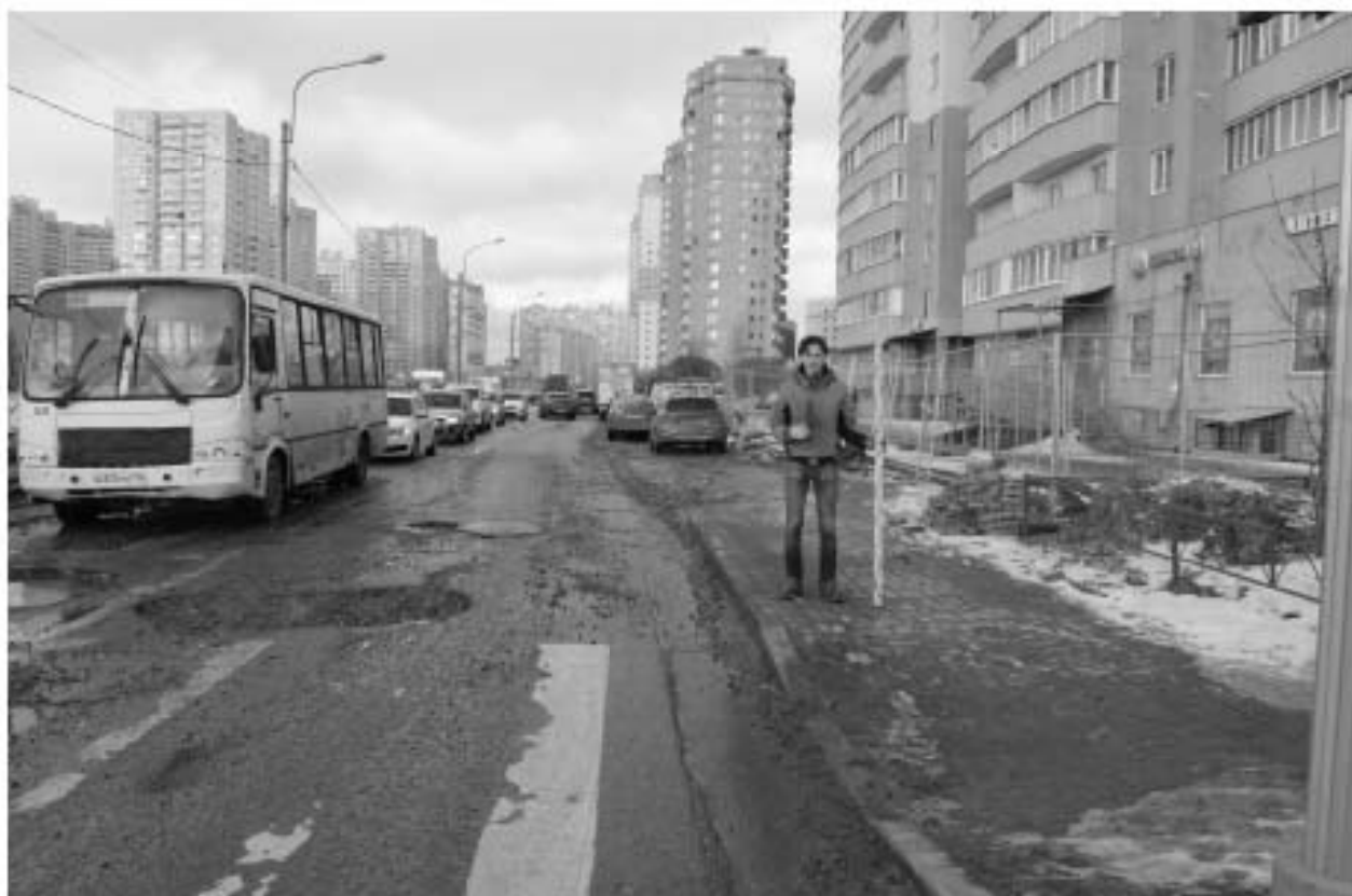
Рис. 25. Шушары, участок 692-2022. Точка фотофиксации 5, вид на север.
