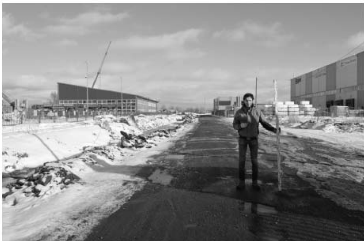
Рис. 33. Шушары, участок 692-2022. Точка фотофиксации 11, вид на восток.
