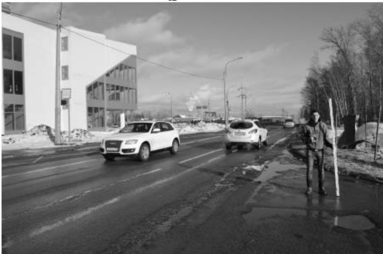
Рис. 40. Шушары, участок 692-2022. Точка фотофиксации 13, вид на северо-восток.
