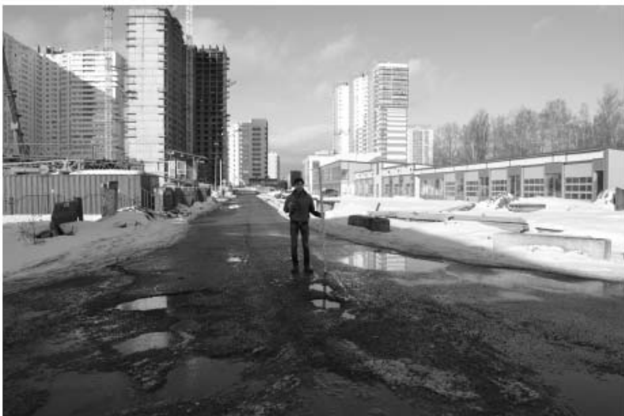
Рис. 35. Шушары, участок 692-2022. Точка фотофиксации 12, вид на север.
