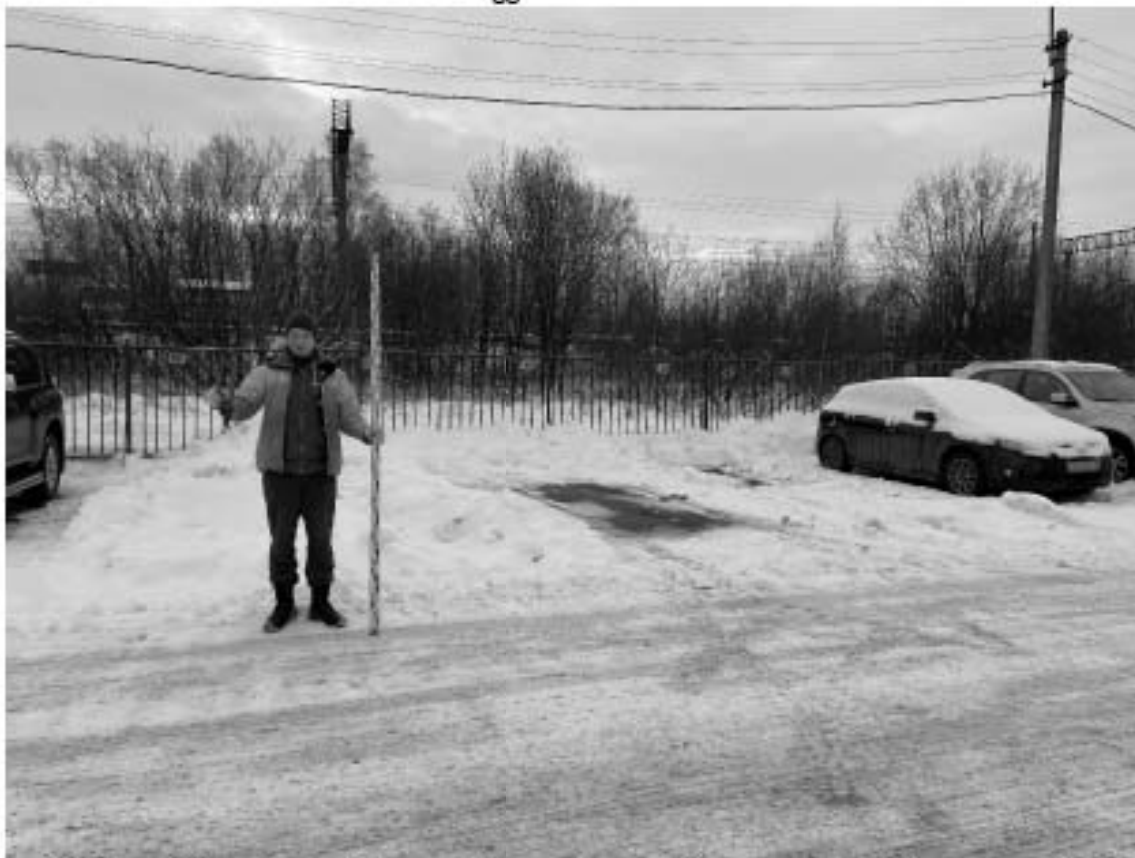
Рис. 21. Санкт-Петербург, «Строительство участка Красносельско-Калининской линии метрополитена от станции «Казаковская» до станции «Сосновая поляна»», площадка 15. Общий вид участка обследования. Точка съемки 4. Вид на юг.
