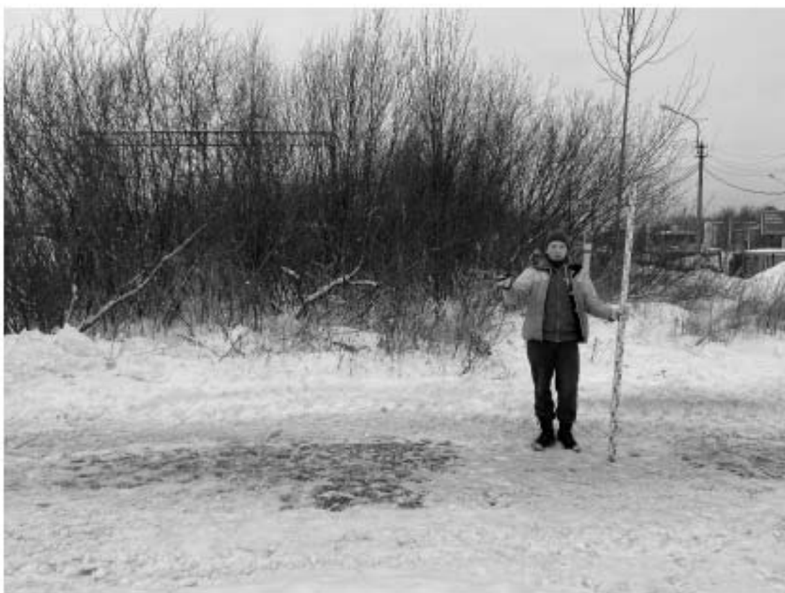
Рис. 24. Санкт-Петербург, «Строительство участка Красносельско-Калининской линии метрополитена от станции «Казаковская» до станции «Сосновая поляна»», площадка 15. Общий вид участка обследования. Точка съемки 5. Вид на запад.
