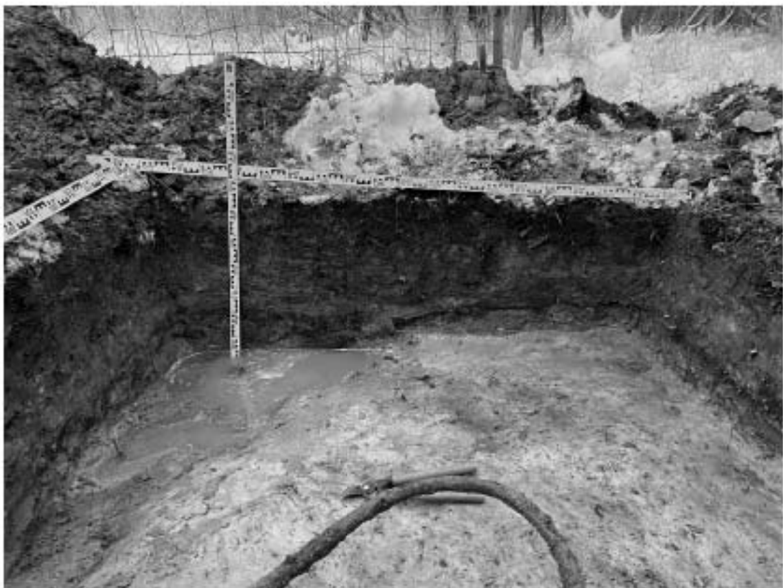
Рис. 38. Санкт-Петербург, «Строительство участка Красносельско-Калининской линии метрополитена от станции «Казаковская» до станции «Сосновая поляна»», площадка 15. Шурф №1. Восточная стенка.
