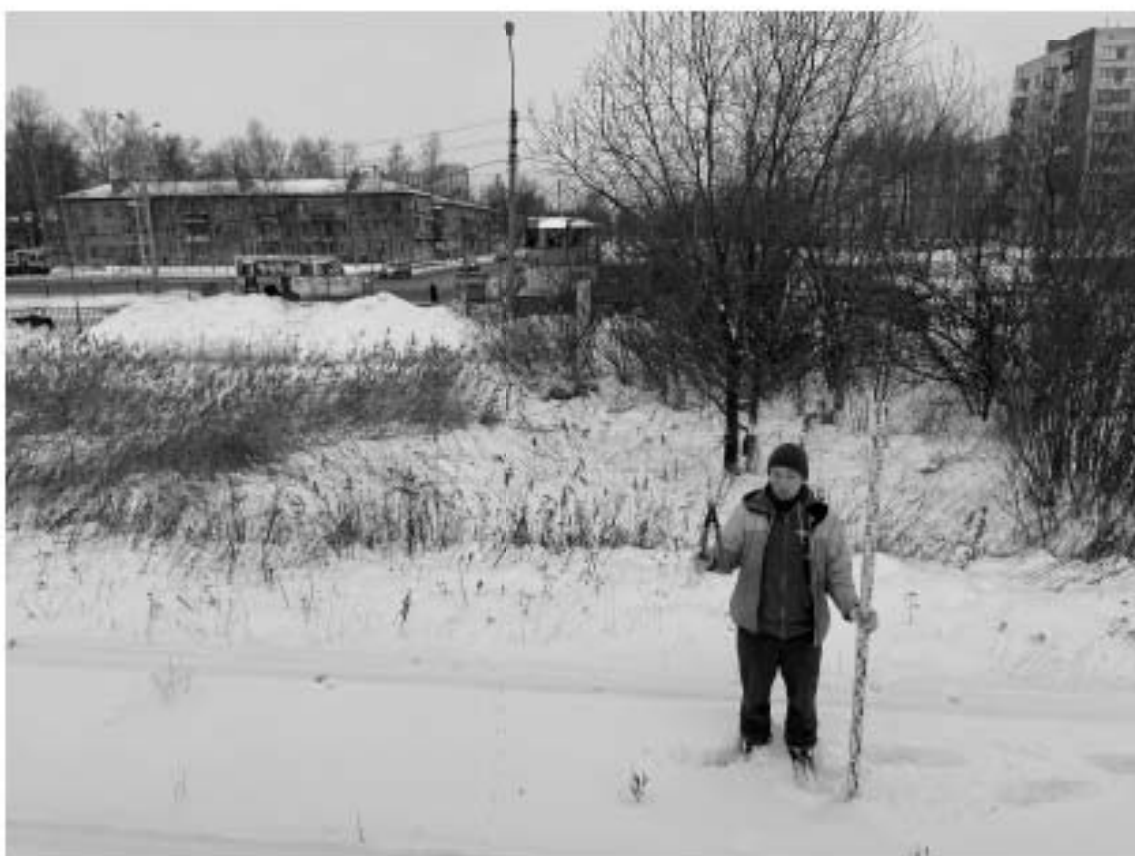
Рис. 30. Санкт-Петербург, «Строительство участка Красносельско-Калининской линии метрополитена от станции «Казаковская» до станции «Сосновая поляна»», площадка 15. Общий вид участка обследования. Точка съемки 8. Вид на север.
