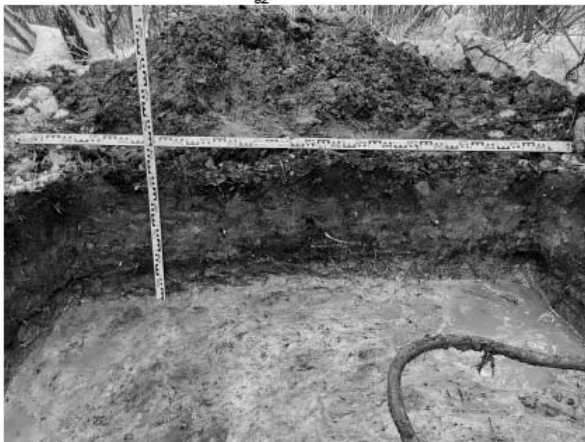
Рис. 39. Санкт-Петербург, «Строительство участка Красносельско-Калининской линии метрополитена от станции «Казаковская» до станции «Сосновая поляна»», площадка 15. Шурф №1. Южная стенка.
