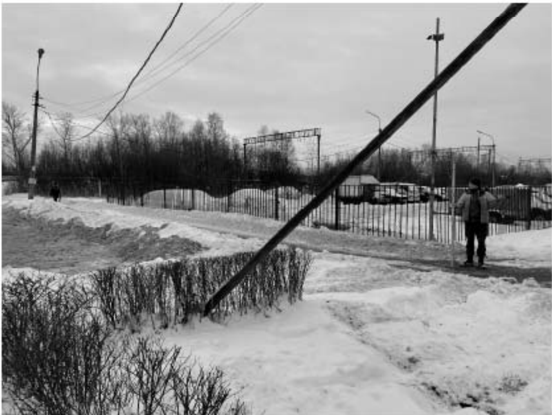
Рис. 12. Санкт-Петербург, «Строительство участка Красносельско-Калининской линии метрополитена от станции «Казаковская» до станции «Сосновая поляна»», площадка 15. Общий вид участка обследования. Точка съемки 1. Вид на запад.
