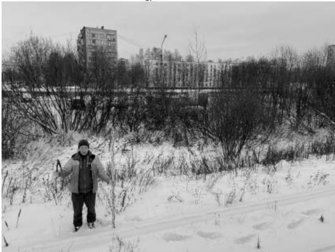
Рис. 29. Санкт-Петербург, «Строительство участка Красносельско-Калининской линии метрополитена от станции «Казаковская» до станции «Сосновая поляна»», площадка 15. Общий вид участка обследования. Точка съемки 7. Вид на север.
