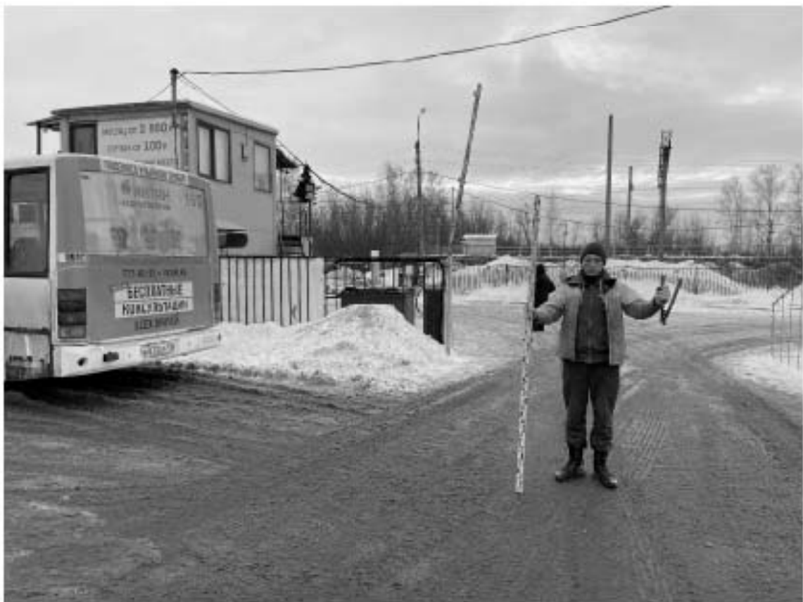
Рис. 16. Санкт-Петербург, «Строительство участка Красносельско-Калининской линии метрополитена от станции «Казаковская» до станции «Сосновая поляна»», площадка 15. Общий вид участка обследования. Точка съемки 3. Вид на юг.
