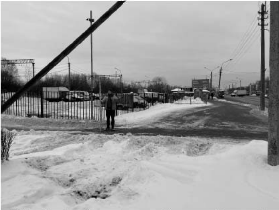
Рис. 11. Санкт-Петербург, «Строительство участка Красносельско-Калининской линии метрополитена от станции «Казаковская» до станции «Сосновая поляна»», площадка 15. Общий вид участка обследования. Точка съемки 1. Вид на запад.
