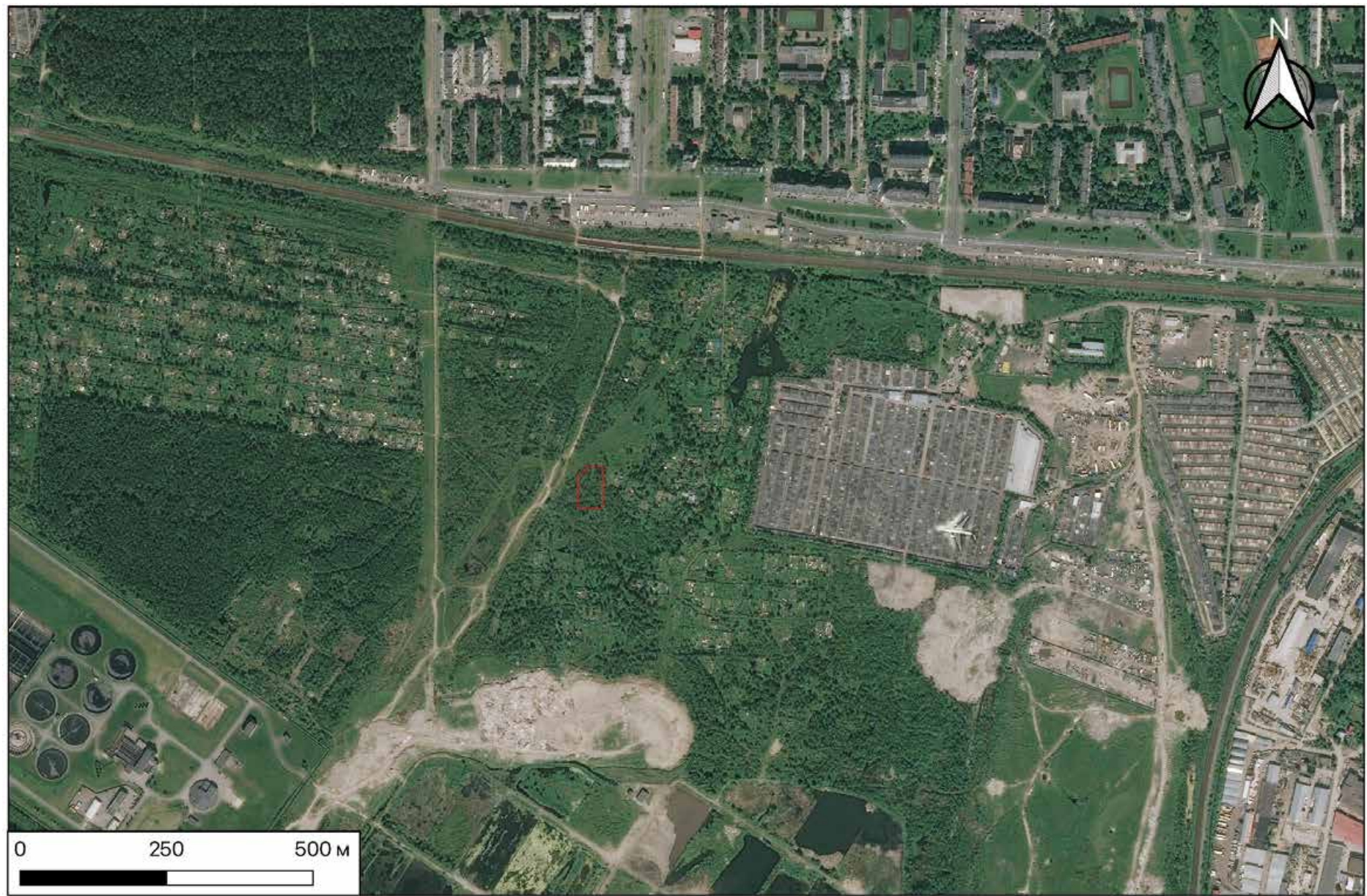
Рис. 4. Участок обследования по объекту «Строительство участка Красносельско-Калининской линии метрополитена от станции «Казаковская» до станции «Сосновая поляна»», площадка 14 на спутниковом снимке Красносельского района Санкт-Петербурга (OSM).
