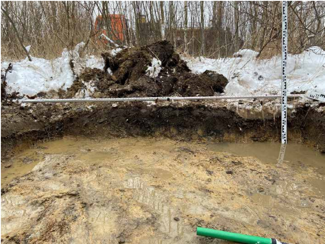
Рис. 33. Санкт-Петербург, «Строительство участка Красносельско-Калининской линии метрополитена от станции «Казаковская» до станции «Сосновая поляна»», площадка 14. Шурф №1. Западная стенка.
