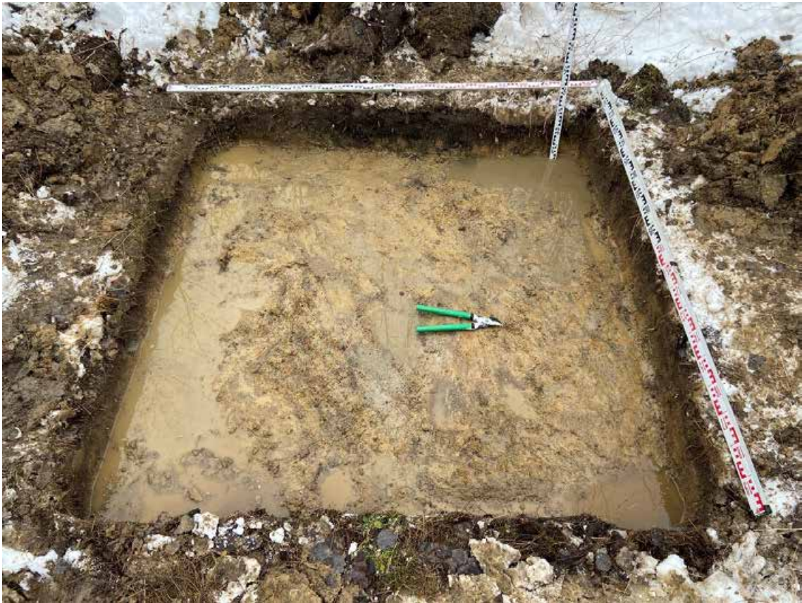
Рис. 29. Санкт-Петербург, «Строительство участка Красносельско-Калининской линии метрополитена от станции «Казаковская» до станции «Сосновая поляна»», площадка 14. Шурф №1. Фиксация по матерiku. Вид на запад.
