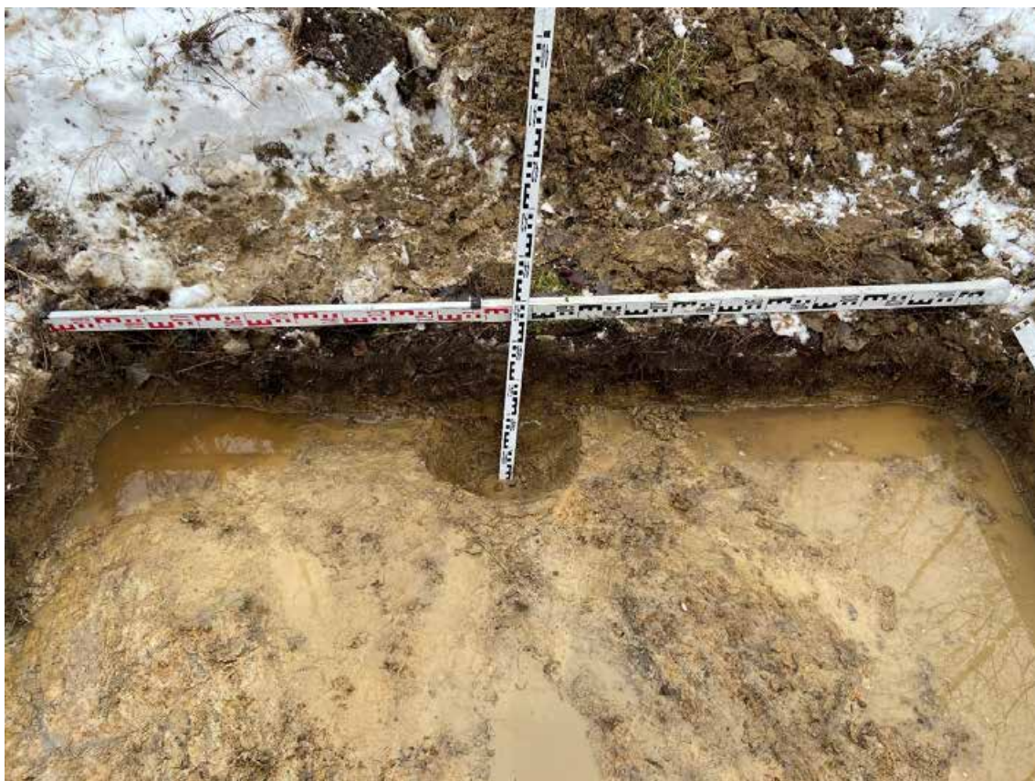
Рис. 36. Санкт-Петербург, «Строительство участка Красносельско-Калининской линии метрополитена от станции «Казаковская» до станции «Сосновая поляна»», площадка 14. Шурф №1. Фиксация контрольного прокопа у восточной стенки.
