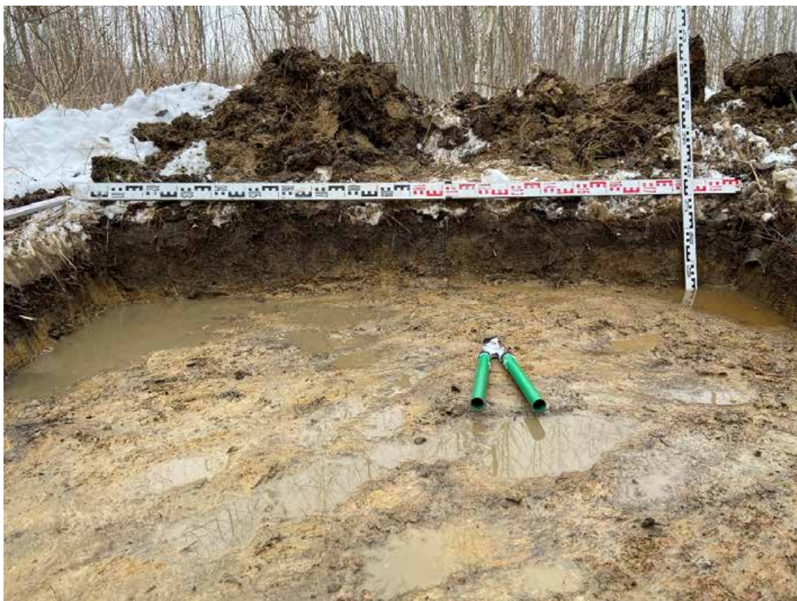
Рис. 32. Санкт-Петербург, «Строительство участка Красносельско-Калининской линии метрополитена от станции «Казаковская» до станции «Сосновая поляна»», площадка 14. Шурф №1. Северная стенка.
