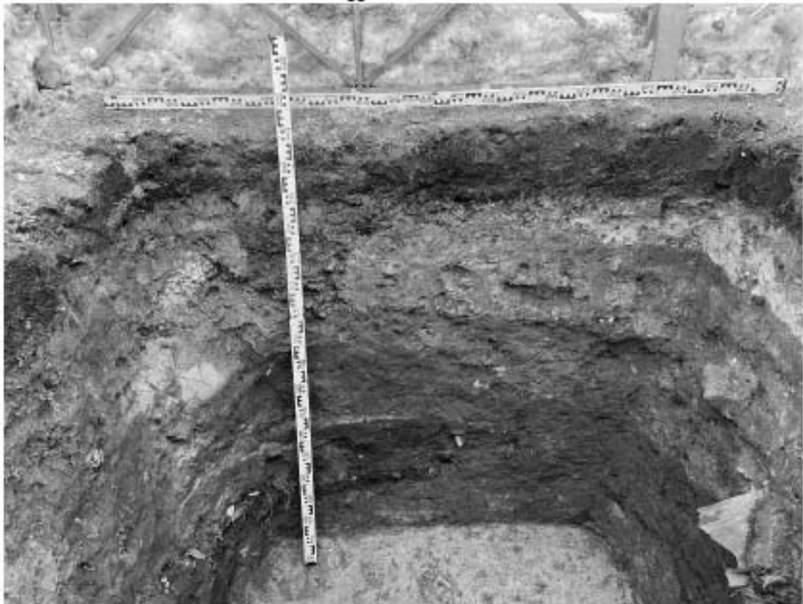
Рис. 39 Санкт-Петербург, «Строительство участка Красносельско-Калининской линии метрополитена от станции «Казаковская» до станции «Сосновая поляна»», площадка 18. Шурф №1. Фиксация северной стенки.
