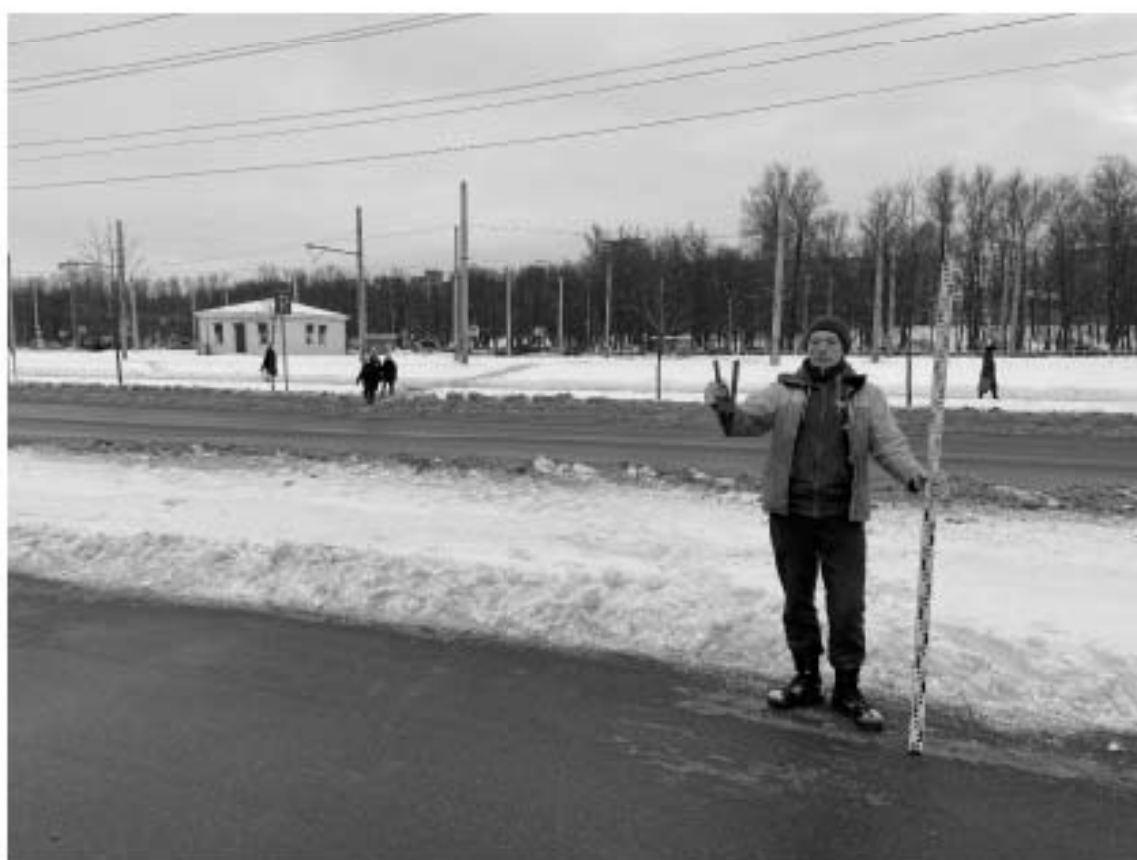
Рис. 34. Санкт-Петербург, «Строительство участка Красносельско-Калининской линии метрополитена от станции «Казаковская» до станции «Сосновая поляна»», площадка 18. Общий вид участка обследования. Точка съемки 8. Вид на юг.
