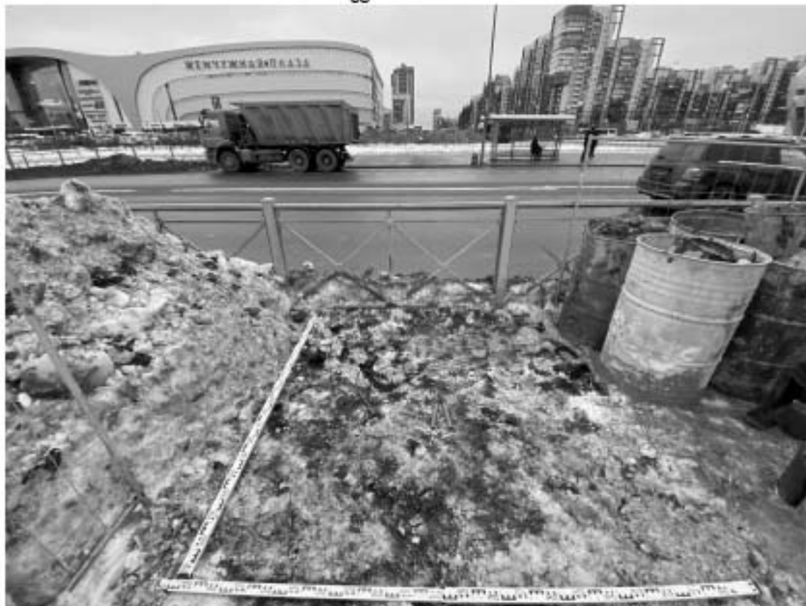
Рис. 37 Санкт-Петербург, «Строительство участка Красносельско-Калининской линии метрополитена от станции «Казаковская» до станции «Сосновая поляна»», площадка 18. Шурф №1. Общий вид до начала работ.
