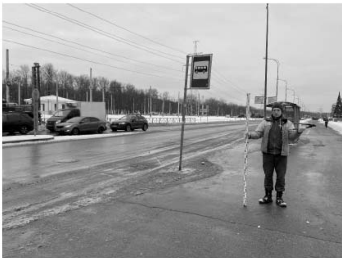
Рис. 30. Санкт-Петербург, «Строительство участка Красносельско-Калининской линии метрополитена от станции «Казаковская» до станции «Сосновая поляна»», площадка 18. Общий вид участка обследования. Точка съемки 6. Вид на запад.
