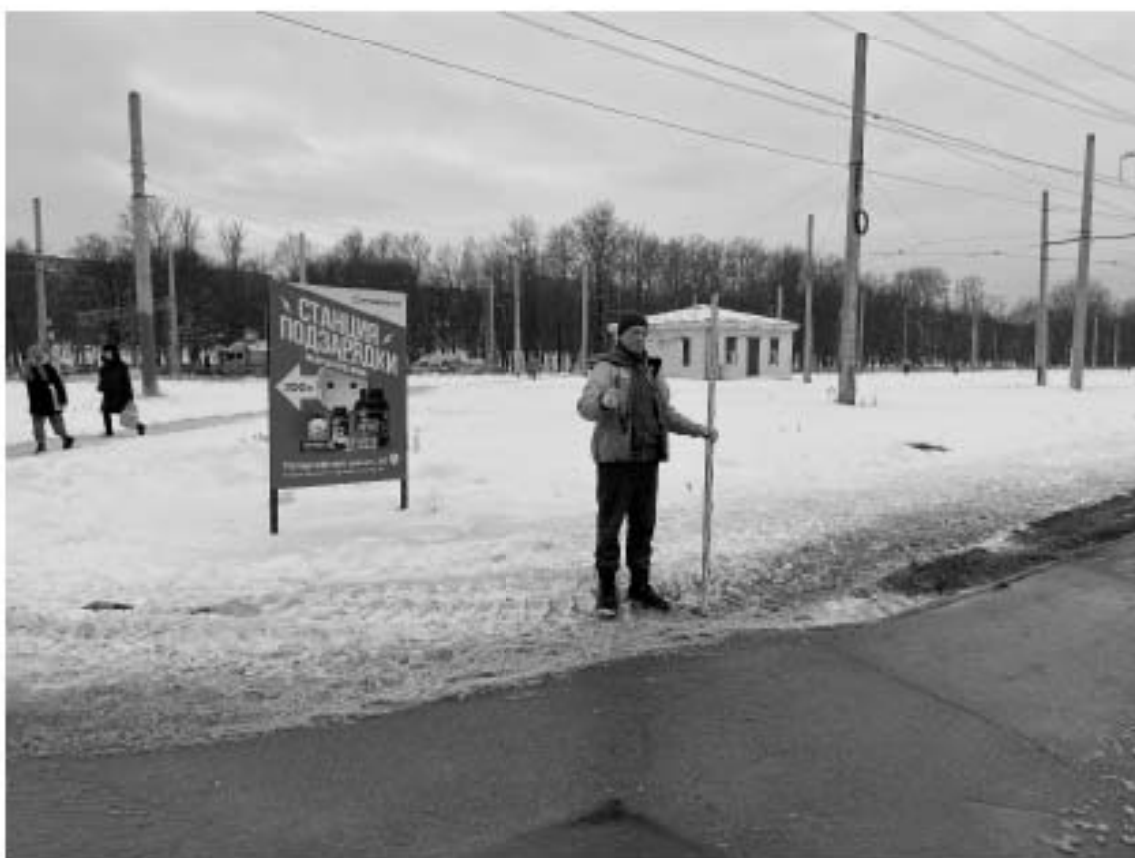
Рис. 14. Санкт-Петербург, «Строительство участка Красносельско-Калининской линии метрополитена от станции «Казаковская» до станции «Сосновая поляна»», площадка 18. Общий вид участка обследования. Точка съемки 2. Вид на юго-запад.
