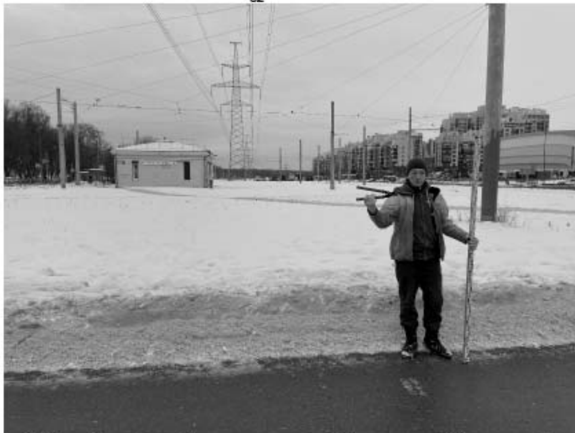
Рис. 11. Санкт-Петербург, «Строительство участка Красносельско-Калининской линии метрополитена от станции «Казаковская» до станции «Сосновая поляна»», площадка 18. Общий вид участка обследования. Точка съемки 1. Вид на запад.
