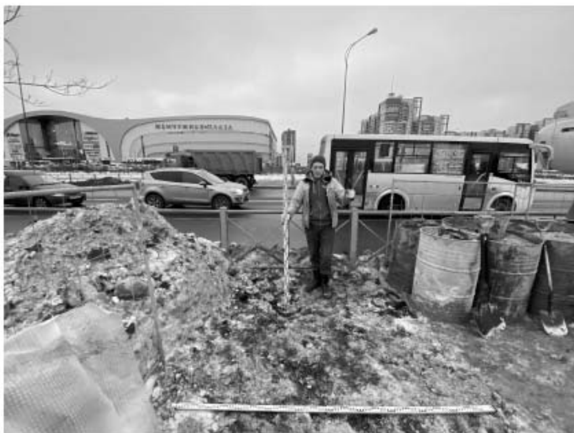
Рис. 36 Санкт-Петербург, «Строительство участка Красносельско-Калининской линии метрополитена от станции «Казаковская» до станции «Сосновая поляна»», площадка 18. Местоположение шурфа №1. Вид до начала работ.
