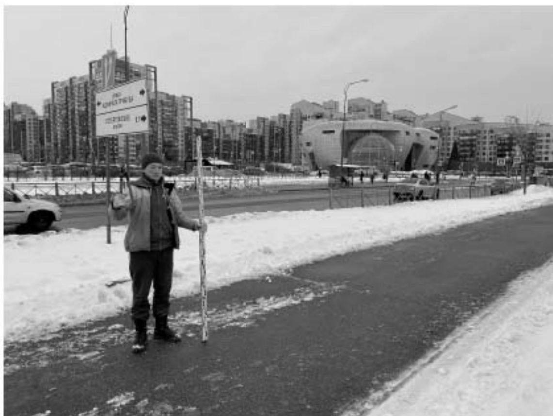
Рис. 20. Санкт-Петербург, «Строительство участка Красносельско-Калининской линии метрополитена от станции «Казаковская» до станции «Сосновая поляна»», площадка 18. Общий вид участка обследования. Точка съемки 3. Вид на северо-восток.
