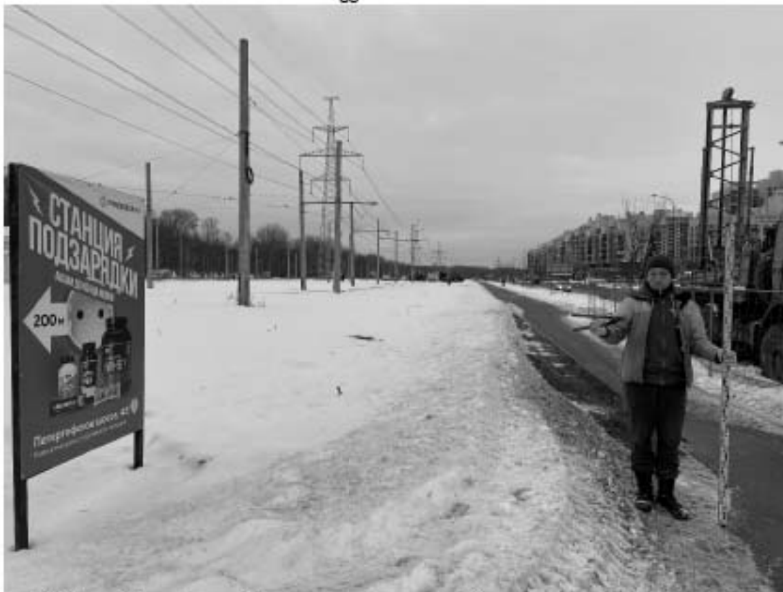
Рис. 13. Санкт-Петербург, «Строительство участка Красносельско-Калининской линии метрополитена от станции «Казаковская» до станции «Сосновая поляна»», площадка 18. Общий вид участка обследования. Точка съемки 2. Вид на запад.
