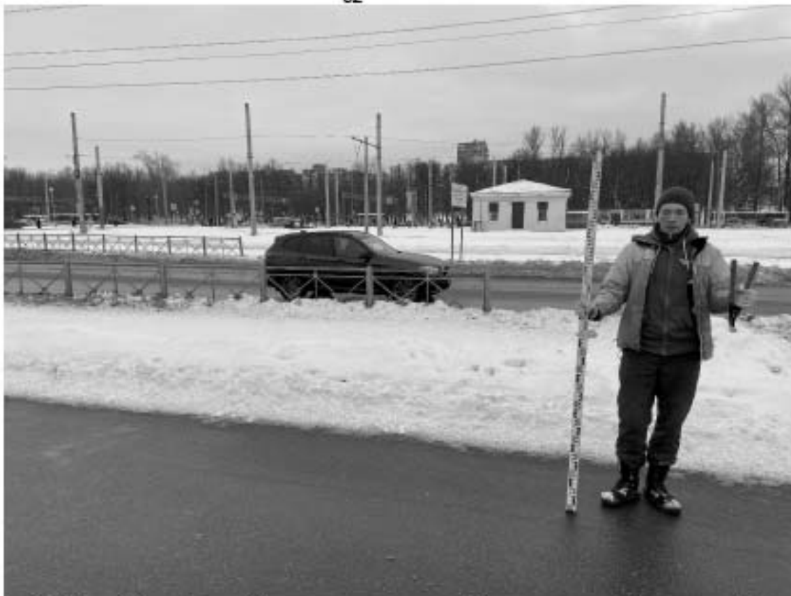
Рис. 31. Санкт-Петербург, «Строительство участка Красносельско-Калининской линии метрополитена от станции «Казаковская» до станции «Сосновая поляна»», площадка 18. Общий вид участка обследования. Точка съемки 7. Вид на юг.
