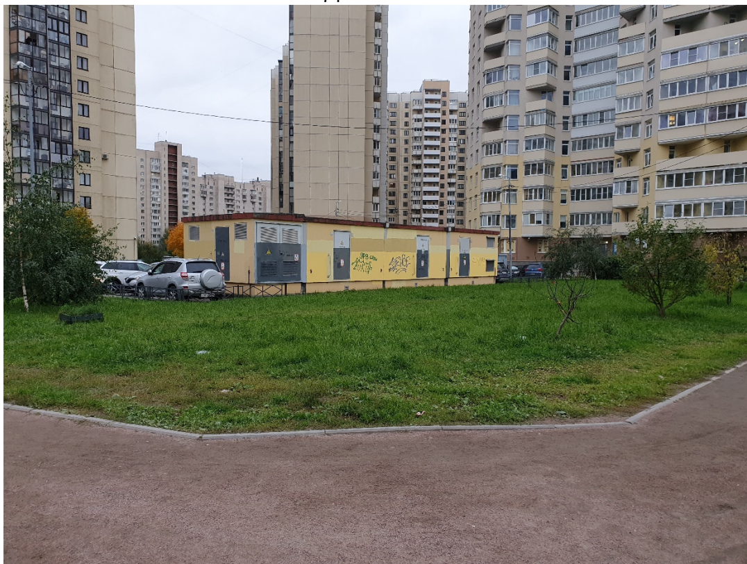
Рис. 11. СПб-2021. Красносельский район. Площадка 23. Общий вид участка обследования. Вид с севера
