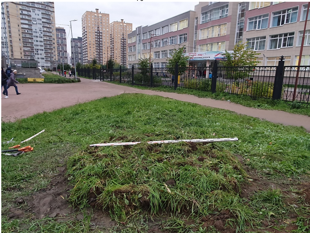
Рис. 21. СПб-2021. Кировский район. «Северные Верфи». Шурф 1. Рекультивация. Вид с юга
