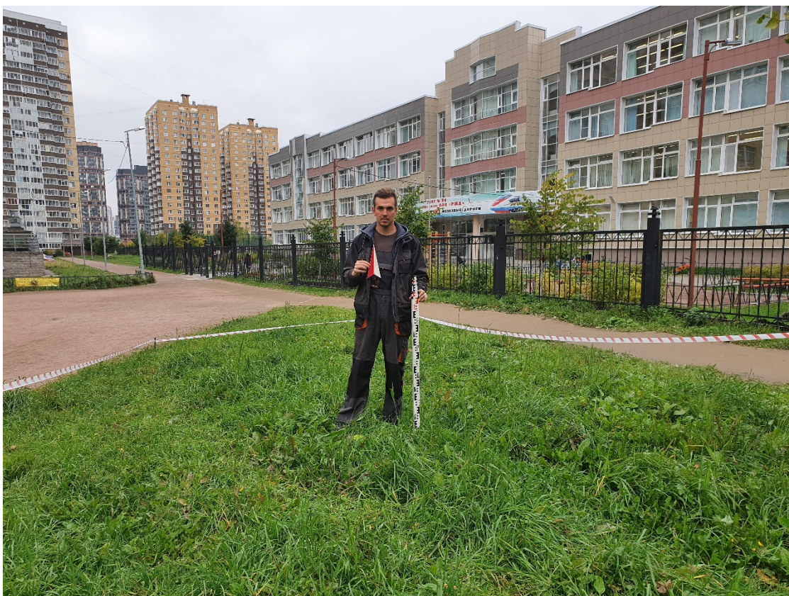
Рис. 14. СПб-2021. Красносельский район. Площадка 23. Шурф 1. До начала работ. Вид с юга
