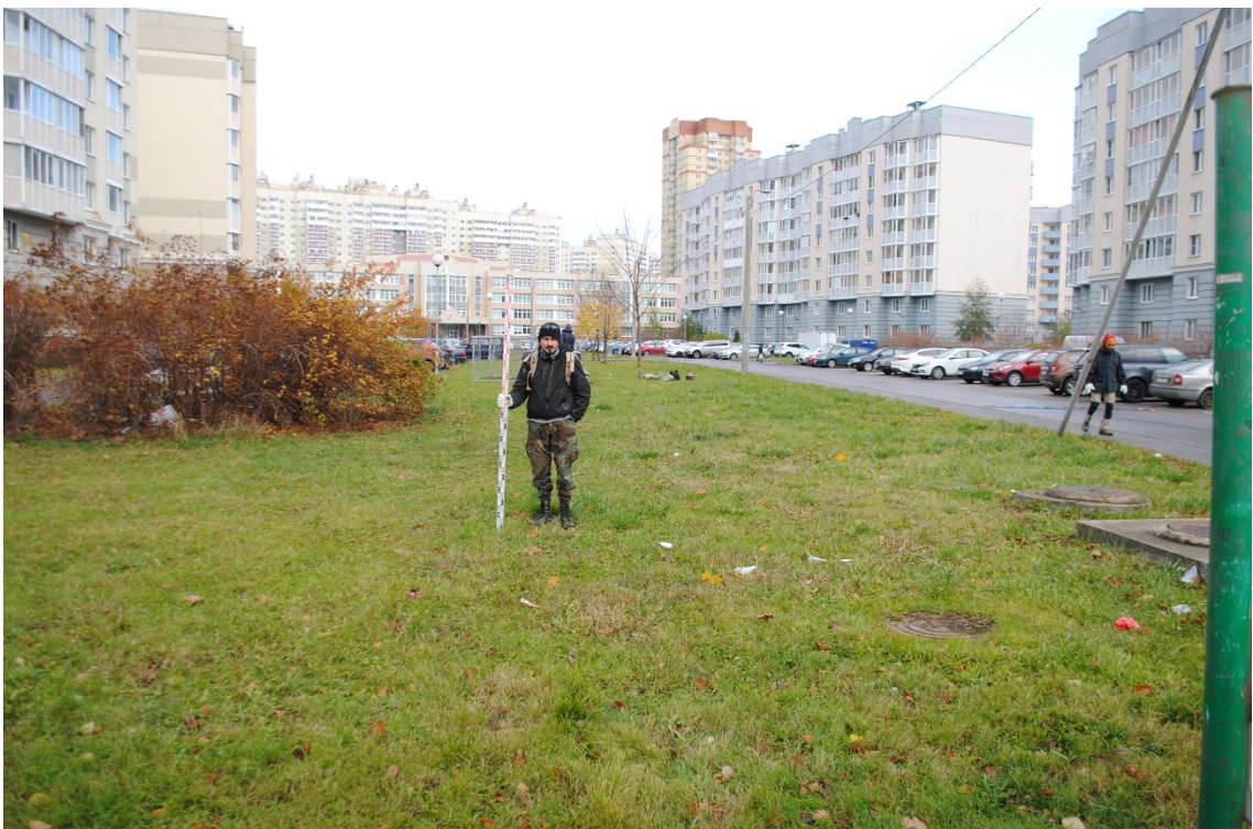
Рис. 12. Санкт-Петербург, «Строительство участка Красносельско-Калининской линии метрополитена от станции «Казаковская» до станции «Сосновая поляна»», площадка 20. Общий вид участка обследования. Точка съемки 1. Вид на север
