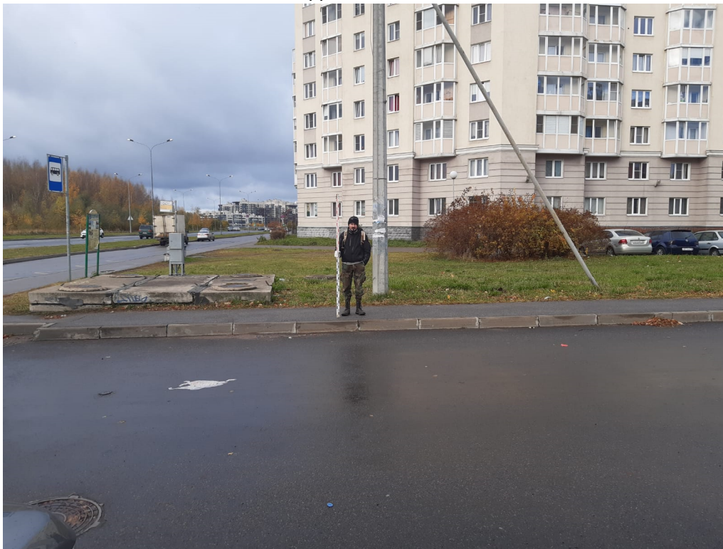
Рис. 17. Санкт-Петербург, «Строительство участка Красносельско-Калининской линии метрополитена от станции «Казаковская» до станции «Сосновая поляна»», площадка 20. Общий вид участка обследования. Точка съемки 4. Вид на запад
