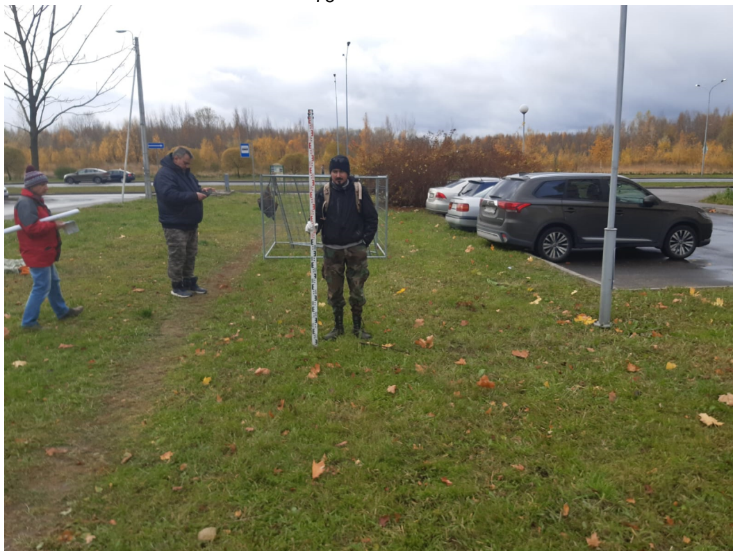
Рис. 19. Санкт-Петербург, «Строительство участка Красносельско-Калининской линии метрополитена от станции «Казаковская» до станции «Сосновая поляна»», площадка 20. Шурф 1. Фотофиксация до начала работ. Вид на юг
