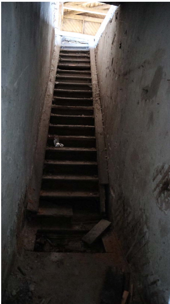
Фото 49. Лестница со 2 этажа на чердак (ЛК-4)
