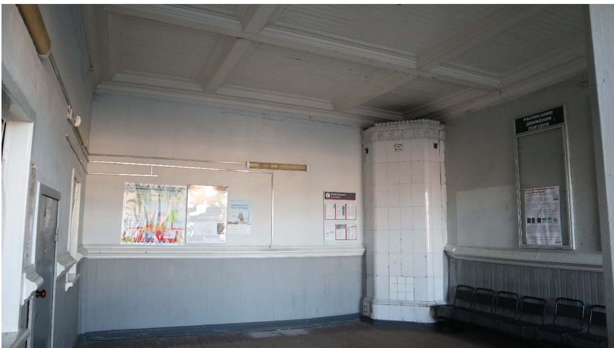
Фото 25. Помещение 1-Н (3). Общий вид.
