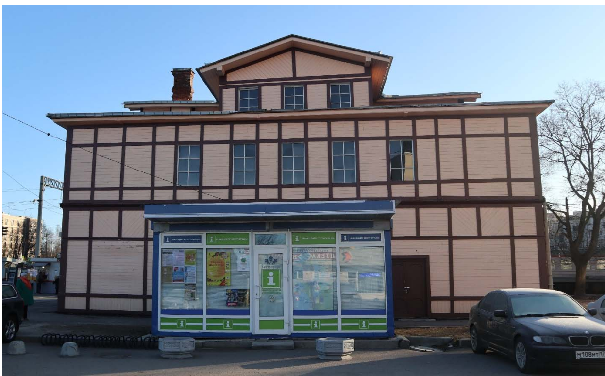
Фото 4. Западный фасад, общий вид.
