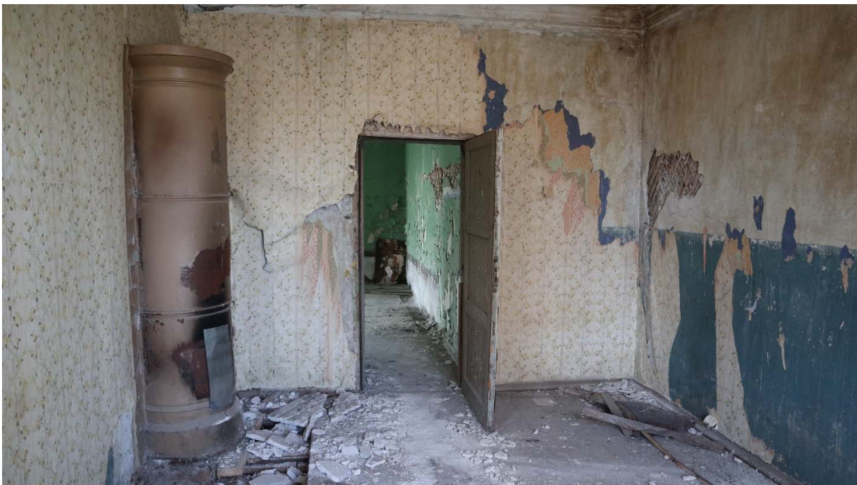
Фото 33. Помещение 2 этажа (2-Н (28))
