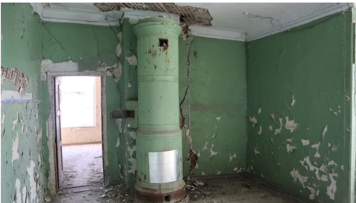
Фото 36. Помещение 2 этажа (2-Н (18))
