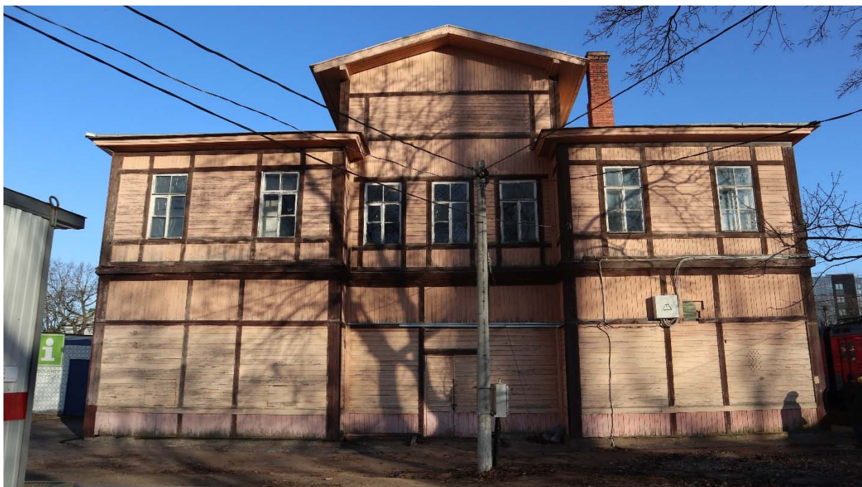
Фото 7. Южный фасад, общий вид.
