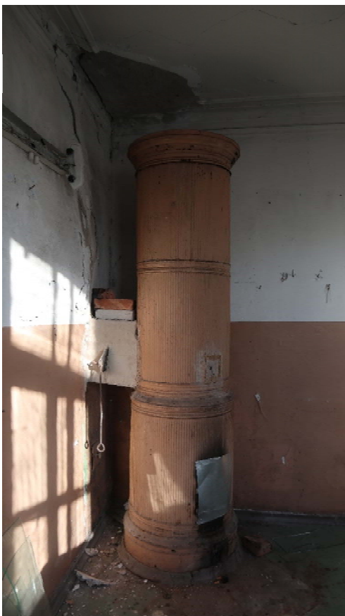
Фото 30. Помещение 2 этажа (2-Н (22)).
