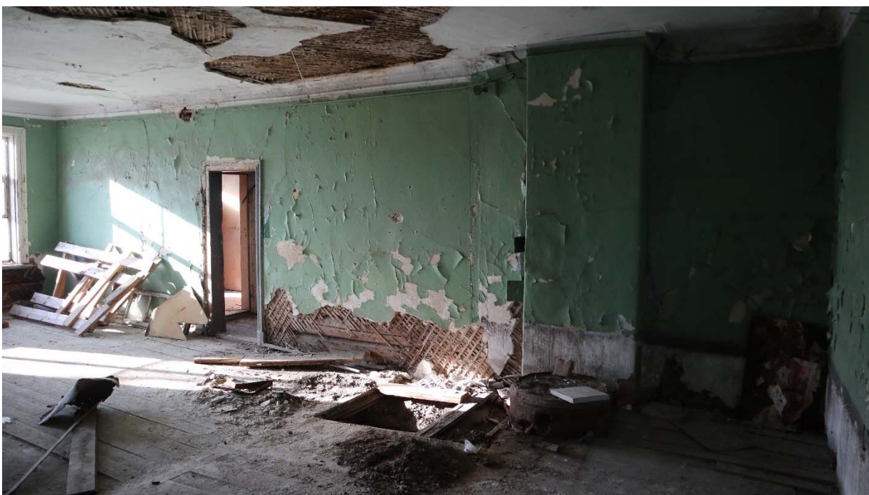
Фото 34. Помещение 2 этажа (2-Н (18))
