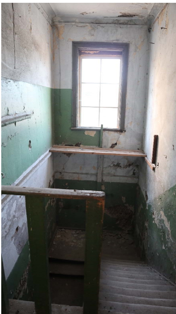
Фото 48. Лестница ЛК-2 (по восточному фасаду)
