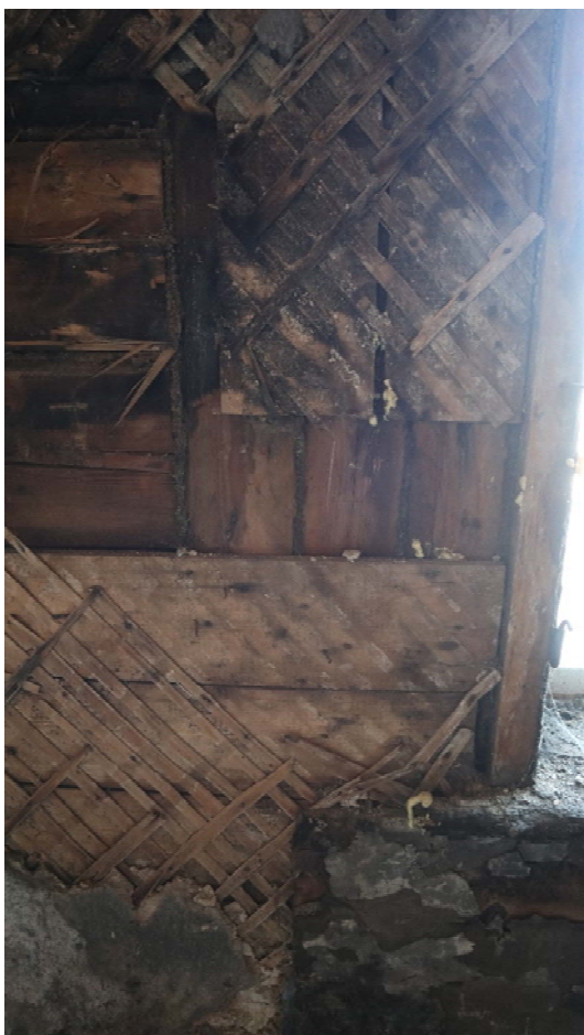
Фото 43. Помещение 2 этажа (2-Н (10)). Фрагмент «наращивания» простенка стены, уменьшивший габариты оконного проёма.
