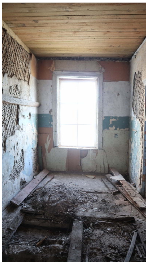
Фото 40. Помещение 2 этажа (2-Н (16))
