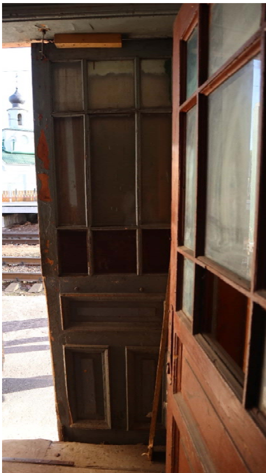
Фото 12. Вход в здание с восточного фасада. Сохранилось дверное заполнение, закрытое с фасада обшивкой.
