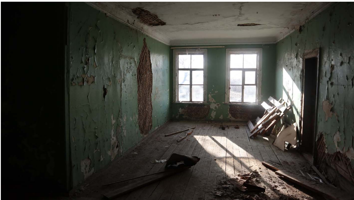
Фото 35. Помещение 2 этажа (2-Н (18))
