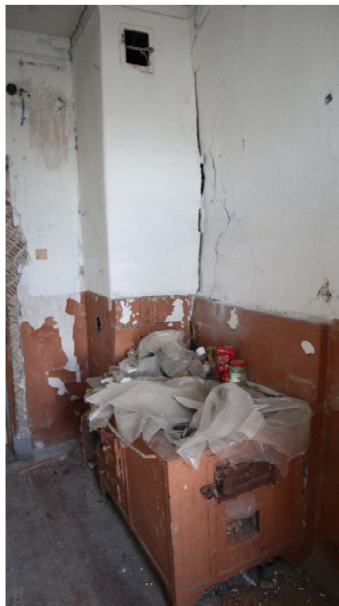
Фото 31. Помещение 2 этажа (2-Н (23))
