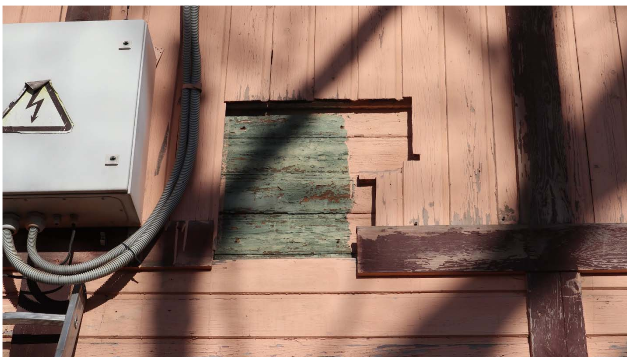
Фото 8. Фрагмент вскрытия обшивки. Под современной обшивкой находится историческая обшивка.
