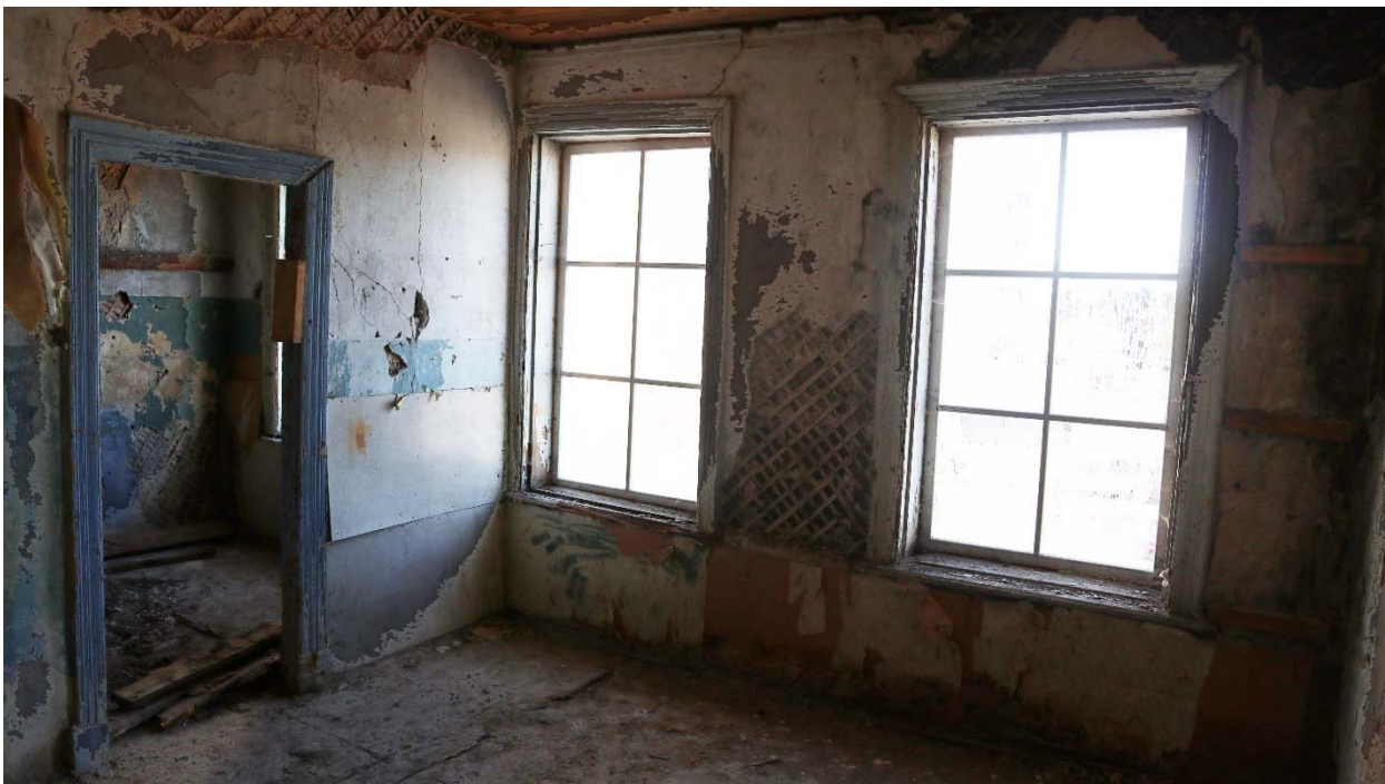
Фото 41. Помещение 2 этажа (2-Н (16))
