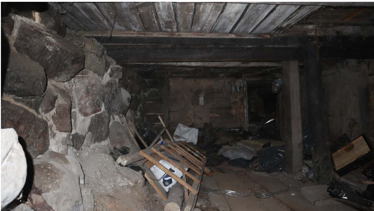
Фото 55. Пространство подвала. Валунный фундамент.
