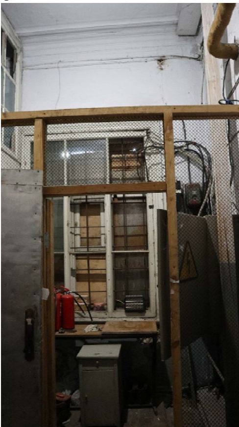
Фото 13. Помещение 1 этажа (2-Н (5))
