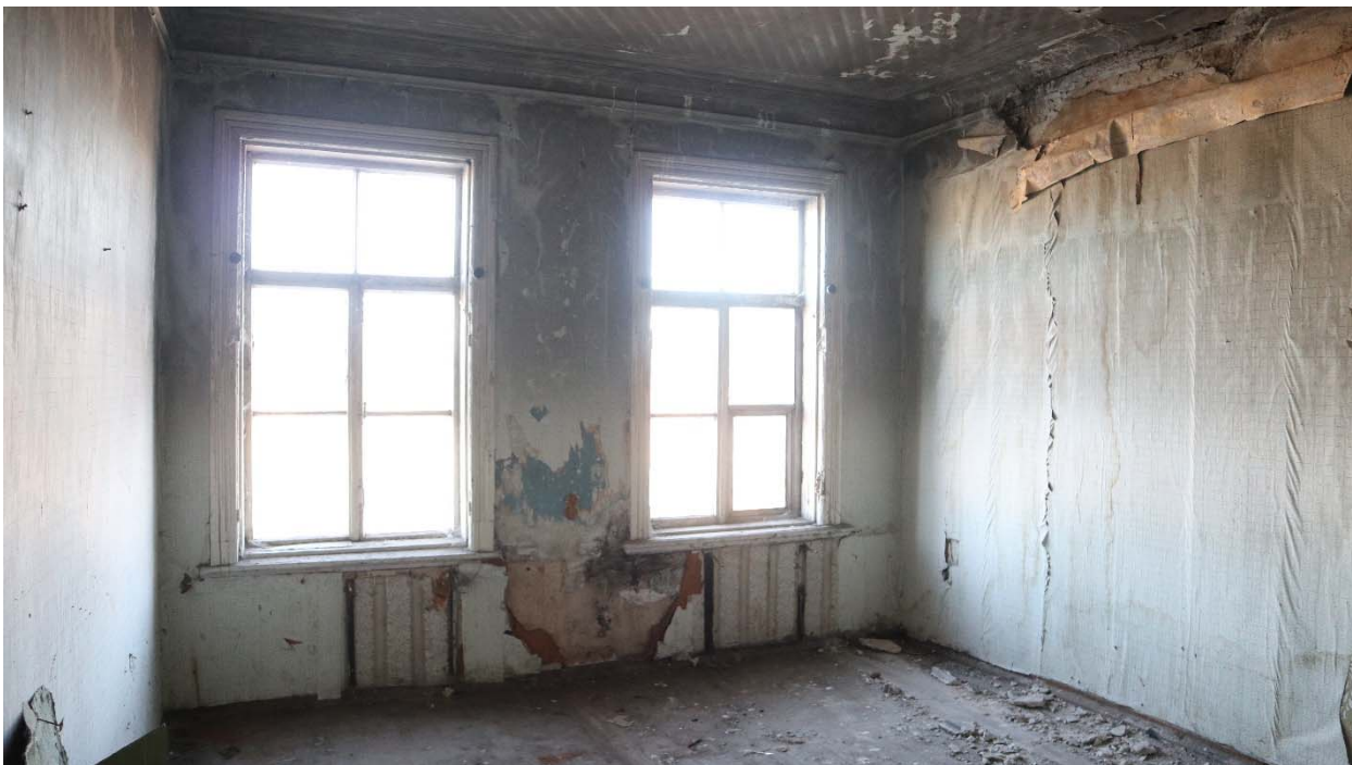
Фото 45. Помещение 2 этажа (2-Н (8))
