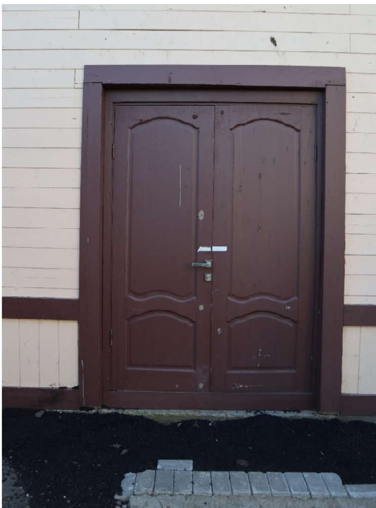
Фото 6. Дверной проём по западному фасаду. Дверное заполнение позднее, выполненное в ходе ремонта 2018 года.
