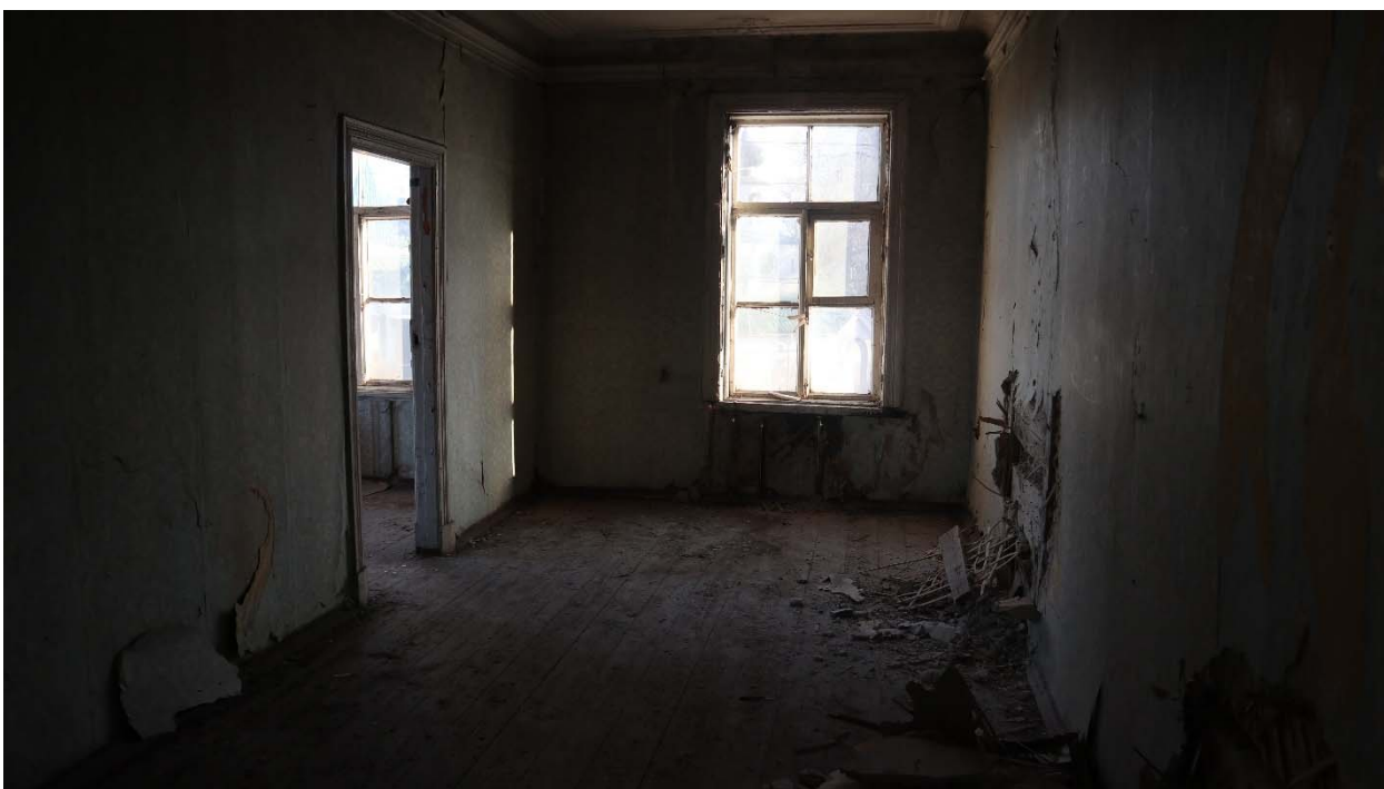
Фото 46. Помещение 2 этажа (2-Н (6))
