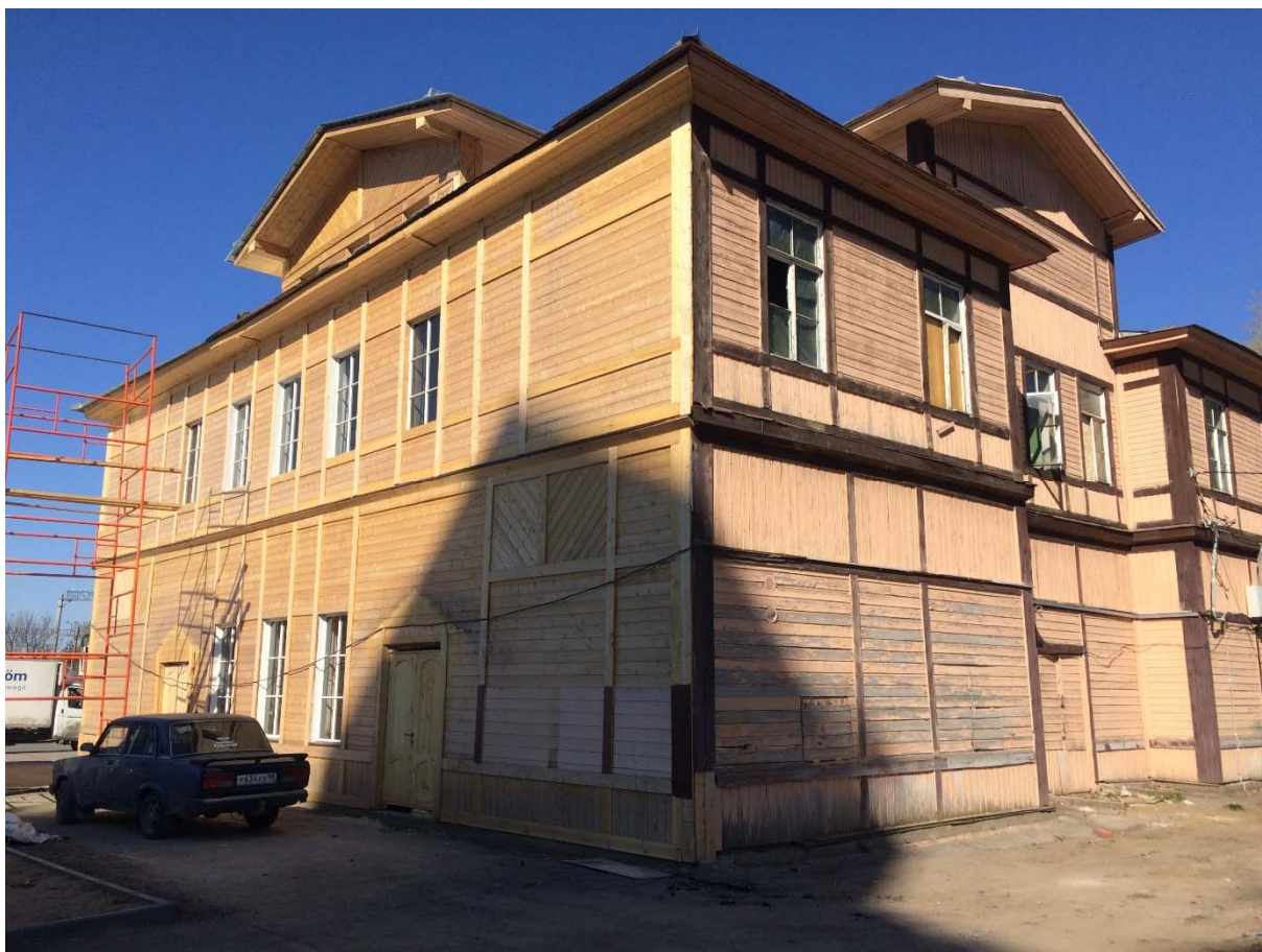
Илл. 31. Сестрорецкий вокзал. Ремонтные работы после пожара в феврале 2018 г.
