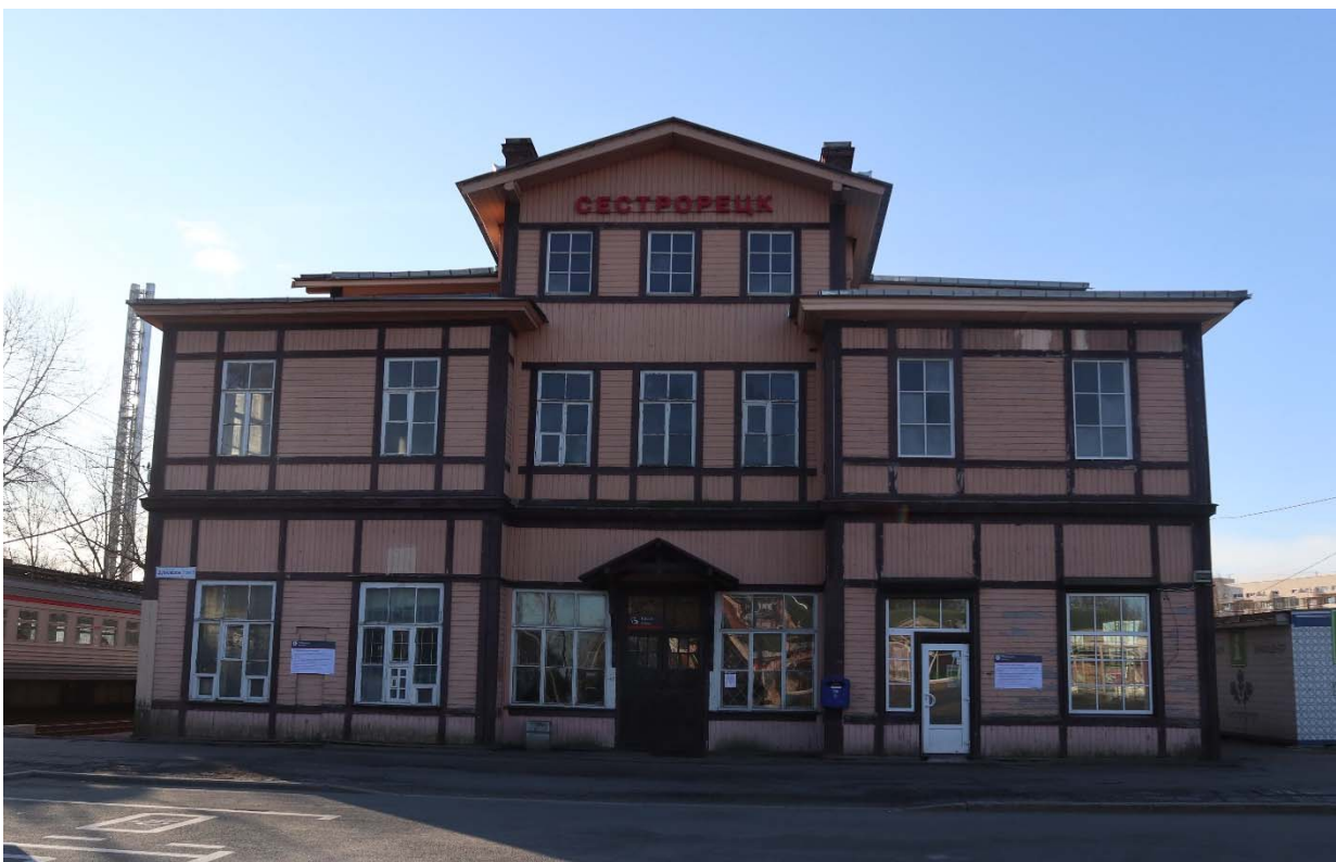
Фото 1. Северный фасад, общий вид.
