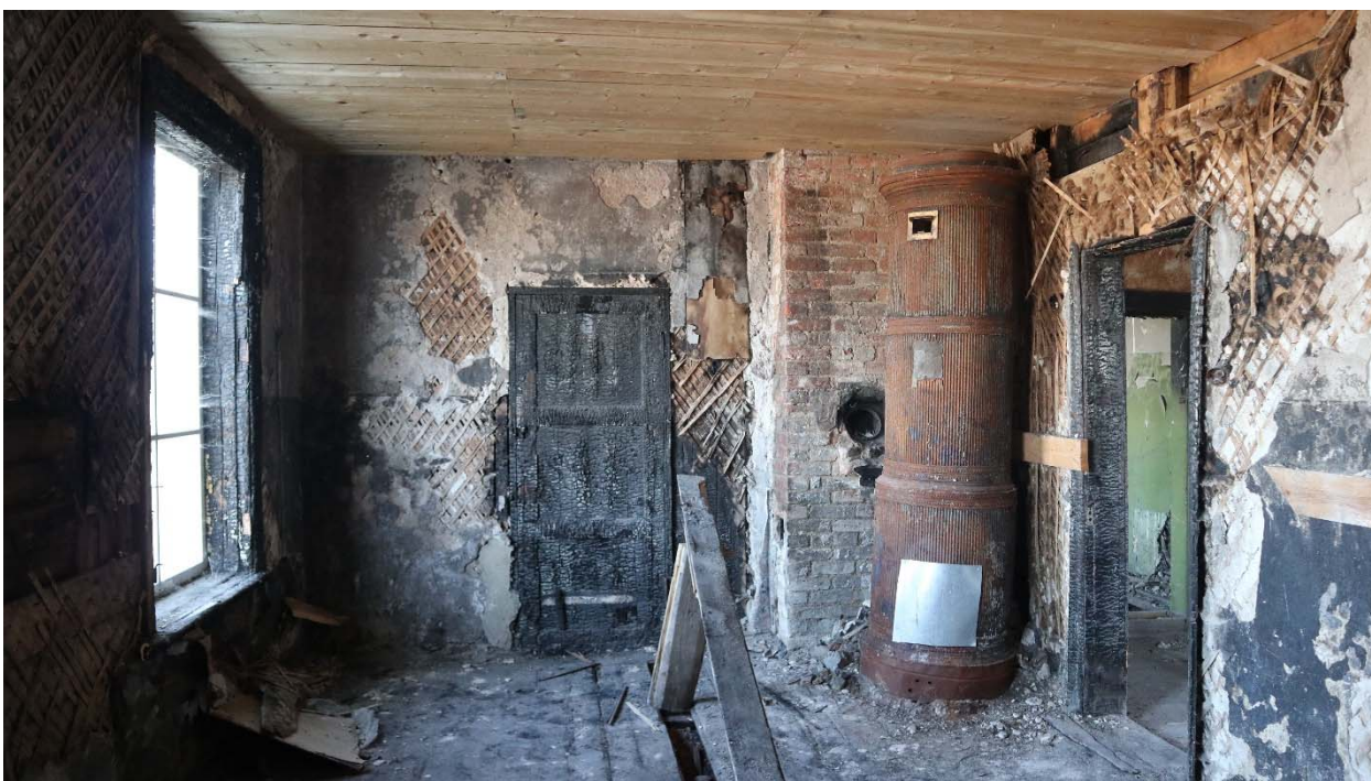
Фото 42. Помещение 2 этажа (2-Н (10))
