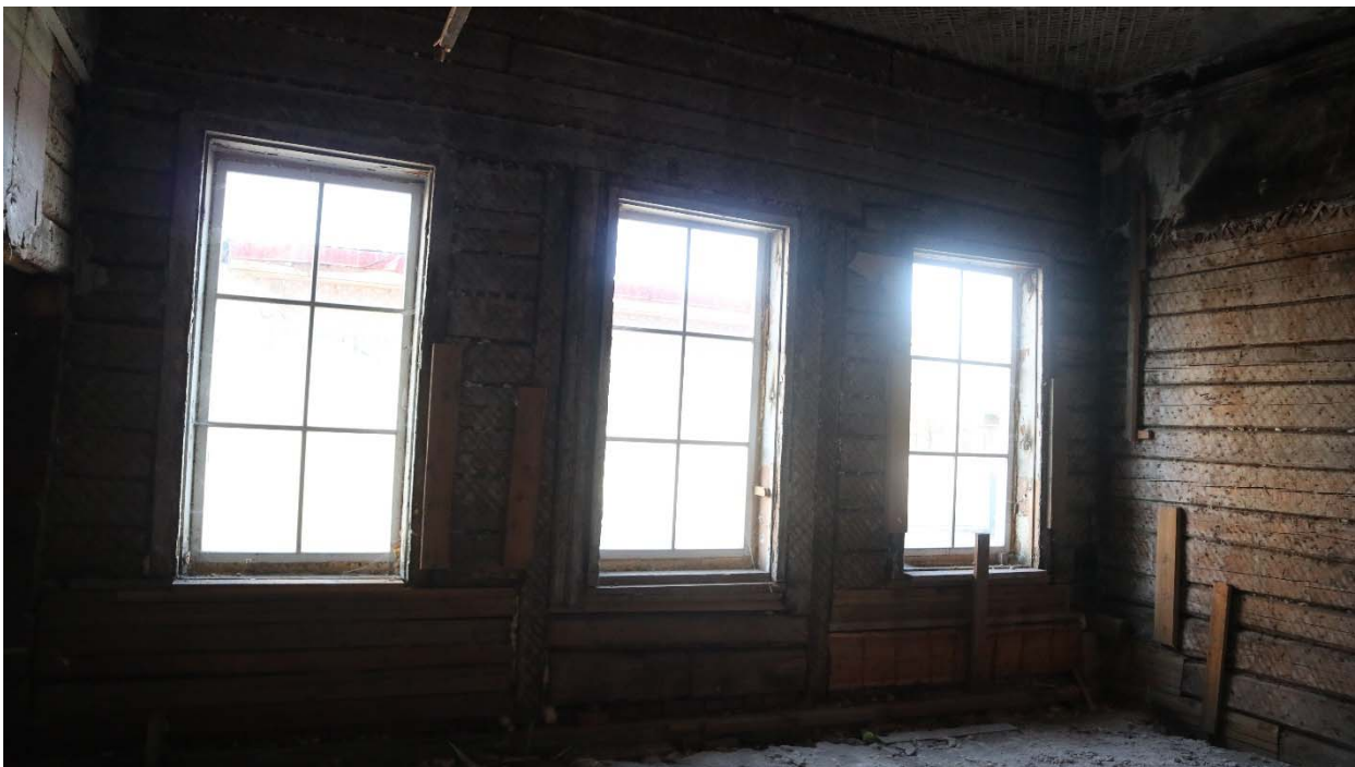
Фото 17. Помещение 2-Н (11,12,13,14,15). Окна, выходящие на западный фасад.
