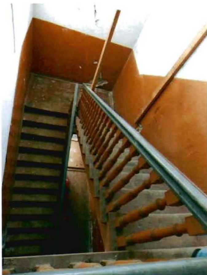
6. Лестница в юго-восточной части здания
