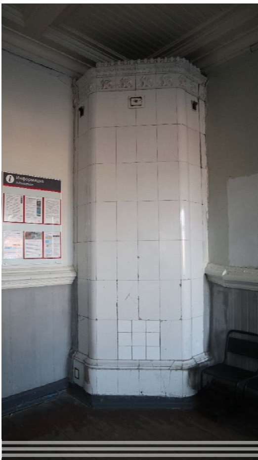
Фото 23. Помещение 1-Н (3). Печь в кассовом зале.
