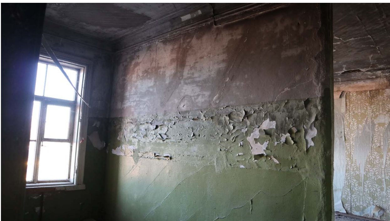
Фото 44. Помещение 2 этажа (2-Н (9))
