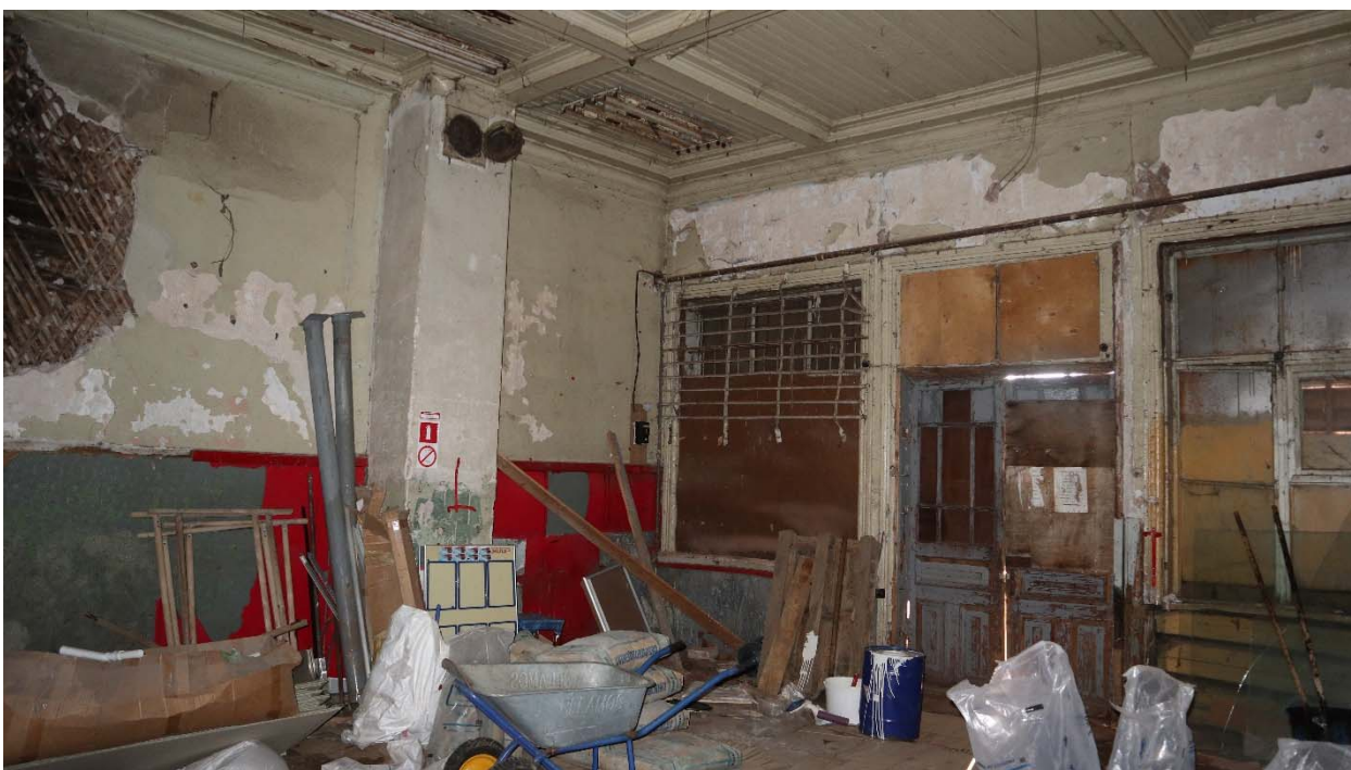
Фото 18. Помещение 2-Н (4). Оконные и дверные проёмы сохранили исторические габариты, сохранились исторические заполнения. Со стороны фасада проёмы закрыты обшивкой.
