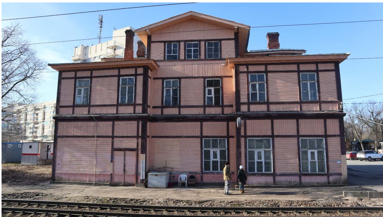
Фото 9. Восточный фасад, общий вид. В уровне первого этажа закрыты оконные проёмы, створки дверного заполнения защиты обшивкой.
