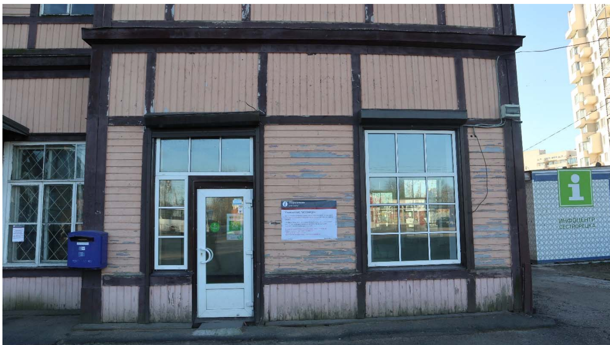
Фото 3. Фрагмент северного фасада. Поздний дверной проём, устроенный в оконном проёме.
