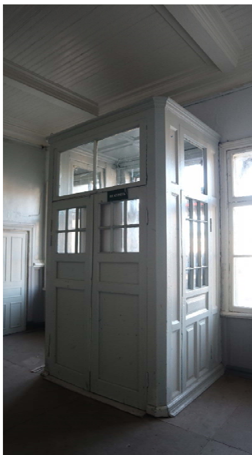
Фото 24. Помещение 1-Н (3). Тамбур у входа с северного фасада.
