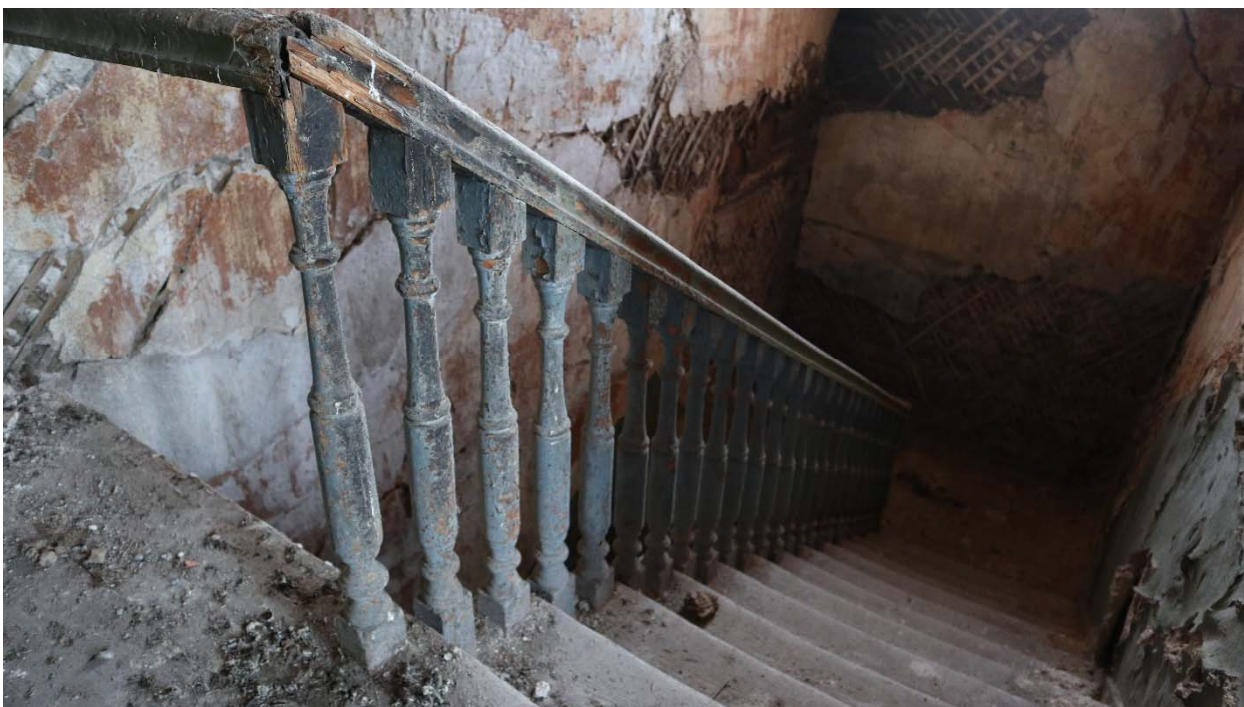
Фото 50. Лестница по восточному фасаду (ЛК-1)
