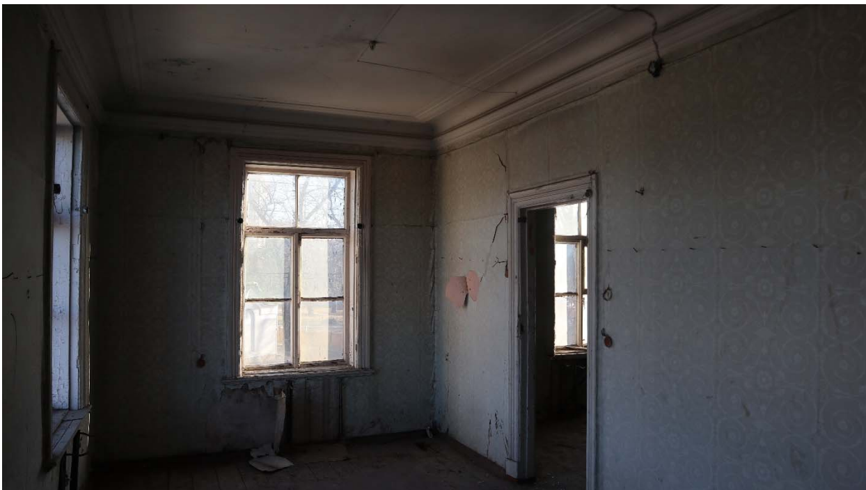
Фото 47. Помещение 2 этажа (2-Н (7))
