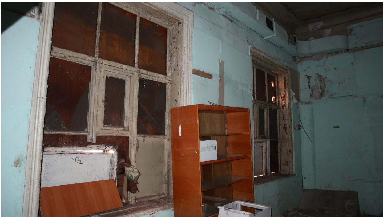
Фото 21. Помещение 2-Н (3). Оконные проёмы выходят на южный фасад. Проёмы закрыты обшивкой со стороны фасадов.
