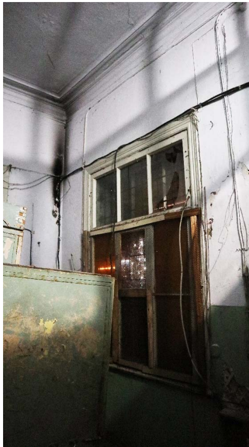
Фото 14. Помещение 1 этажа (2-Н (6))
