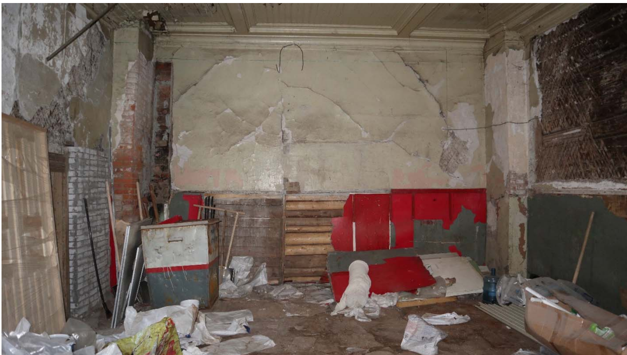
Фото 19. Помещение 2-Н (4). Стена, разделяющая бывший зал ожидания и кассовый зал.
