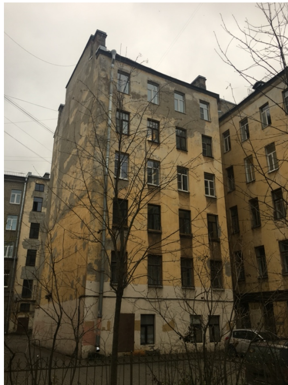
5. Вид дворового фасада. Направление съемки юго-восток.
