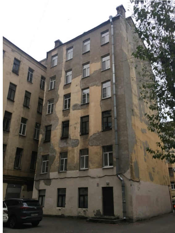
4. Вид дворового фасада. Направление съемки юго-восток.
