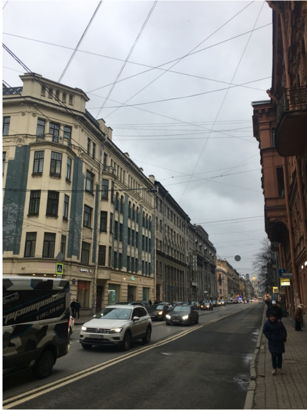
2. Вид лицевого фасада с пр. Загородного
