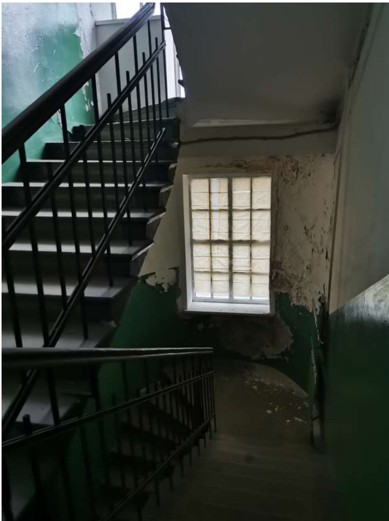
Фото 32. Вид на лестницу (вход со стороны южного фасада)
