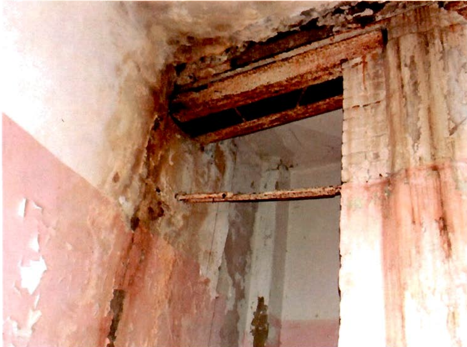
18. Фрагмент интерьера 1ого этажа
