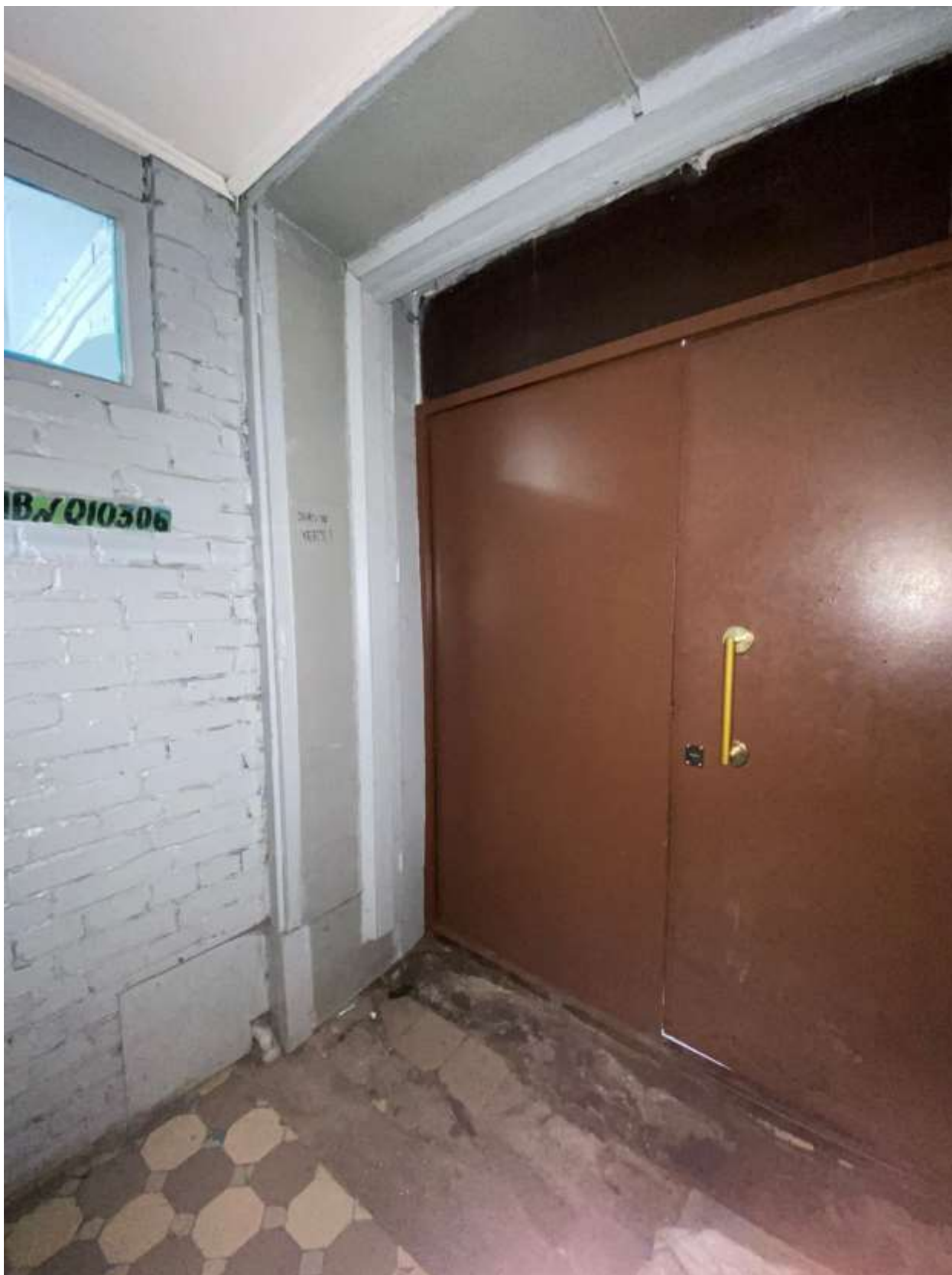
Фото 9. Тамбур при входе в пассажирский зал
