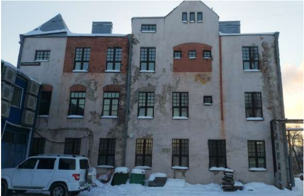
Фото 3. Вид на северный дворовый фасад
