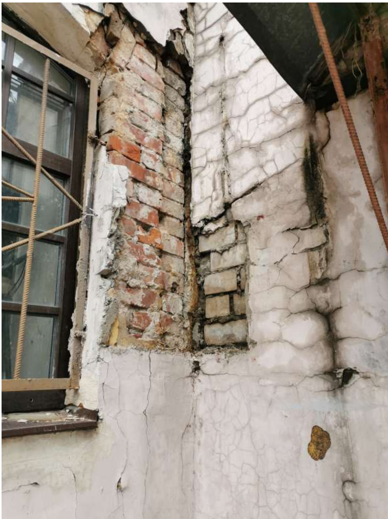
Фото 6. Вид на вход в пристройку
