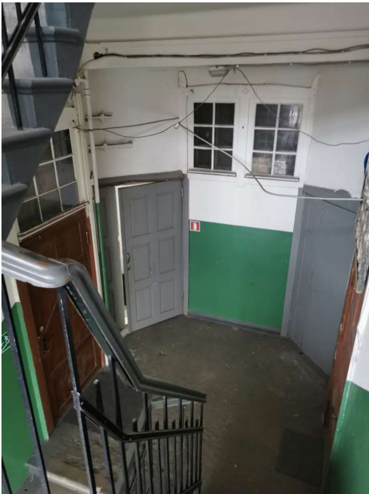
Фото 28. Вид на лестничную площадку на 3-м этаже
