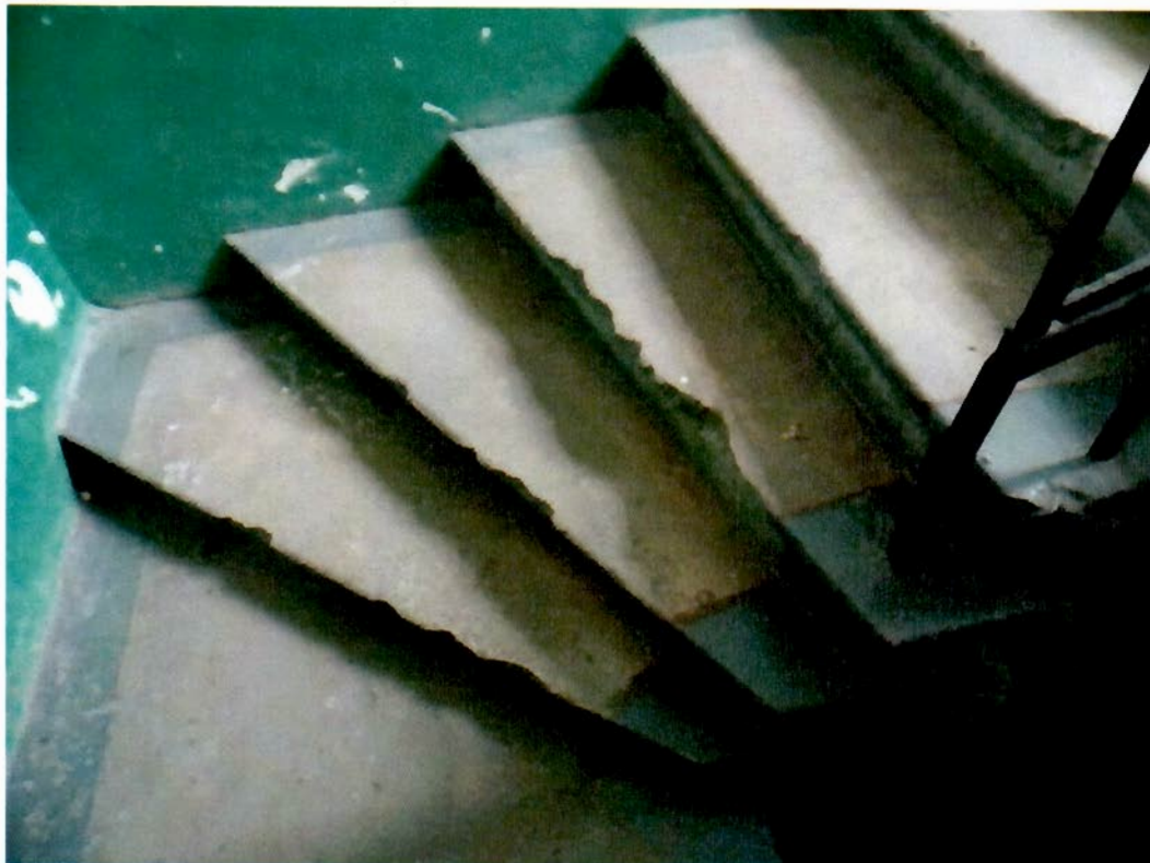
21. Фрагмент лестничного марша
