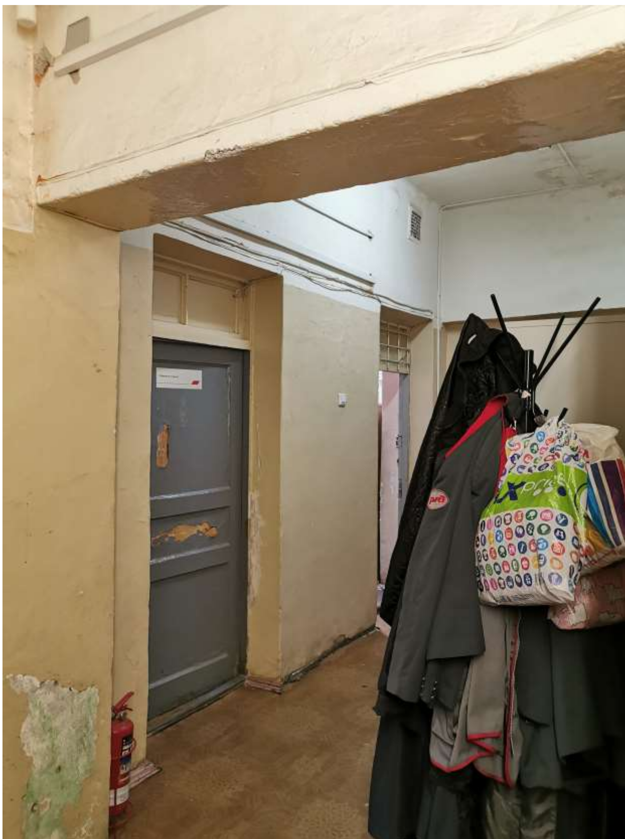
Фото 14. Вид на коридор 1-го этажа
