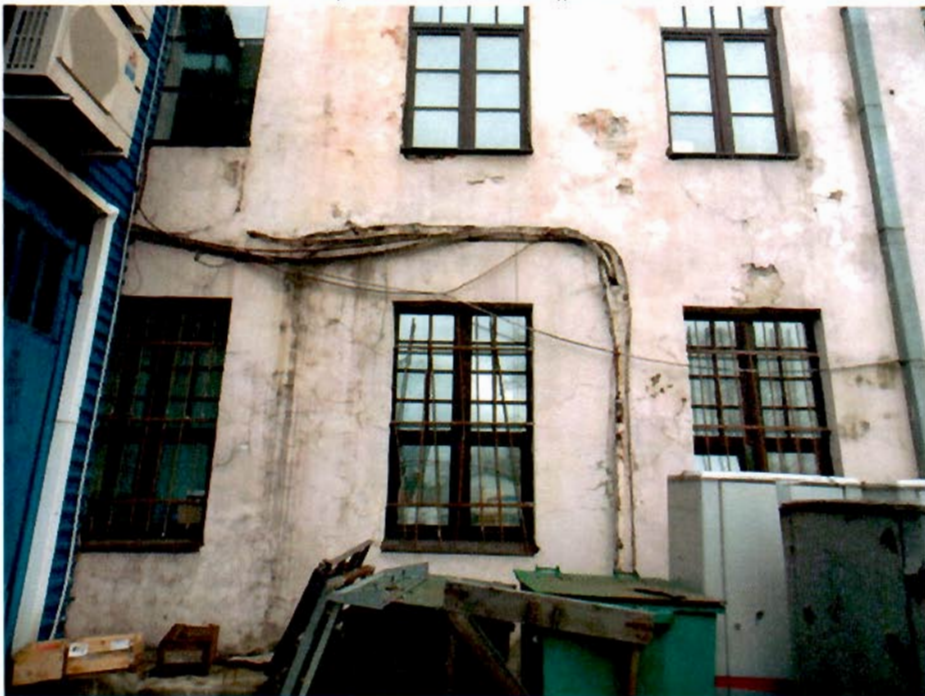
10. Фрагменты стены с северо-западной стороны
