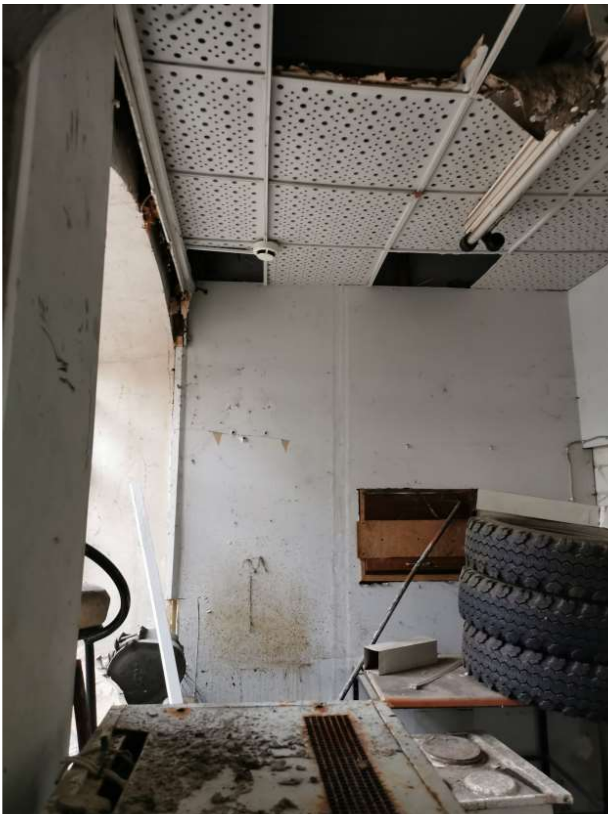
Фото 7. Вид на подсобное помещение в пристройке
