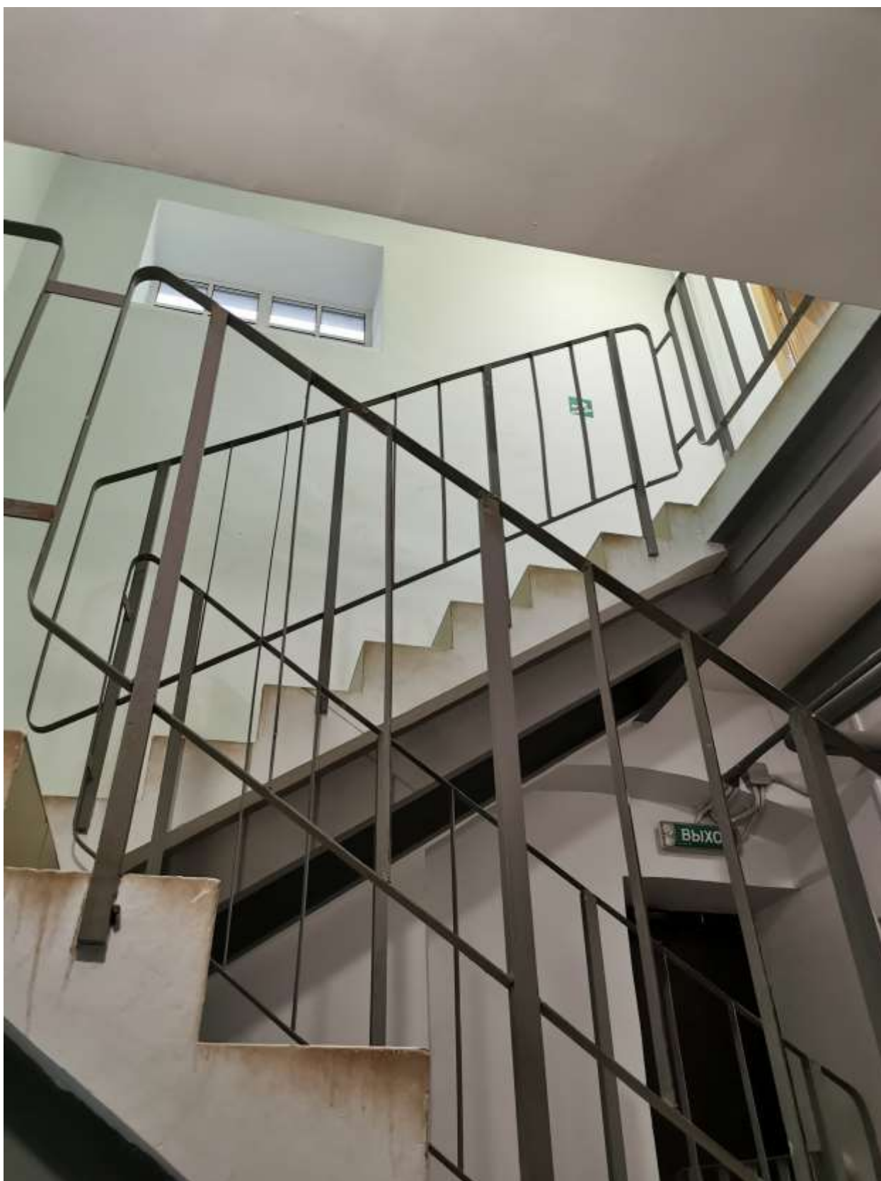
Фото 23. Вид на лестницу (вход со стороны восточного фасада)
