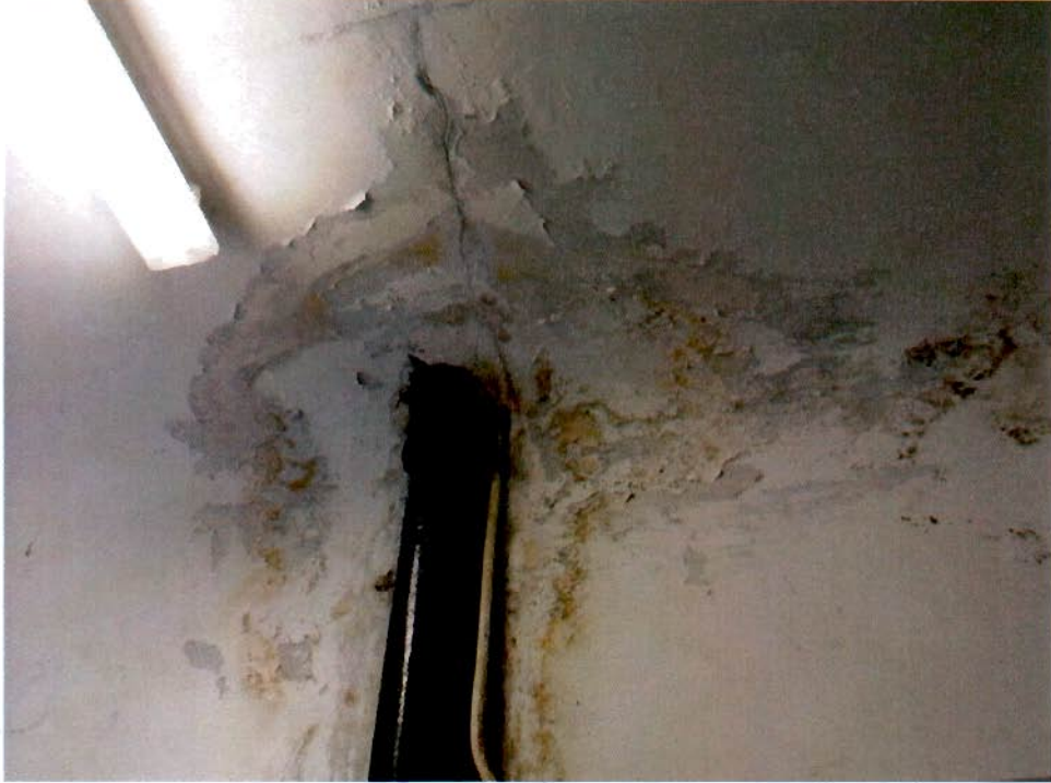
17. Фрагмент интерьера 1ого этажа
