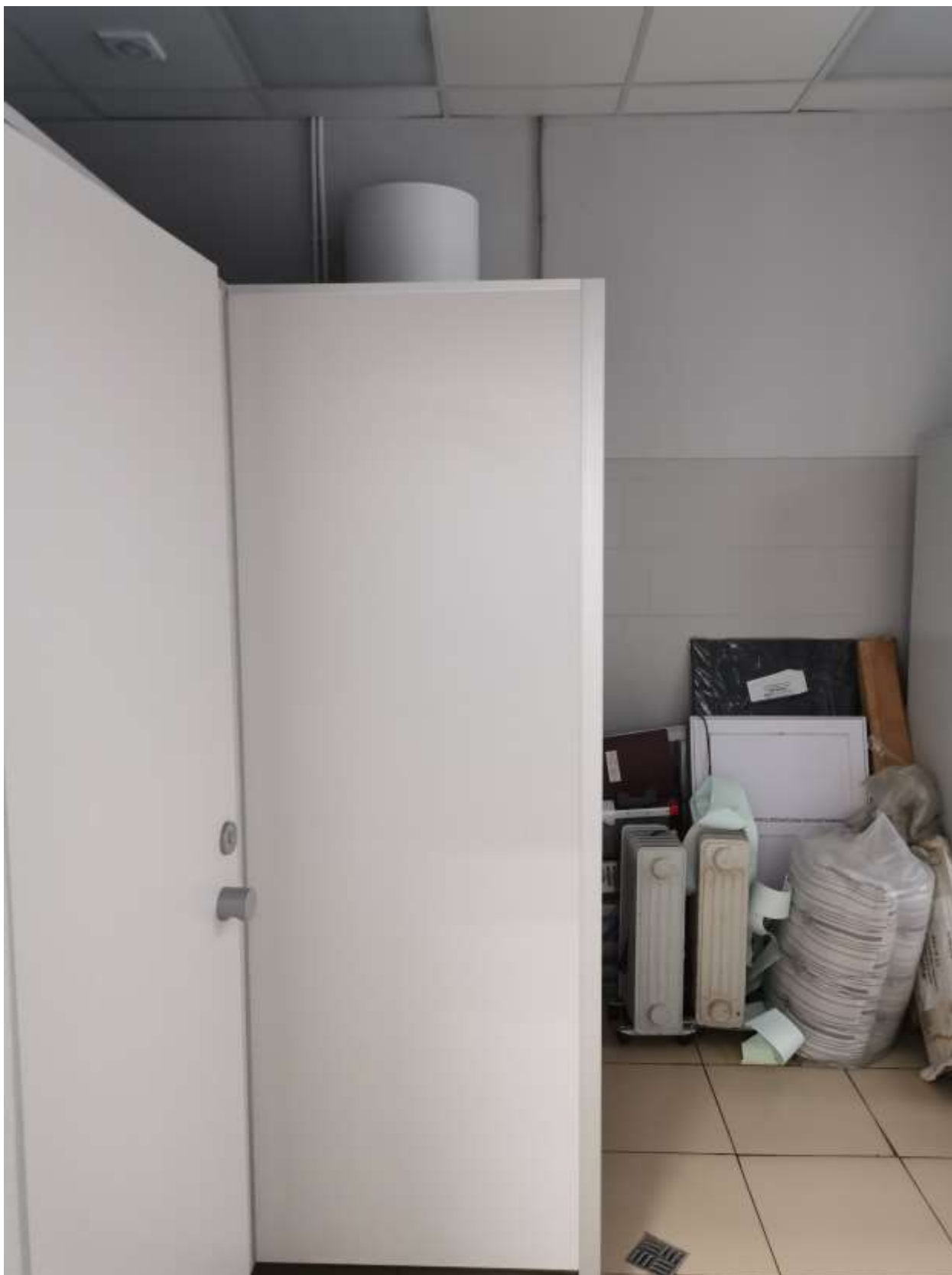
Фото 15. Вид на санузел на 1-м этаже
