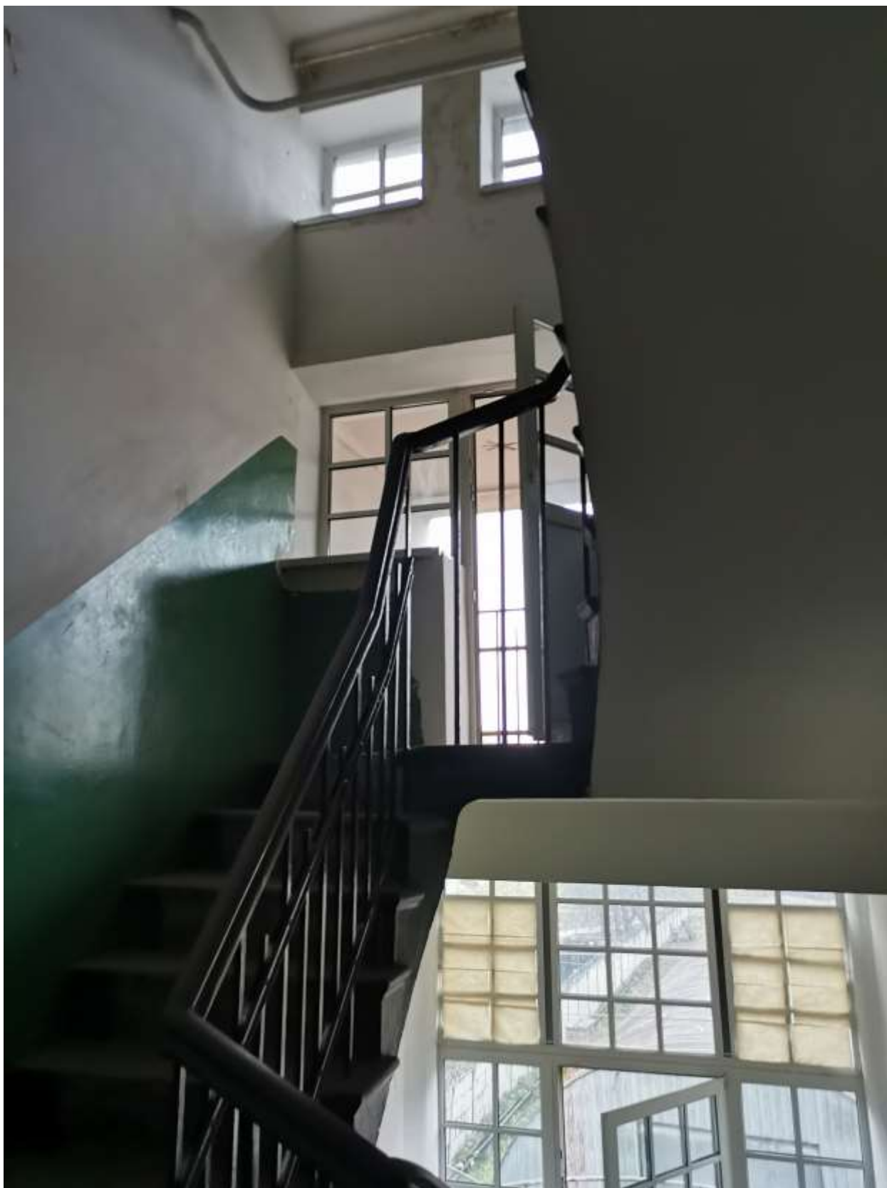
Фото 30. Вид на балкон и лестницу (вход со стороны южного фасада)
