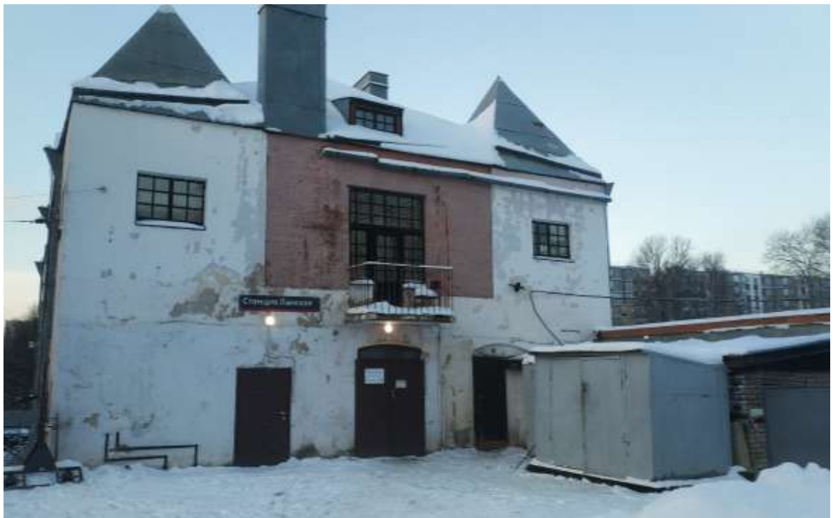
Фото 4. Вид на восточный фасад
