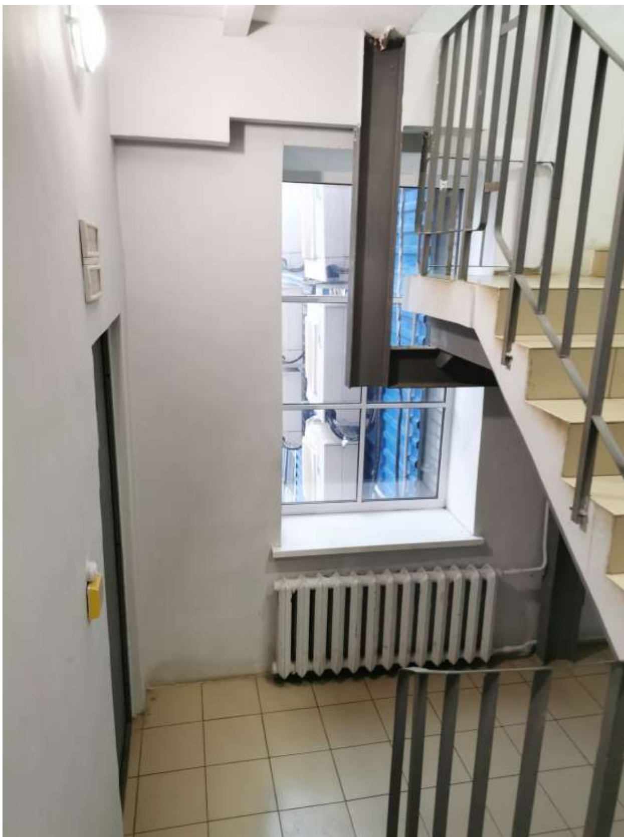
Фото 21. Вид на лестницу (вход со стороны восточного фасада)
