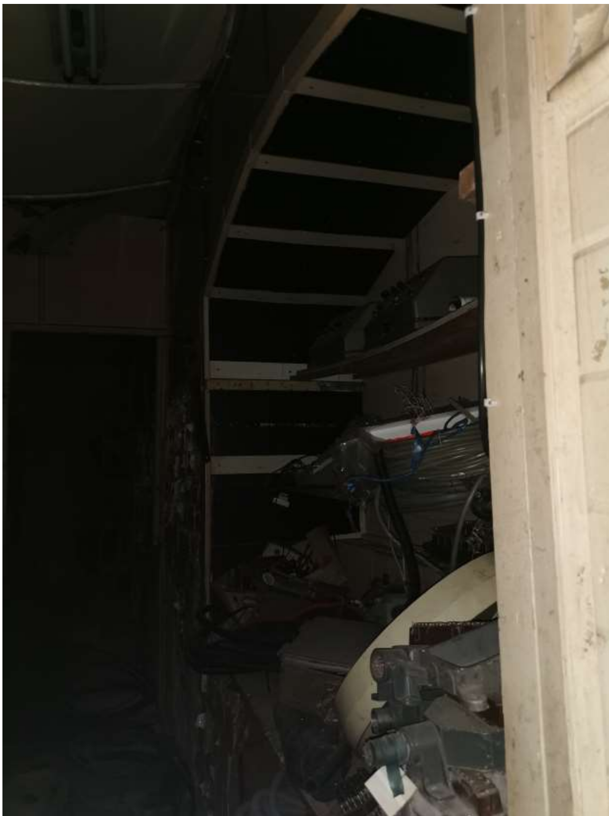
Фото 8. Вид на подсобное помещение в пристройке
