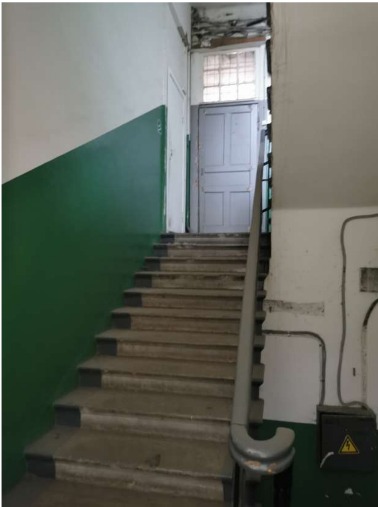
Фото 33. Вид на лестницу (вход со стороны южного фасада)
