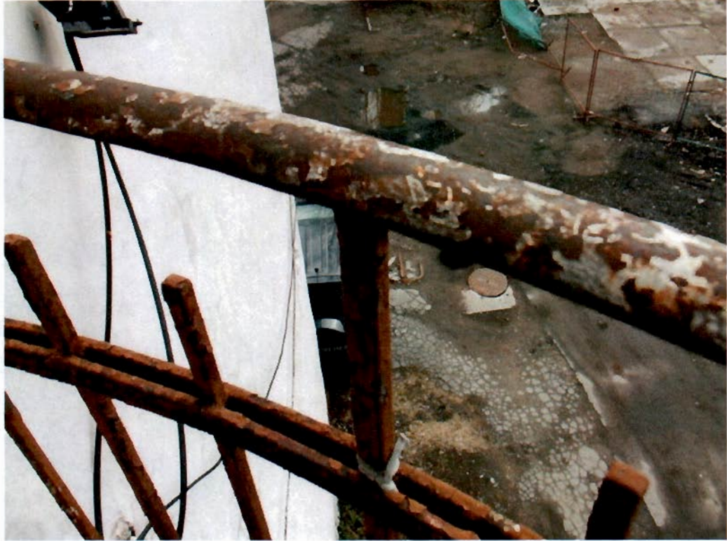
23. Элементы балкона 2ого этажа с юго-западной стороны.
