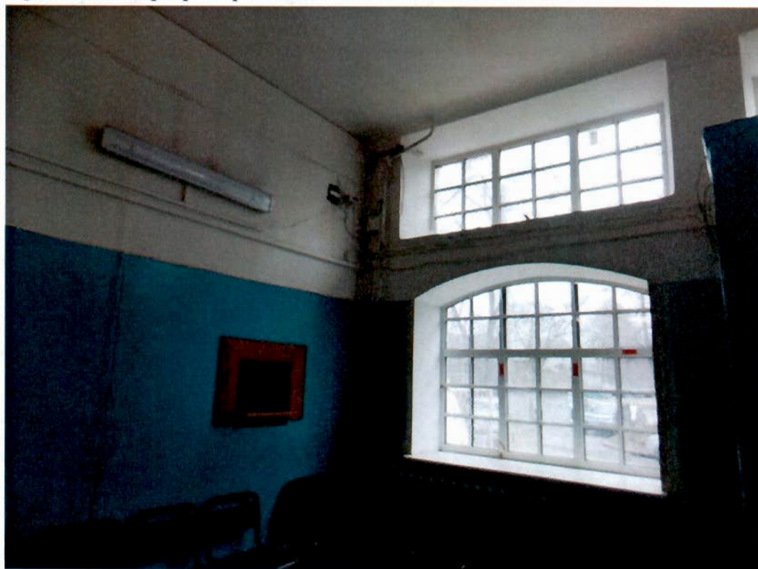
16. Фрагмент интерьера парадного зала ж.д. станции Ланская
