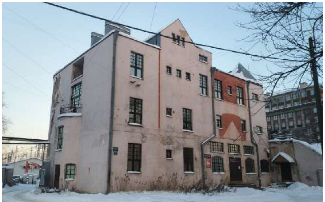
Фото 2. Вид на южный центральный фасад
