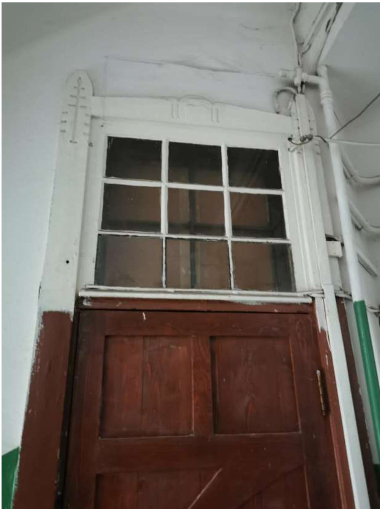
Фото 29. Вид на деревянное дверное полотно на 3-м этаже
