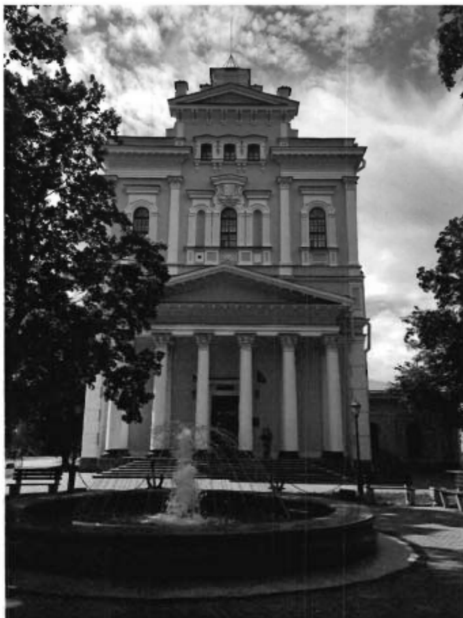
1. Лицевой фасад. Общий вид.
