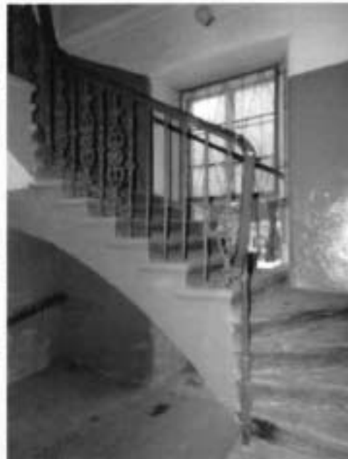
4. Внутренняя лестница (пом. I-Н(7)).
