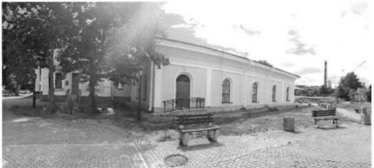
4. Западный фасад. Общий вид.
