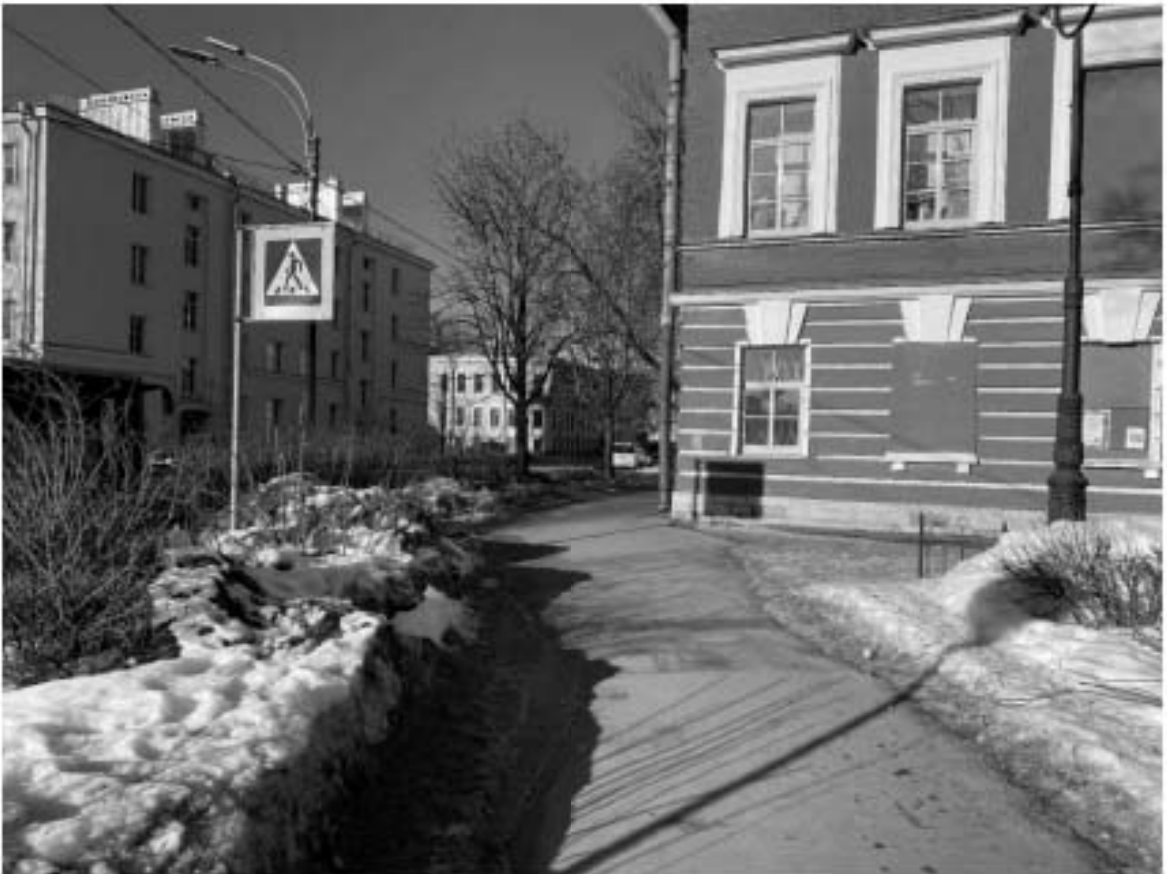
Фото 9. Вид вдоль ул. Ленинградской, справа - объект культурного наследия федерального значения «Дом пастора».
