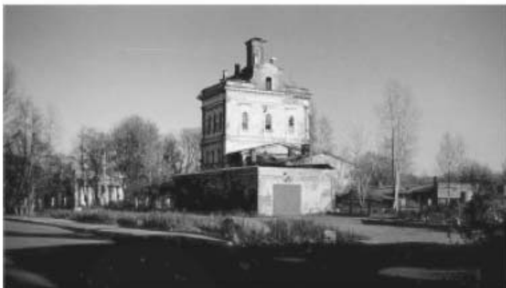
8. «Башня городского водопровода. Вид с юго-запада». Фотография 1999 г. – Архив КГИОП.
