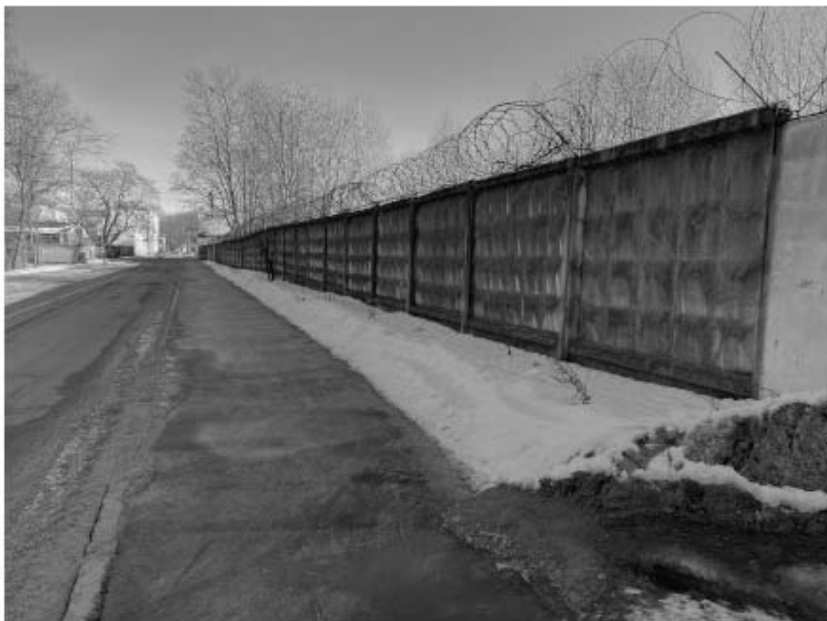
Фото 1. Тротуар вдоль ул. Ильмянинова.
