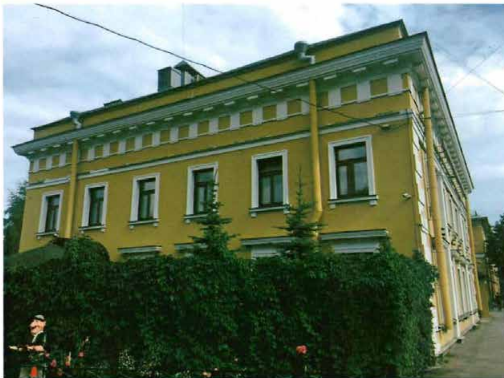
2. Фрагмент северо-западного фасада.
