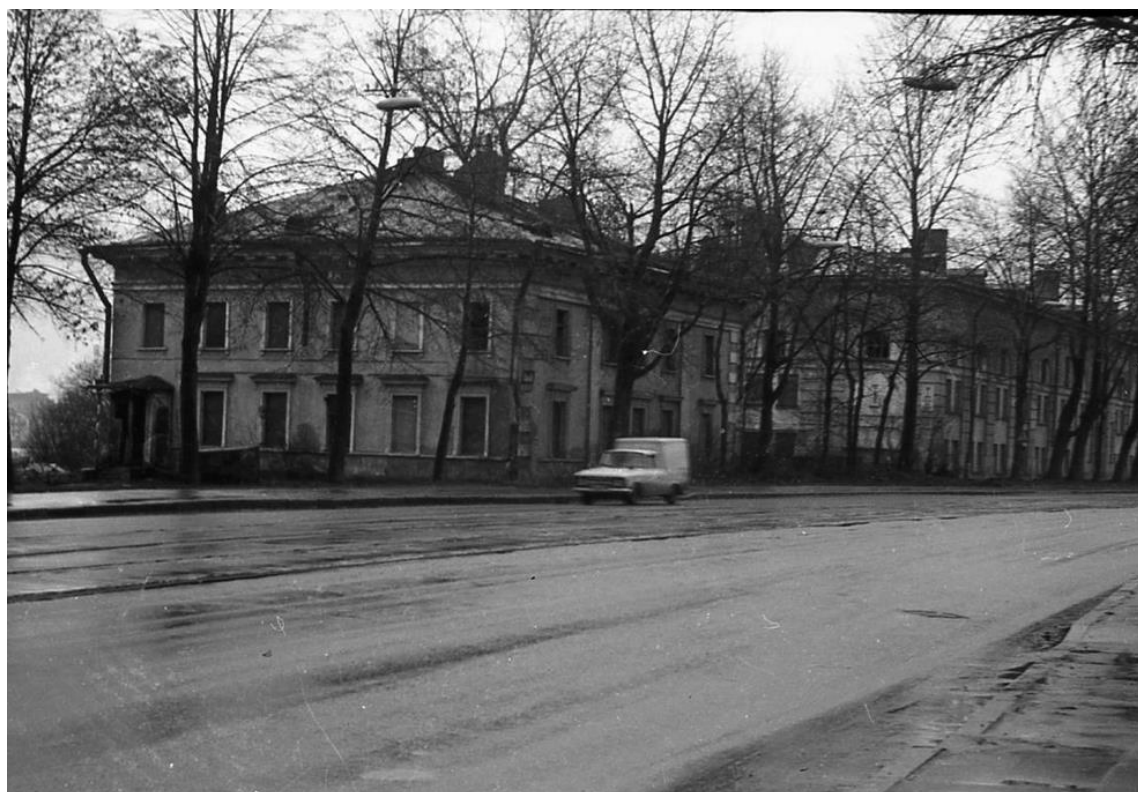
Илл. 17. Общий вид дома № 26 на проспекте Обуховской Оборона в период капитального ремонта (бывший дом смотрителя при провиантском магазине на Рожке, 1835 г.). Retro View of Mankind's Habitat [Электронный ресурс]. Режим доступа: https://pastvu.com/ .
