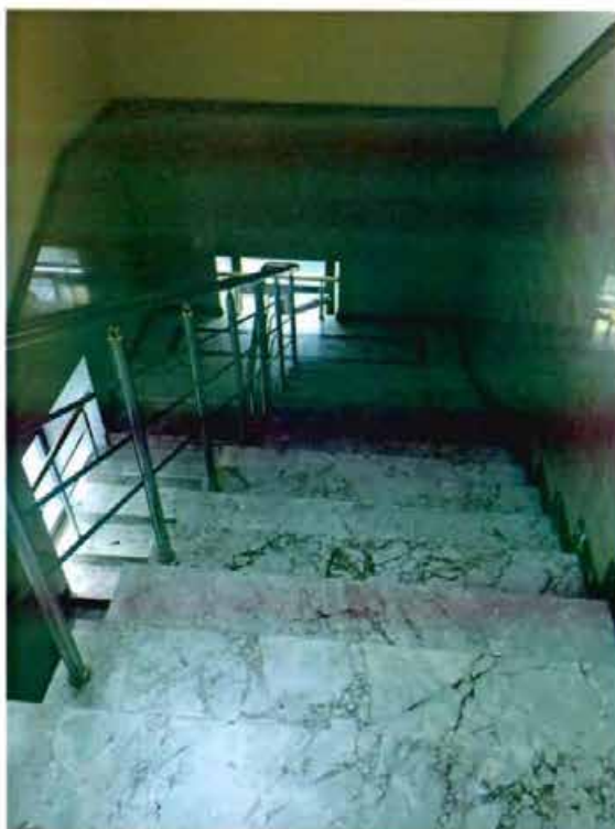
7. Фрагмент черной двухмаршевой лестницы.
