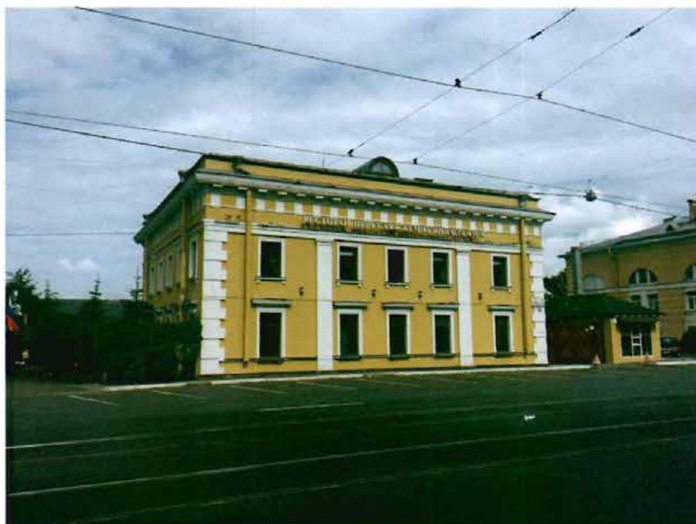
1. Общий вид на юго-западный фасад.
