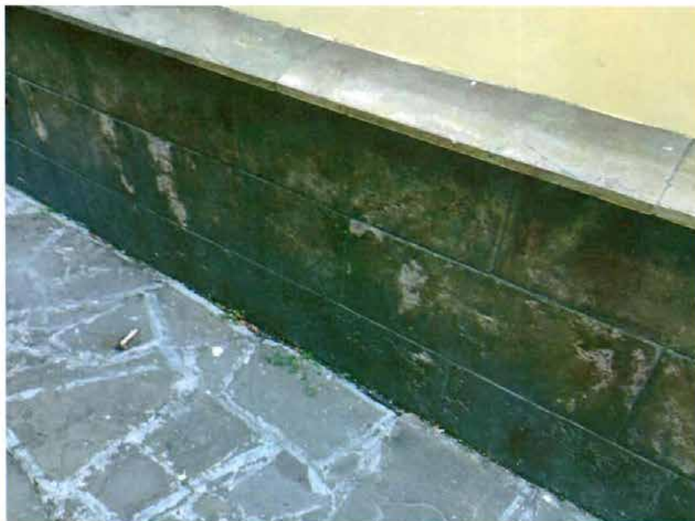
5. Фрагмент известнякового цоколя.
