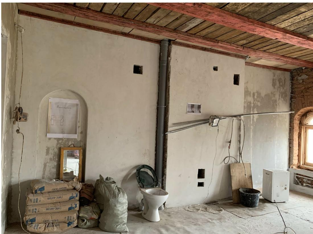
Фото №4. Общий вид на заложённое окно в осях А-В, фрагмент окна ОК-1 проектируемой квартиры в осях 3-4
