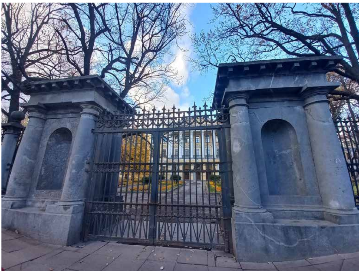
Фото 10. Вид с ул. Садовая. Центральная часть – пилоны и ворота. Направление съемки – северо-запад.
