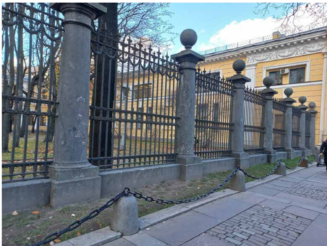
Фото 8. Вид с ул. Садовая. Направление съемки – северо-восток.
