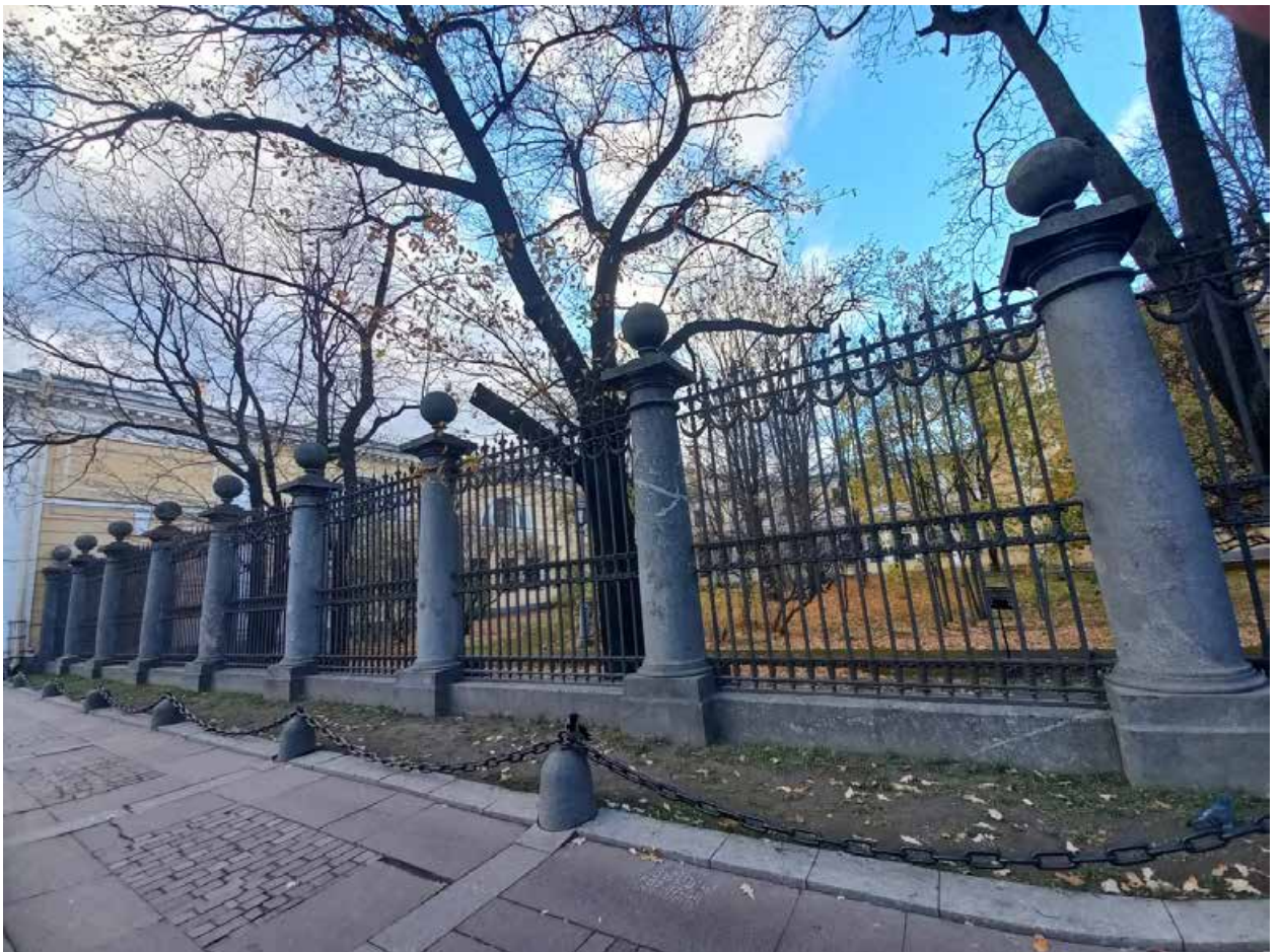
Фото 11. Вид с ул. Садовая. Направление съемки –запад.
