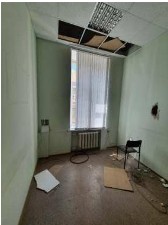
76. «Здание Коммерческого училища (с оградой)», ул. Ломоносова, д. 9, лит. А. Помещение №207. Общий вид. Фото 01.12.2020 г.
