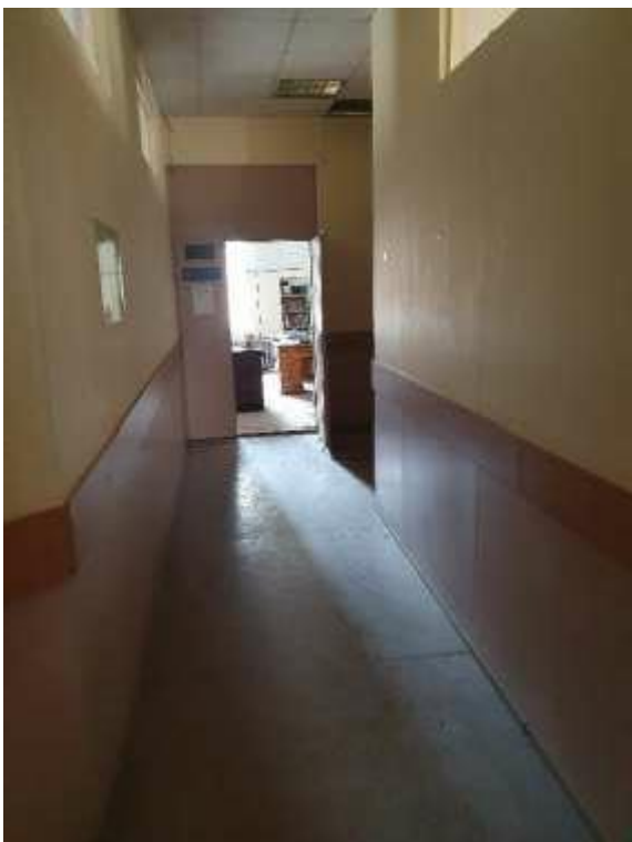
43. «Здание Коммерческого училища (с оградой)», ул. Ломоносова, д. 9, лит. А. Помещение №204. Общий вид. Фото 01.12.2020 г.
