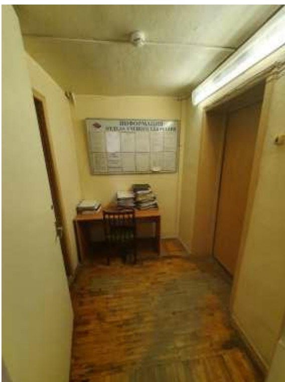
7. «Здание Коммерческого училища (с оградой)», ул. Ломоносова, д. 9, лит. А. Помещение №199. Общий вид. Фото 01.12.2020 г.
