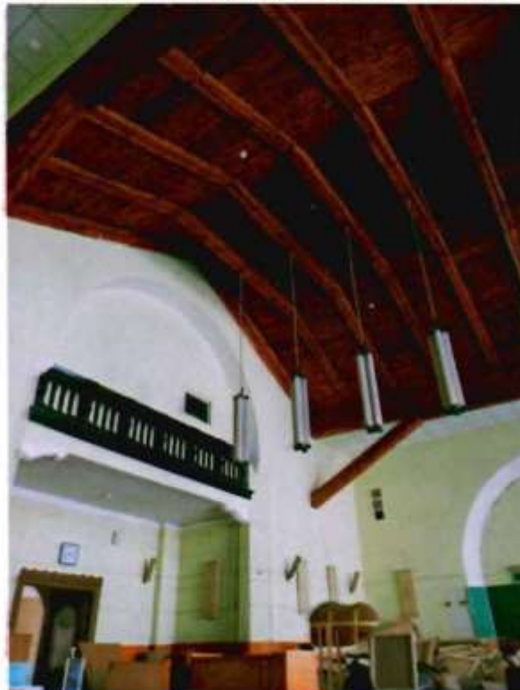
10. Актный зал (перекрытие, балкон на консолях)
