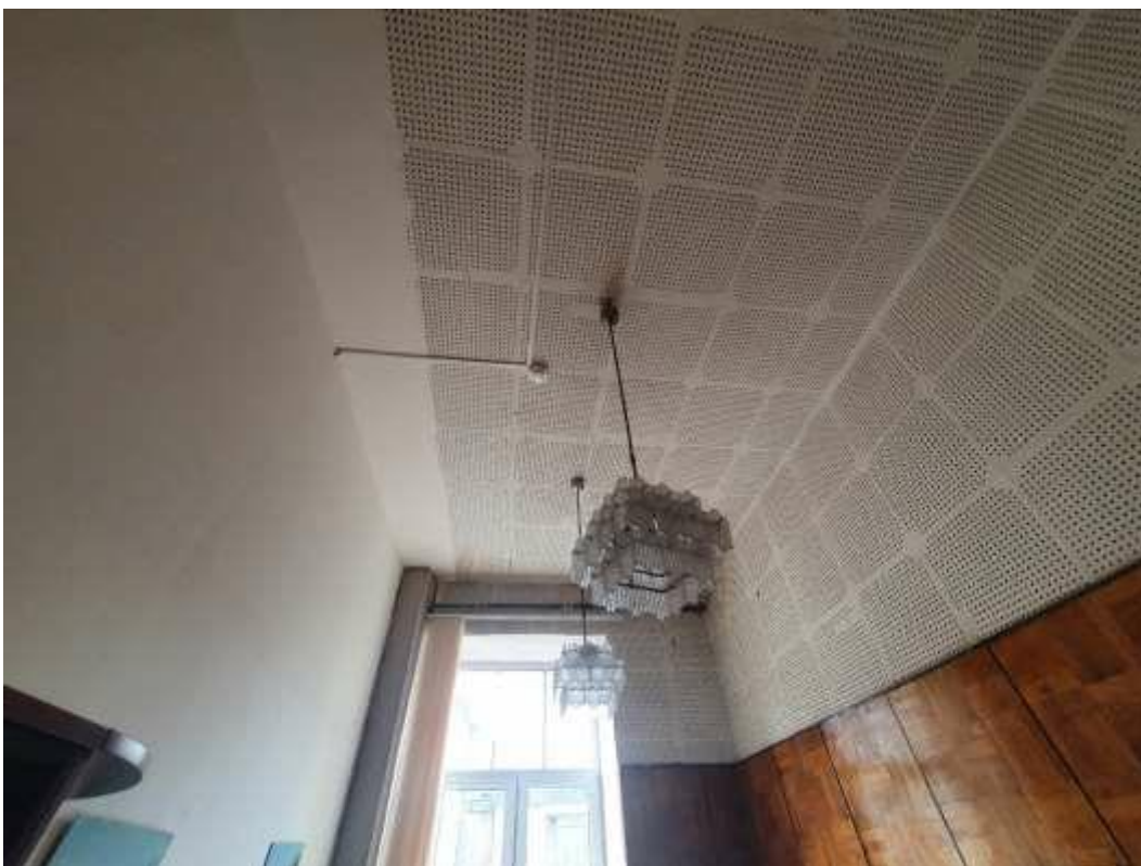
19. «Здание Коммерческого училища (с оградой)», ул. Ломоносова, д. 9, лит. А. Помещение №203. Фрагмент. Фото 01.12.2020 г.
