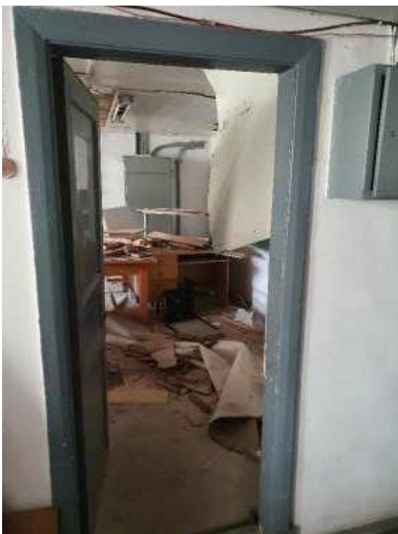
52. «Здание Коммерческого училища (с оградой)», ул. Ломоносова, д. 9, лит. А. Помещение №211. Фрагмент. Фото 01.12.2020 г.
