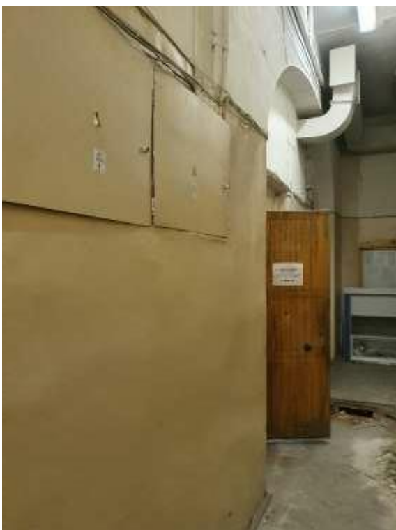
34. «Здание Коммерческого училища (с оградой)», ул. Ломоносова, д. 9, лит. А. Помещение №204. Фрагмент. Фото 01.12.2020 г.
