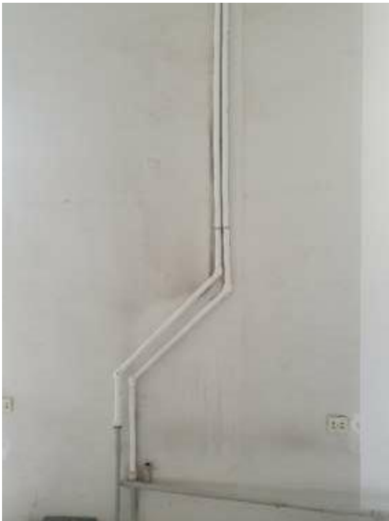
84. «Здание Коммерческого училища (с оградой)», ул. Ломоносова, д. 9, лит. А. Помещение №206. Фрагмент. Фото 01.12.2020 г.
