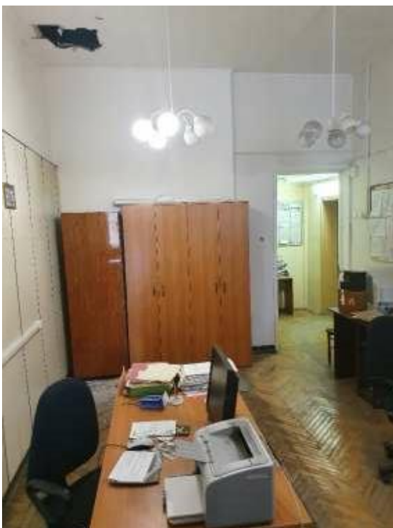
10. «Здание Коммерческого училища (с оградой)», ул. Ломоносова, д. 9, лит. А. Помещение №201. Общий вид. Фото 01.12.2020 г.
