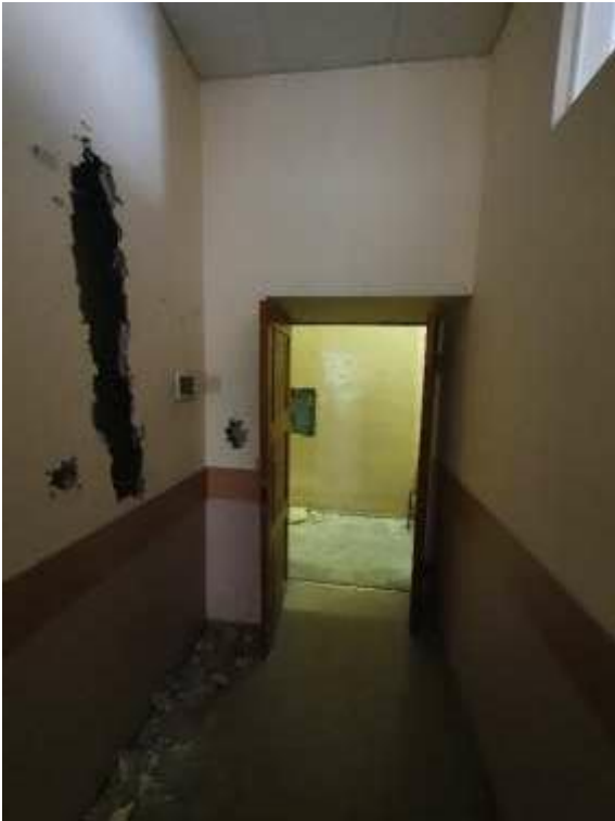
35. «Здание Коммерческого училища (с оградой)», ул. Ломоносова, д. 9, лит. А. Помещение №204. Фрагмент. Фото 01.12.2020 г.
