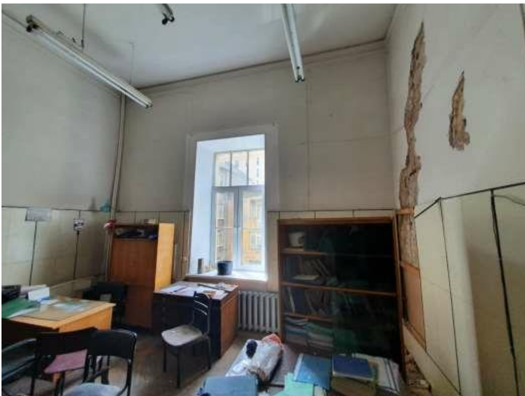
70. «Здание Коммерческого училища (с оградой)», ул. Ломоносова, д. 9, лит. А. Помещение №207. Фрагмент. Фото 01.12.2020 г.
