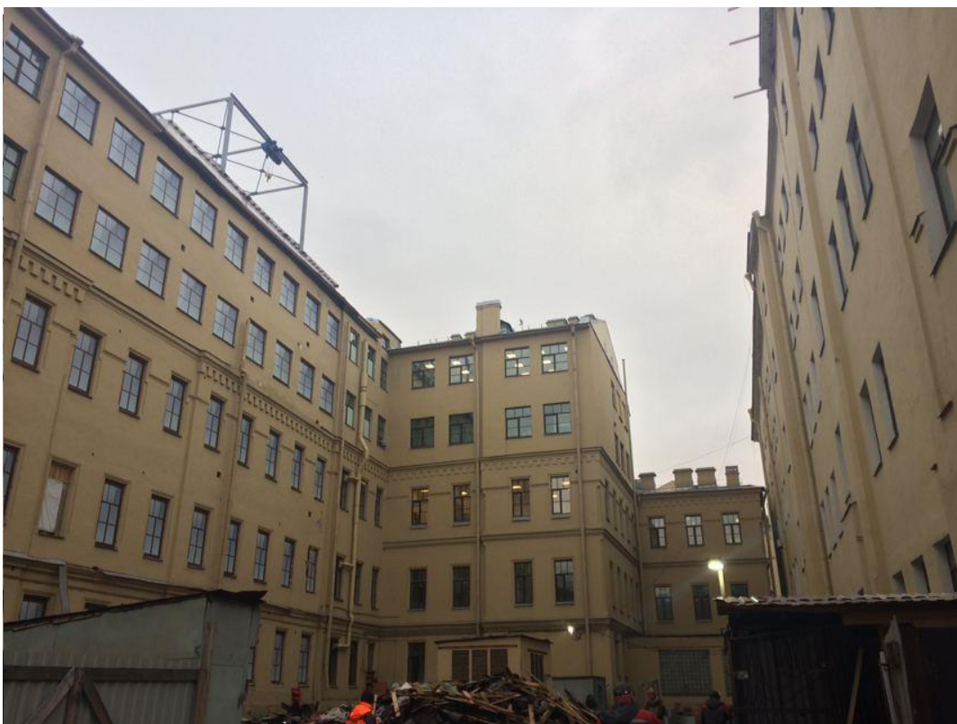
2. «Здание Коммерческого училища (с оградой)», ул. Ломоносова, д. 9, лит. А. Дворовый фасад. Общий вид. Фото 01.12.2020 г.
