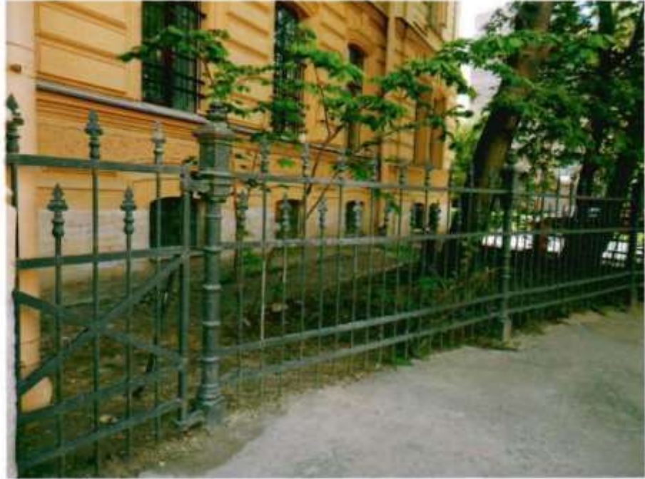
15. Северо-западная часть ограды
