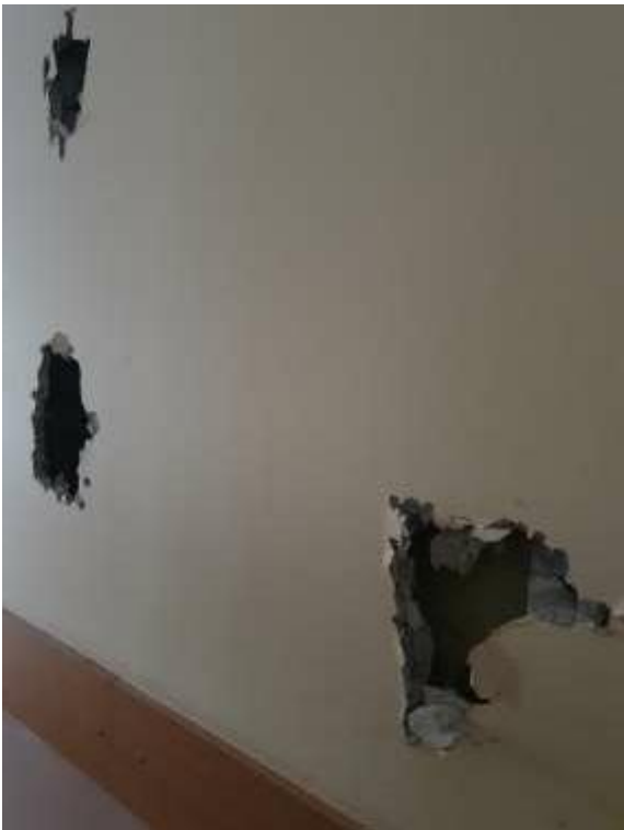
38. «Здание Коммерческого училища (с оградой)», ул. Ломоносова, д. 9, лит. А. Помещение №204. Фрагмент. Фото 01.12.2020 г.
