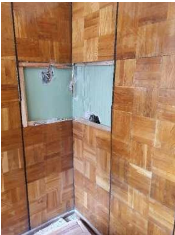
18. «Здание Коммерческого училища (с оградой)», ул. Ломоносова, д. 9, лит. А. Помещение №203. Фрагмент. Фото 01.12.2020 г.
