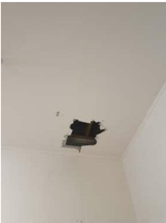
13. «Здание Коммерческого училища (с оградой)», ул. Ломоносова, д. 9, лит. А. Помещение №201. Фрагмент. Фото 01.12.2020 г.
