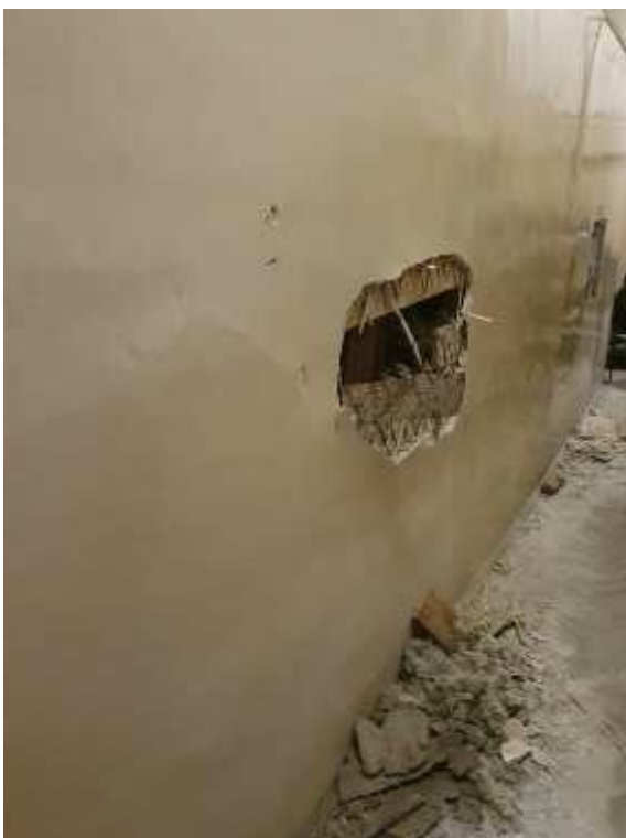
28. «Здание Коммерческого училища (с оградой)», ул. Ломоносова, д. 9, лит. А. Помещение №204. Фрагмент. Фото 01.12.2020 г.
