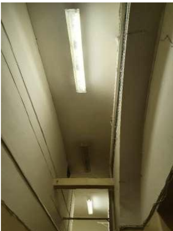
26. «Здание Коммерческого училища (с оградой)», ул. Ломоносова, д. 9, лит. А. Помещение №204. Фрагмент. Фото 01.12.2020 г.
