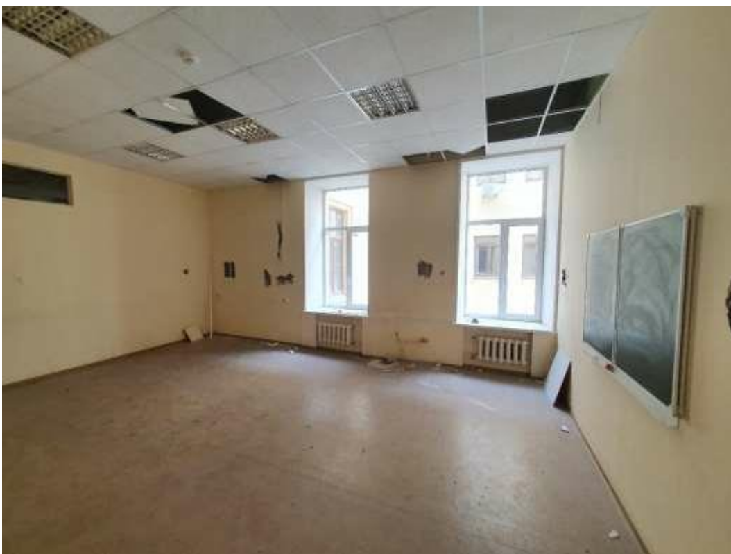
44. «Здание Коммерческого училища (с оградой)», ул. Ломоносова, д. 9, лит. А. Помещение №205. Общий вид. Фото 01.12.2020 г.
