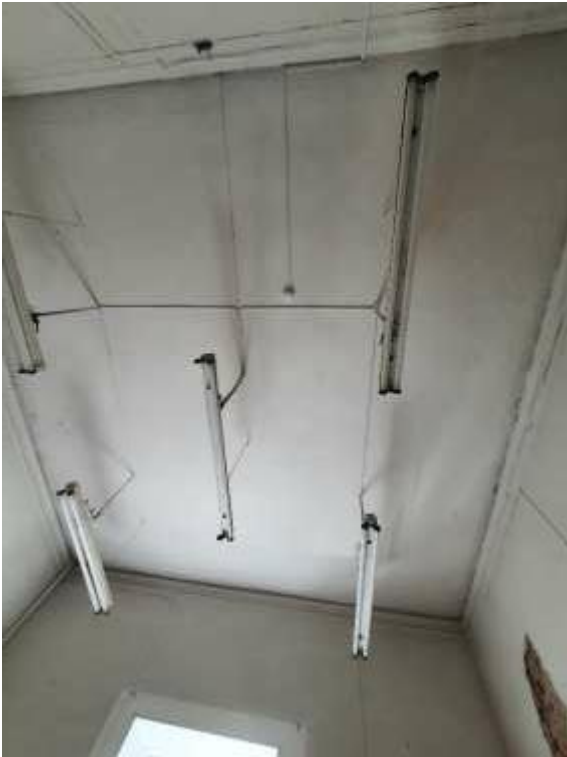
67. «Здание Коммерческого училища (с оградой)», ул. Ломоносова, д. 9, лит. А. Помещение №207. Фрагмент. Фото 01.12.2020 г.
