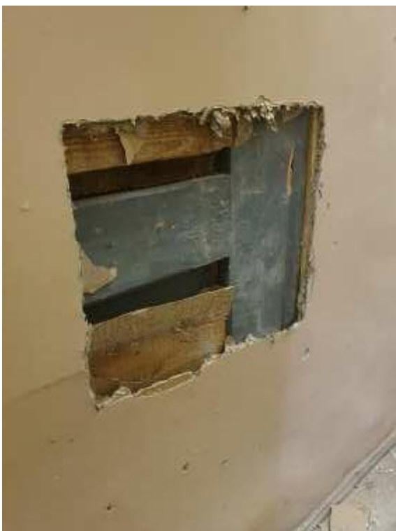
32. «Здание Коммерческого училища (с оградой)», ул. Ломоносова, д. 9, лит. А. Помещение №204. Фрагмент. Фото 01.12.2020 г.
