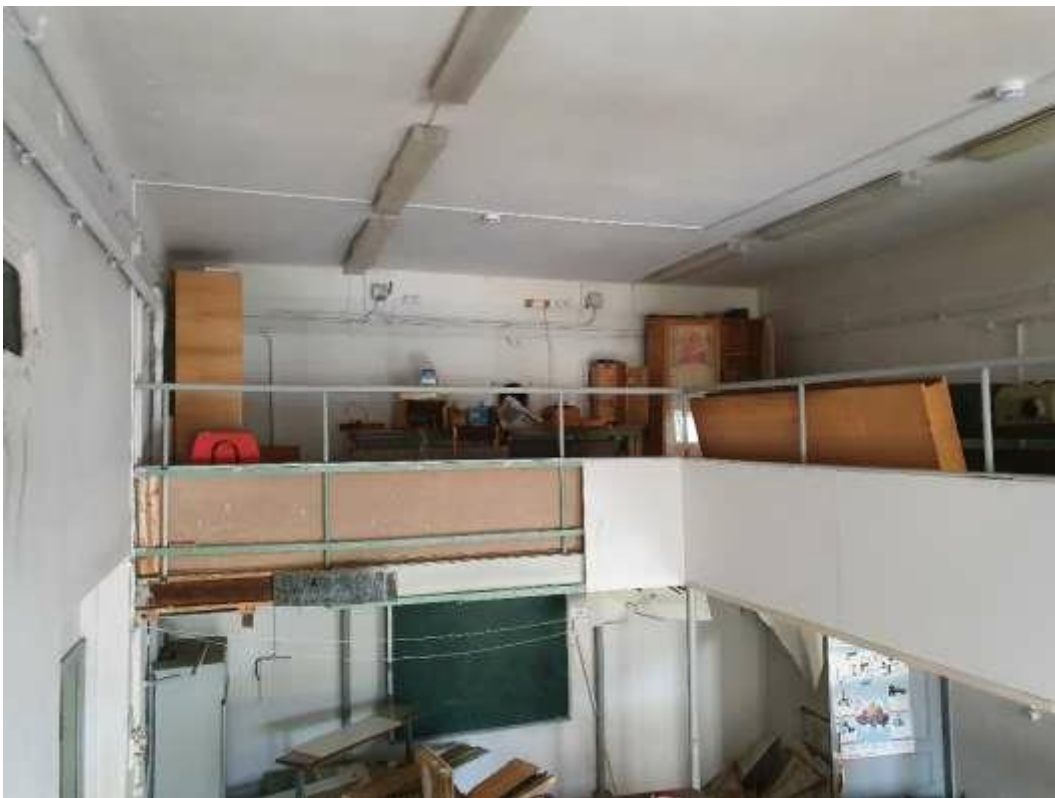
57. «Здание Коммерческого училища (с оградой)», ул. Ломоносова, д. 9, лит. А. Помещение №211. Общий вид. Фото 01.12.2020 г.
