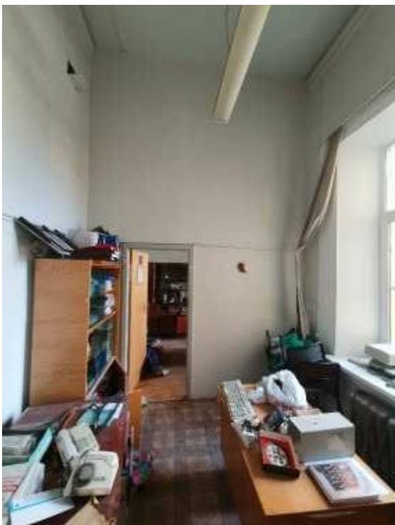
89. «Здание Коммерческого училища (с оградой)», ул. Ломоносова, д. 9, лит. А. Помещение №206. Общий вид. Фото 01.12.2020 г.
