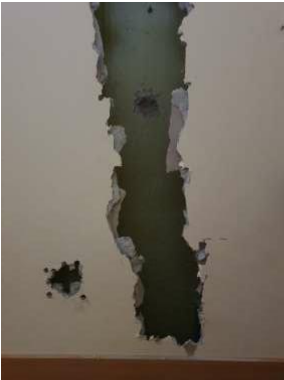
36. «Здание Коммерческого училища (с оградой)», ул. Ломоносова, д. 9, лит. А. Помещение №204. Фрагмент. Фото 01.12.2020 г.
