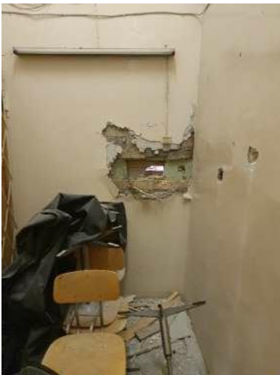
33. «Здание Коммерческого училища (с оградой)», ул. Ломоносова, д. 9, лит. А. Помещение №204. Фрагмент. Фото 01.12.2020 г.
