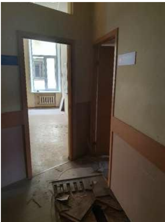
41. «Здание Коммерческого училища (с оградой)», ул. Ломоносова, д. 9, лит. А. Помещение №204. Фрагмент. Фото 01.12.2020 г.
