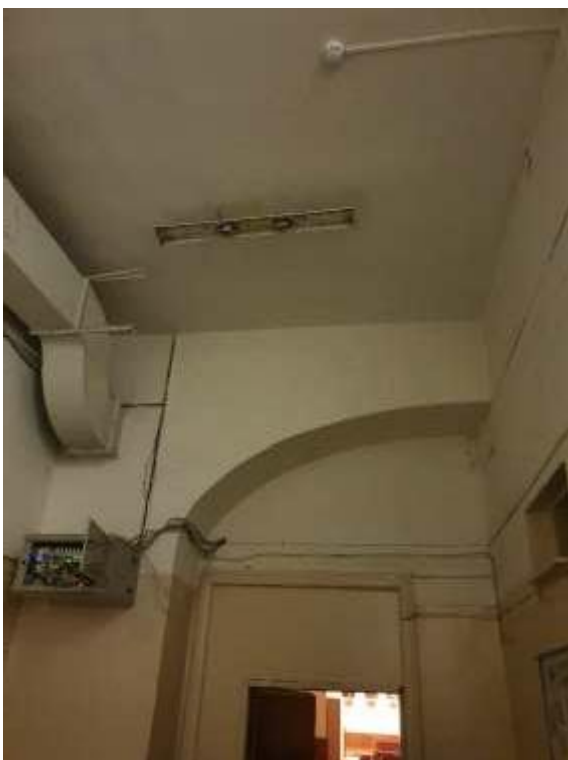
24. «Здание Коммерческого училища (с оградой)», ул. Ломоносова, д. 9, лит. А. Помещение №204. Фрагмент. Фото 01.12.2020 г.
