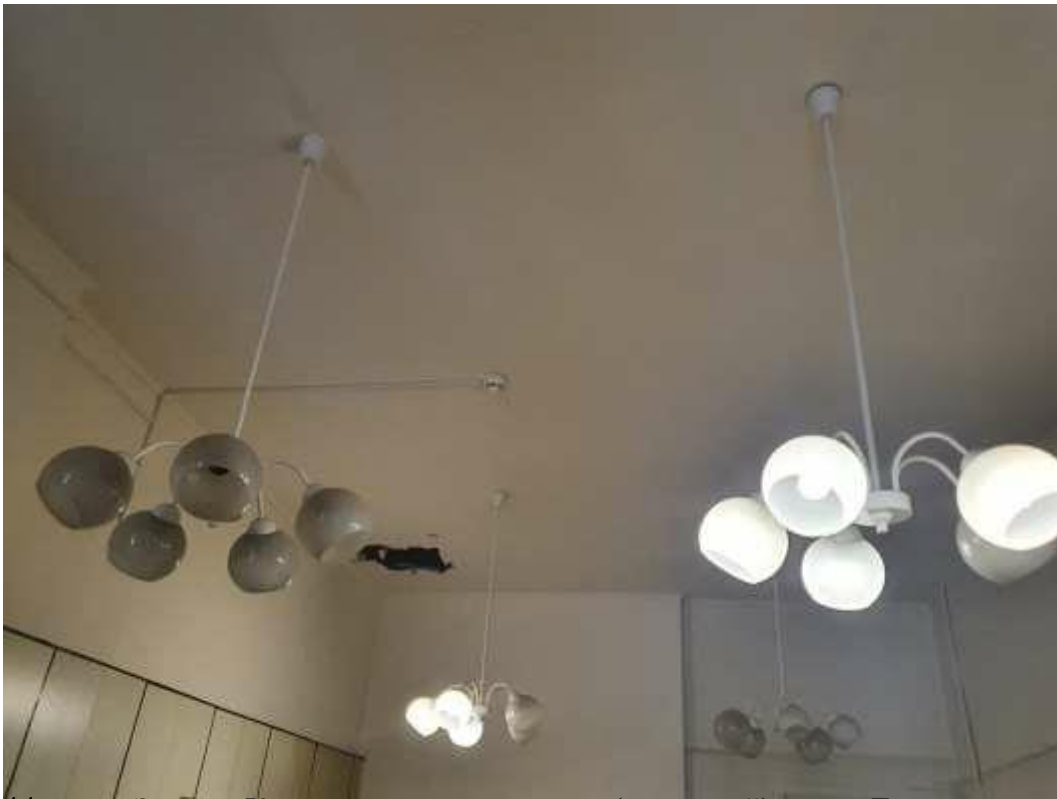
11. «Здание Коммерческого училища (с оградой)», ул. Ломоносова, д. 9, лит. А. Помещение №201. Фрагмент. Фото 01.12.2020 г.
