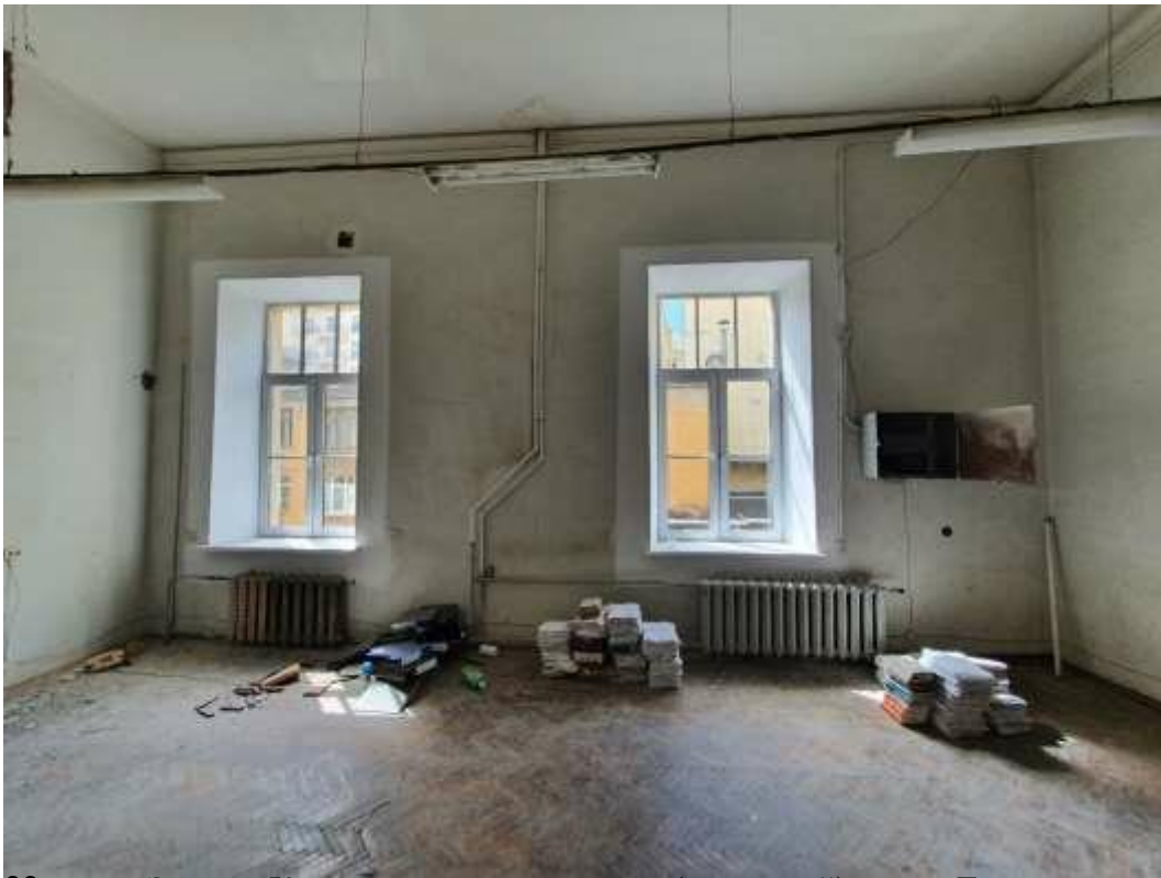
83. «Здание Коммерческого училища (с оградой)», ул. Ломоносова, д. 9, лит. А. Помещение №206. Фрагмент. Фото 01.12.2020 г.
