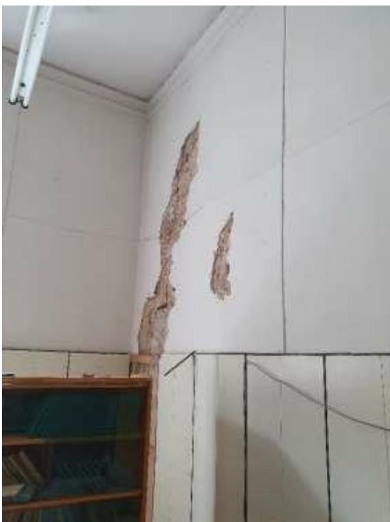
66. «Здание Коммерческого училища (с оградой)», ул. Ломоносова, д. 9, лит. А. Помещение №207. Фрагмент. Фото 01.12.2020 г.
