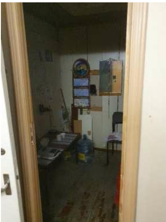
8. «Здание Коммерческого училища (с оградой)», ул. Ломоносова, д. 9, лит. А. Помещение №200. Общий вид. Фото 01.12.2020 г.
