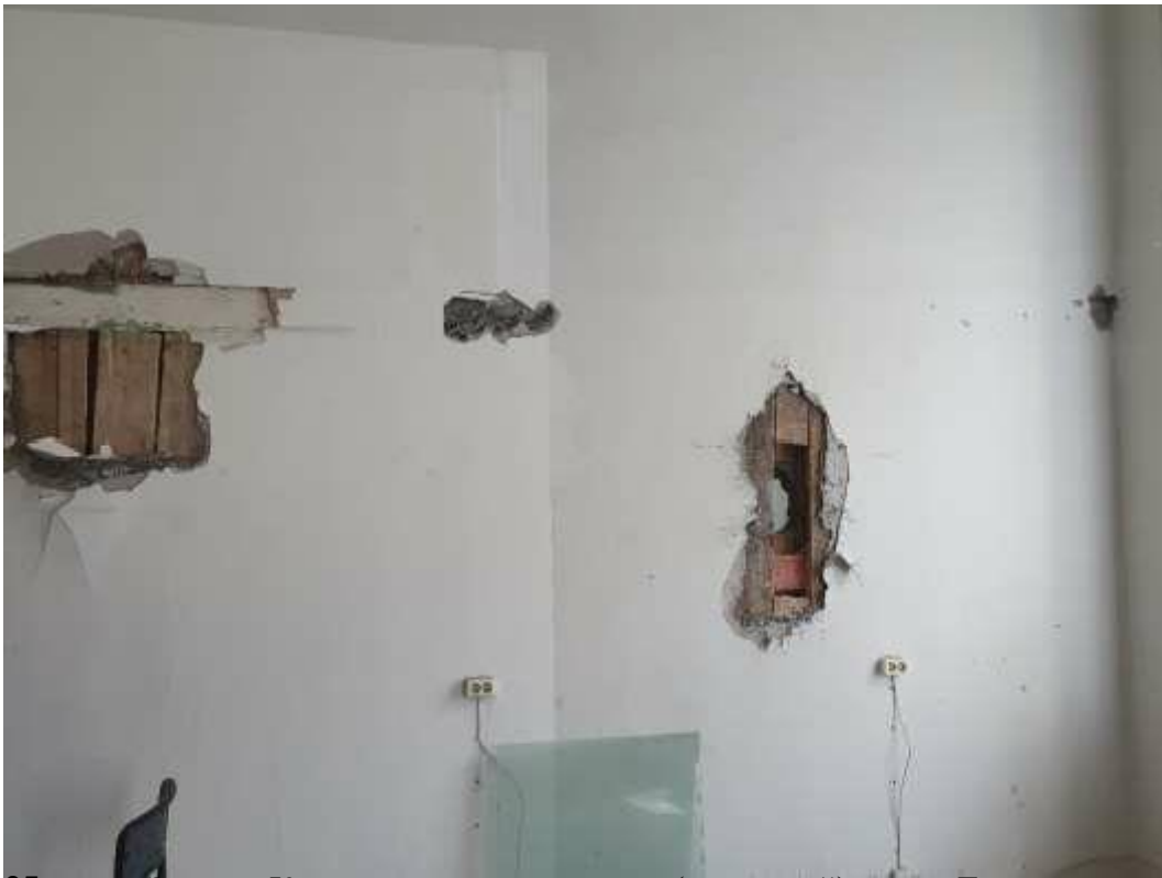
85. «Здание Коммерческого училища (с оградой)», ул. Ломоносова, д. 9, лит. А. Помещение №206. Фрагмент. Фото 01.12.2020 г.
