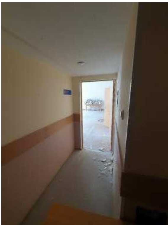
74. «Здание Коммерческого училища (с оградой)», ул. Ломоносова, д. 9, лит. А. Помещение №204. Фрагмент. Фото 01.12.2020 г.
