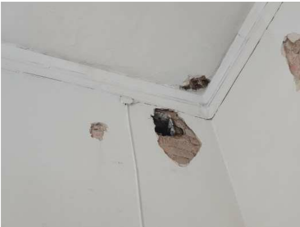
69. «Здание Коммерческого училища (с оградой)», ул. Ломоносова, д. 9, лит. А. Помещение №207. Фрагмент. Фото 01.12.2020 г.
