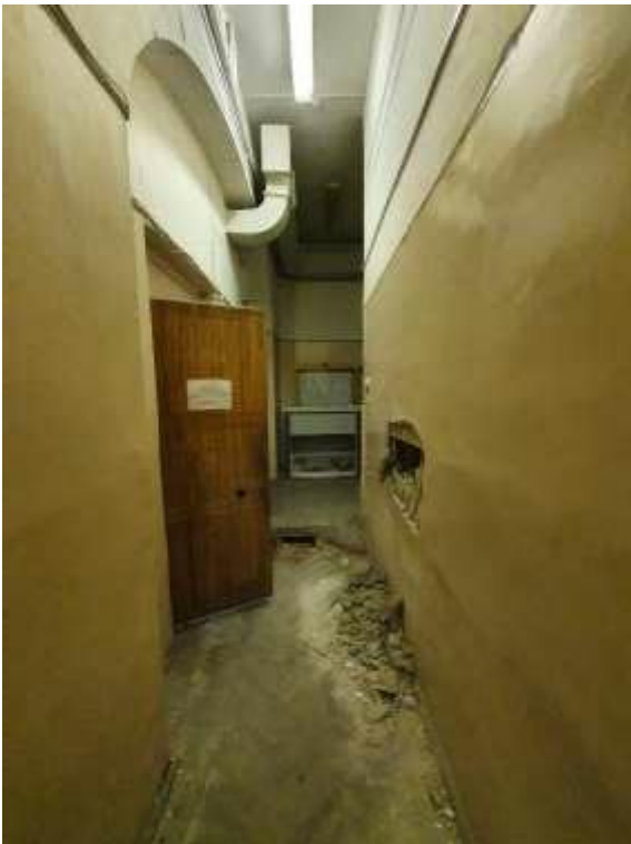
30. «Здание Коммерческого училища (с оградой)», ул. Ломоносова, д. 9, лит. А. Помещение №204. Фрагмент. Фото 01.12.2020 г.
