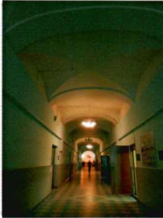
11. Коридор 2-го этажа
