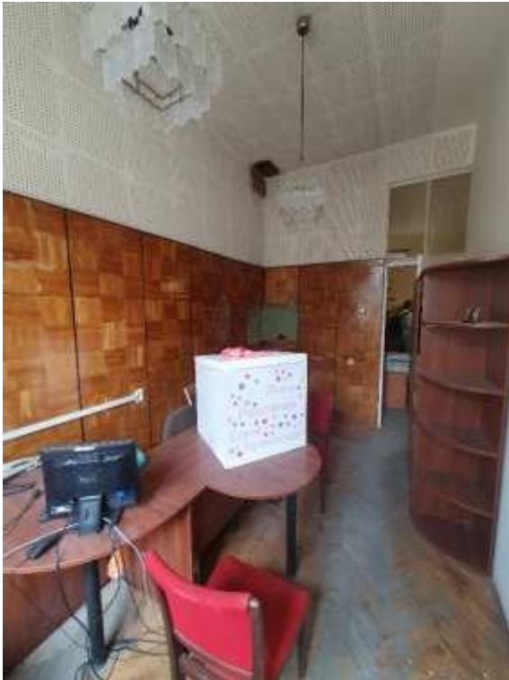
17. «Здание Коммерческого училища (с оградой)», ул. Ломоносова, д. 9, лит. А. Помещение №203. Фрагмент. Фото 01.12.2020 г.
