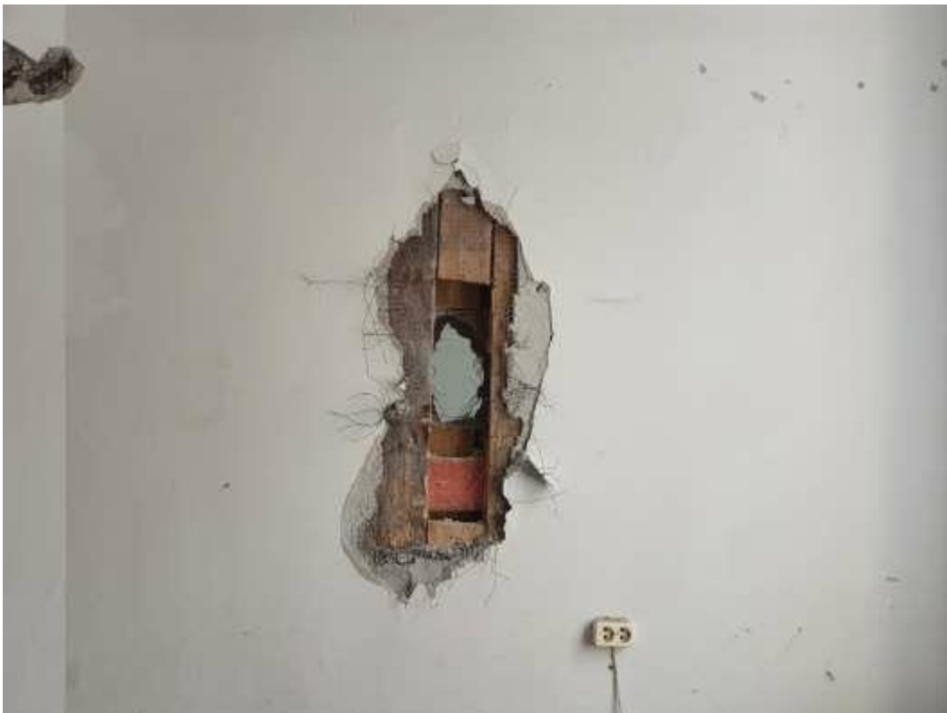
86. «Здание Коммерческого училища (с оградой)», ул. Ломоносова, д. 9, лит. А. Помещение №206. Фрагмент. Фото 01.12.2020 г.
