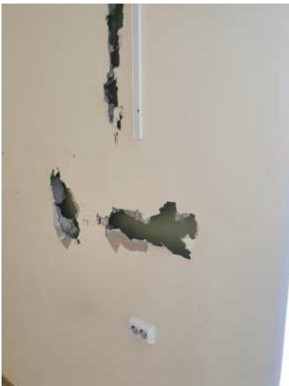
47. «Здание Коммерческого училища (с оградой)», ул. Ломоносова, д. 9, лит. А. Помещение №205. Фрагмент. Фото 01.12.2020 г.
