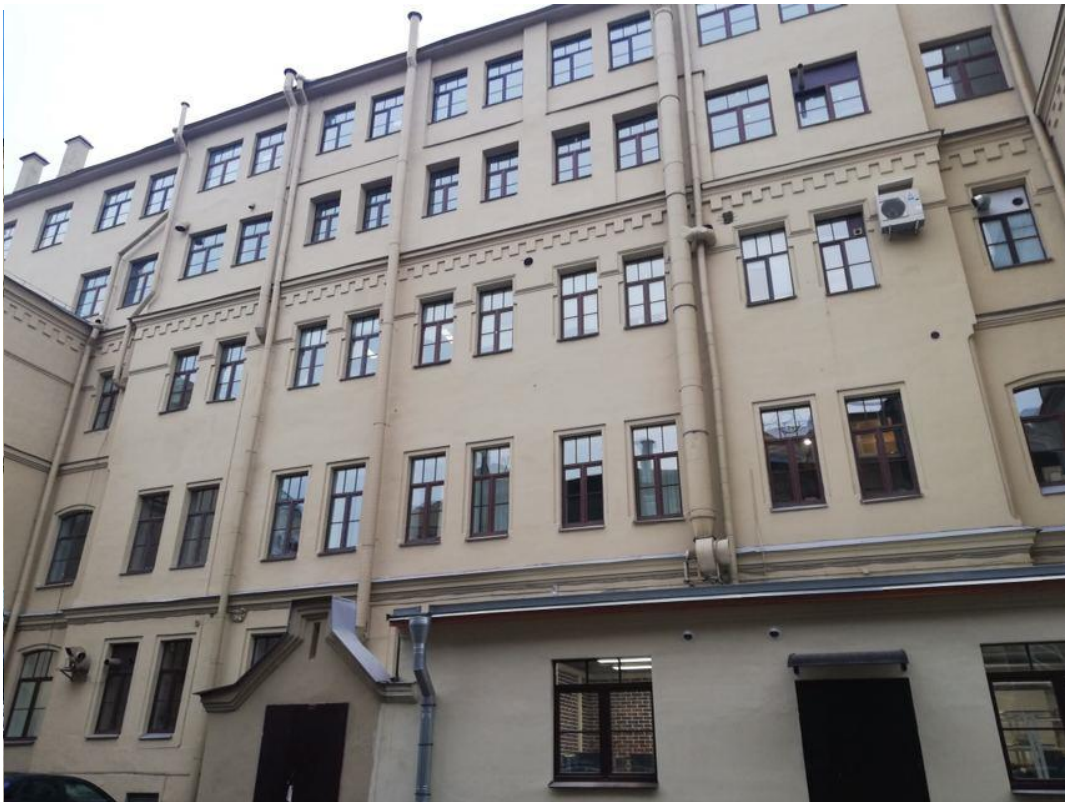
3. «Здание Коммерческого училища (с оградой)», ул. Ломоносова, д. 9, лит. А. Дворовый фасад. Общий вид. Фото 01.12.2020 г.
