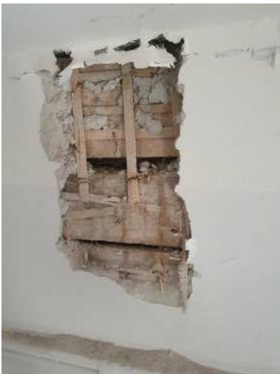
59. «Здание Коммерческого училища (с оградой)», ул. Ломоносова, д. 9, лит. А. Помещение №211. Фрагмент. Фото 01.12.2020 г.
