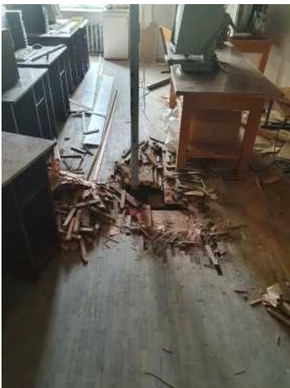
54. «Здание Коммерческого училища (с оградой)», ул. Ломоносова, д. 9, лит. А. Помещение №211. Фрагмент. Фото 01.12.2020 г.
