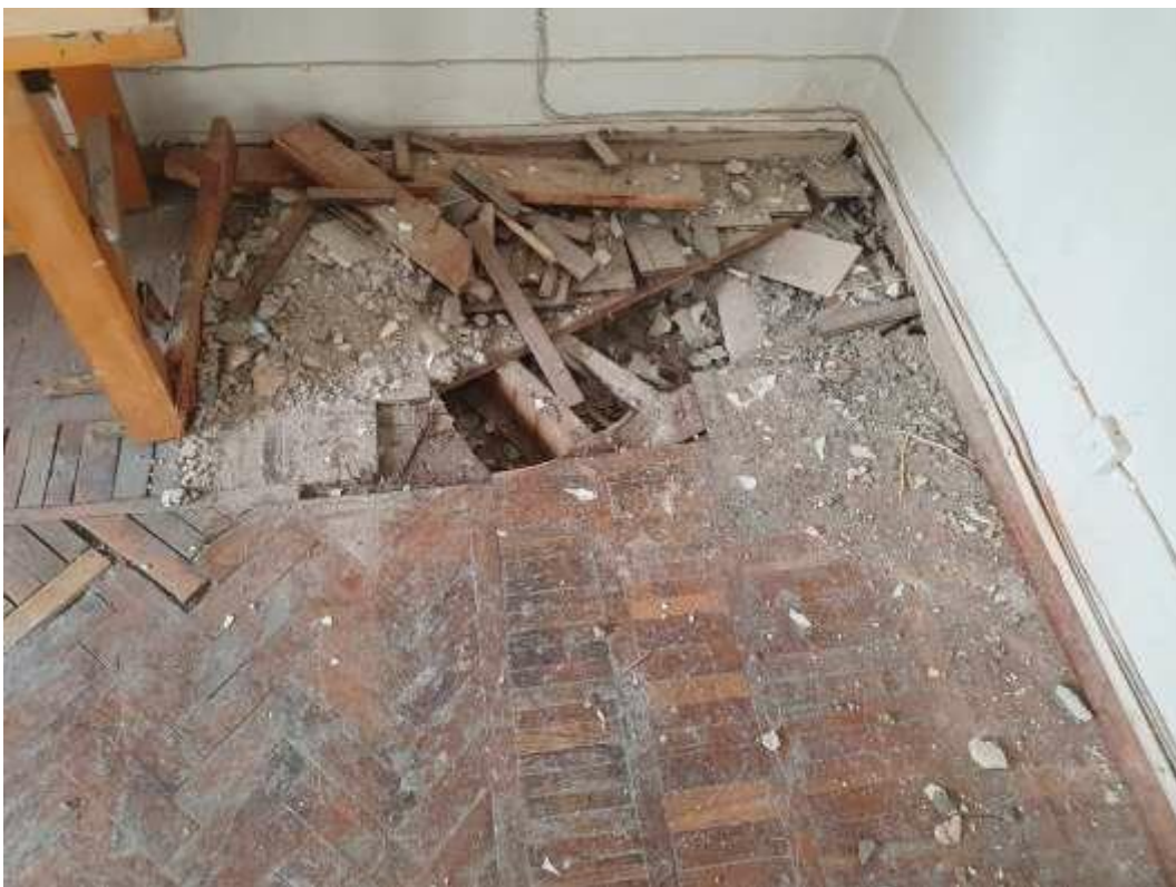
80. «Здание Коммерческого училища (с оградой)», ул. Ломоносова, д. 9, лит. А. Помещение №206. Фрагмент. Фото 01.12.2020 г.
