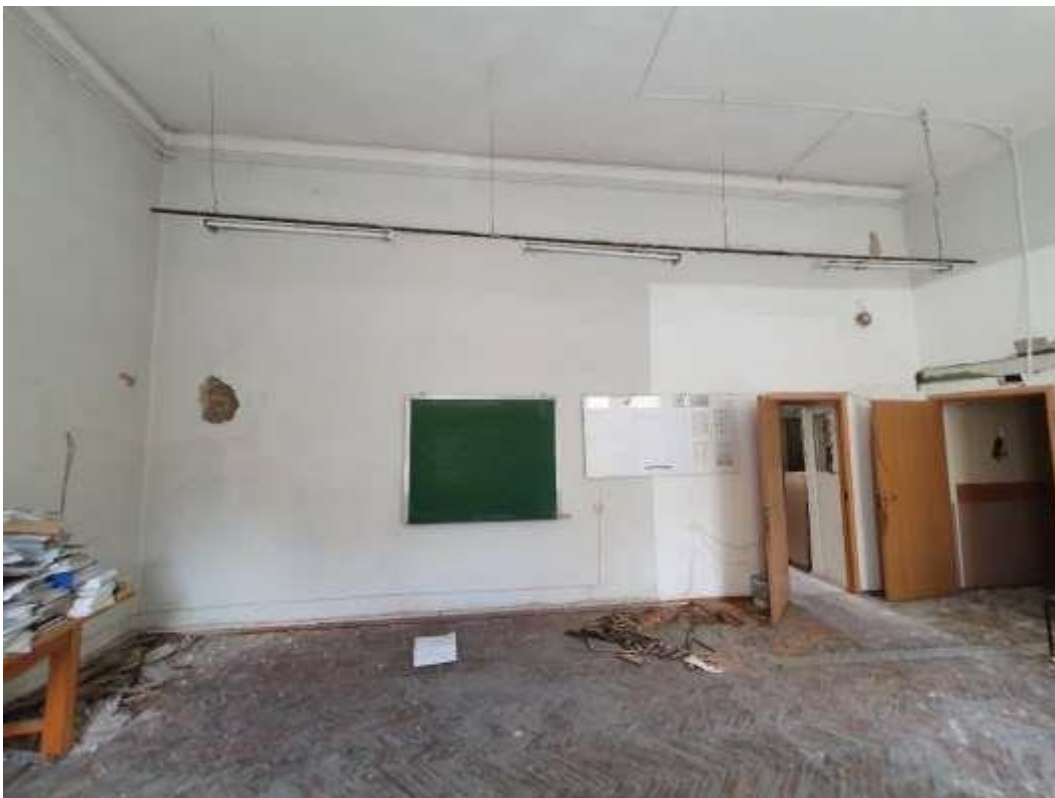
81. «Здание Коммерческого училища (с оградой)», ул. Ломоносова, д. 9, лит. А. Помещение №206. Фрагмент. Фото 01.12.2020 г.
