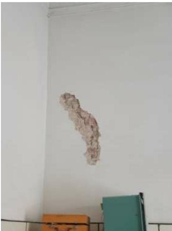
65. «Здание Коммерческого училища (с оградой)», ул. Ломоносова, д. 9, лит. А. Помещение №207. Фрагмент. Фото 01.12.2020 г.
