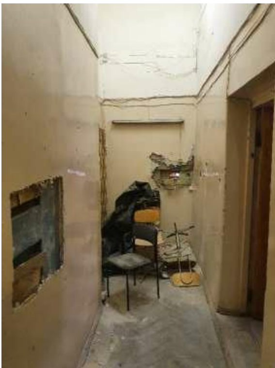
31. «Здание Коммерческого училища (с оградой)», ул. Ломоносова, д. 9, лит. А. Помещение №204. Фрагмент. Фото 01.12.2020 г.
