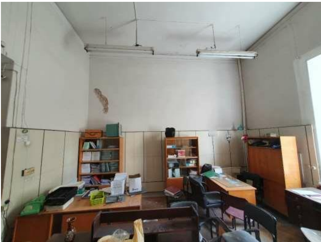
71. «Здание Коммерческого училища (с оградой)», ул. Ломоносова, д. 9, лит. А. Помещение №207. Фрагмент. Фото 01.12.2020 г.
