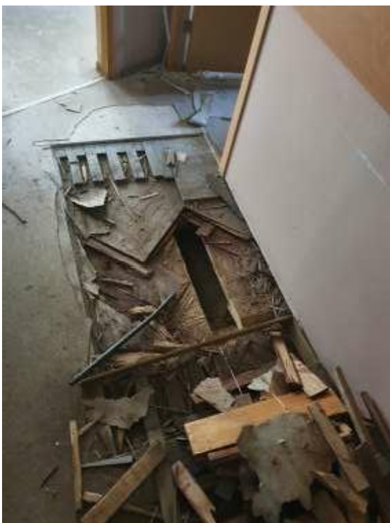
42. «Здание Коммерческого училища (с оградой)», ул. Ломоносова, д. 9, лит. А. Помещение №204. Фрагмент. Фото 01.12.2020 г.
