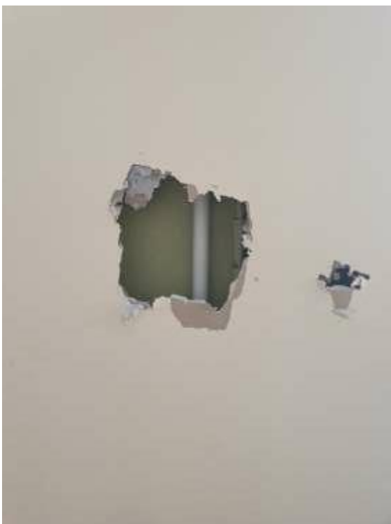
46. «Здание Коммерческого училища (с оградой)», ул. Ломоносова, д. 9, лит. А. Помещение №205. Фрагмент. Фото 01.12.2020 г.
