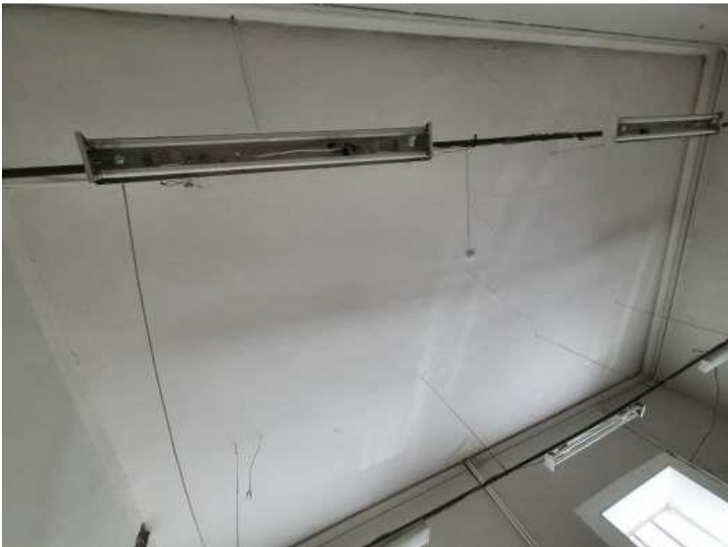
78. «Здание Коммерческого училища (с оградой)», ул. Ломоносова, д. 9, лит. А. Помещение №206. Фрагмент. Фото 01.12.2020 г.
