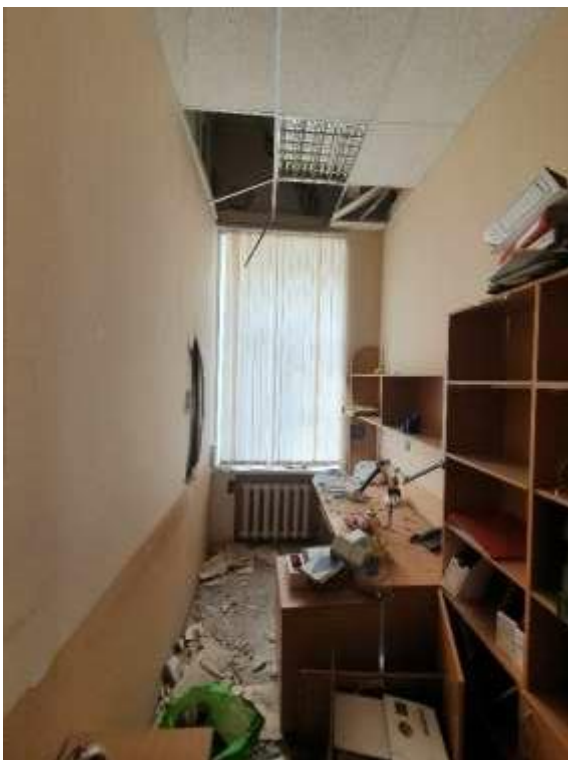
75. «Здание Коммерческого училища (с оградой)», ул. Ломоносова, д. 9, лит. А. Помещение №207. Общий вид. Фото 01.12.2020 г.
