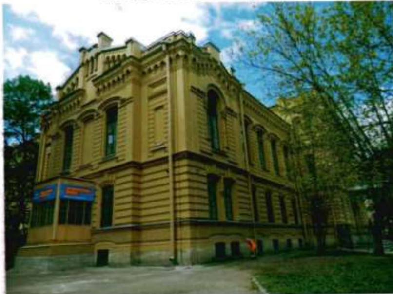
2. Северо-восточная часть фасада
