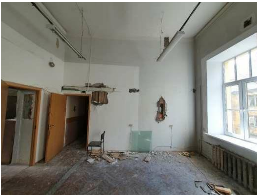
88. «Здание Коммерческого училища (с оградой)», ул. Ломоносова, д. 9, лит. А. Помещение №206. Фрагмент. Фото 01.12.2020 г.
