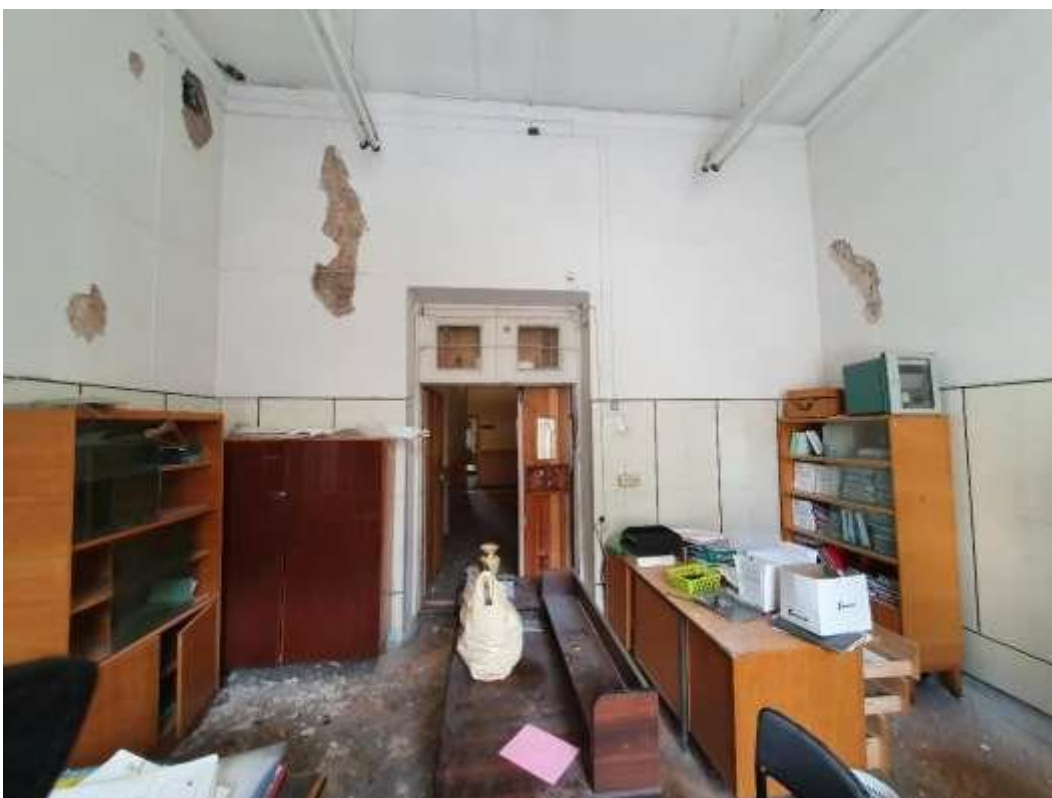
62. «Здание Коммерческого училища (с оградой)», ул. Ломоносова, д. 9, лит. А. Помещение №207. Общий вид. Фото 01.12.2020 г.
