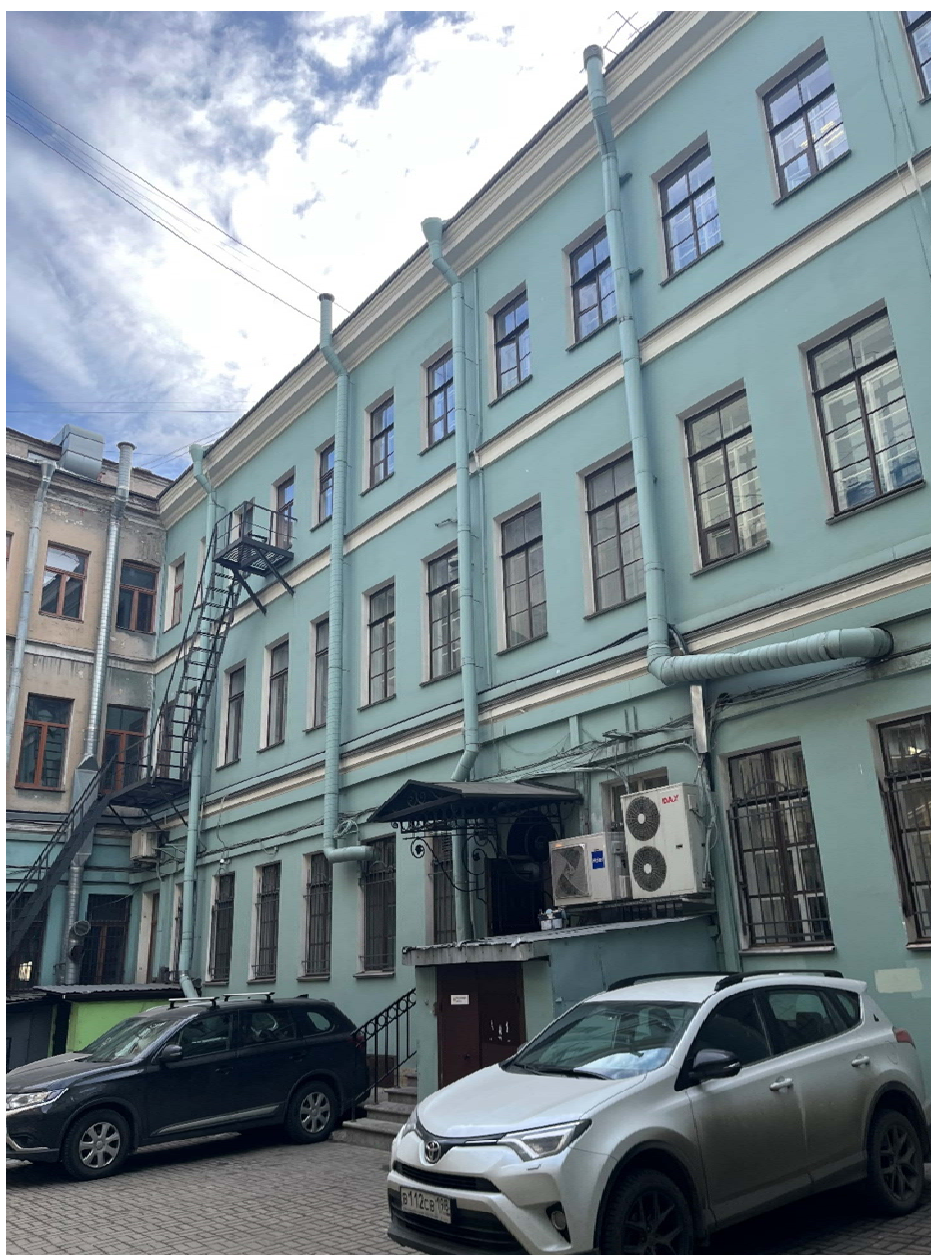
Фото №27. Дворовый (северный) фасад лицевого корпуса по Невскому пр.
