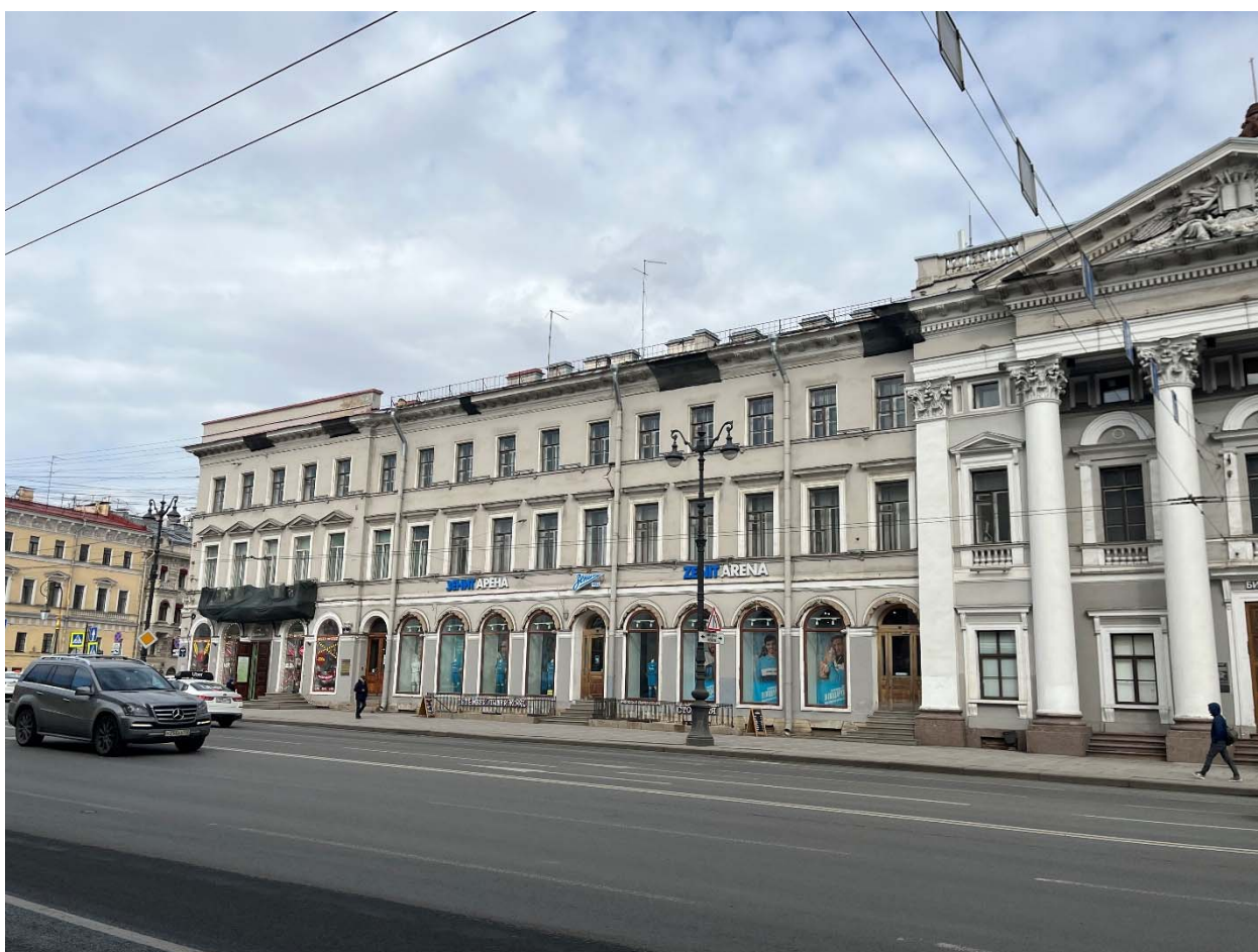
Фото №3. Лицевой (южный) фасад по Невскому пр.
