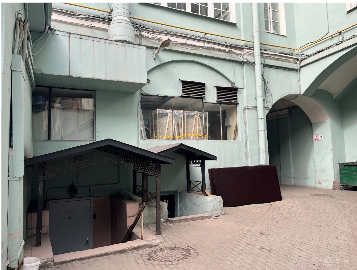
Фото №21. Дворовый (восточный) фасад лицевого корпуса по наб. р. Мойки.
