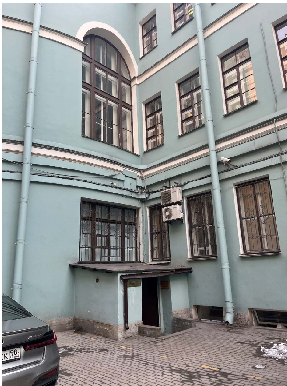
Фото №20. Дворовый (северный) фасад лицевого корпуса по Невскому пр., ротонда.
