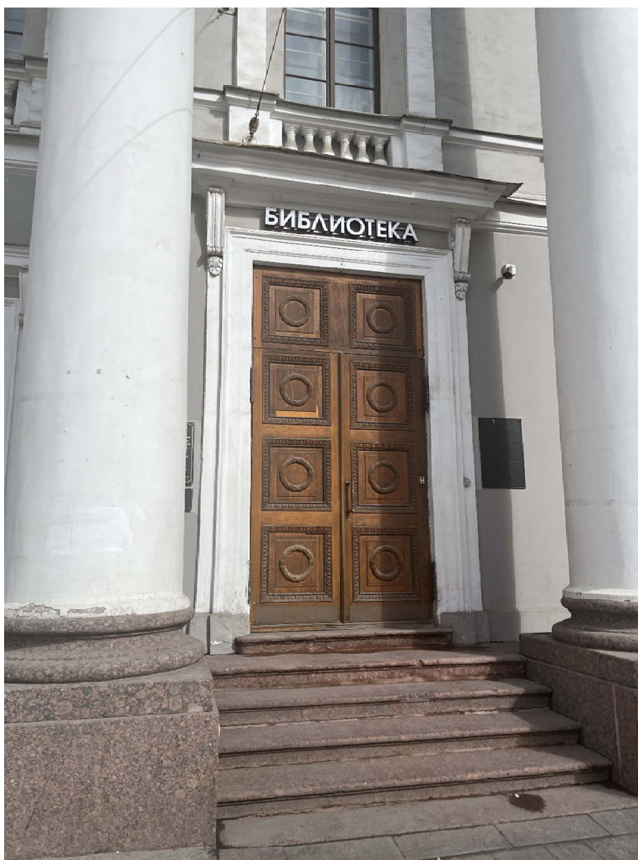
Фото №9. Лицевой (южный) фасад по Невскому пр., вход в библиотеку.
