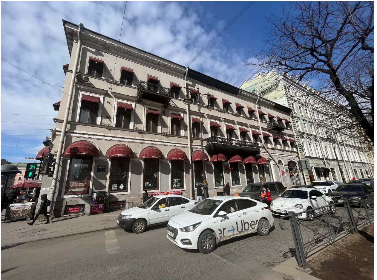
Фото №13. Лицевой (восточный) фасад по Большой Конюшенной улице.
