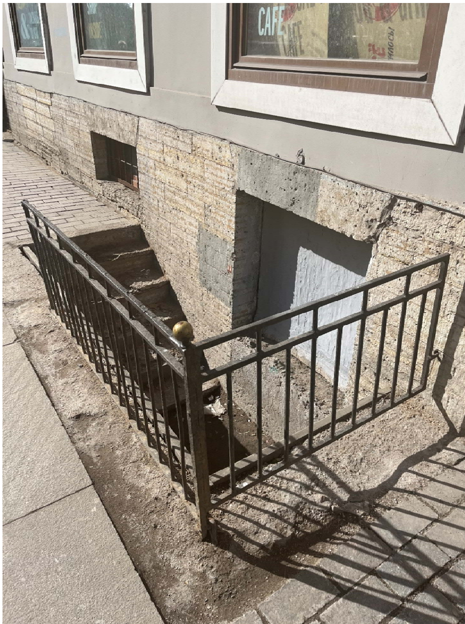
Фото №15. Лицевой (восточный) фасад по Большой Конюшенной улице, приямок.
