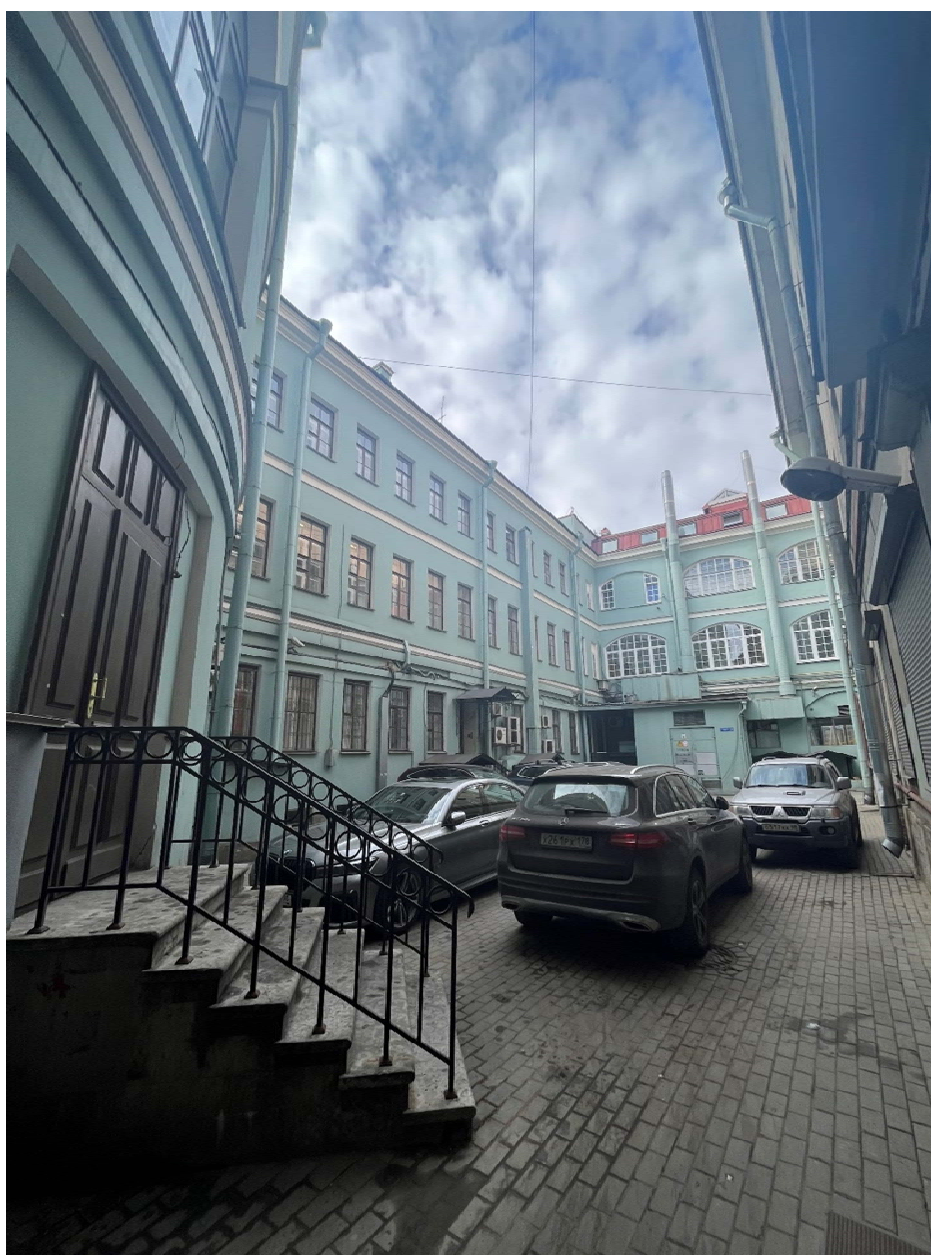
Фото №25. Дворовые фасады, вход в ротонду со стороны двора.
