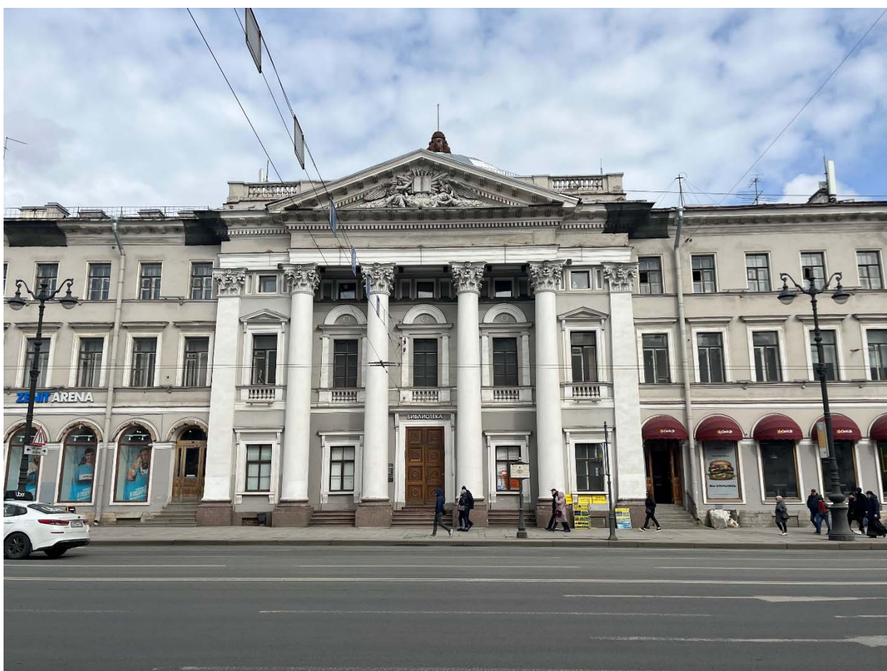
Фото №1. Лицевой (южный) фасад по Невскому пр.
