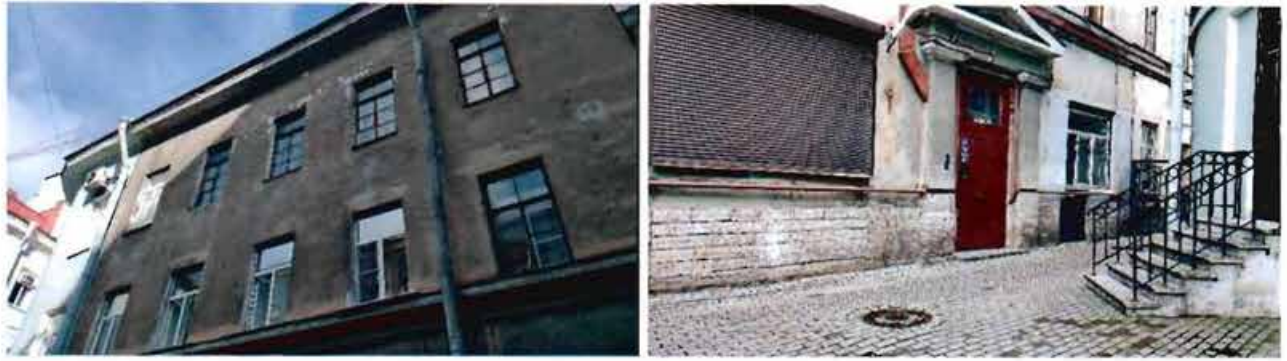
8, 9, 10. Дворовый флигель объекта культурного наследия
