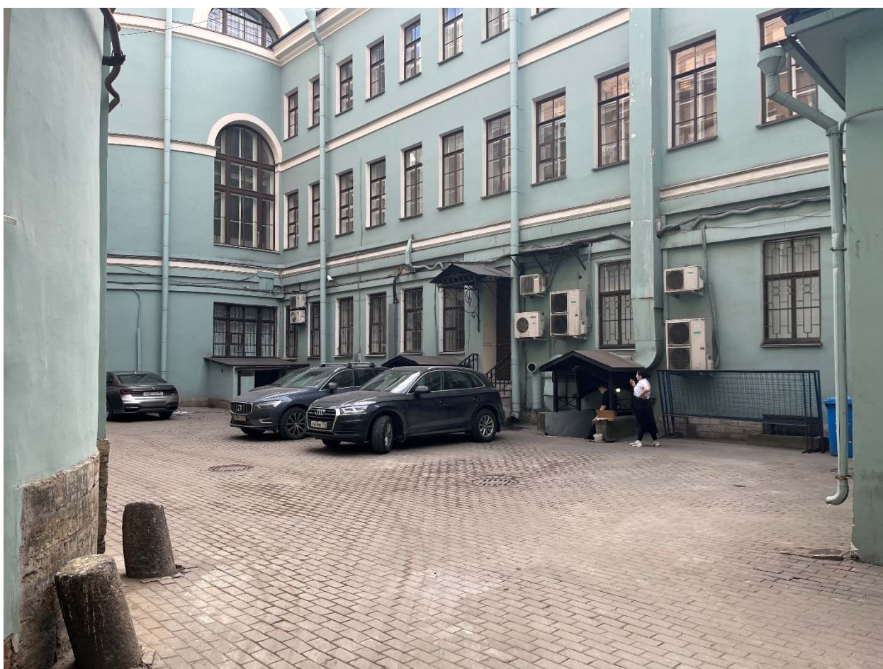
Фото №22. Дворовый (северный) фасад лицевого корпуса по Невскому пр.
