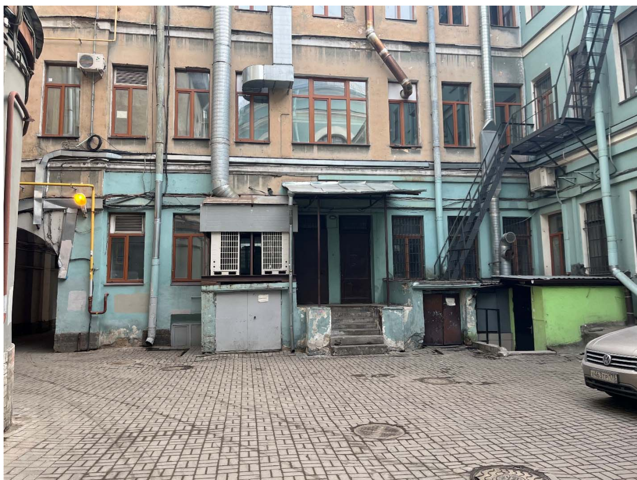
Фото №26. Дворовый (западный) фасад лицевого корпуса по ул. Большой Конюшенной.
