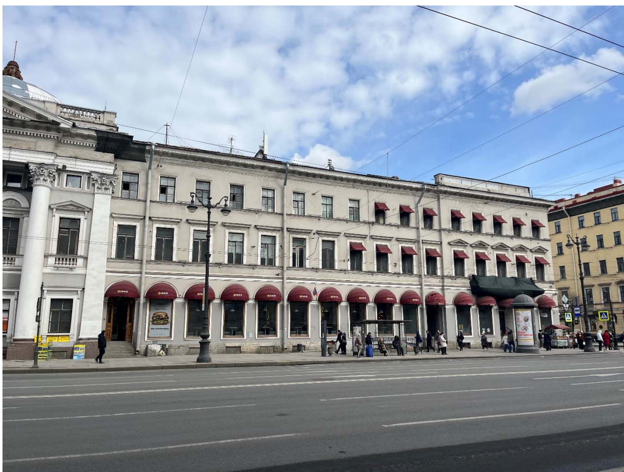
Фото №2. Лицевой (южный) фасад по Невскому пр.
