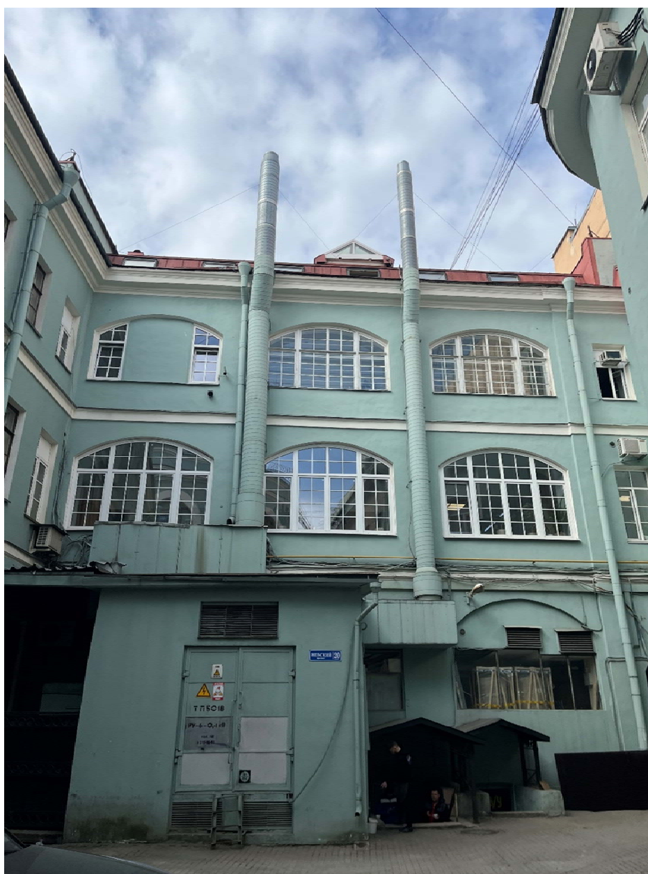
Фото №24. Дворовый (восточный) фасад лицевого корпуса по наб. р. Мойки.
