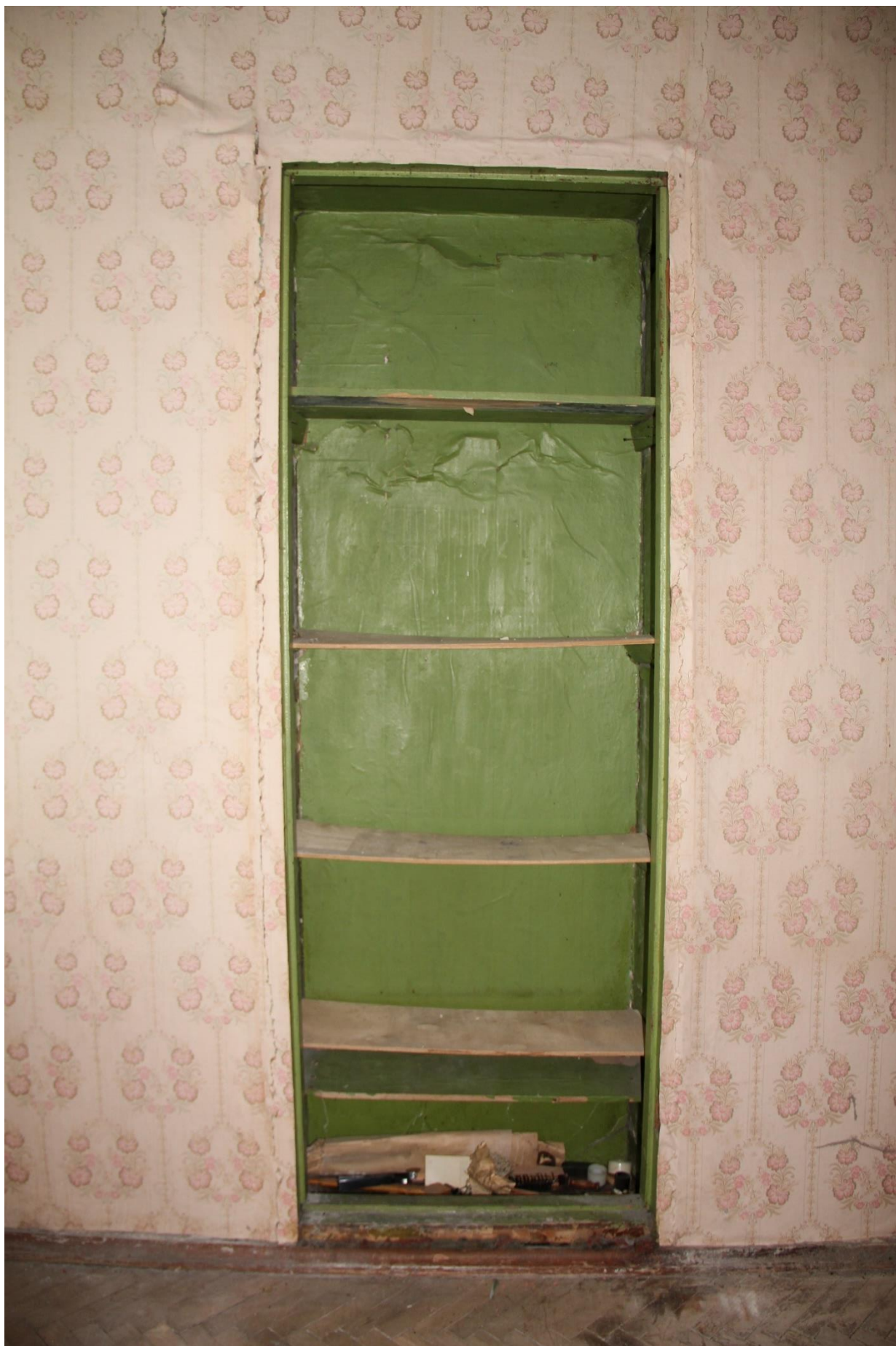
Фото 15. Ниша в помещении № 8.
