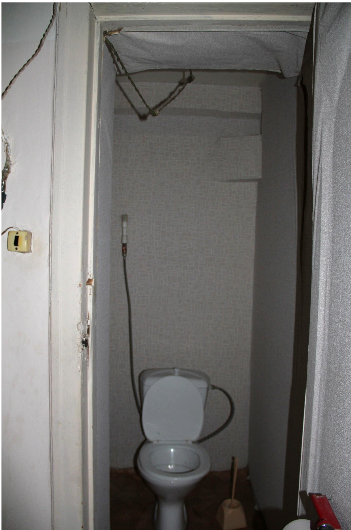
Фото 26. Вид на санузел.
