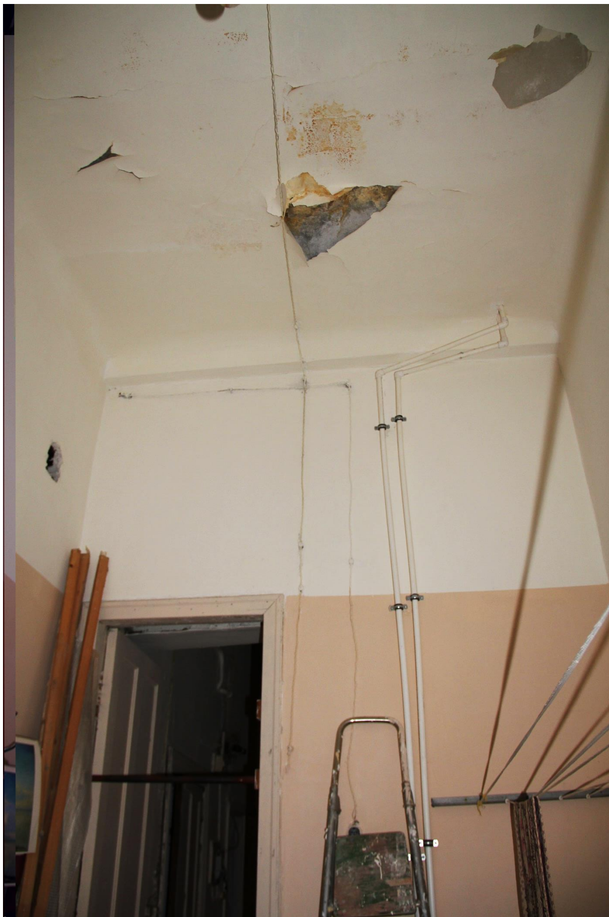
Фото 31. Вид на помещение № 13.
