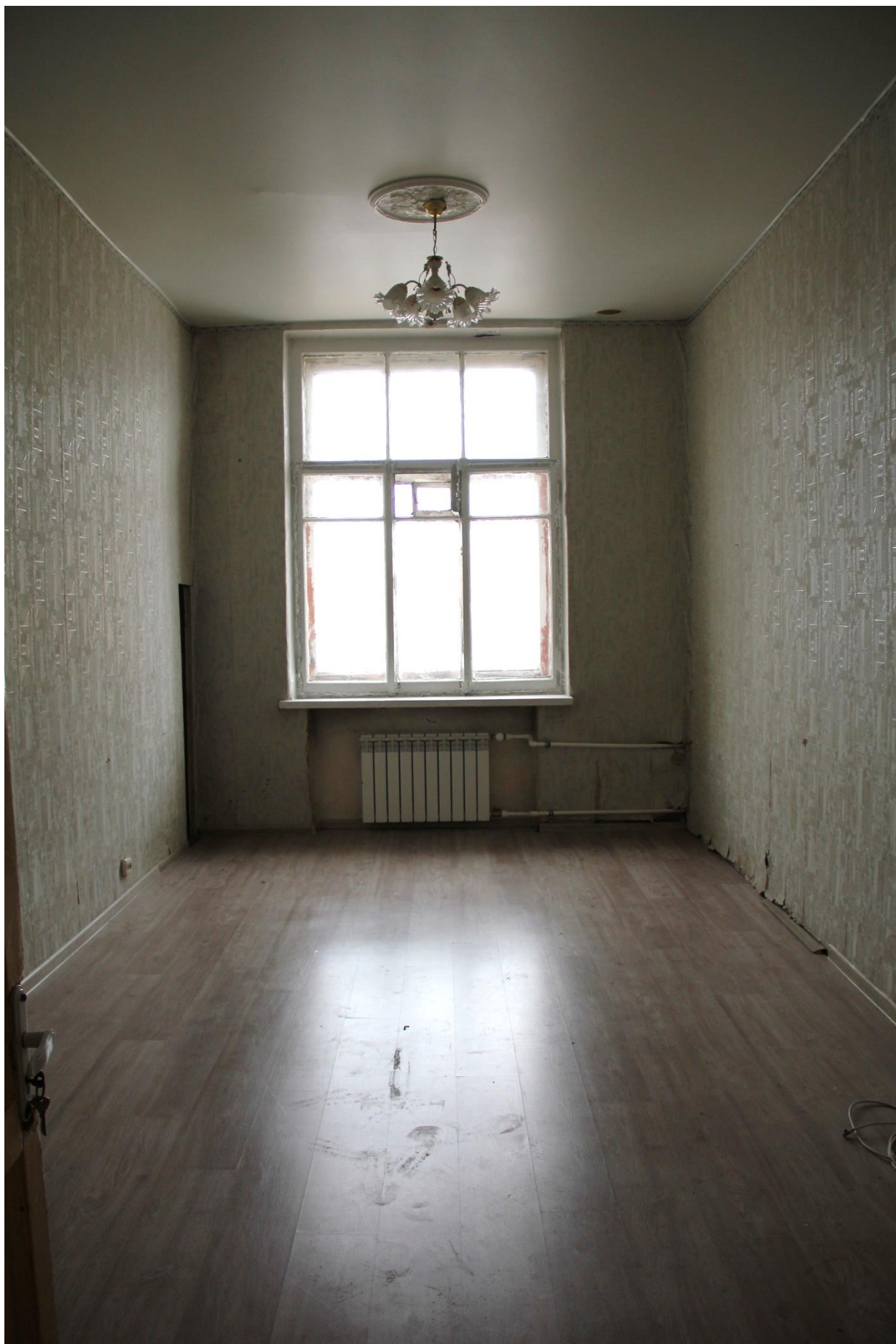
Фото 17. Вид на помещение № 9, расположенное в центральной части квартиры.
