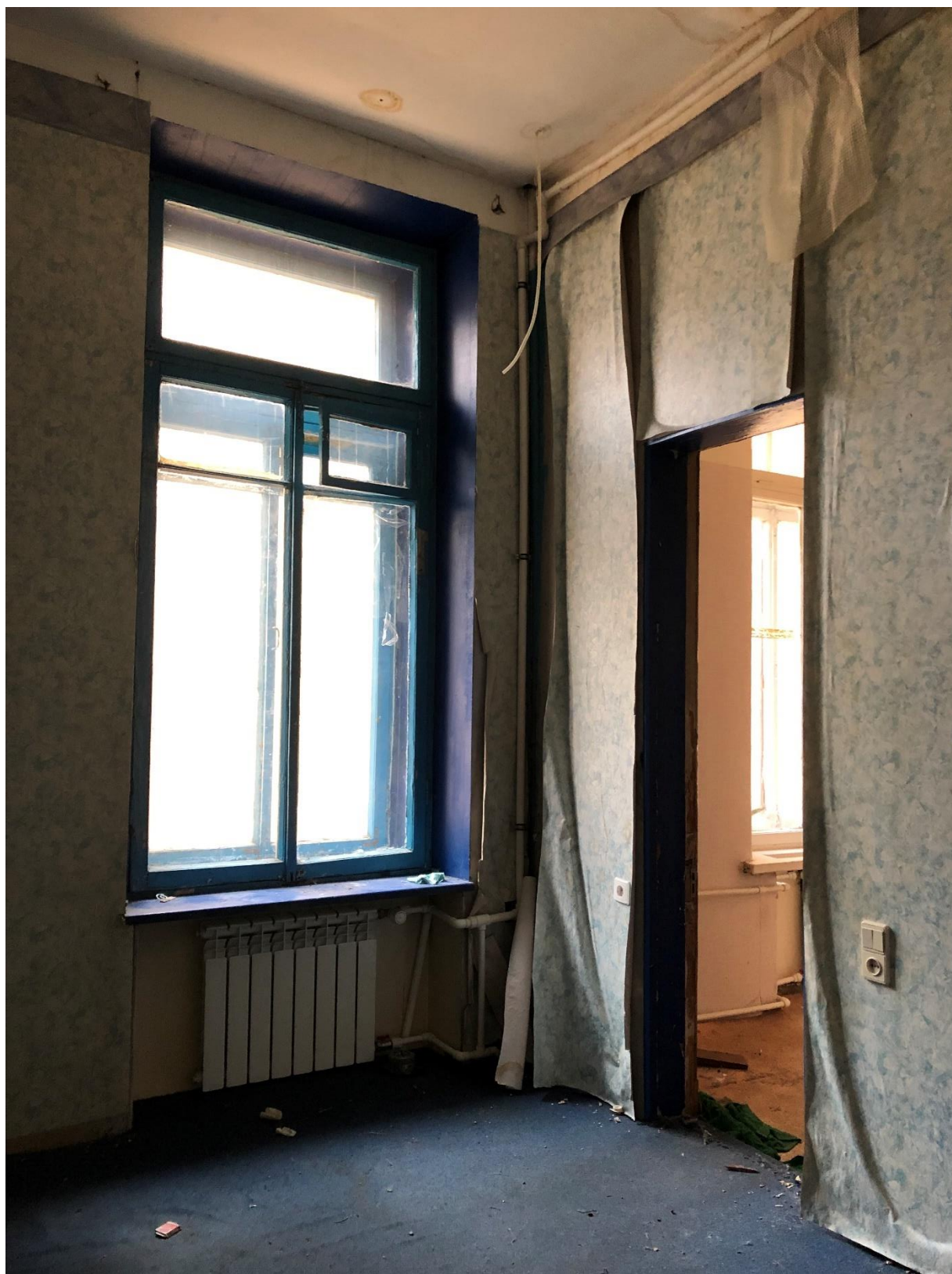
Фото 21. Вид на помещение № 6, окно выходит во двор.
