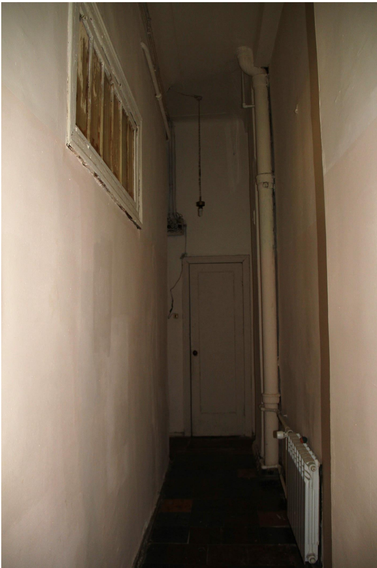
Фото 23. Вид на коридор в северной части квартиры № 35.
