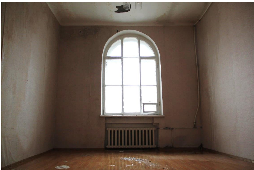
Фото 7. Вид на помещение № 3.
