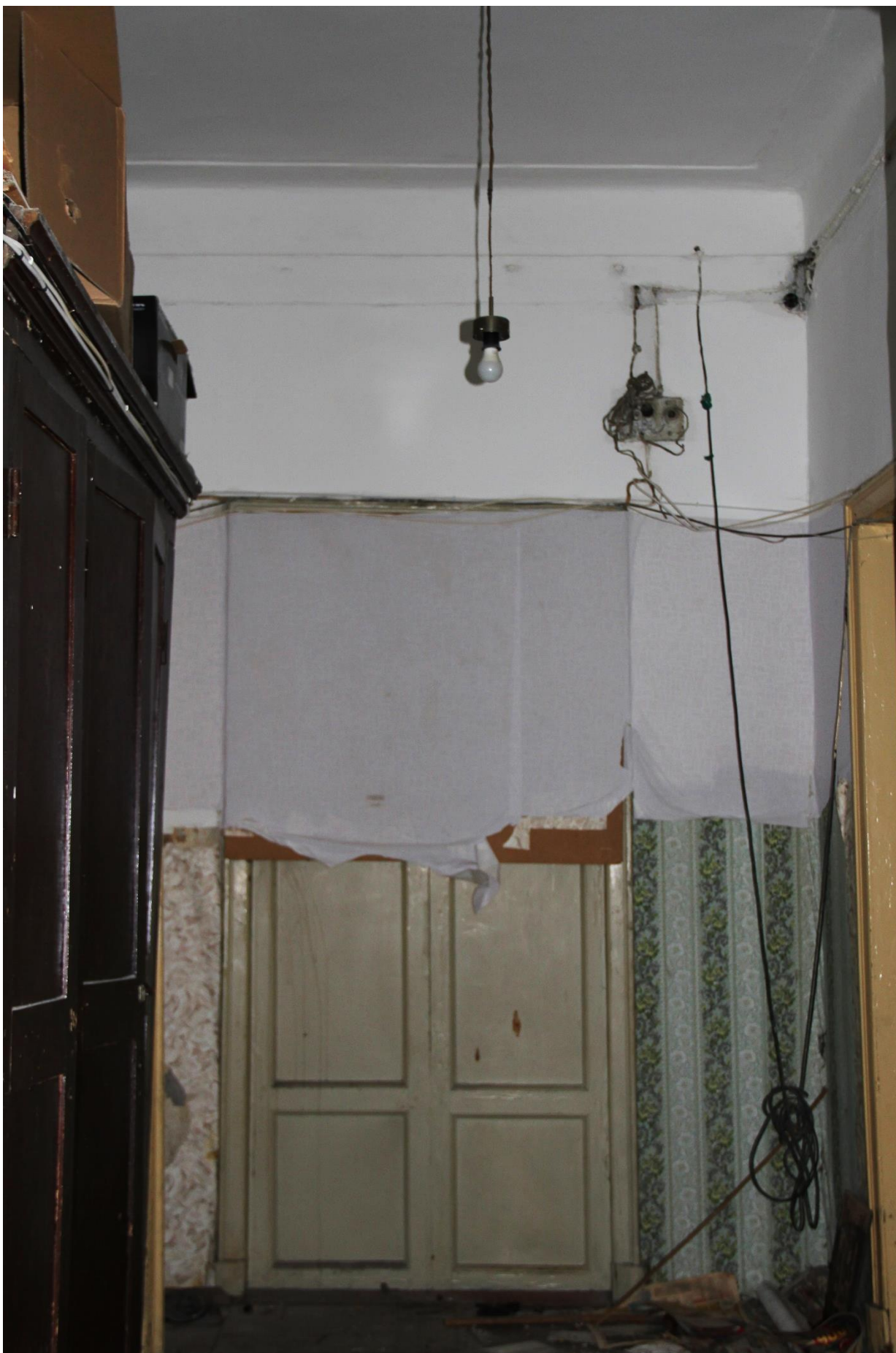
Фото 5. Дверь между помещениями № 1 и 6 со стороны прихожей.
