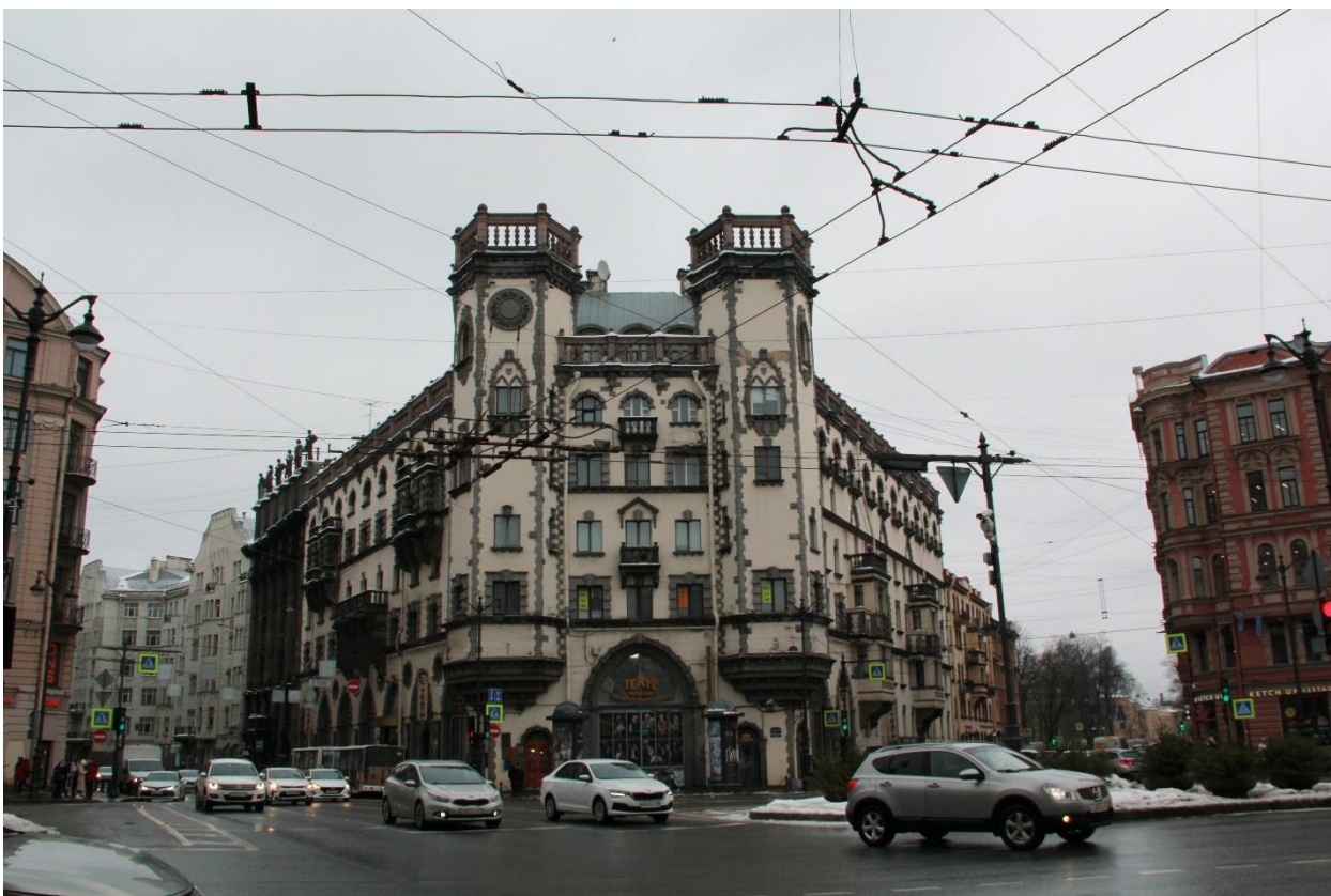
Фото 1. Вид на лицевой фасад здания по Каменноостровскому пр.
