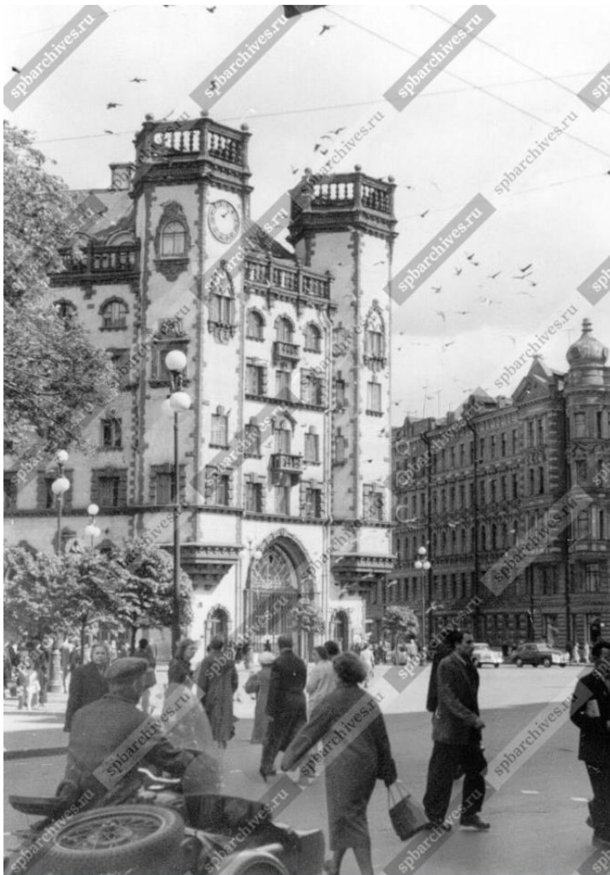
Илл. 48. Вид на лицевой фасад по Каменноостровскому проспекту. Дата: конец 1950-х – начало 1960-х гг. Источник: ЦГАКФФД СПб Ар 196931.
