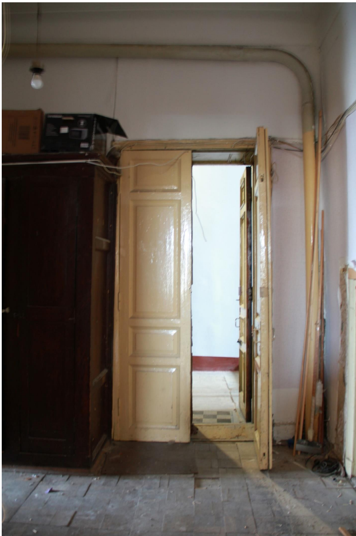
Фото 4. Вид на входную дверь квартиры № 35 со стороны прихожей.
