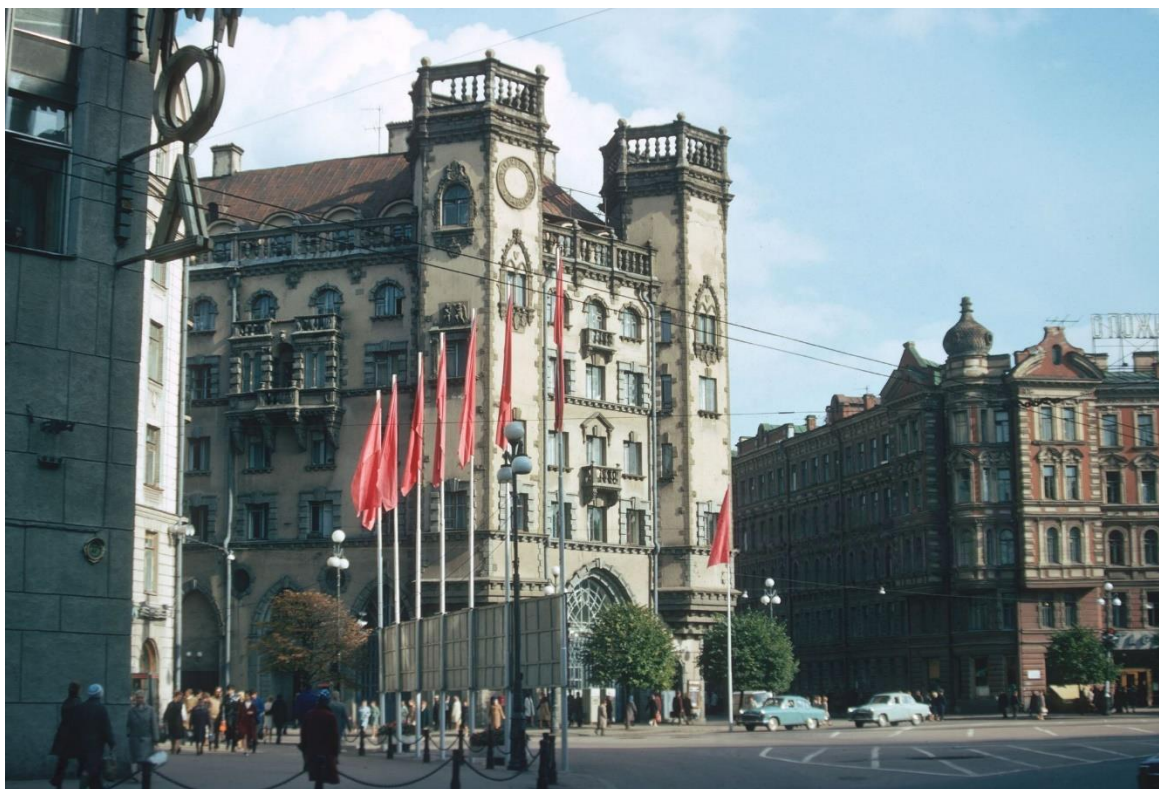
Илл. 51. Вид на лицевой фасад по Каменноостровскому проспекту с севера Каменноостровского проспекта. Дата: 1970-1973 гг. Источник: pastvu.com.
