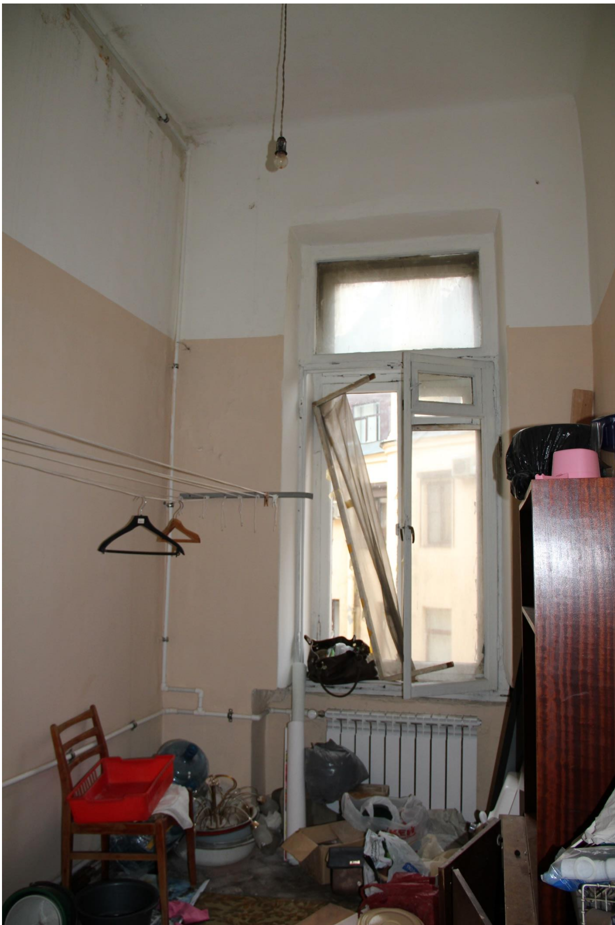
Фото 30. Вид на помещение № 13, окно выходит во двор.
