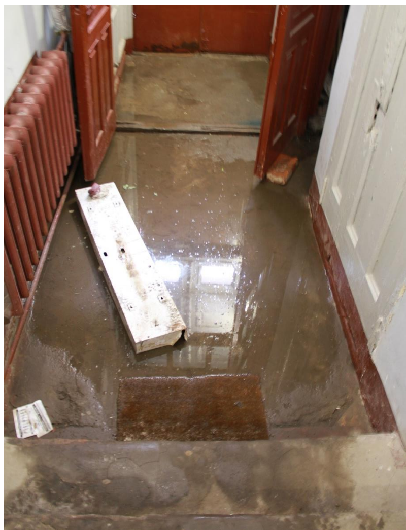
Фото 2. Вид на часть парадной лестницы.
