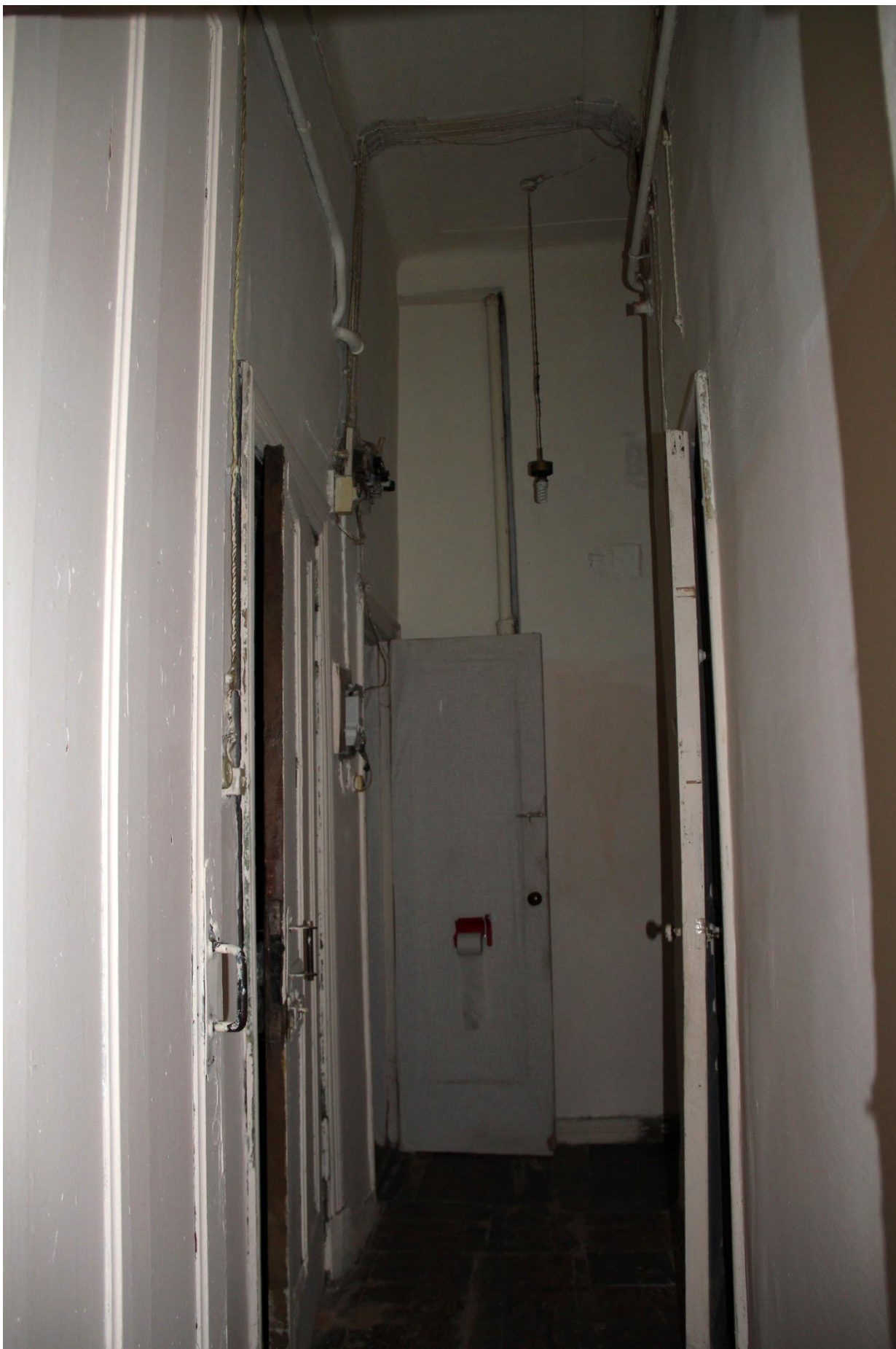
Фото 27. Вид на коридор в северной части квартиры № 35.
