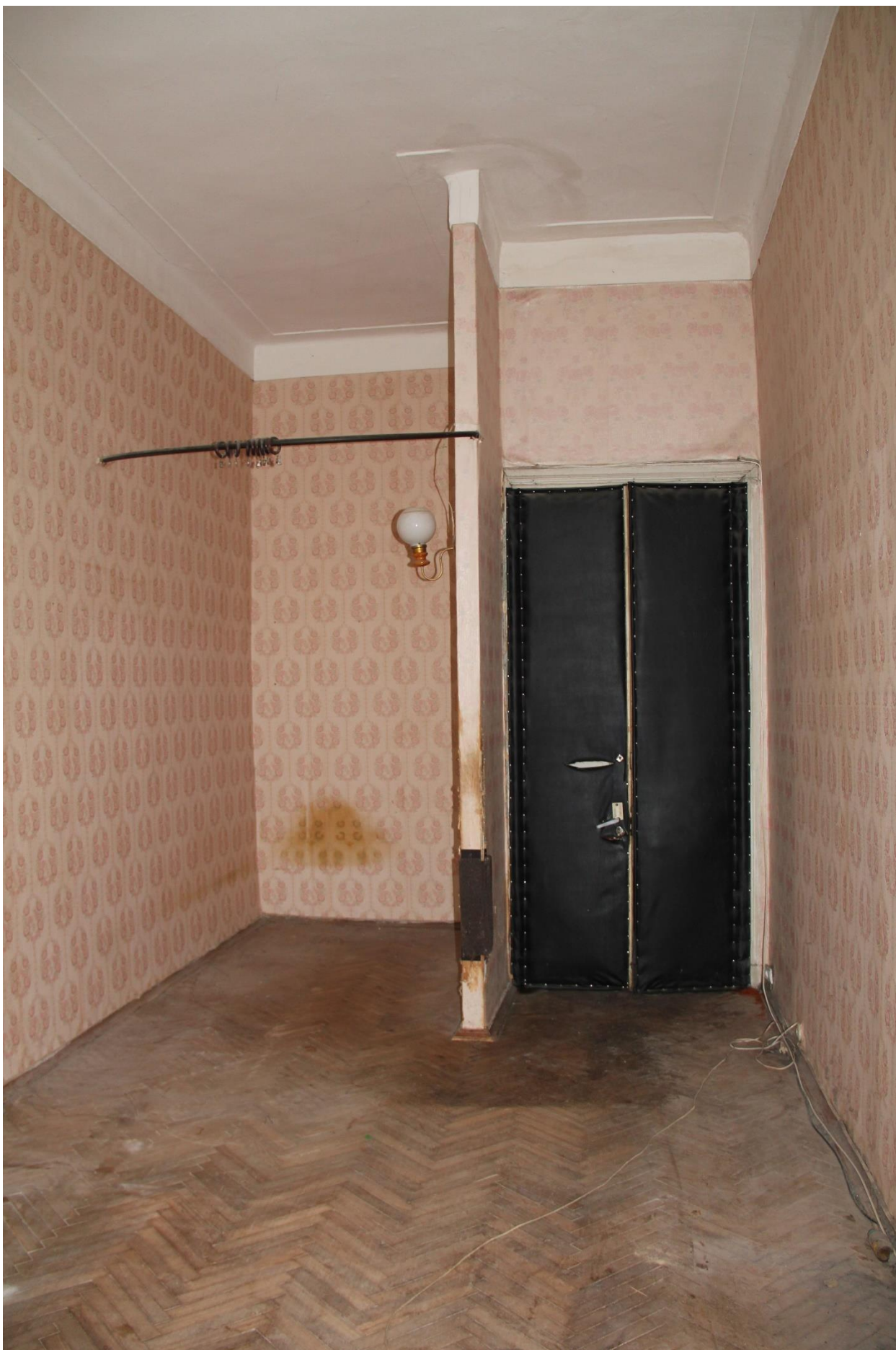
Фото 16. Вид на помещение № 8.
