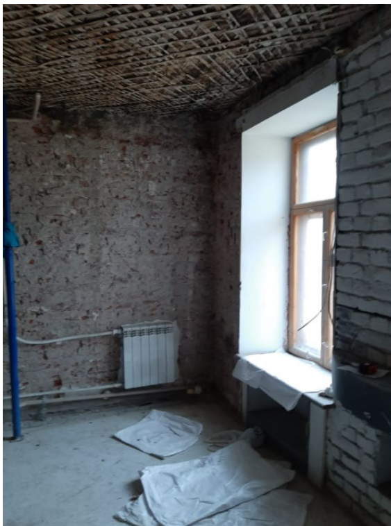
21. Фрагмент интерьеров кв. №75
