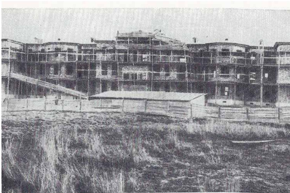
Строительство нейрохирургической клиники Психоневрологического института.
