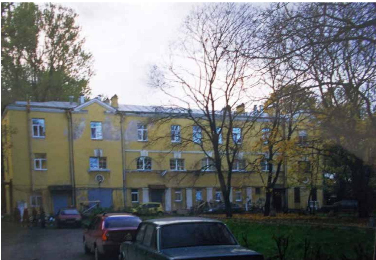
Илл. 120. Лабораторный корпус. (ул. Бехтерева, д. 3 лит. В) 2006 г. Фото Л.Л. Крупник. Архив КГИОП.
