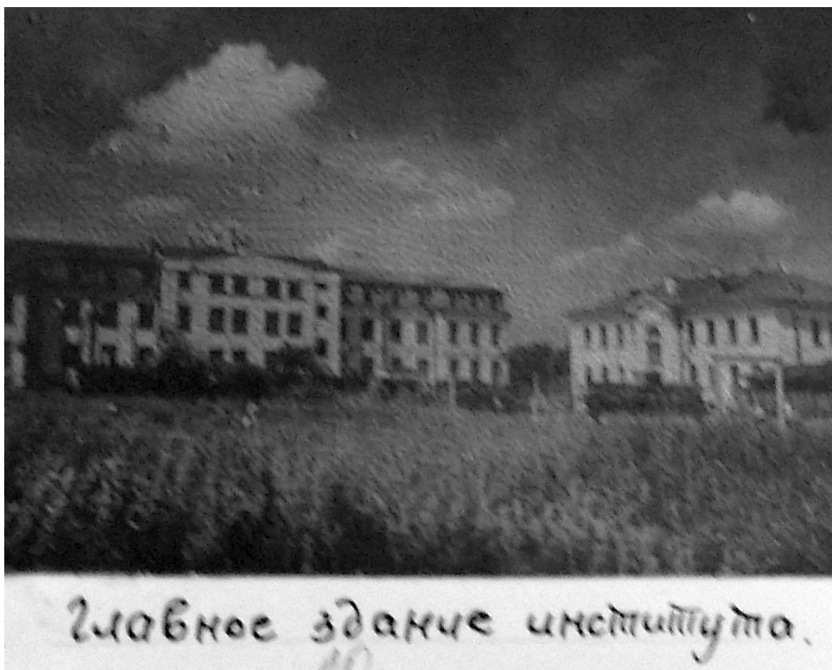
Илл. 107. Восточный фасад главного здания (бывший Противоалкогольный институт). 1936-1937 гг. ЦГА НТД. Ф. 313. Оп. 11. Д. 107.
