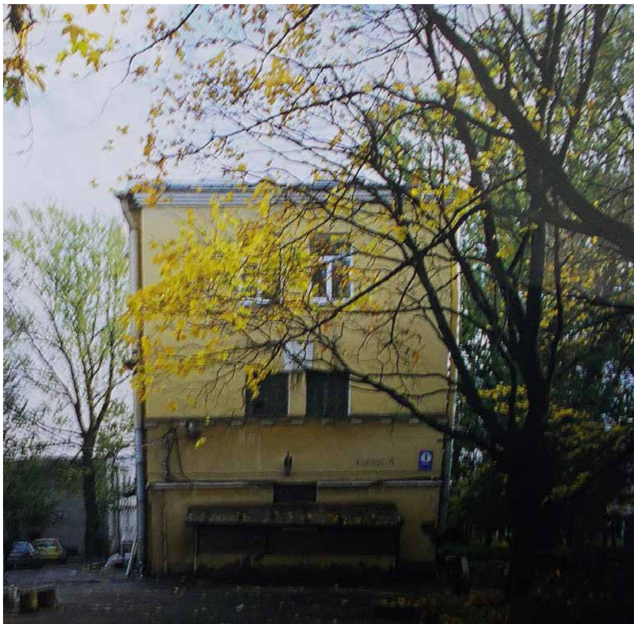
Илл. 121. Лабораторный корпус. (ул. Бехтерева, д. 3 лит. В) 2006 г. Фото Л.Л. Крупник. Архив КГИОП.
