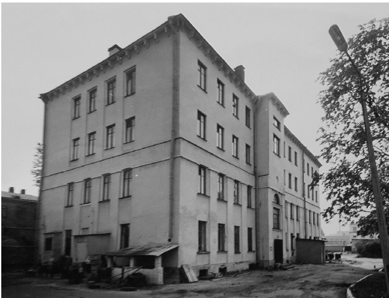
Илл. 118. Северный лабораторный корпус (исторически: корпус трудотерапии, общежитие). 1990 г. Фото А. Григорьев. Архив КГИОП.
