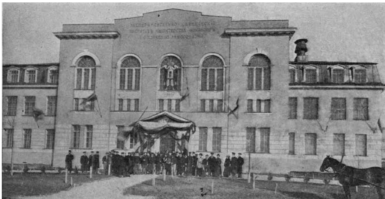
Илл. 98. Здание нового экспериментально-клинического института министерства финансов по изучению алкоголизма. Ателье К.К.Булла. Огонек. – 1912. - №20
