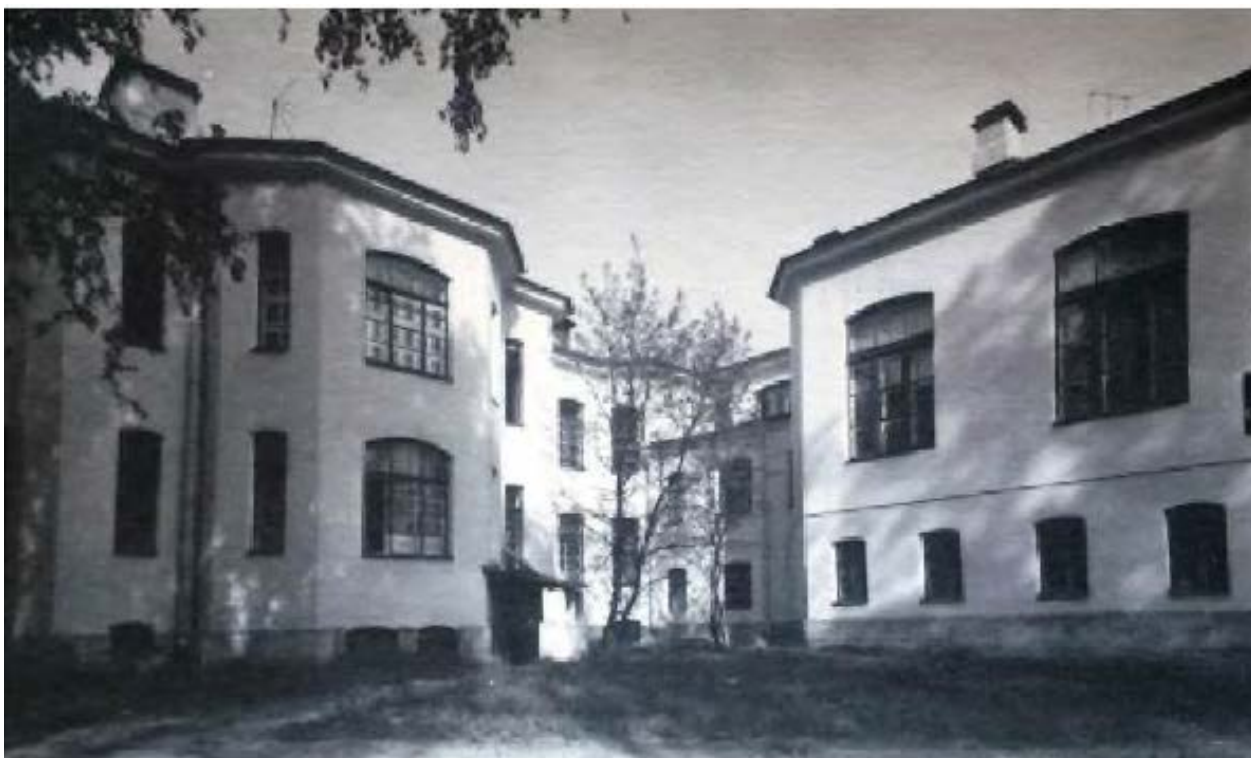
Илл. 114. Психиатрический корпус. Восточный фасад. 1990 г. Архив КГИОП.
