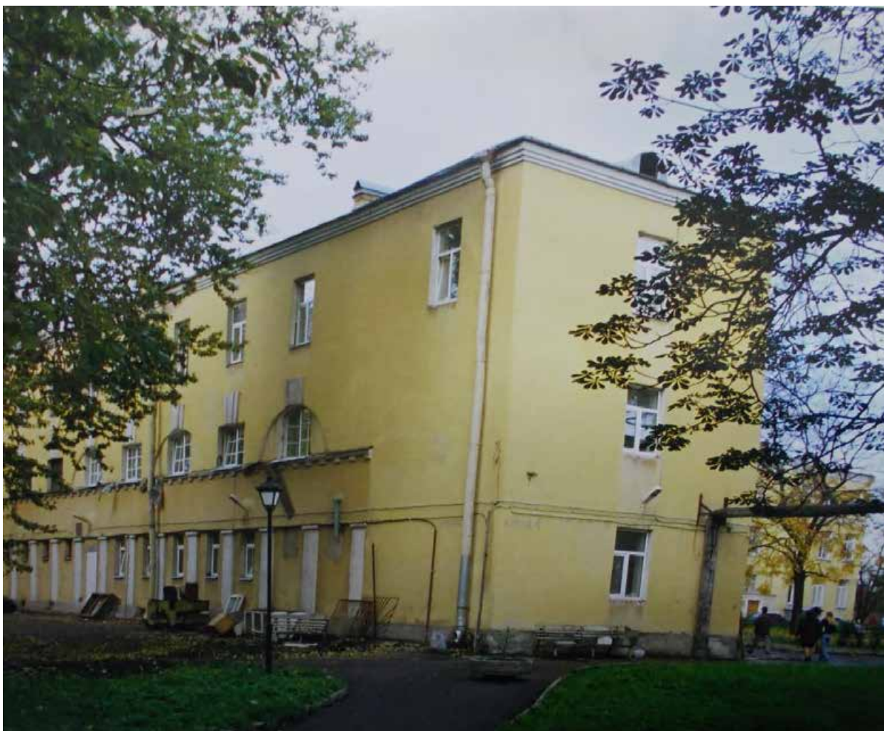
Илл. 122. Лабораторный корпус. (ул. Бехтерева, д. 3 лит. В) 2006 г. Фото Л.Л. Крупник. Архив КГИОП.
