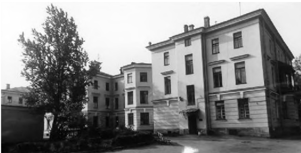
Илл. 115. Северный фасад здания нервных болезней (Нервно-Хирургический корпус). 1990 г. Архив КГИОП.
