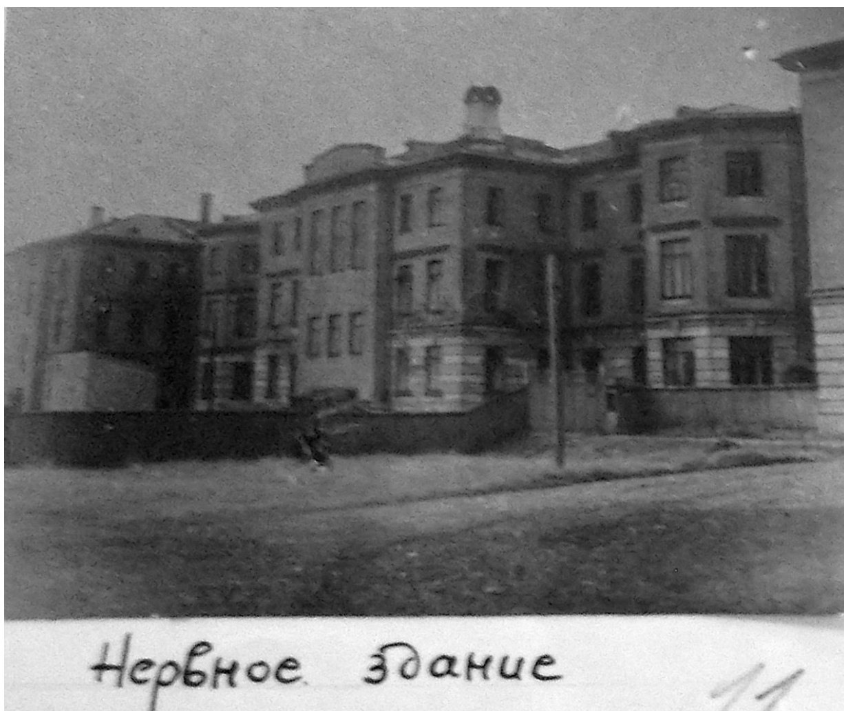
Илл. 104. Северный фасад здания нервных болезней (Нервно-Хирургический корпус). 1936-1937 гг. ЦГА НТД. Ф. 313. Оп. 11. Д. 107.
