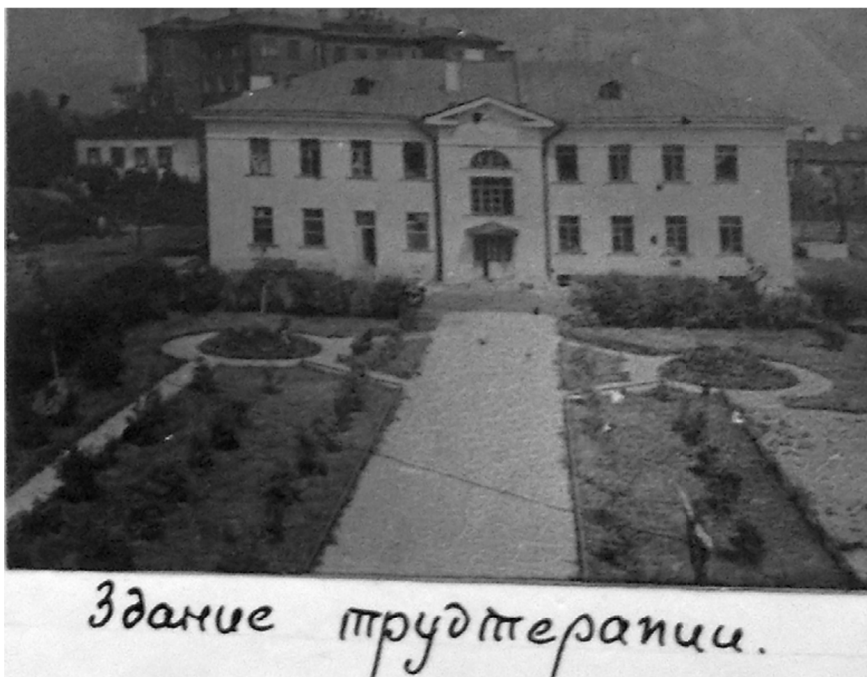
Илл. 108. Здание трудотерапии (северный флигель). Южный фасад. 1936-1937 гг. ЦГА НТД. Ф. 313. Оп. 11. Д. 107.
