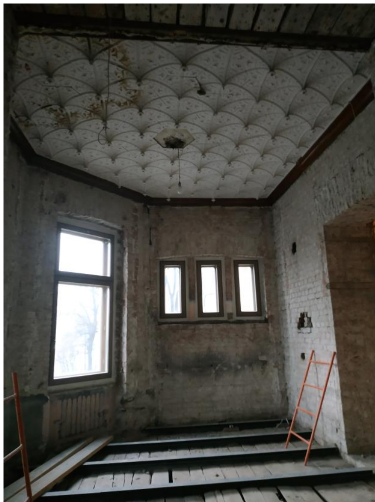
30. Вид интерьера с лепным потолком квартиры № 36.
