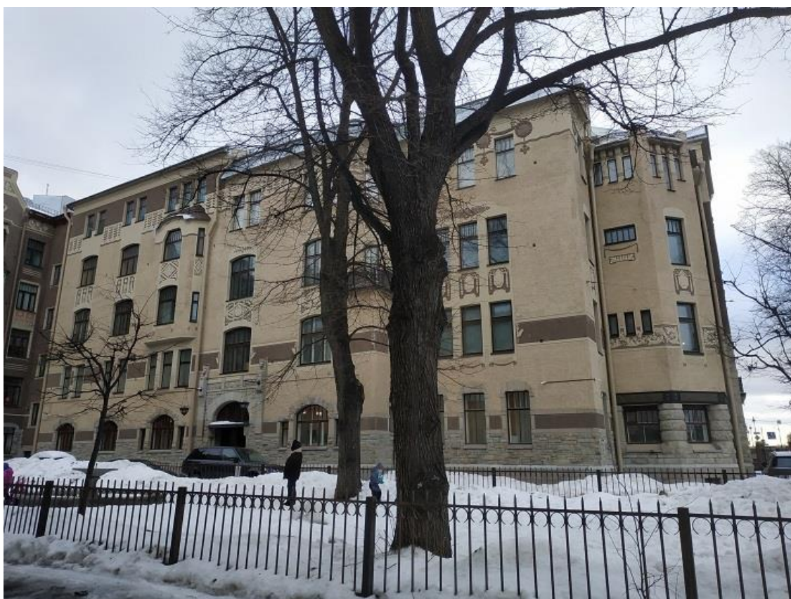
6. Здание по адресу: Санкт-Петербург, Каменноостровский проспект, д. 1-3. Вид дворового фасада.
