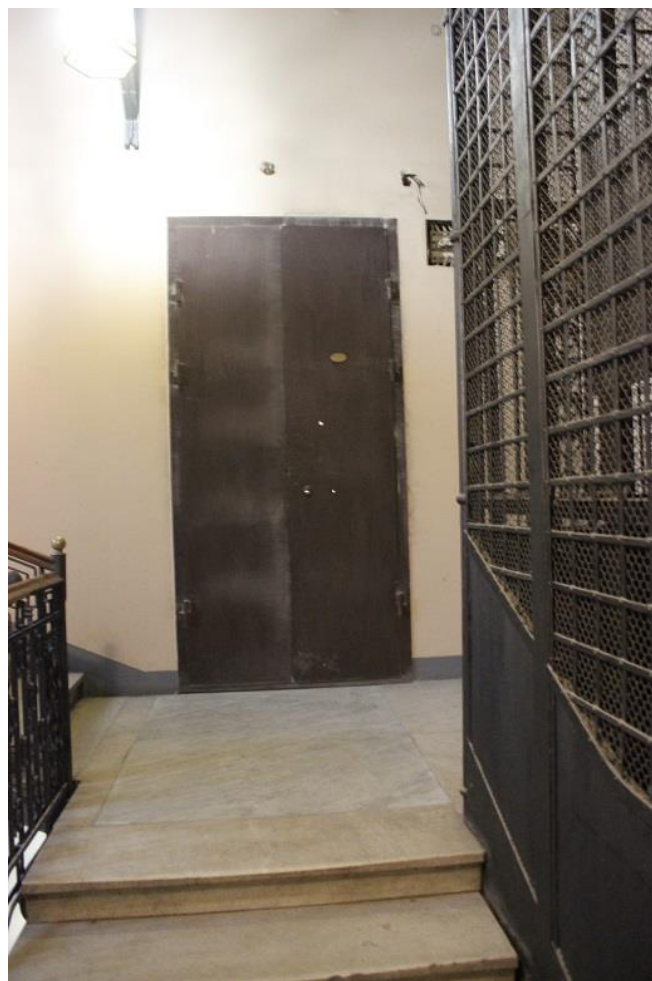
16. Вход в квартиру № 36.
