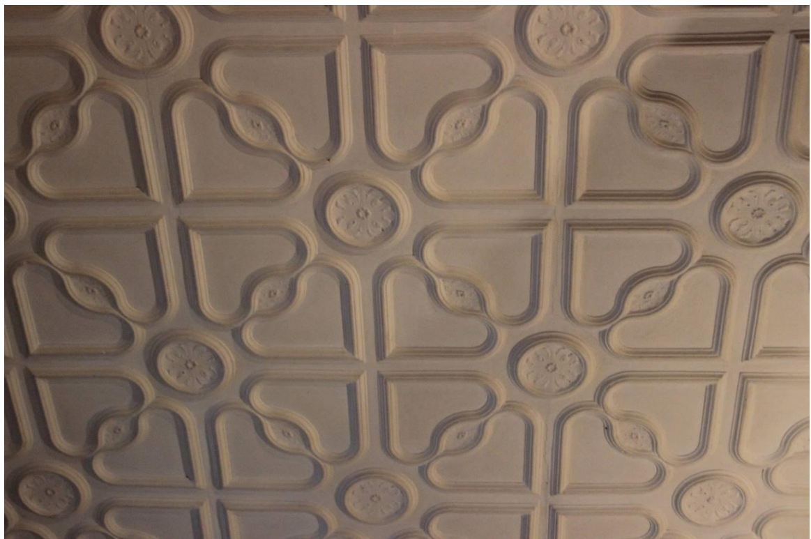
23. Фрагмент оформления лепного потолка в помещении квартиры № 36.
