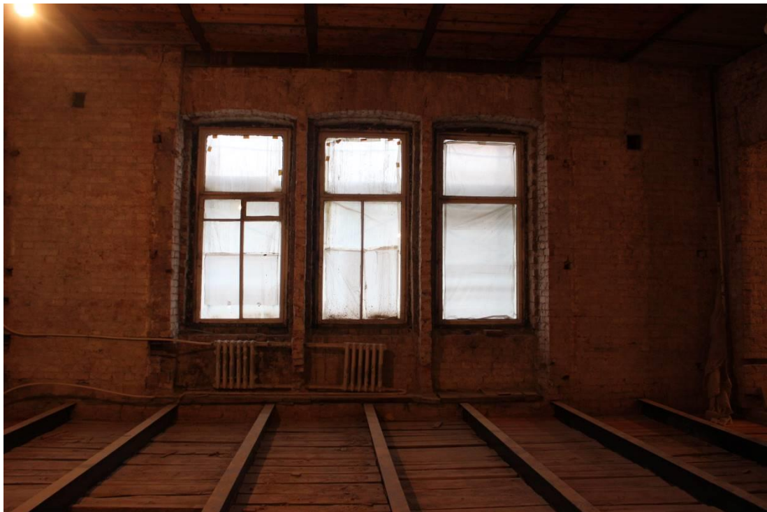
21. Вид интерьера квартиры № 36.
