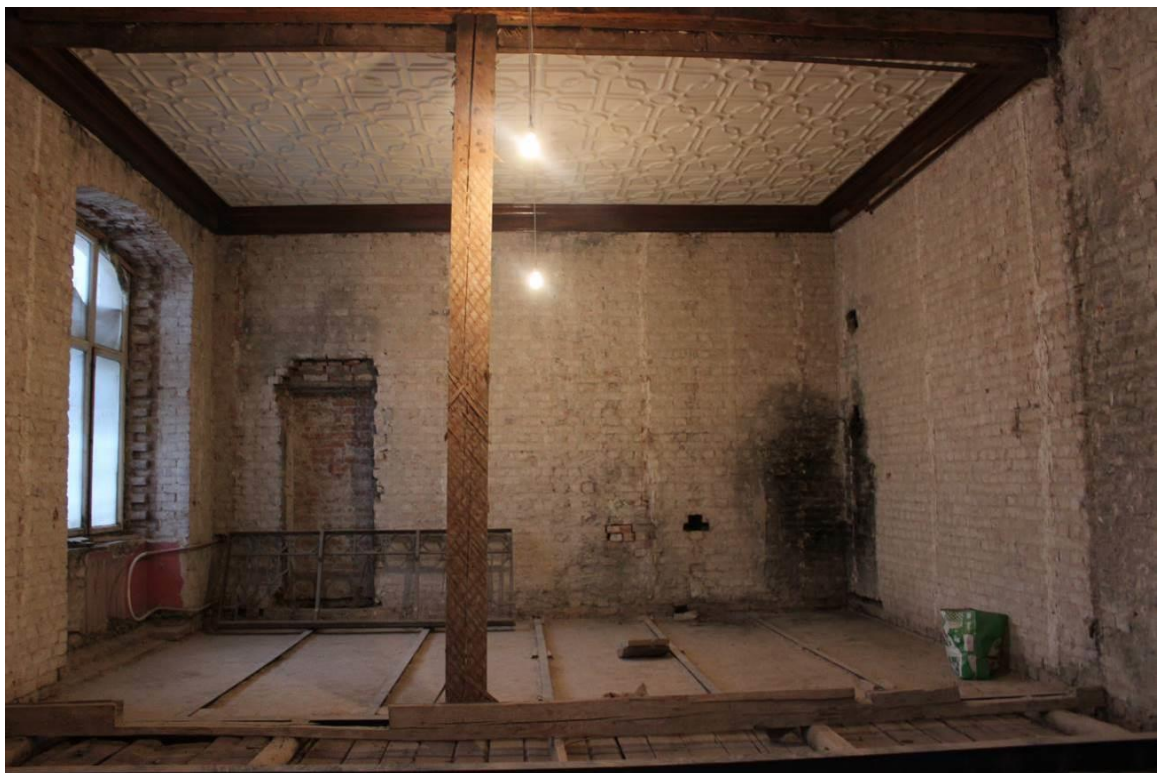
22. Вид интерьера квартиры № 36.
