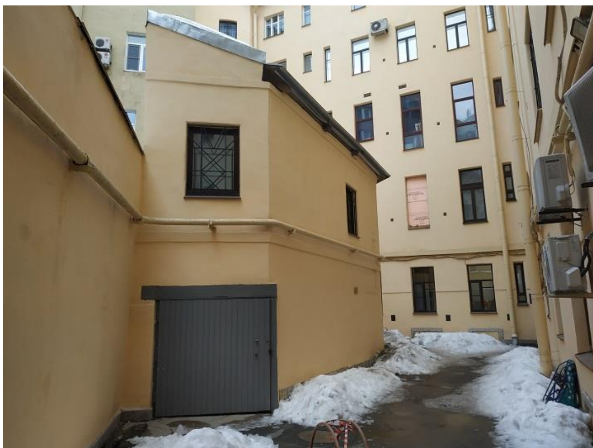
11. Здание по адресу: Санкт-Петербург, Каменноостровский проспект, д. 1-3. Общий вид служебного дворового флигеля.
