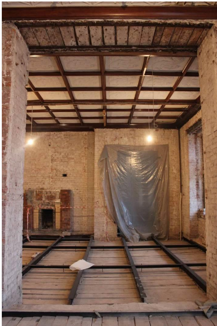
26. Вид интерьера квартиры № 36.
