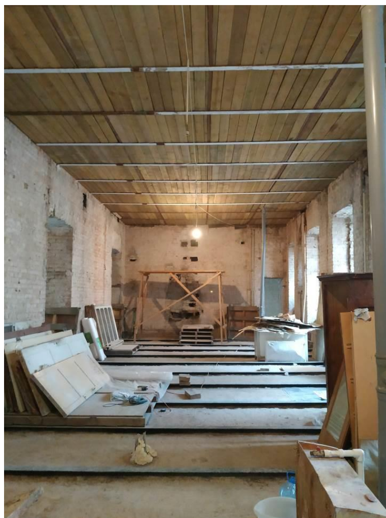
25. Вид интерьера квартиры № 36.
