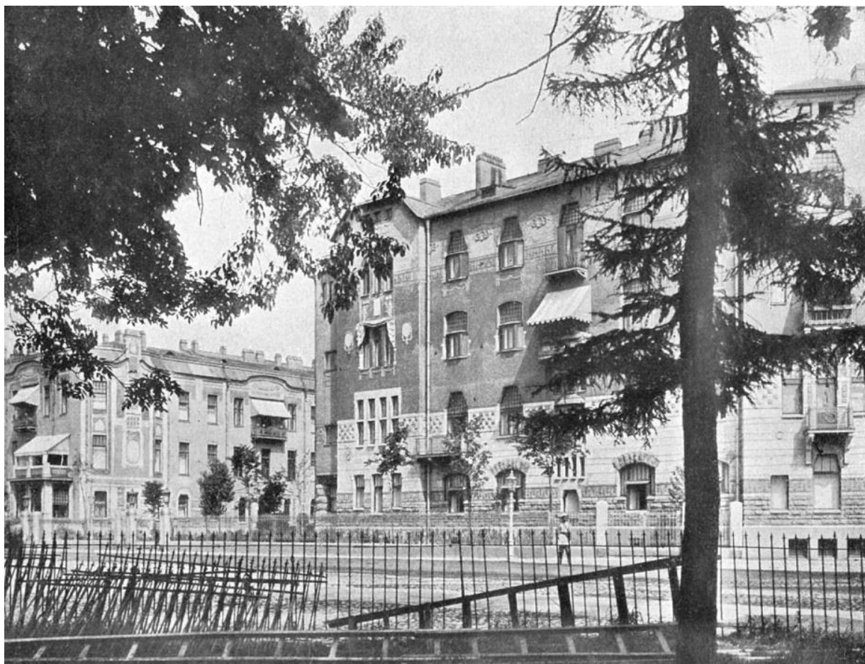
88. Доходный дом Каменноостровский пр., д. 1. Ф.И.Лидваль. 1906 г. Ежегодник Общества Архитекторов-Художников С.Петербург. 1906 г. Выпуск 1. Л. 59.
