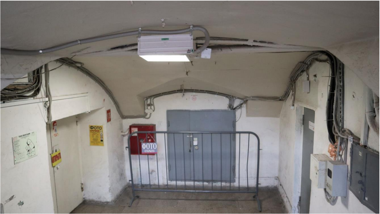
Фото 250. 3 цокольный этаж, коридор, помещение 8Н (1).
