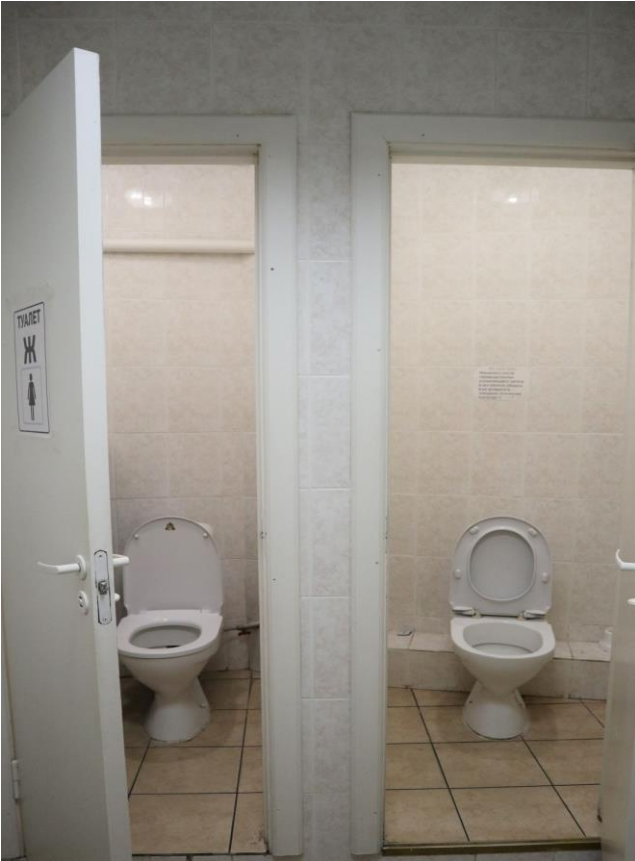
Фото 130. 2 этаж, санузел, помещение, 21Н (3, 4).
