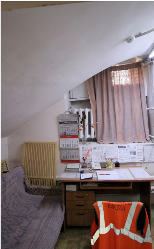
Фото 251. 3 цокольный этаж, коридор, помещение 8Н (2).
