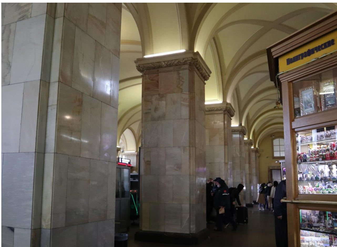
Фото 12. 1 этаж, прямоугольные пилоны вестибюля, помещение 9Н (35).
