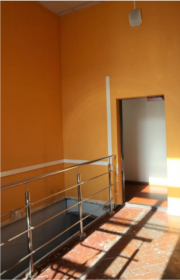
Фото 159. 3 этаж, помещение 28Н (24).
