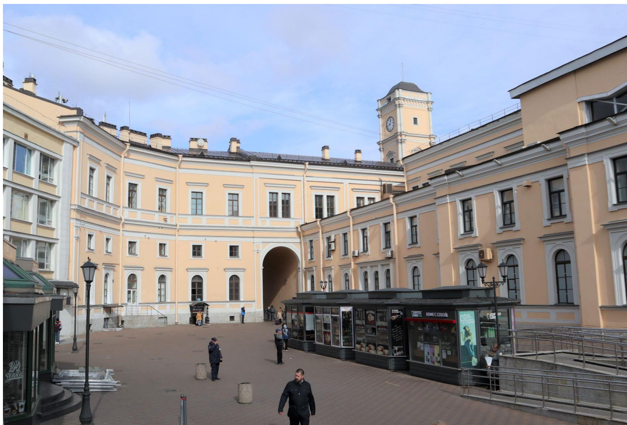
Фото 9. Западный дворовый фасад.
