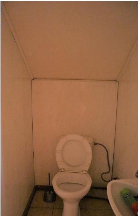
Фото 77. 1 этаж, санузел, помещение 10Н (2).
