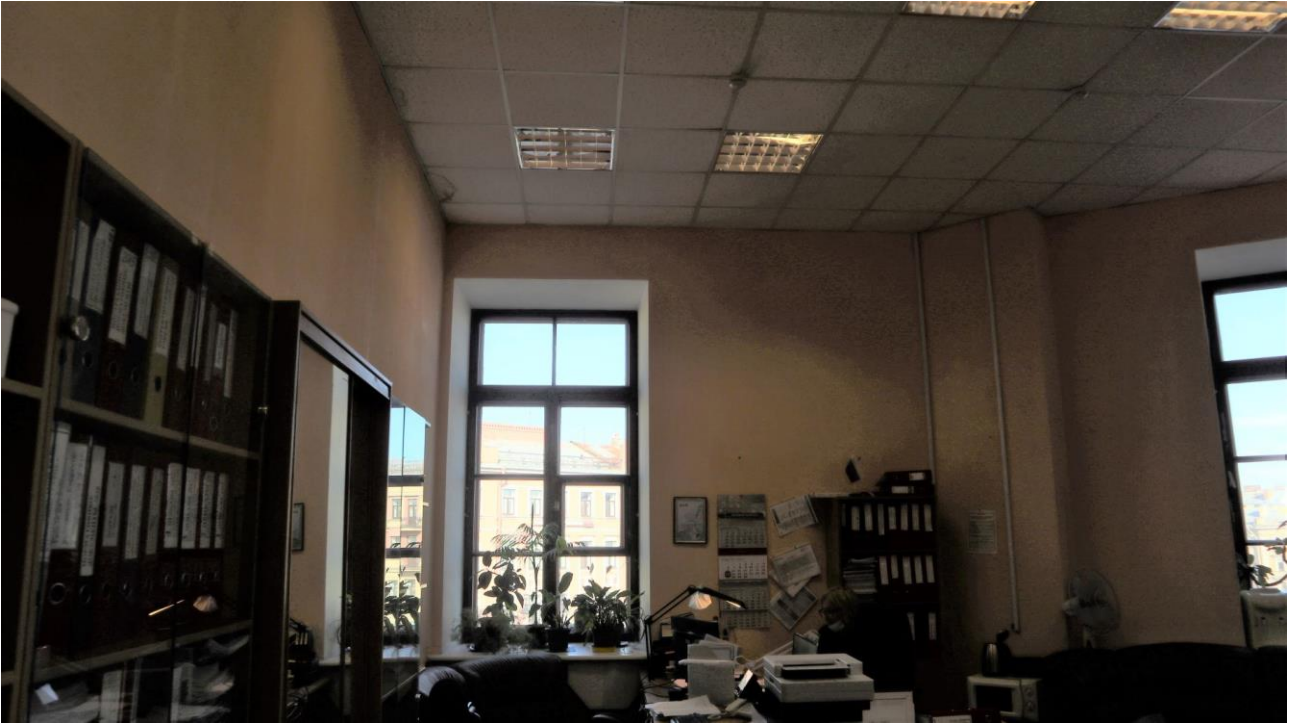
Фото 171. 3 этаж, офисное помещение 28Н (12).
