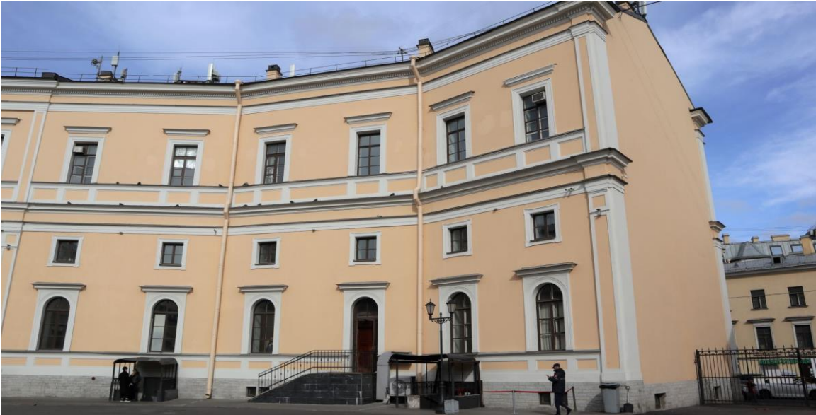
Фото 6. Восточный дворовый фасад.
