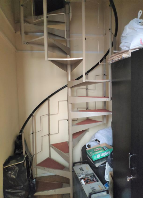
Фото 196. 3 этаж, лестница на антресоль, помещение 30Н (56).
