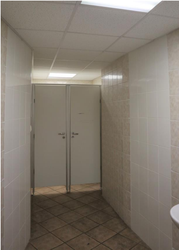
Фото 227. 3 этаж, санузел, помещение 30Н (41).
