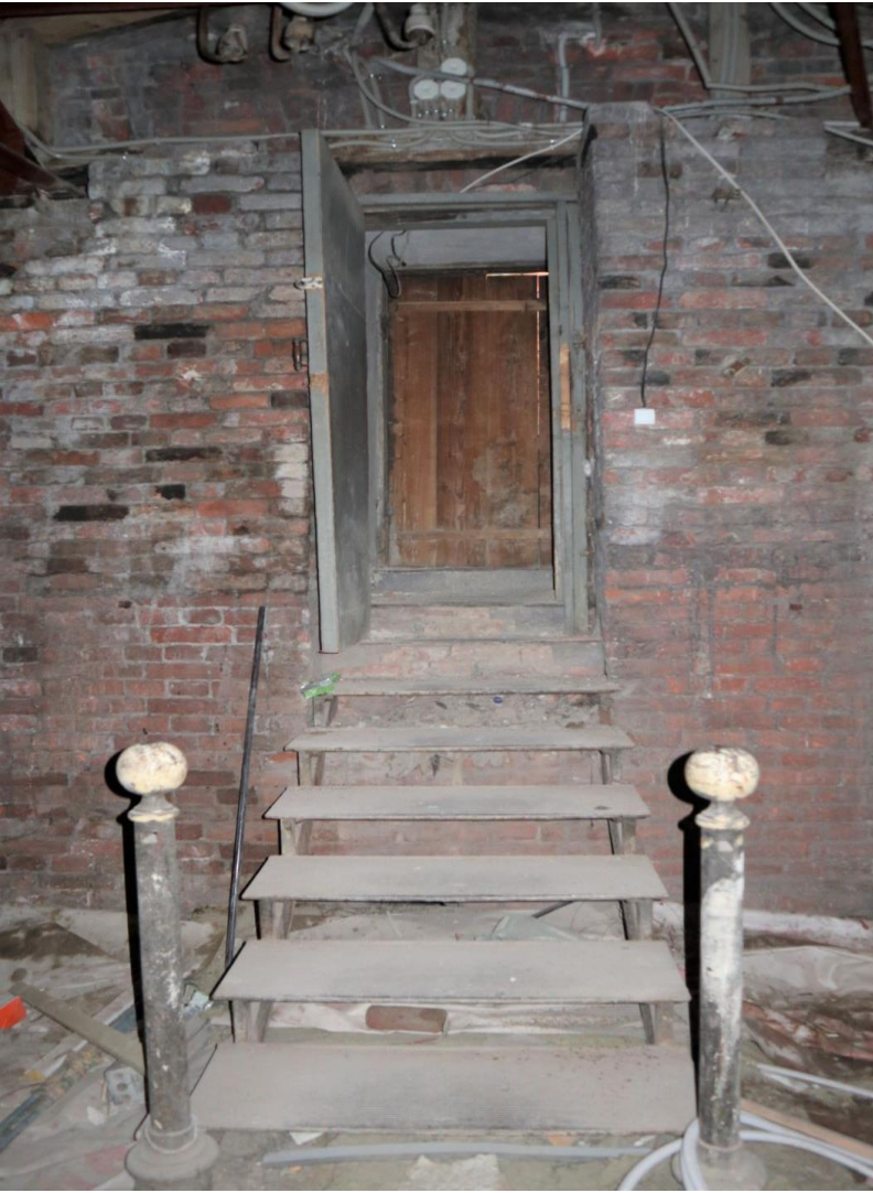
Фото 259. Чердачное помещение, вход в часовую башню.
