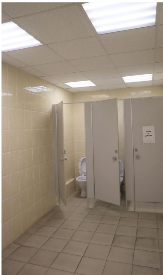
Фото 215. 3 этаж, санузел, помещение 30Н (51).
