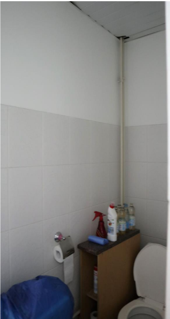
Фото 42. 1 этаж, санузел, помещение 18Н (4).
