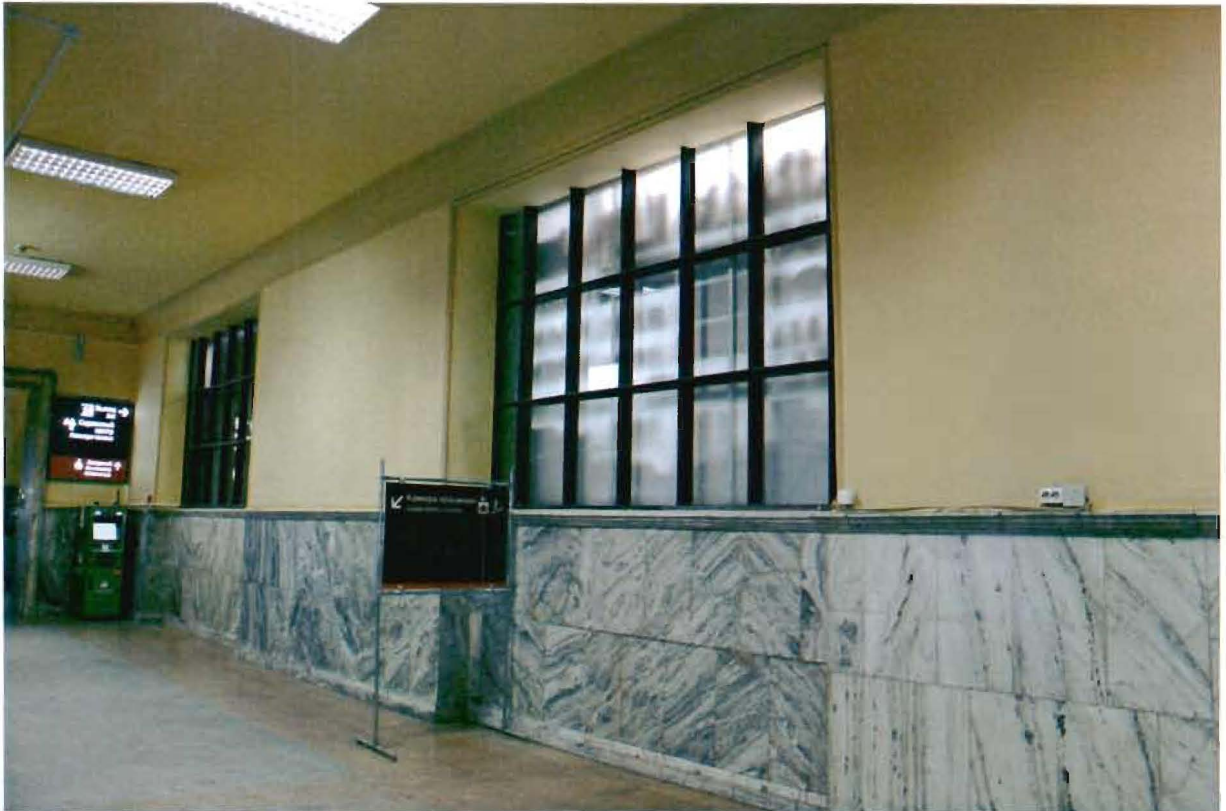
Фото №5. Проходной холл.
