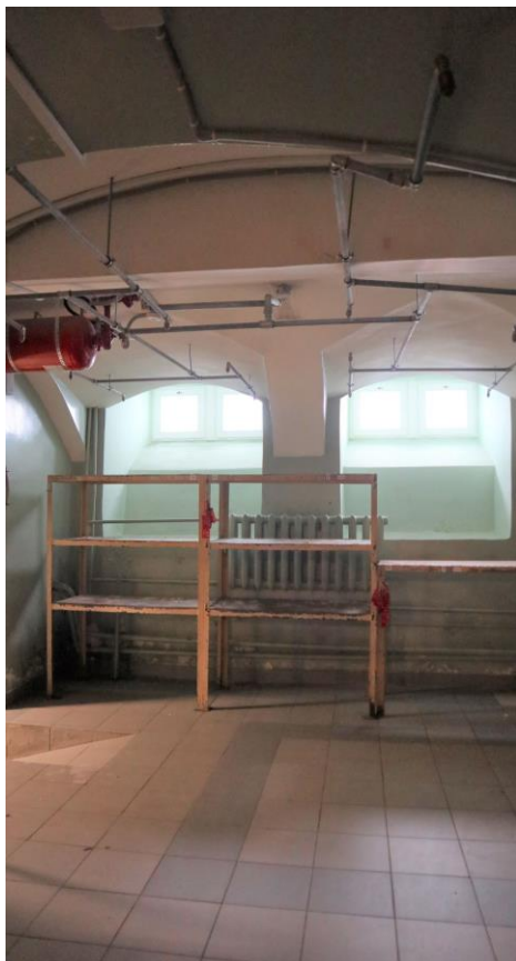
Фото 248. 3 цокольный этаж, коридор, помещение 2Н (14).
