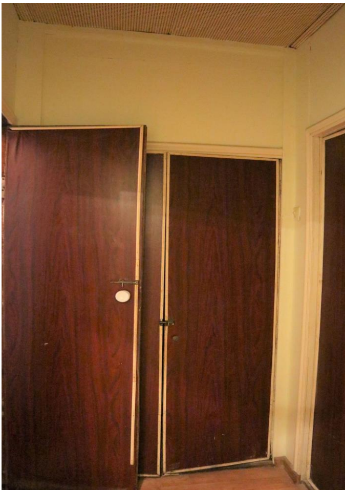
Фото 117. 2 этаж, помещение 20Н (21).
