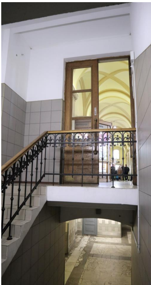
Фото 36. 1 этаж, лестница, Л-9.
