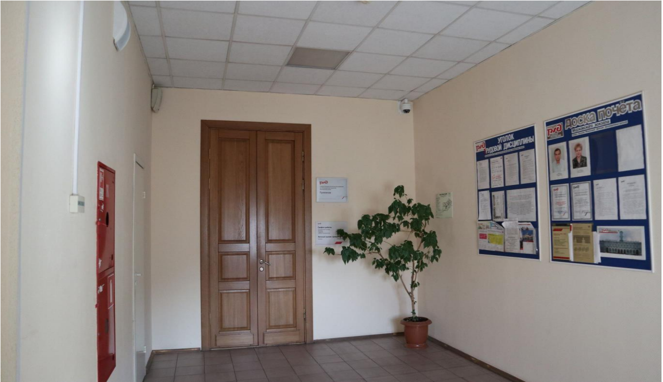
Фото 94. 2 этаж, помещение 27Н (1).
