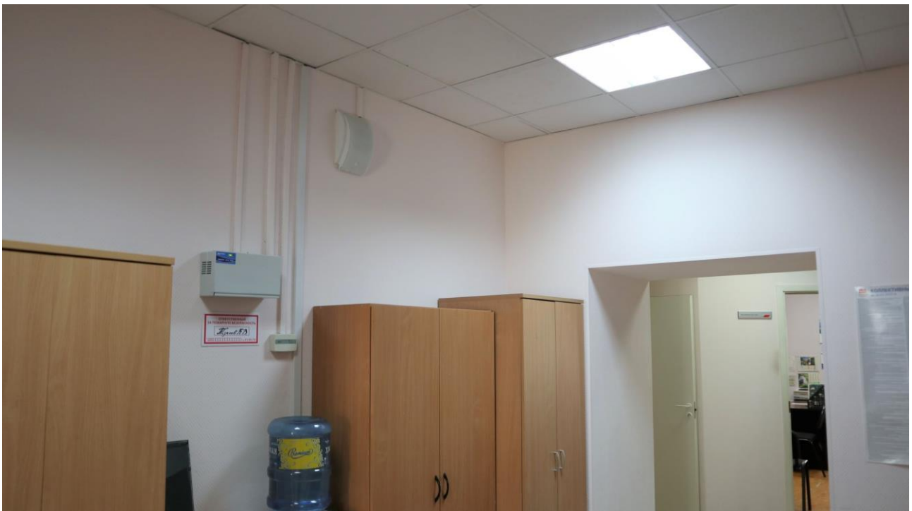
Фото 142. 2 этаж, помещение 27Н (21).
