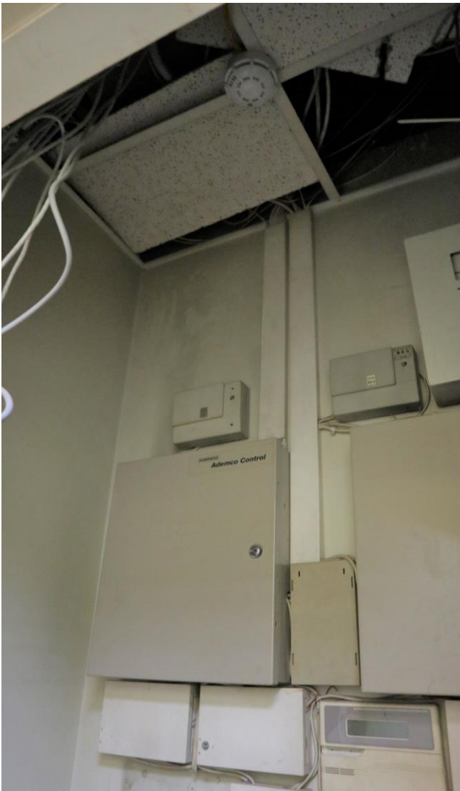
Фото 232. 3 этаж, помещение 30Н (63).
