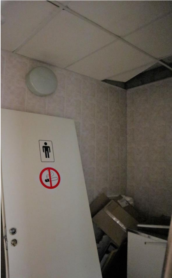
Фото 216. 3 этаж, помещение 30Н (50).
