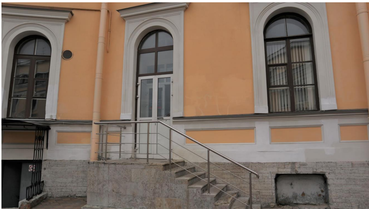
Фото 60. 1 этаж, лестница Л-1.
