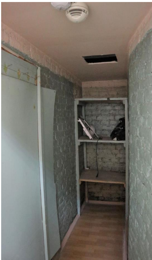
Фото 126. 2 этаж, помещение 20Н (18).
