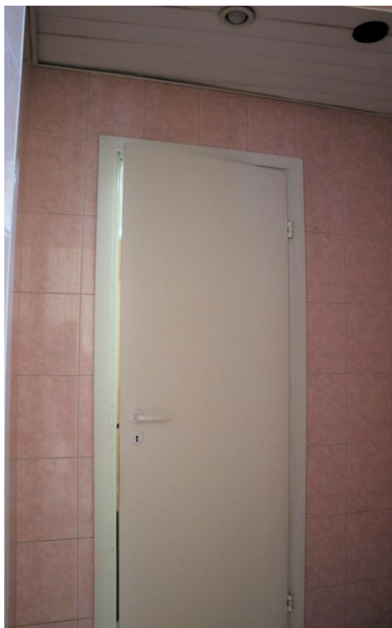
Фото 137. 2 этаж, помещение 27Н (23).
