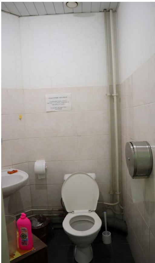
Фото 51. 1 этаж, санузел, помещение 18Н (23).
