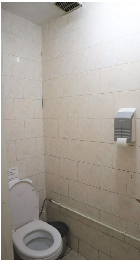
Фото 109. 2 этаж, санузел, помещение 20Н (8).
