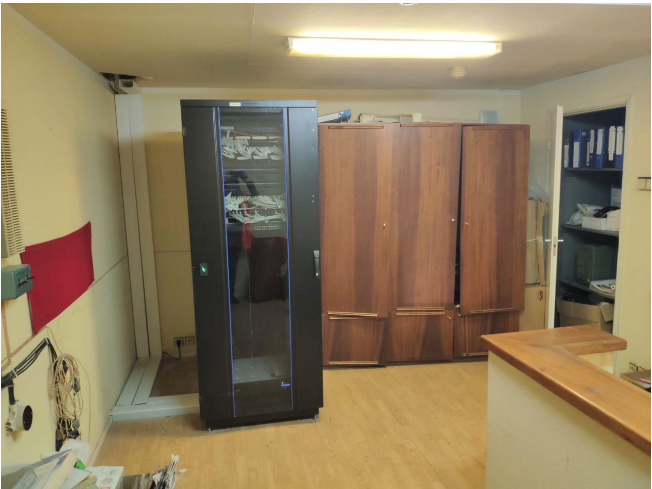
Фото 197. 3 этаж, антресоль, помещение 30Н (60).
