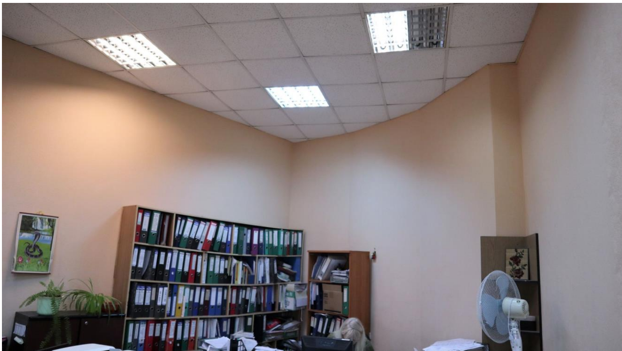
Фото 114. 2 этаж, офисное помещение, 20Н (12).
