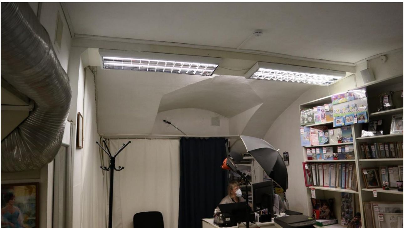
Фото 253. 3 цокольный этаж, коридор, помещение 8Н (7).
