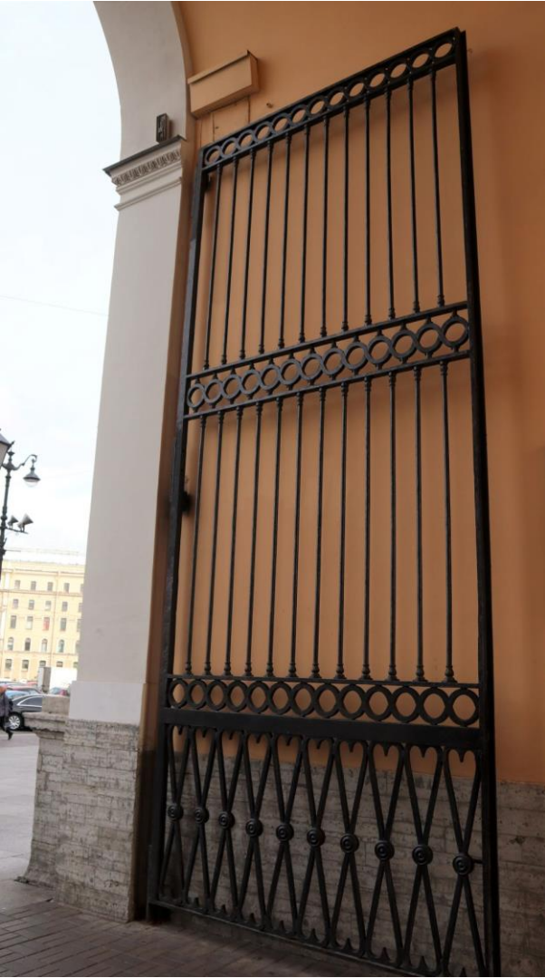
Фото 4. Ажурное заполнение воротного проезда.
