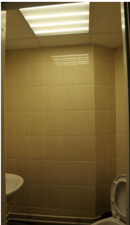
Фото 44. 1 этаж, санузел, помещение 18Н (7).
