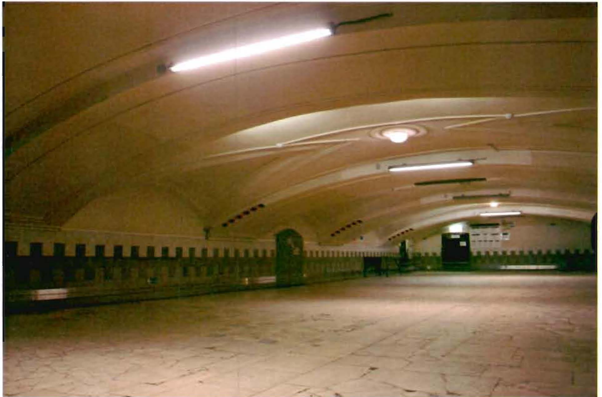
Фото №7. Цокольный этаж.
