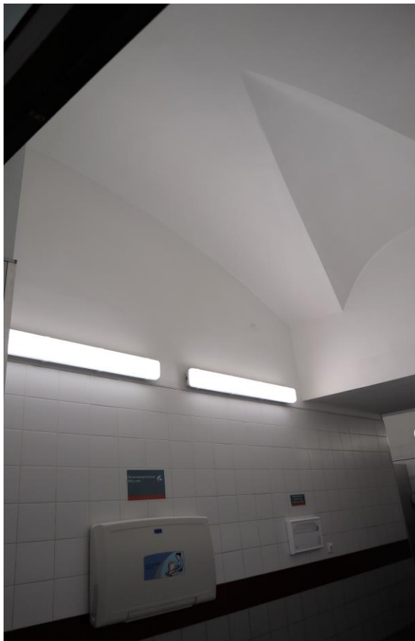
Фото 88. 1 этаж, санузел, помещение 9Н (52).
