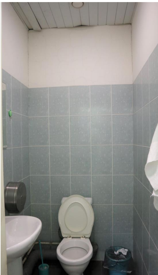
Фото 52. 1 этаж, санузел, помещение 18Н (22).
