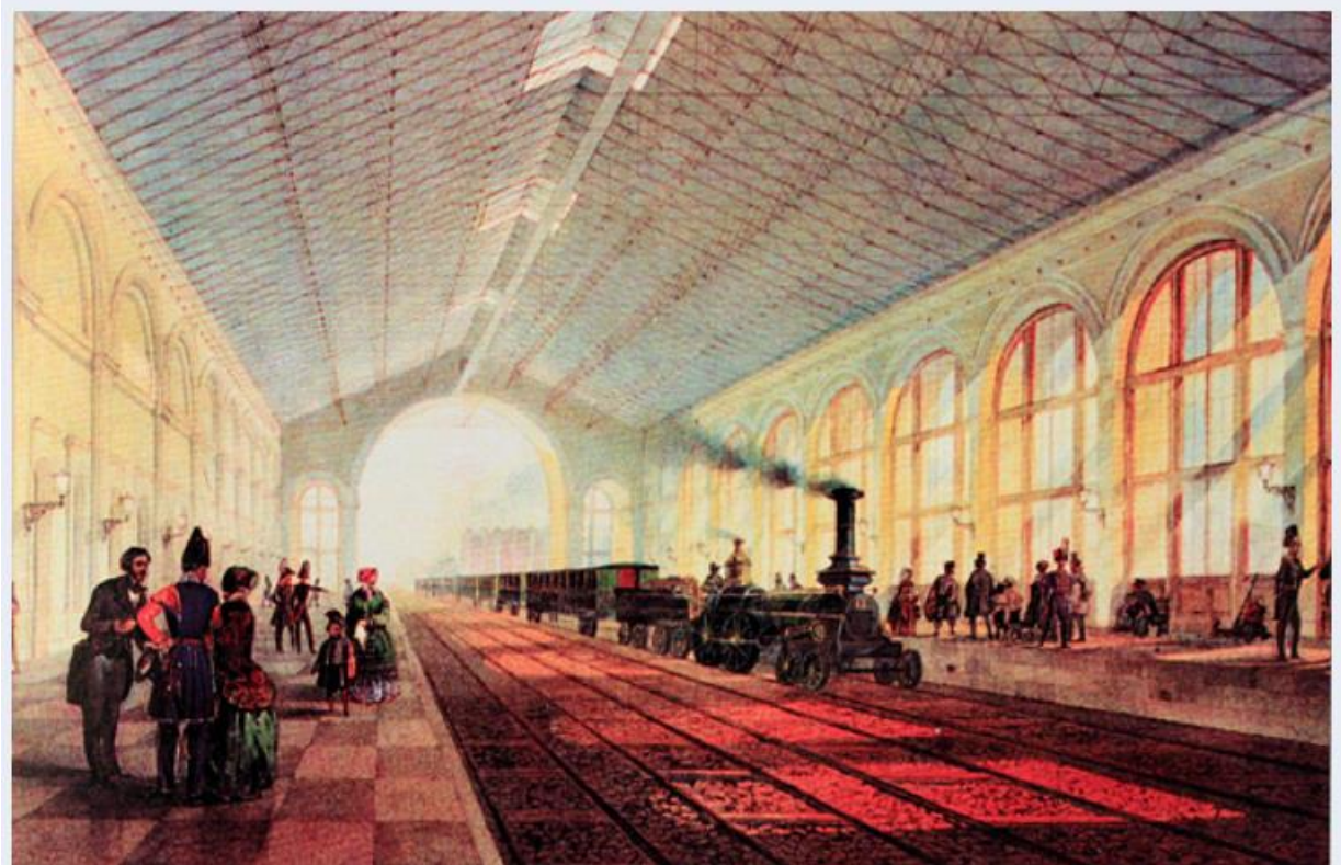
Илл. 23. Крытый перрон (галерея) Санкт-Петербургской пассажирской станции. Акварель А. Петцольта. 1851 г. РНБ, Фонд эстампов, Шифр: ЭАЛТ247777
