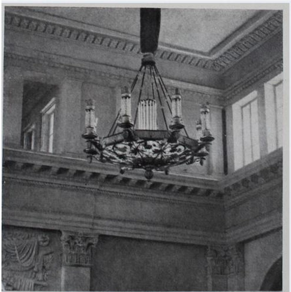
Илл. 42. Московский вокзал. Фрагмент зала ожидания после реконструкции./// Ежегодник «Ленинградского отделения Союза советских архитекторов» 1953 г. С. 111
