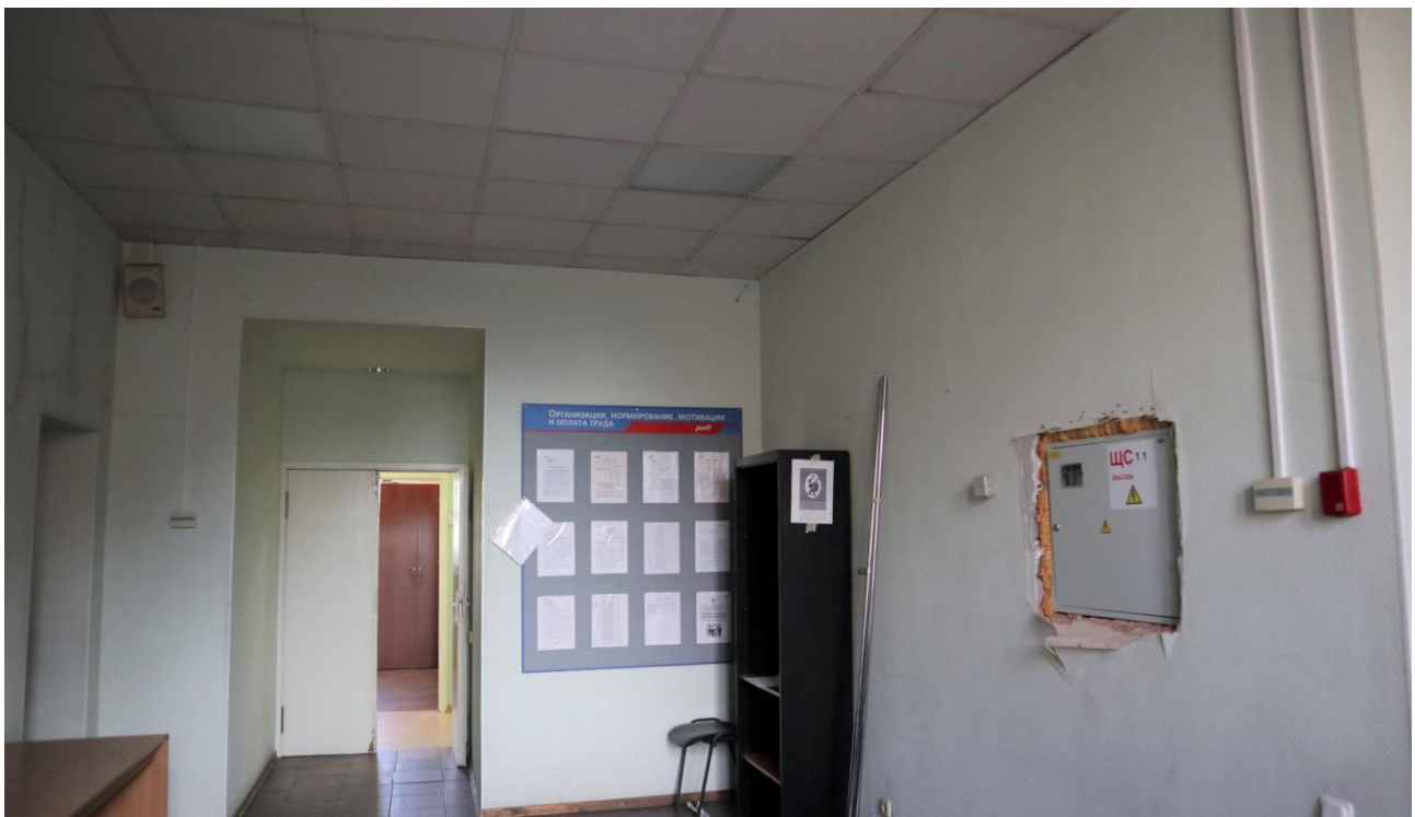
Фото 38. 1 этаж, помещение, 18Н (1).
