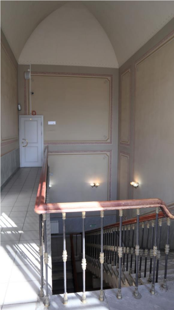
Фото 184. 3 этаж, лестница, Л-4.
