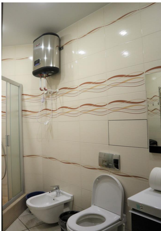
Фото 102. 2 этаж, санузел, помещение 27Н (7).
