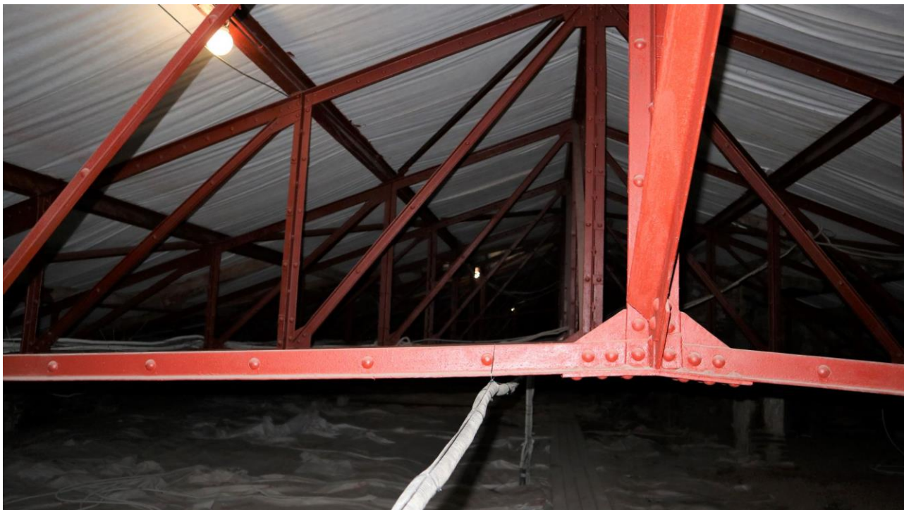
Фото 258. Чердачное помещение, металлические клепаные фермы (над центральной частью здания).
