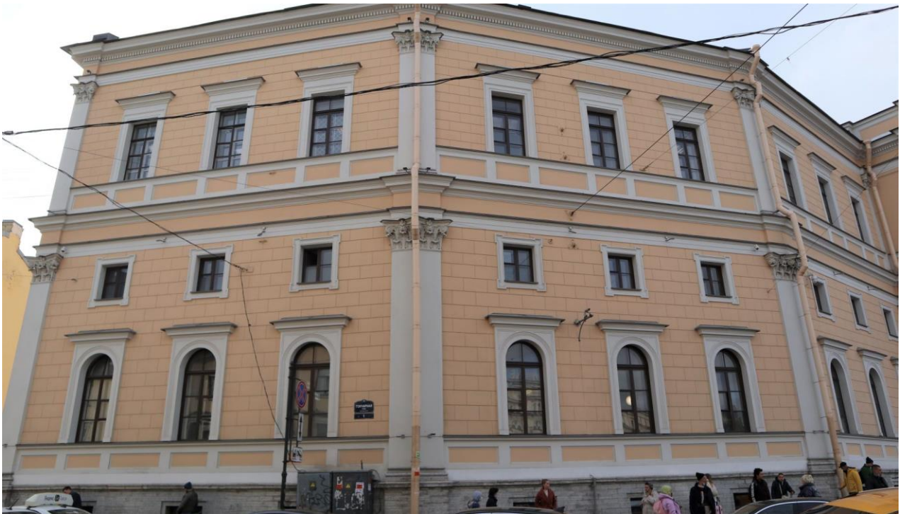
Фото 5. Восточный лицевой фасад с Гончарной улицы.
