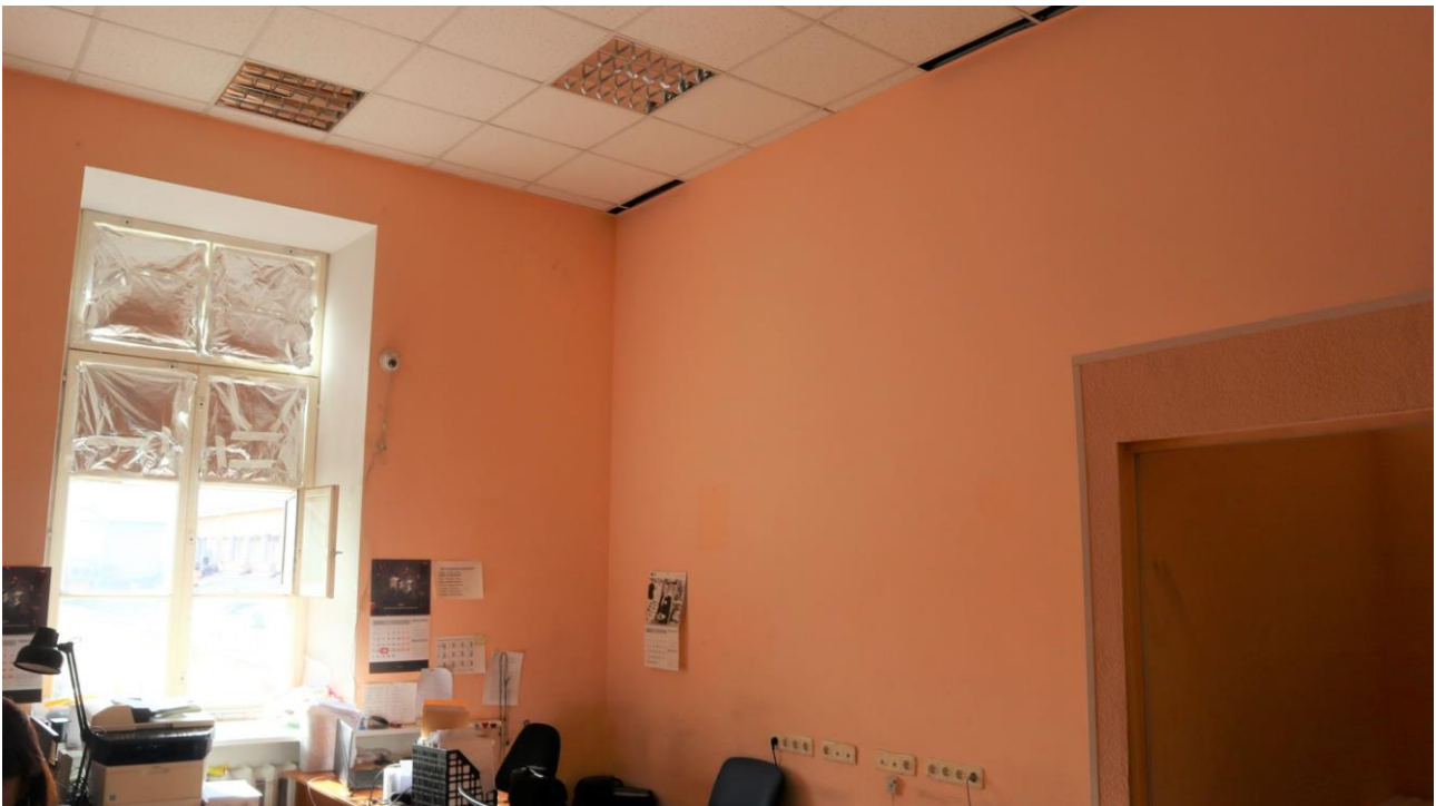
Фото 226. 3 этаж, помещение 30Н (42).
