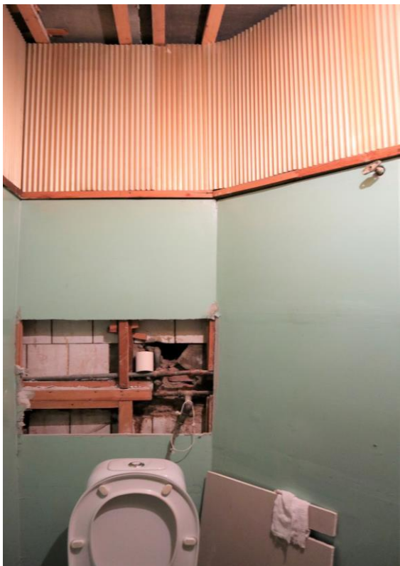
Фото 118. 2 этаж, санузел, помещение 20Н (16).
