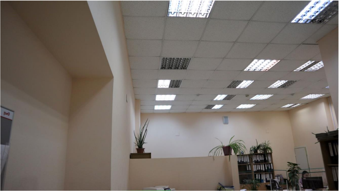
Фото 124. 2 этаж, офисное помещение, 20Н (5).
