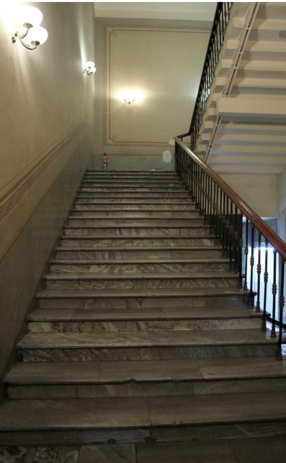
Фото 34. 1 этаж, лестница, Л-3.
