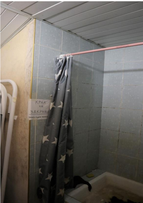
Фото 66. 1 этаж, помещение 34Н (13).
