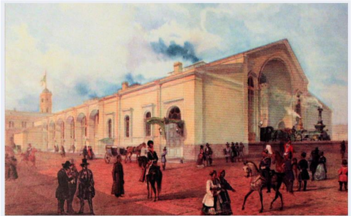
Илл. 24. Двор Санкт-Петербургской пассажирской станции. Акварель А. Петцольта. 1851 г. РНБ, Фонд эстампов, Шифр: ЭАлТ247778
