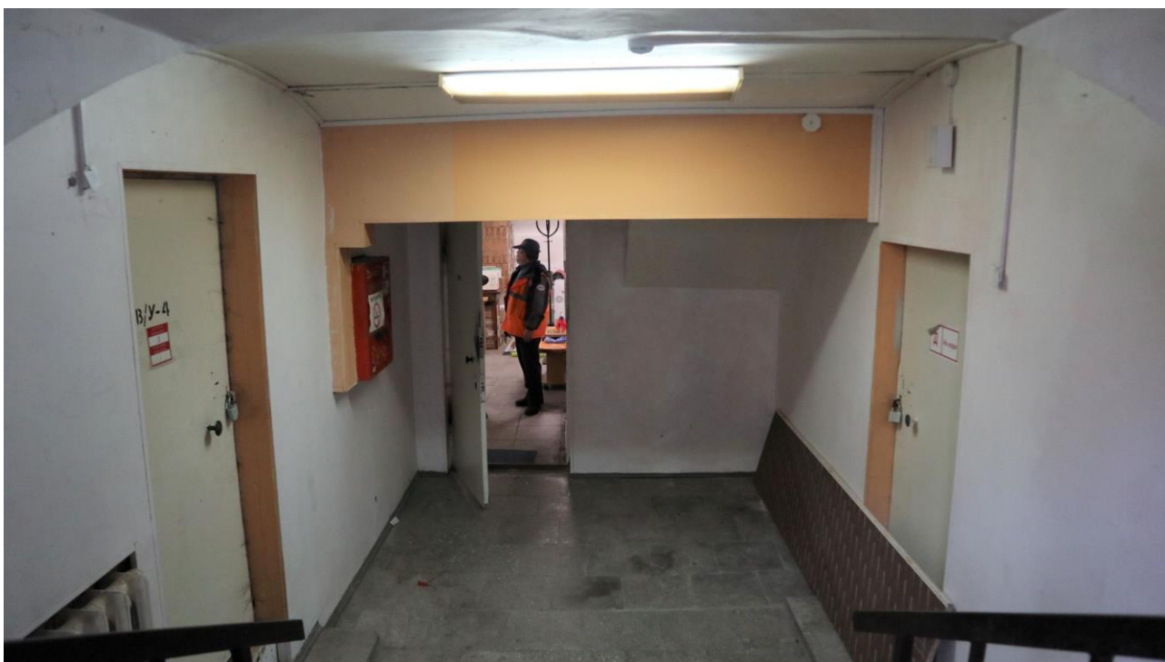
Фото 255. 3 цокольный этаж, коридор, помещение 35Н (1).
