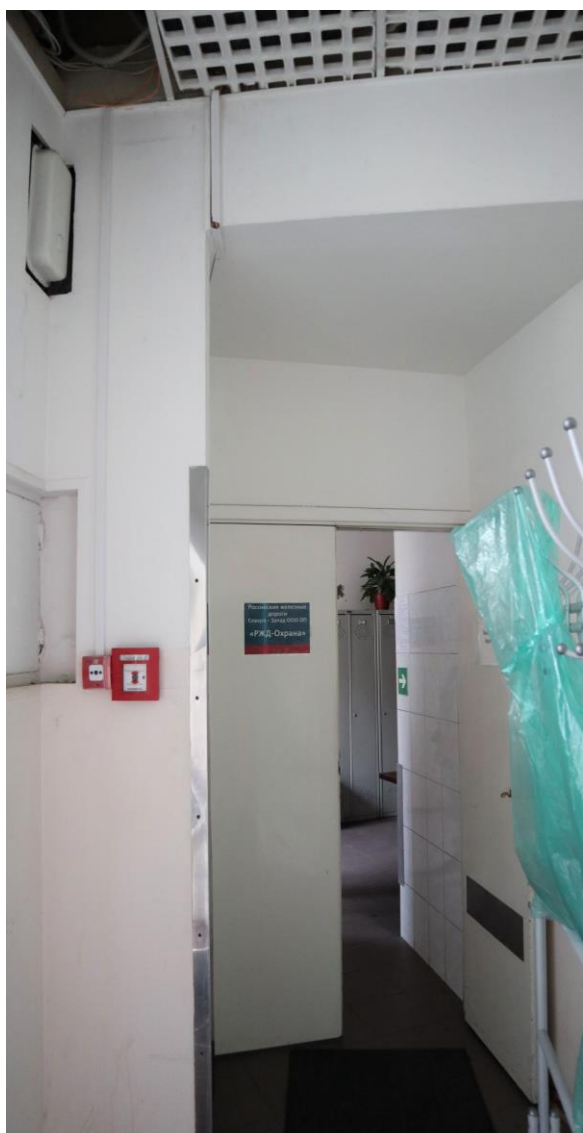
Фото 62. 1 этаж, помещение 34H.
