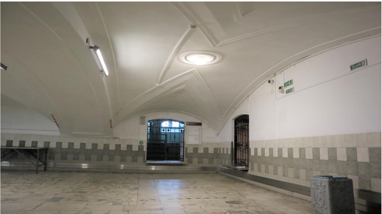
Фото 247. 3 цокольный этаж, коридор, помещение 2Н (10).
