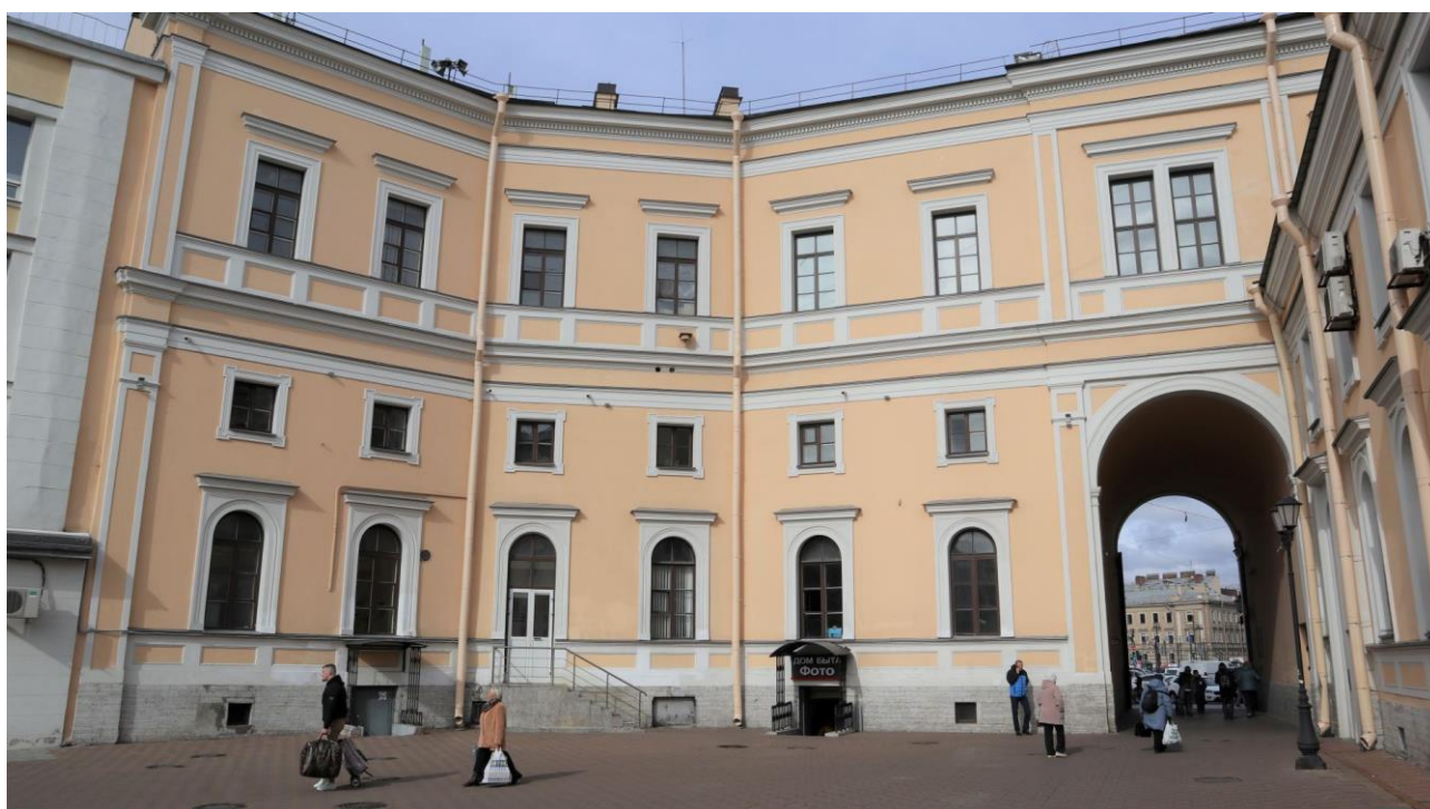
Фото 10. Западный дворовый фасад.
