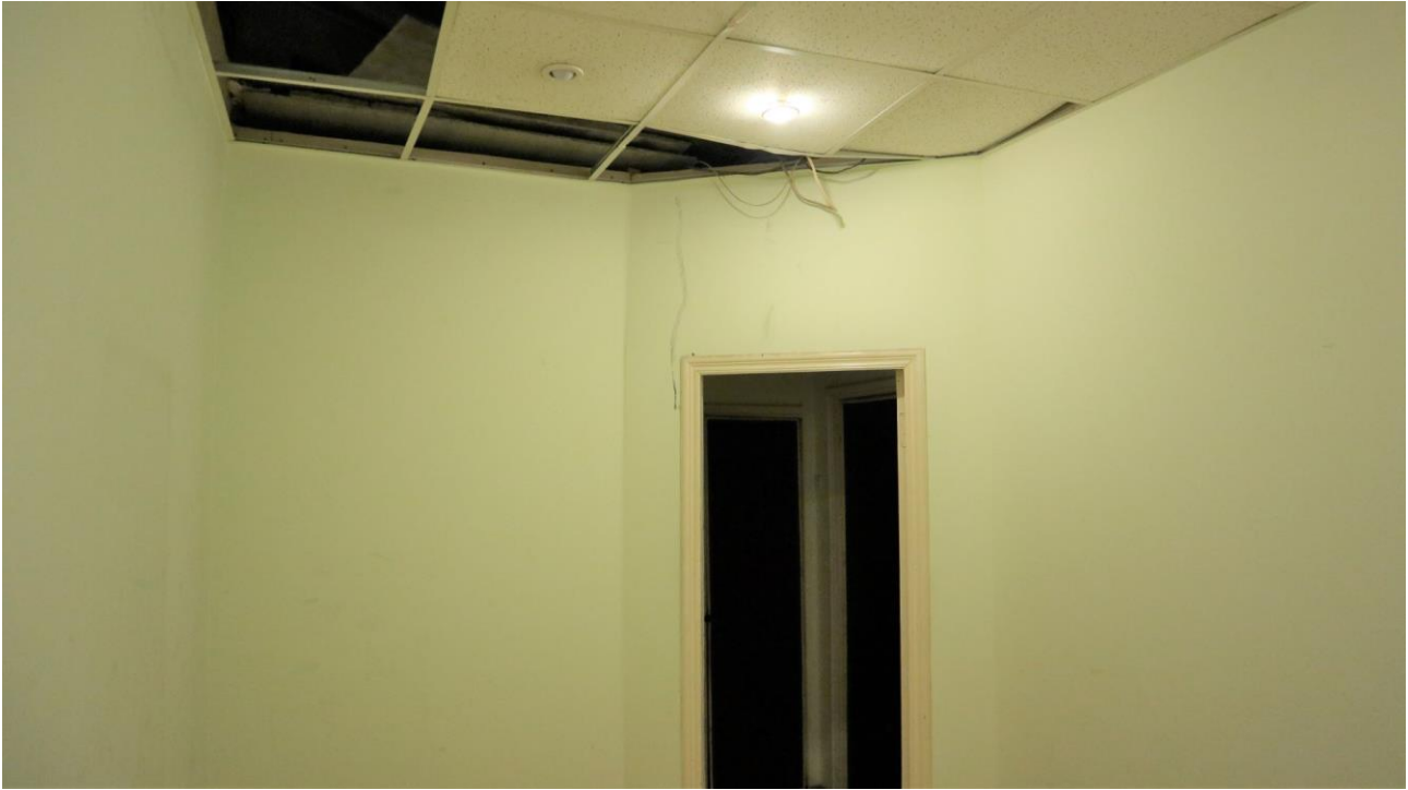
Фото 116. 2 этаж, помещение 20Н (17).
