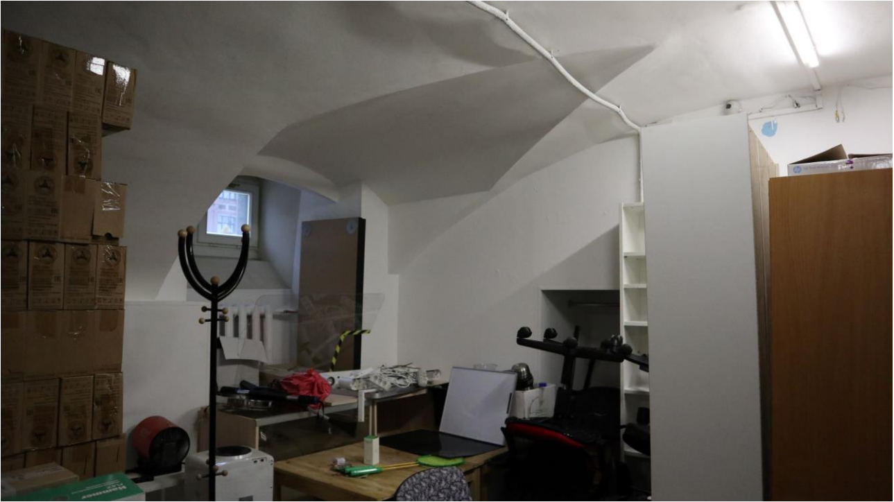
Фото 256. 3 цокольный этаж, коридор, помещение 35Н (3).
