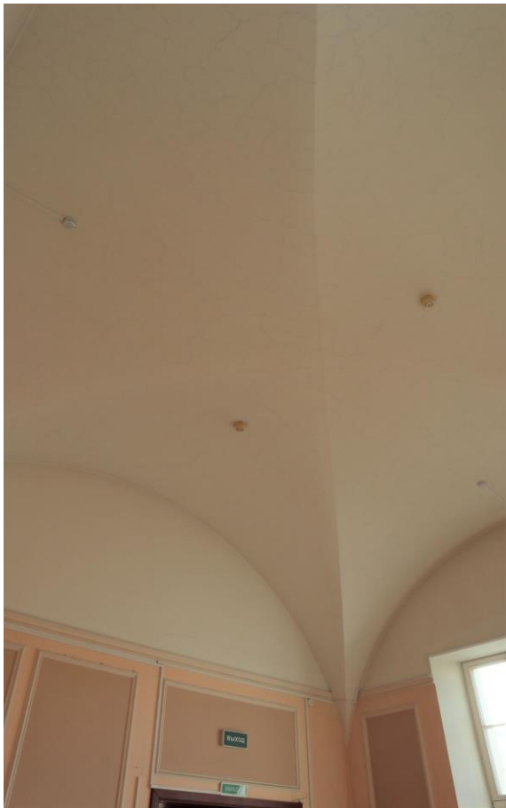
Фото 180. 3 этаж, свод, помещение 28Н (1).
