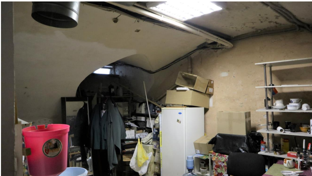
Фото 254. 3 цокольный этаж, коридор, помещение 8Н (6).
