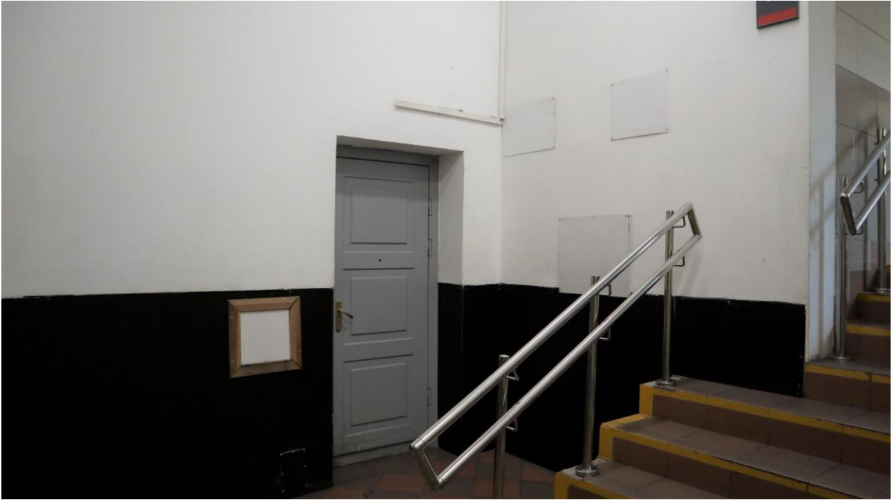
Фото 93. 1 этаж, помещение 9Н (45).
