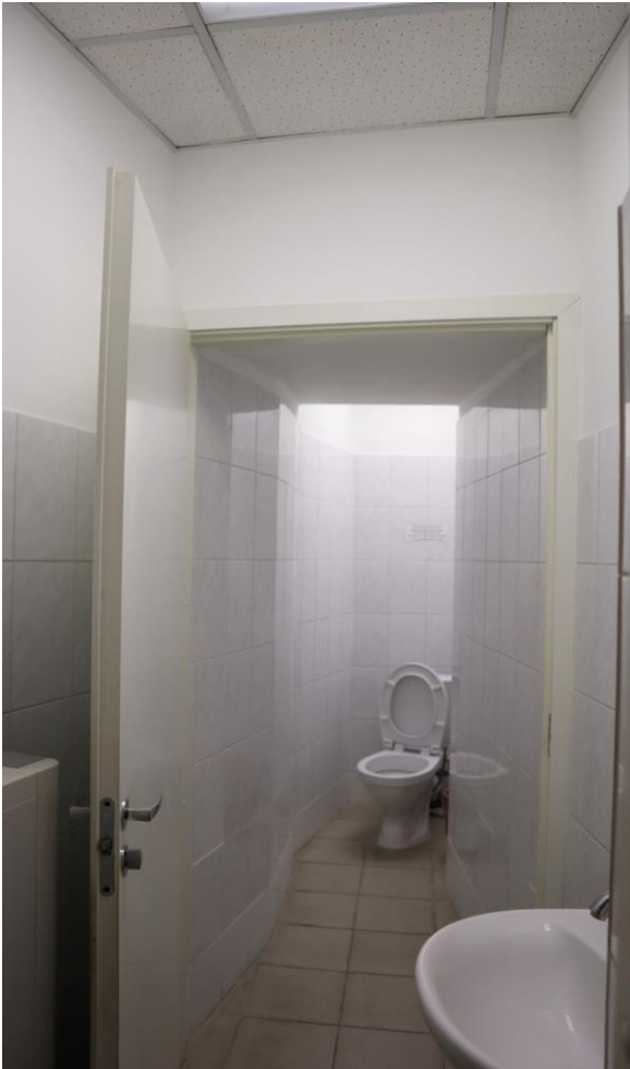
Фото 162. 3 этаж, санузел, помещение 28Н (23).
