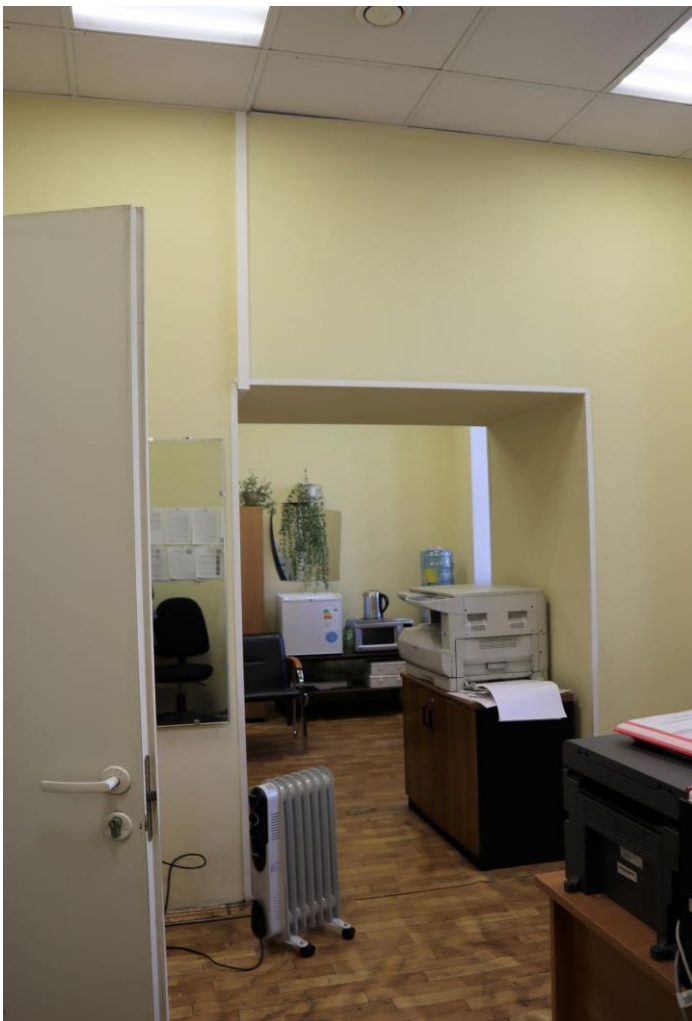
Фото 58. 1 этаж, офисное помещение, 18Н (17).
