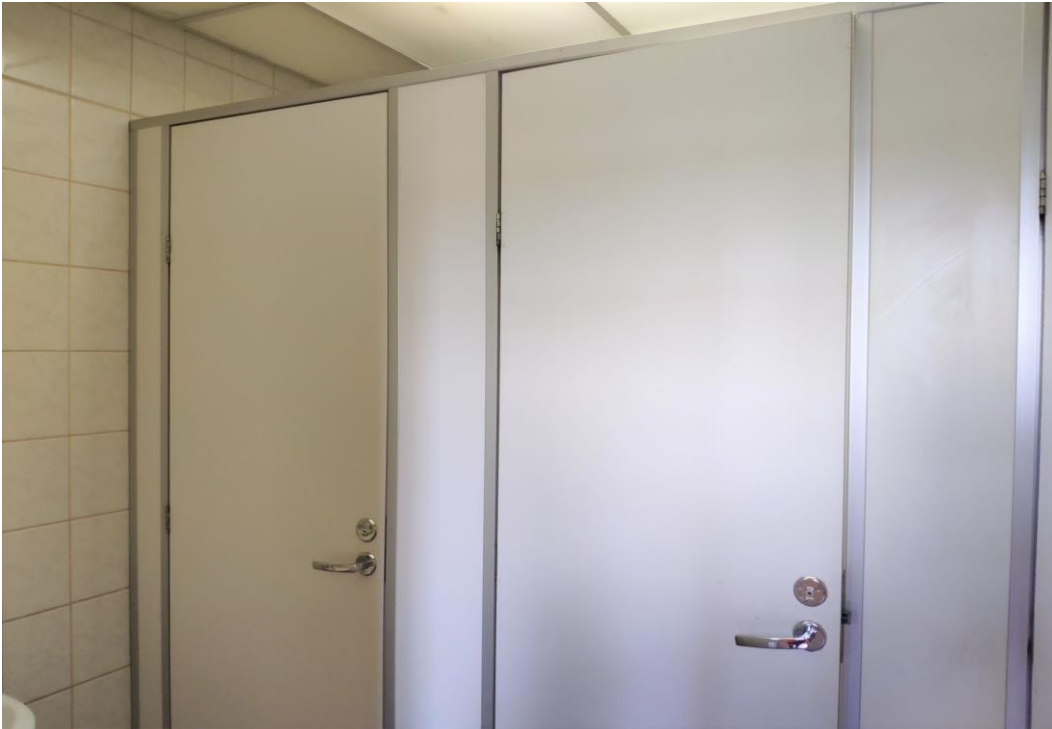
Фото 200. 3 этаж, санузел, помещение 30Н (53).
