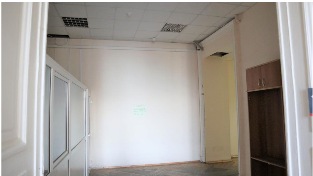
Фото 204. 3 этаж, помещение 30Н (2).
