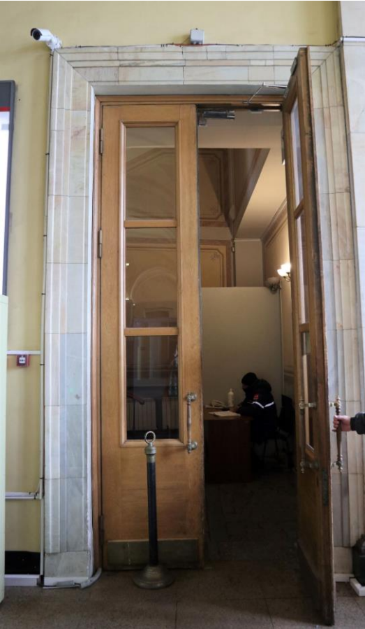
Фото 35. 1 этаж, оформление входного проема в соседнее с вестибюлем 9Н(35) помещение (Л-3).
