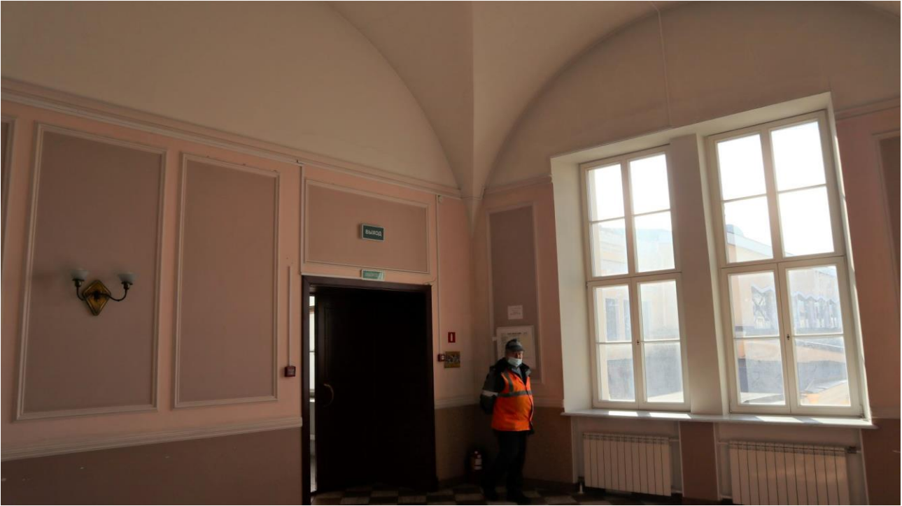
Фото 179. 3 этаж, помещение 28Н (1).
