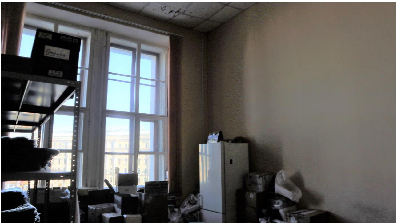
Фото 217. 3 этаж, помещение 30Н (8).
