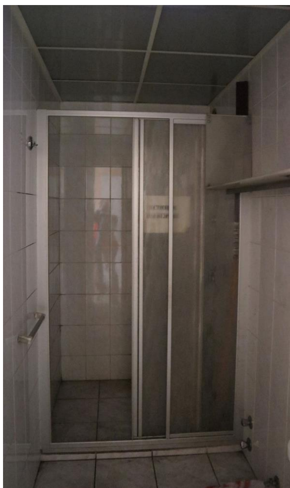
Фото 219. 3 этаж, помещение 30Н (44).
