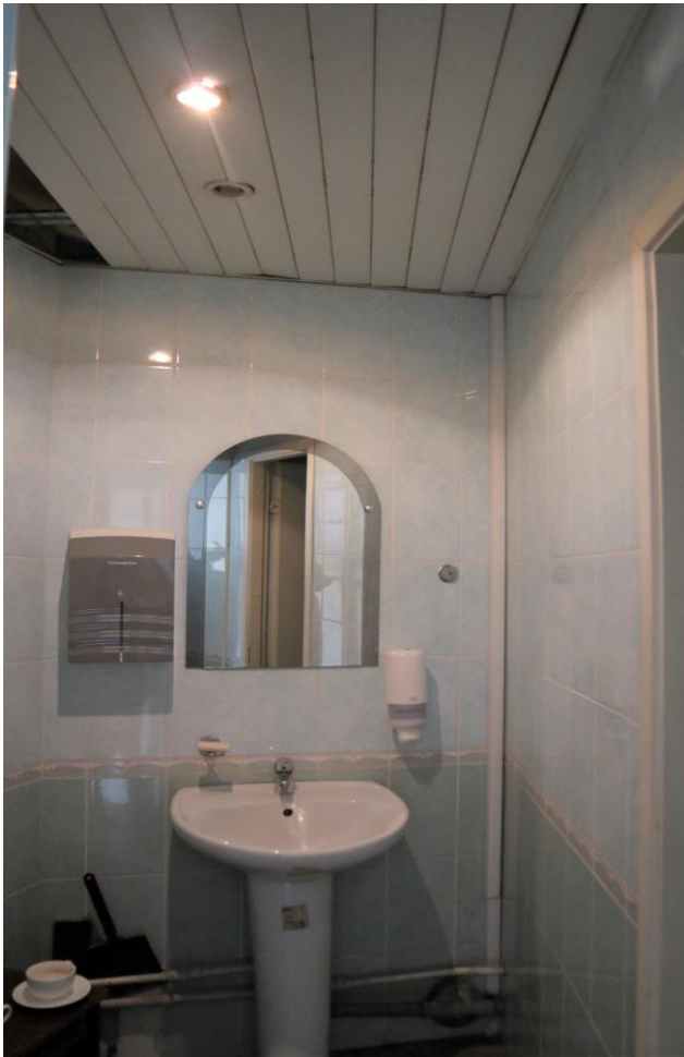
Фото 95. 2 этаж, санузел, помещение 27Н (11).
