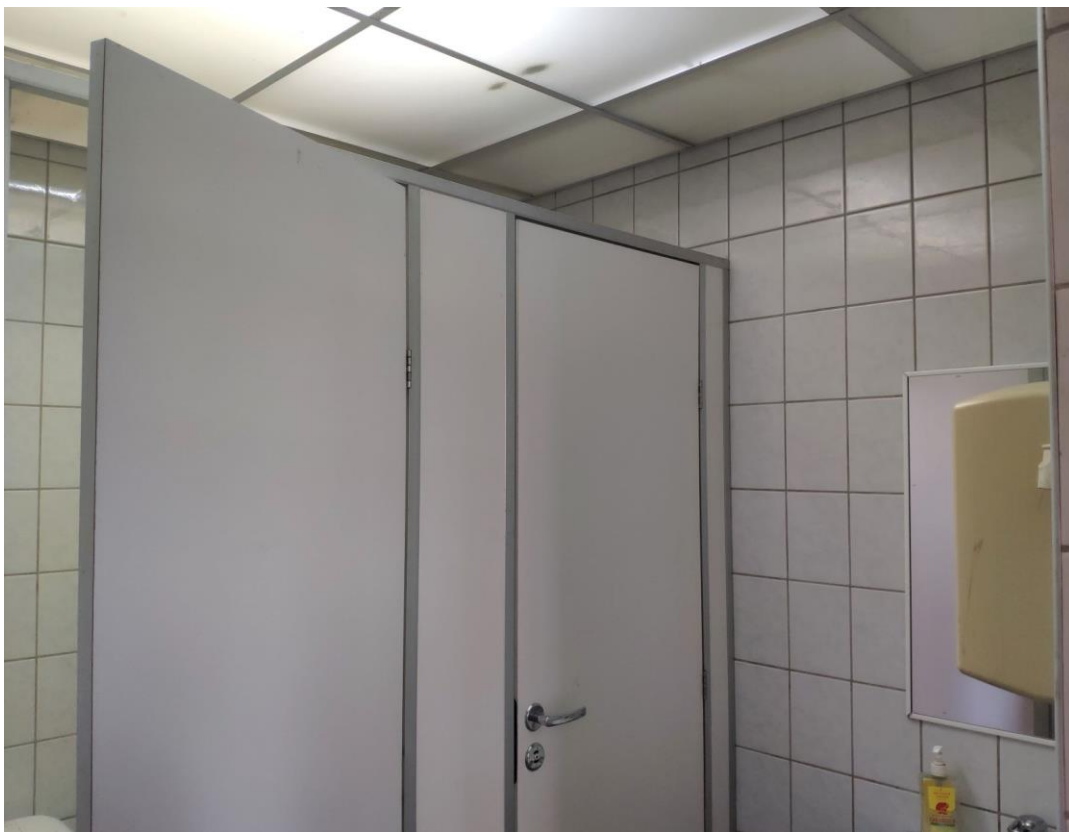
Фото 201. 3 этаж, санузел, помещение 30Н (52).
