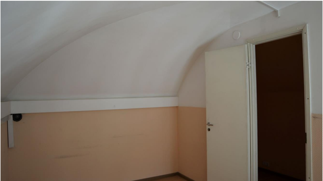
Фото 223. 3 этаж, антресоль над комн. 43, 44, помещение 30Н (46).
