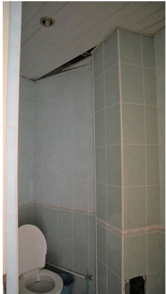
Фото 96. 2 этаж, санузел, помещение 27Н (12).
