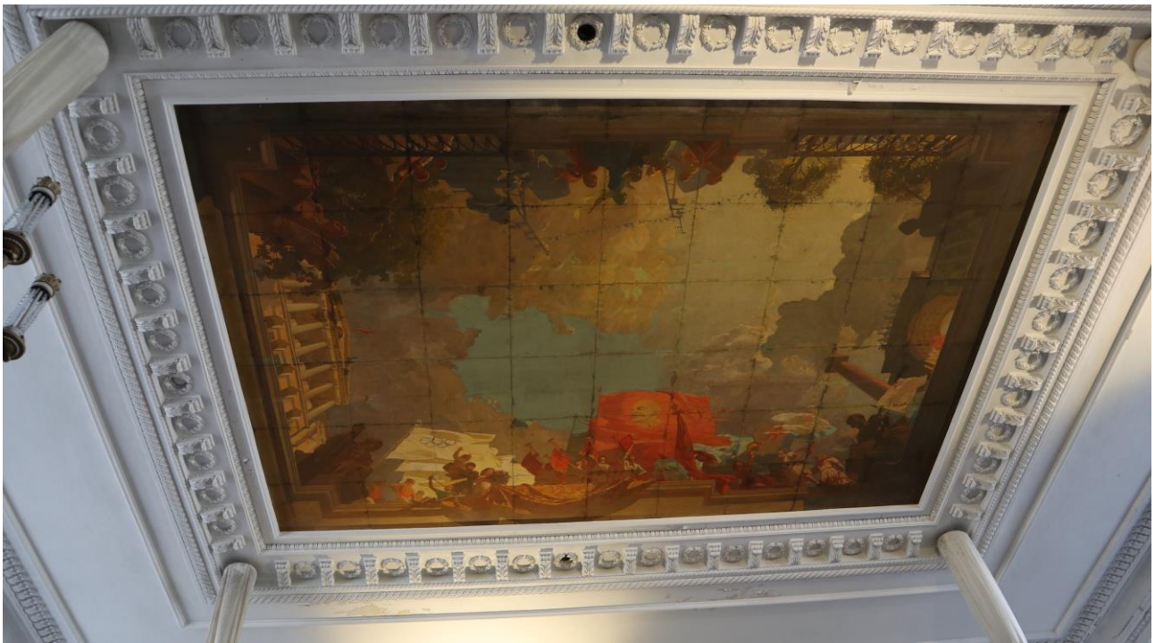
Фото 18. 1 этаж, плафон, Зал ожидания, помещение 9Н (36).
