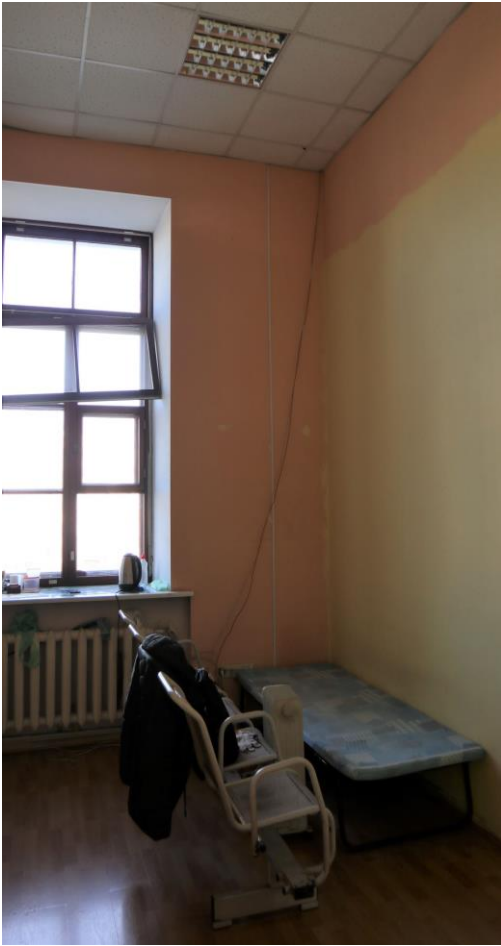
Фото 225. 3 этаж, помещение 30Н (25).
