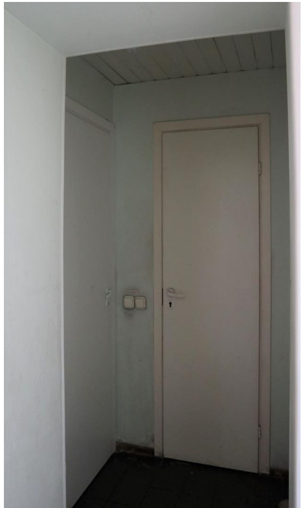
Фото 43. 1 этаж, помещение 18Н (6).
