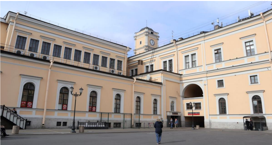
Фото 7. Восточный дворовый фасад.
