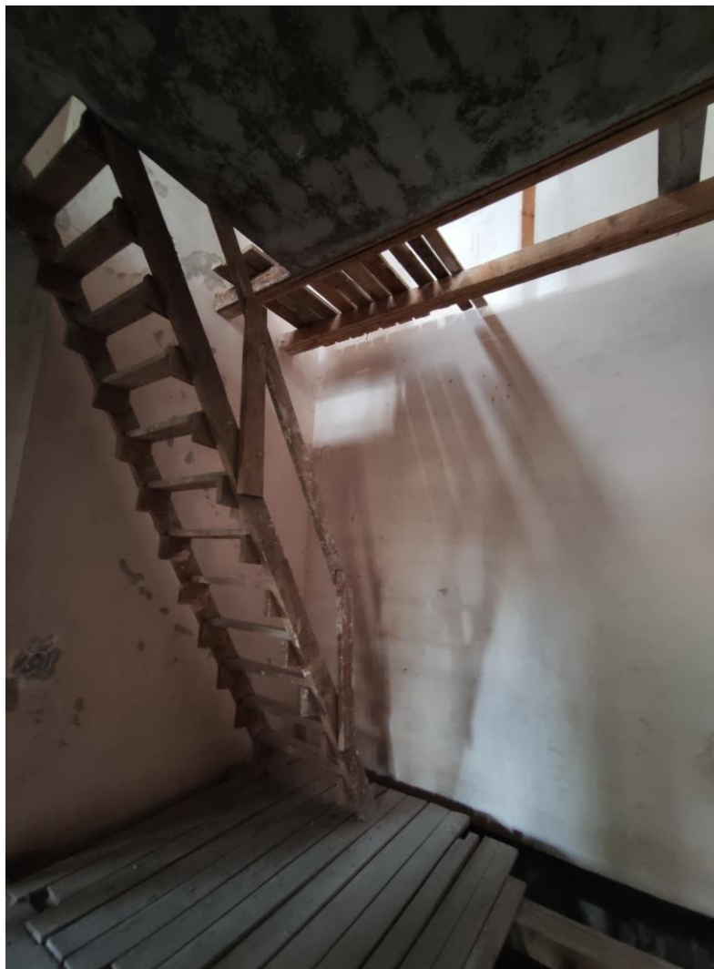
Фото 37. Объект культурного наследия регионального значения «Дачный дом», расположенный по адресу: г. Санкт-Петербург, проспект Энгельса, дом 4, корпус 2, литера А. Фрагмент пом. № 3-Н(6), 1 этаж.
