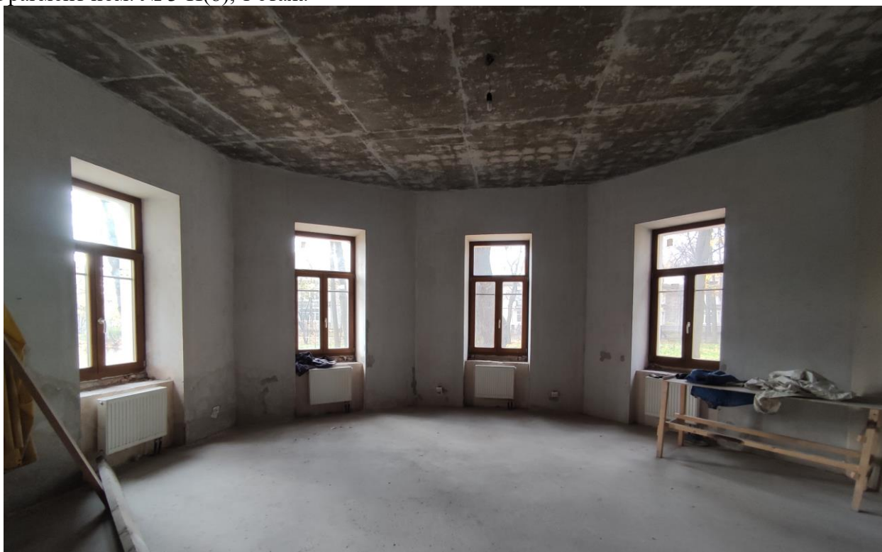
Фото 40. Объект культурного наследия регионального значения «Дачный дом», расположенный по адресу: г. Санкт-Петербург, проспект Энгельса, дом 4, корпус 2, литера А. Общий вид пом. № 3-Н(9), 1 этаж.
