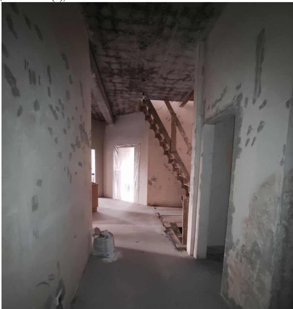
Фото 36. Объект культурного наследия регионального значения «Дачный дом», расположенный по адресу: г. Санкт-Петербург, проспект Энгельса, дом 4, корпус 2, литера А. Фрагмент пом. № 3-Н(6), 1 этаж.
