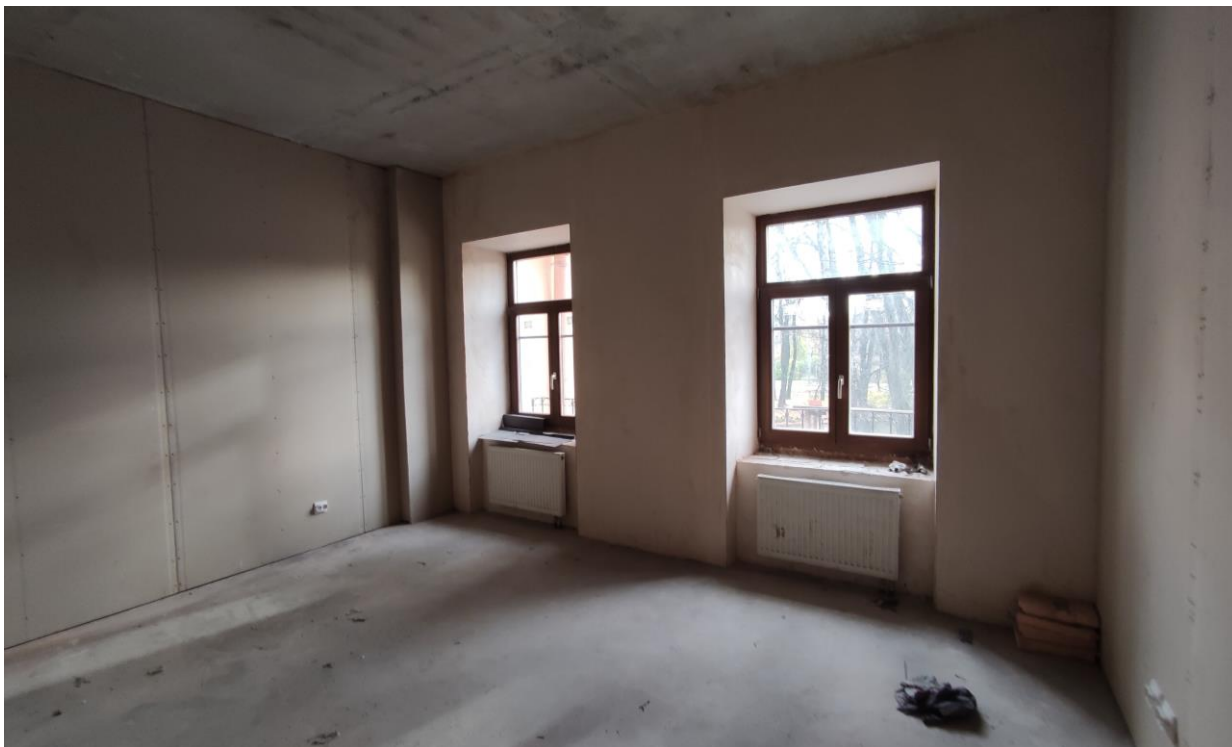
Фото 59. Объект культурного наследия регионального значения «Дачный дом», расположенный по адресу: г. Санкт-Петербург, проспект Энгельса, дом 4, корпус 2, литера А. Общий вид пом. № 3-Н(14), 2 этаж.
