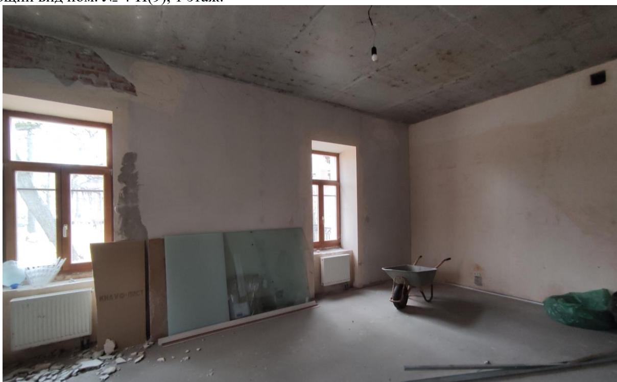
Фото 32. Объект культурного наследия регионального значения «Дачный дом», расположенный по адресу: г. Санкт-Петербург, проспект Энгельса, дом 4, корпус 2, литера А. Общий вид пом. № 4-Н(8), 1 этаж.
