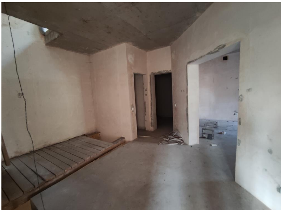
Фото 44. Объект культурного наследия регионального значения «Дачный дом», расположенный по адресу: г. Санкт-Петербург, проспект Энгельса, дом 4, корпус 2, литера А. Фрагмент пом. № 2-Н(12), 2 этаж.
