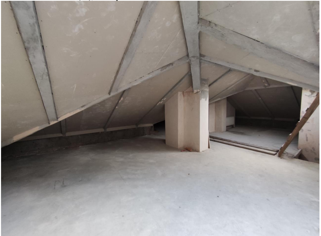
Фото 62. Объект культурного наследия регионального значения «Дачный дом», расположенный по адресу: г. Санкт-Петербург, проспект Энгельса, дом 4, корпус 2, литера А. Общий вид пом. № 2-Н(19), мансарда.
