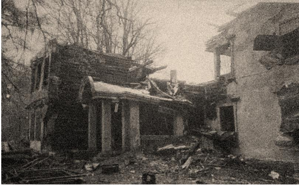
38. Восточный фасад. 1990-е гг. (после пожара). Сектор хранения документированной информации Управления организационного обеспечения и контроля КГИОП.
