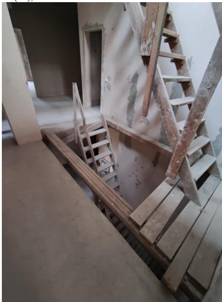
Фото 54. Объект культурного наследия регионального значения «Дачный дом», расположенный по адресу: г. Санкт-Петербург, проспект Энгельса, дом 4, корпус 2, литера А. Фрагмент пом. № 4-Н(13), 2 этаж.
