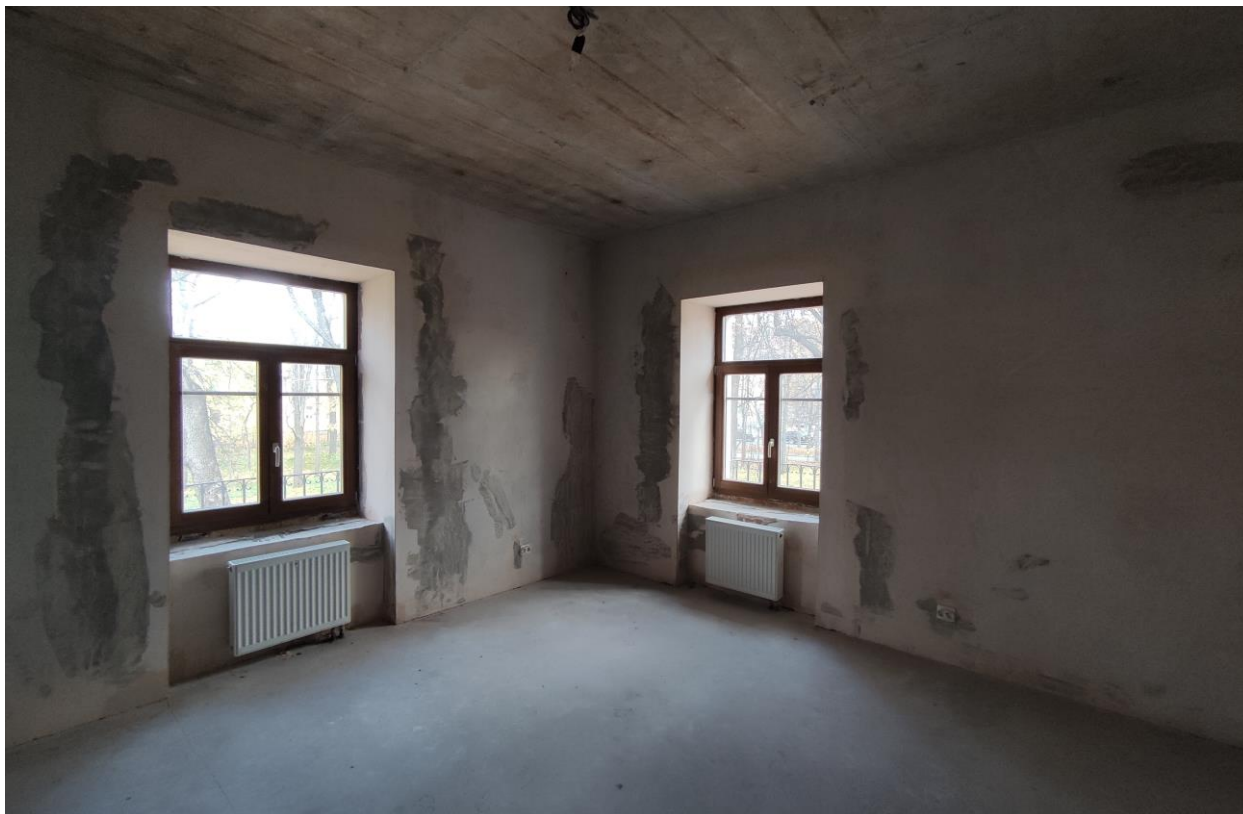
Фото 49. Объект культурного наследия регионального значения «Дачный дом», расположенный по адресу: г. Санкт-Петербург, проспект Энгельса, дом 4, корпус 2, литера А. Общий вид пом. № 4-Н(17), 2 этаж.
