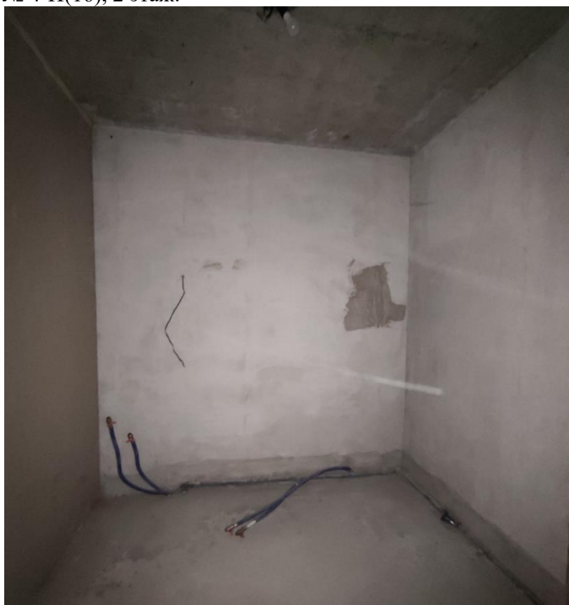
Фото 52. Объект культурного наследия регионального значения «Дачный дом», расположенный по адресу: г. Санкт-Петербург, проспект Энгельса, дом 4, корпус 2, литера А. Общий вид пом. № 4-Н(15), 2 этаж.
