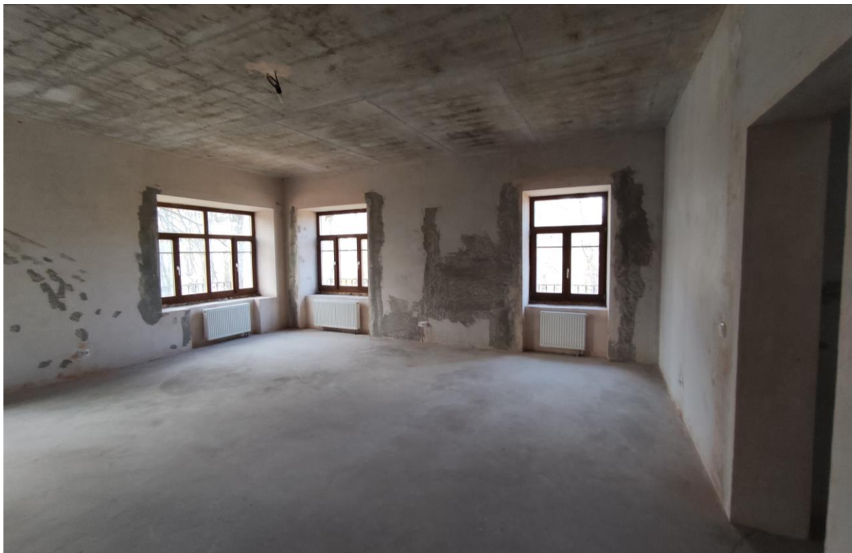
Фото 53. Объект культурного наследия регионального значения «Дачный дом», расположенный по адресу: г. Санкт-Петербург, проспект Энгельса, дом 4, корпус 2, литера А. Общий вид пом. № 4-Н(14), 2 этаж.
