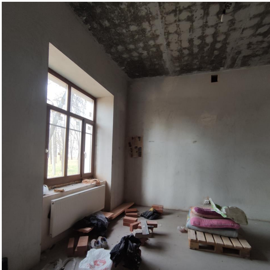
Фото 41. Объект культурного наследия регионального значения «Дачный дом», расположенный по адресу: г. Санкт-Петербург, проспект Энгельса, дом 4, корпус 2, литера А. Фрагмент пом. № 3-Н(10), 1 этаж.
