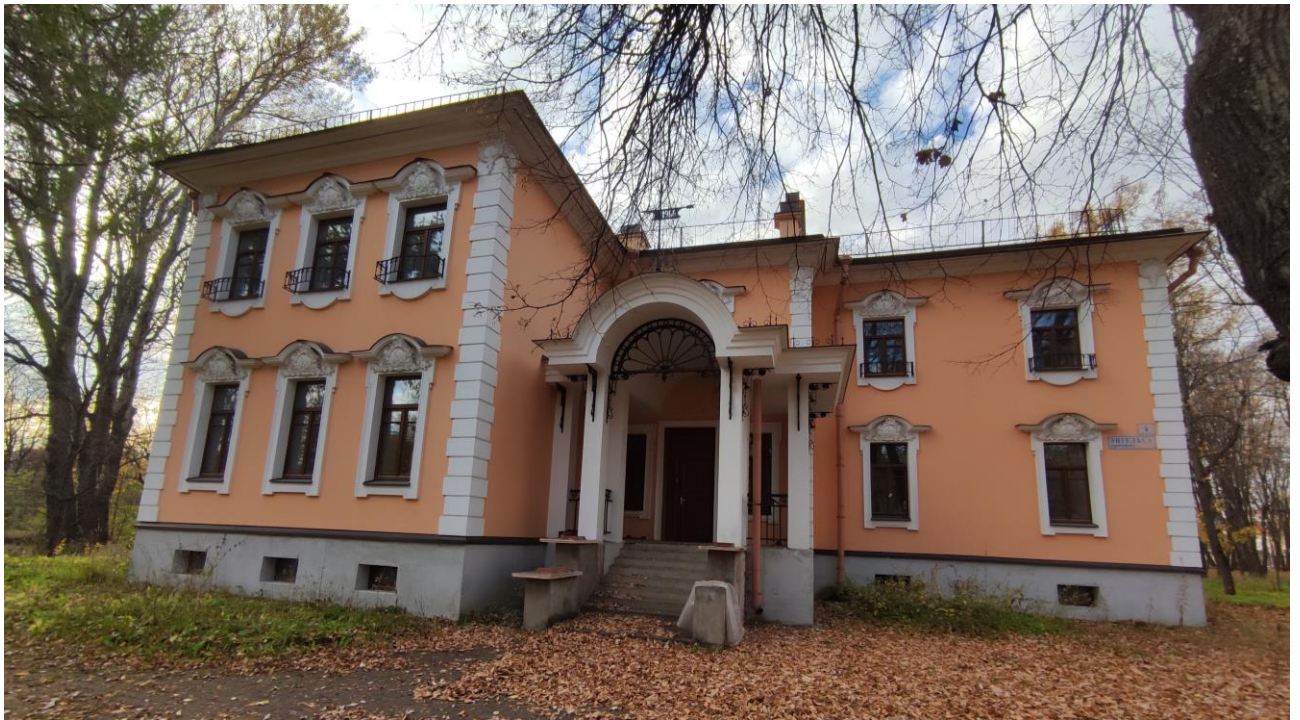
Фото 1. Объект культурного наследия регионального значения «Дачный дом», расположенный по адресу: г. Санкт-Петербург, проспект Энгельса, дом 4, корпус 2, литера А, входящий в состав объекта культурного наследия регионального значения «Дом Ланских (комплекс с парком в границах Б. Сампсониевского пр., 108 до пр. Энгельса, 6 и Октябрьской ж.д., с двумя прудами и оградой)», расположенного по адресу Санкт-Петербург, Энгельса пр., 4. 1 Общий вид восточного фасада.
