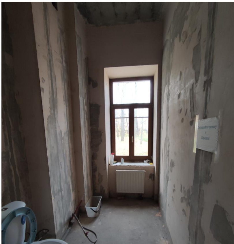
Фото 33. Объект культурного наследия регионального значения «Дачный дом», расположенный по адресу: г. Санкт-Петербург, проспект Энгельса, дом 4, корпус 2, литера А. Общий вид пом. № 4-Н(11), 1 этаж.
