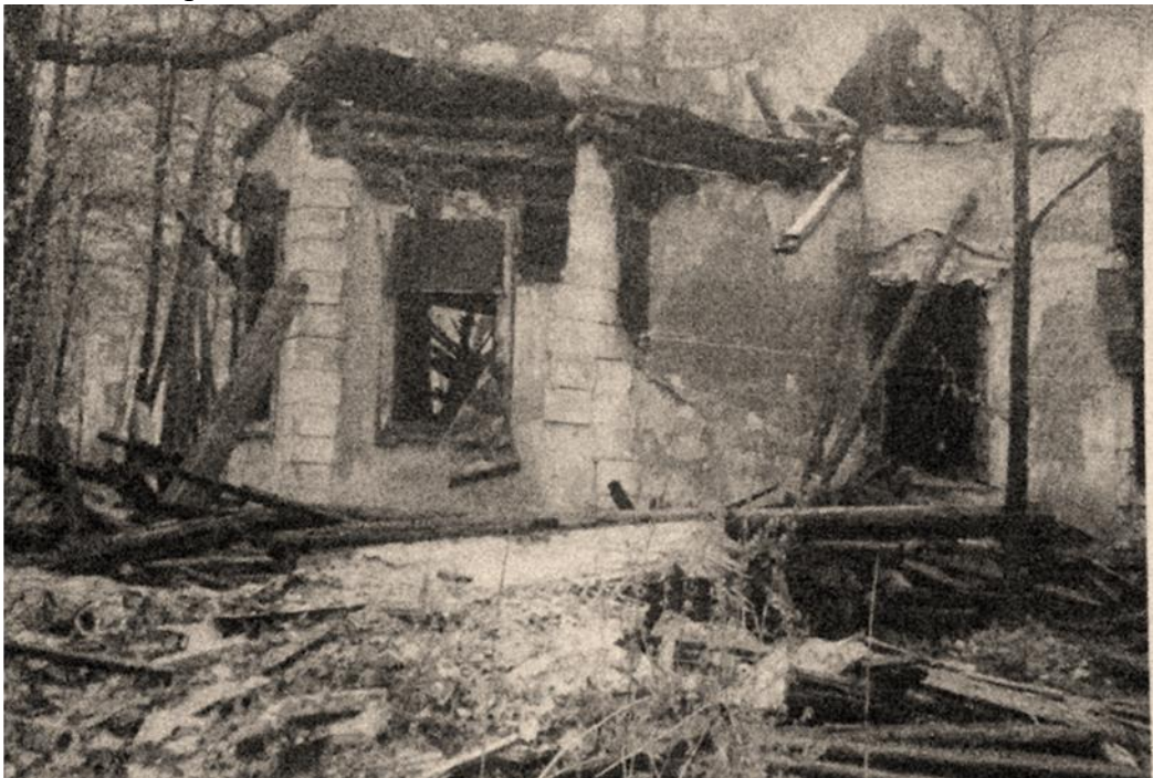
39. Южный фасад. 1990-е гг. (после пожара). Сектор хранения документированной информации Управления организационного обеспечения и контроля КГИОП.
