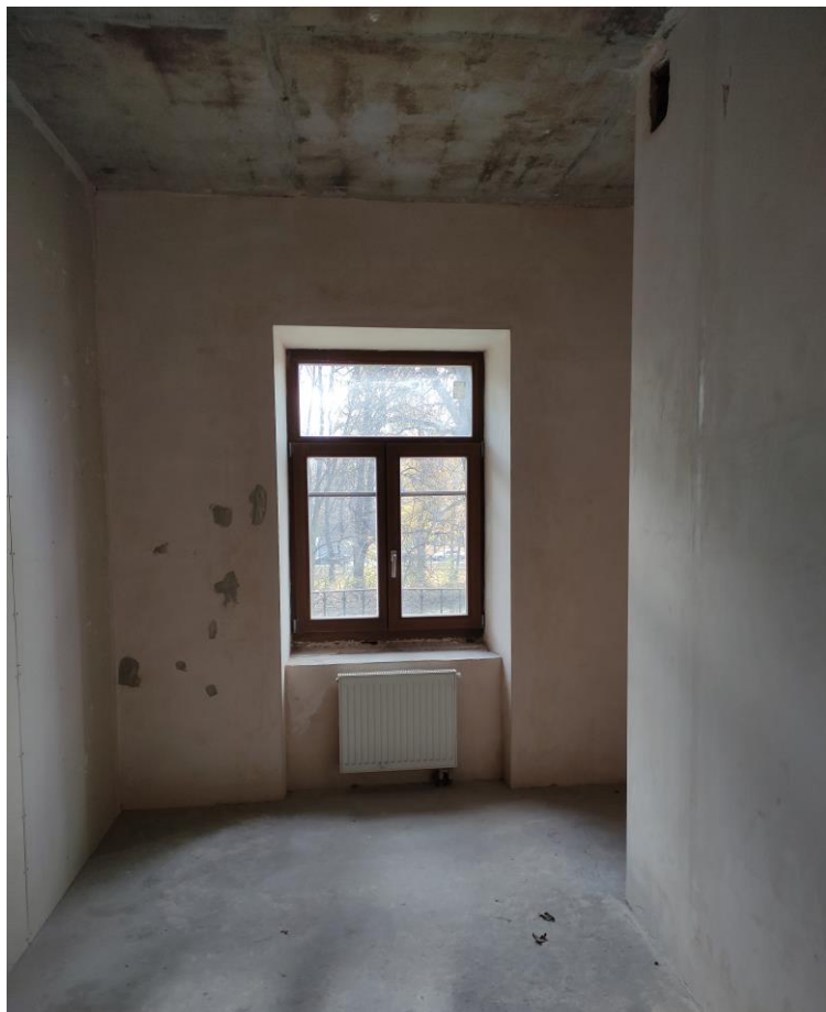
Фото 45. Объект культурного наследия регионального значения «Дачный дом», расположенный по адресу: г. Санкт-Петербург, проспект Энгельса, дом 4, корпус 2, литера А. Общий вид пом. № 2-Н(17), 2 этаж.
