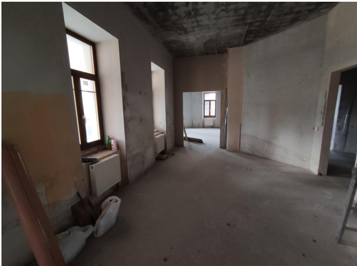
Фото 39. Объект культурного наследия регионального значения «Дачный дом», расположенный по адресу: г. Санкт-Петербург, проспект Энгельса, дом 4, корпус 2, литера А. Фрагмент пом. № 3-Н(8), 1 этаж.
