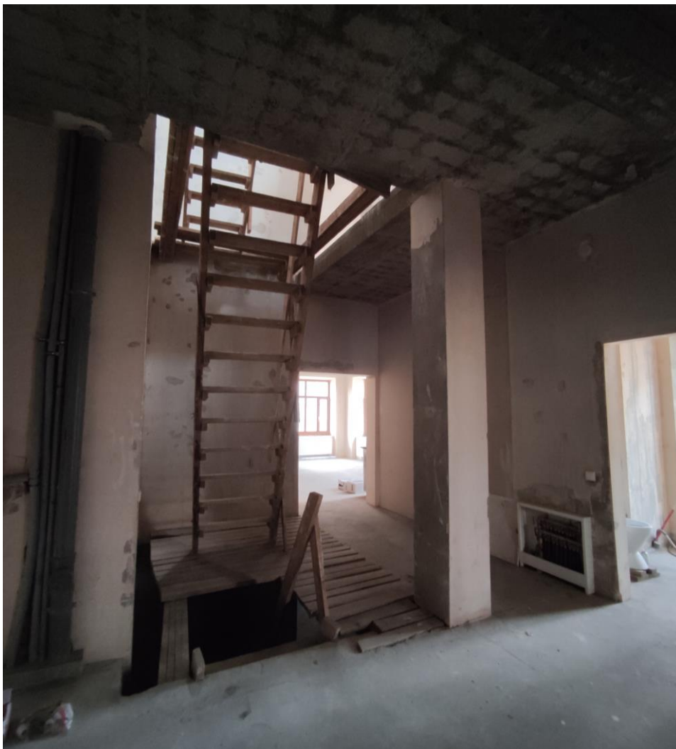
Фото 31. Объект культурного наследия регионального значения «Дачный дом», расположенный по адресу: г. Санкт-Петербург, проспект Энгельса, дом 4, корпус 2, литера А. Общий вид пом. № 4-Н(9), 1 этаж.
