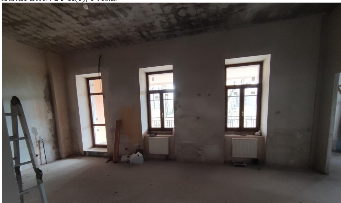
Фото 38. Объект культурного наследия регионального значения «Дачный дом», расположенный по адресу: г. Санкт-Петербург, проспект Энгельса, дом 4, корпус 2, литера А. Фрагмент пом. № 3-Н(8), 1 этаж.
