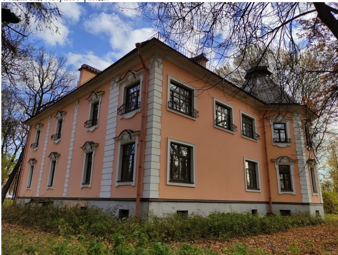
Фото 4. Объект культурного наследия регионального значения «Дачный дом», расположенный по адресу: г. Санкт-Петербург, проспект Энгельса, дом 4, корпус 2, литера А. Общий вид северного и западного фасадов.
