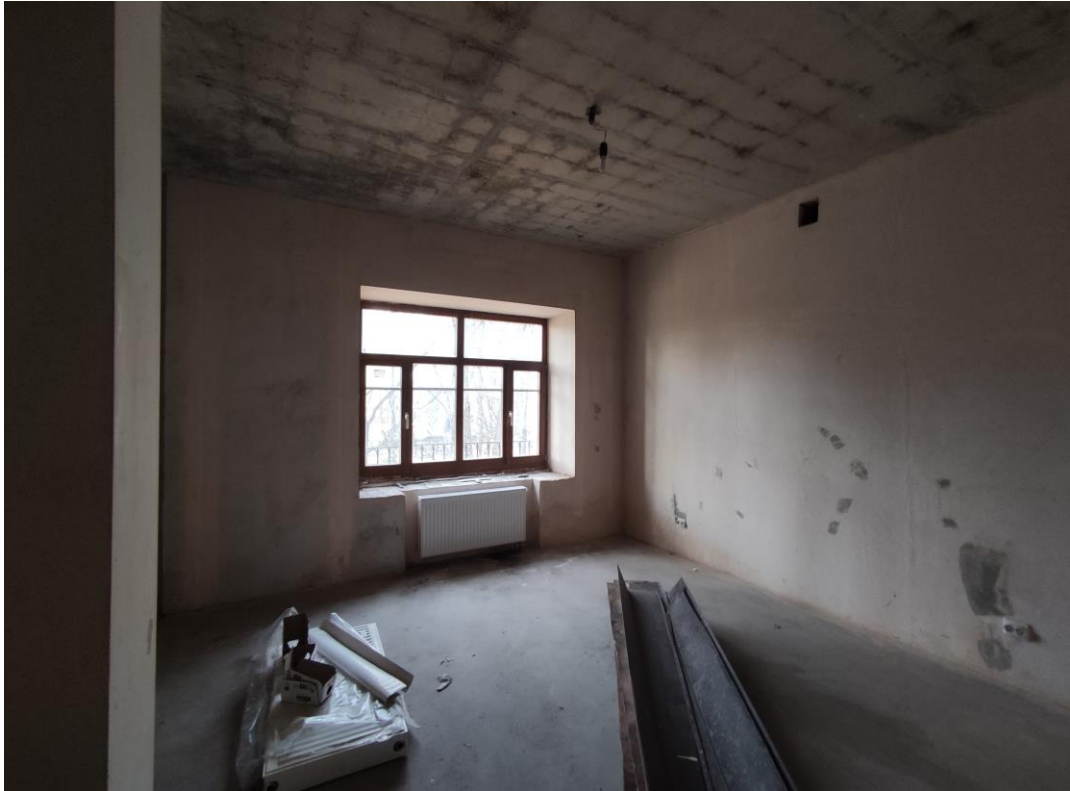
Фото 55. Объект культурного наследия регионального значения «Дачный дом», расположенный по адресу: г. Санкт-Петербург, проспект Энгельса, дом 4, корпус 2, литера А. Общий вид пом. № 3-Н(17), 2 этаж.
