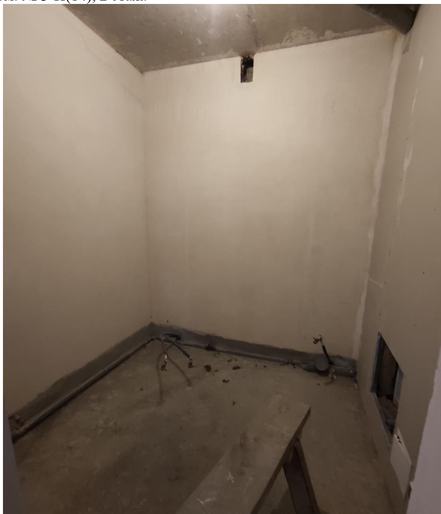
Фото 60. Объект культурного наследия регионального значения «Дачный дом», расположенный по адресу: г. Санкт-Петербург, проспект Энгельса, дом 4, корпус 2, литера А. Общий вид пом. № 3-Н(13), 2 этаж.
