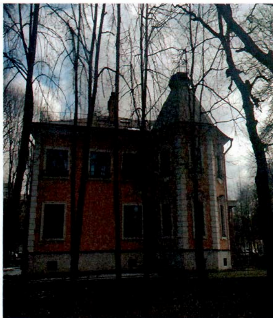
5. Общий вид (западный фасад).
