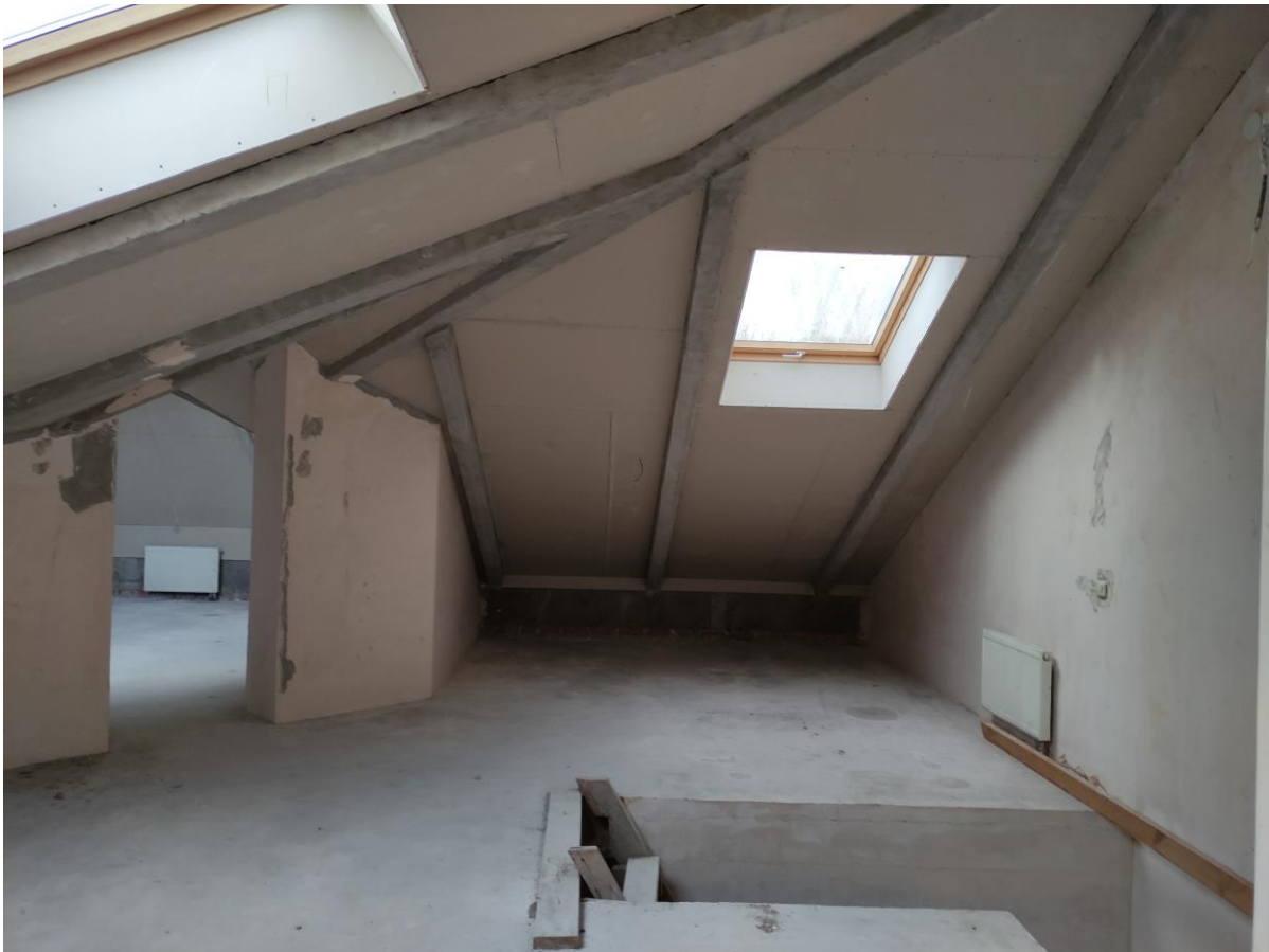
Фото 67. Объект культурного наследия регионального значения «Дачный дом», расположенный по адресу: г. Санкт-Петербург, проспект Энгельса, дом 4, корпус 2, литера А. Общий вид пом. № 3-Н(18), мансарда.
