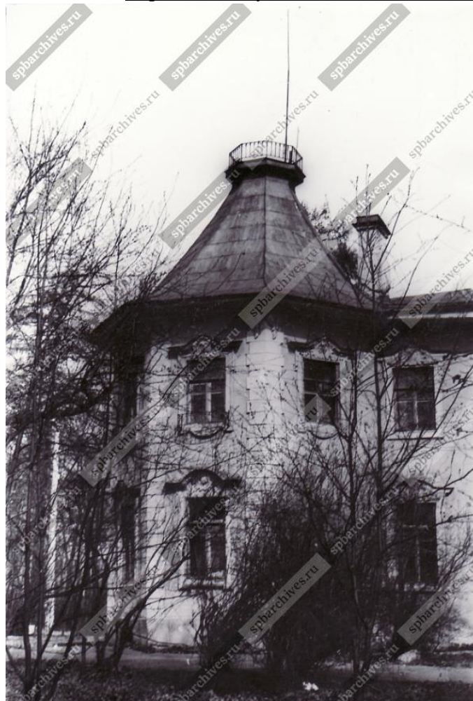
21. Вид со стороны парка части фасада № 4 на проспекте Энгельса. Фотография 1980 г. ЦГАКФФД СПб. Шифр: Ар 224717
