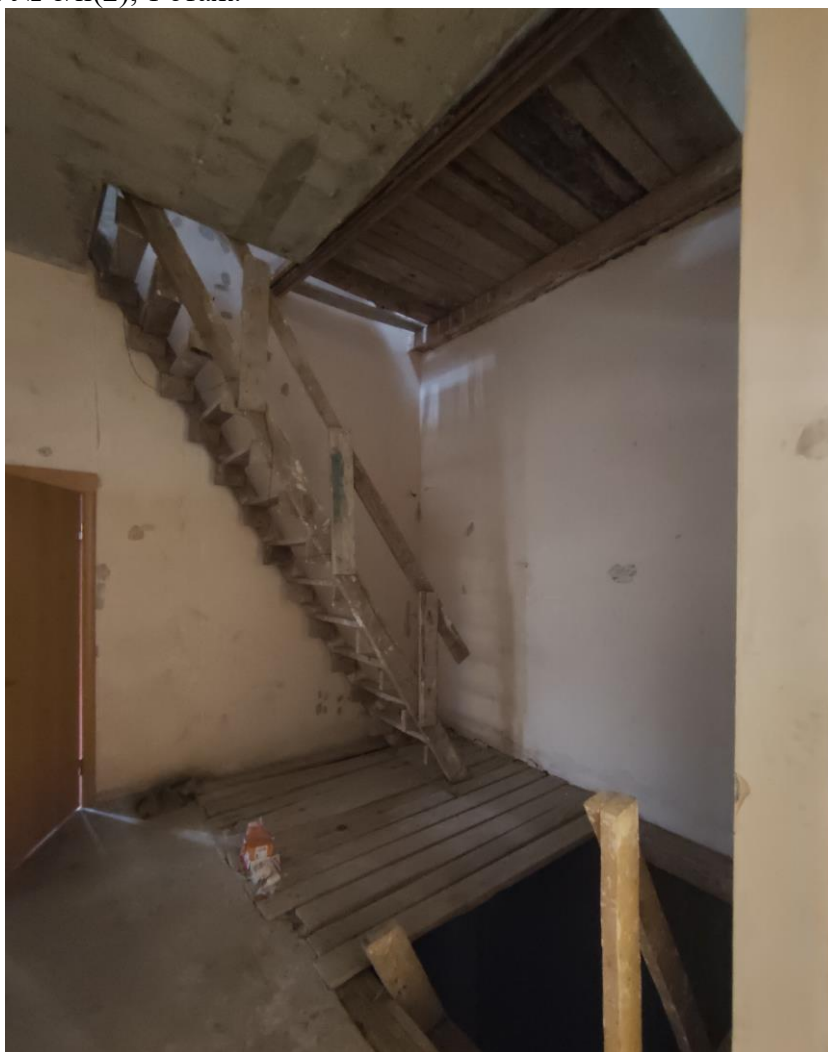
Фото 28. Объект культурного наследия регионального значения «Дачный дом», расположенный по адресу: г. Санкт-Петербург, проспект Энгельса, дом 4, корпус 2, литера А. Общий вид пом. № 2-Н(8), 1 этаж.
