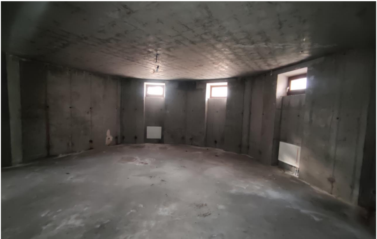
Фото 9. Объект культурного наследия регионального значения «Дачный дом», расположенный по адресу: г. Санкт-Петербург, проспект Энгельса, дом 4, корпус 2, литера А. Фрагмент пом. № 3-Н(5), подвал.
