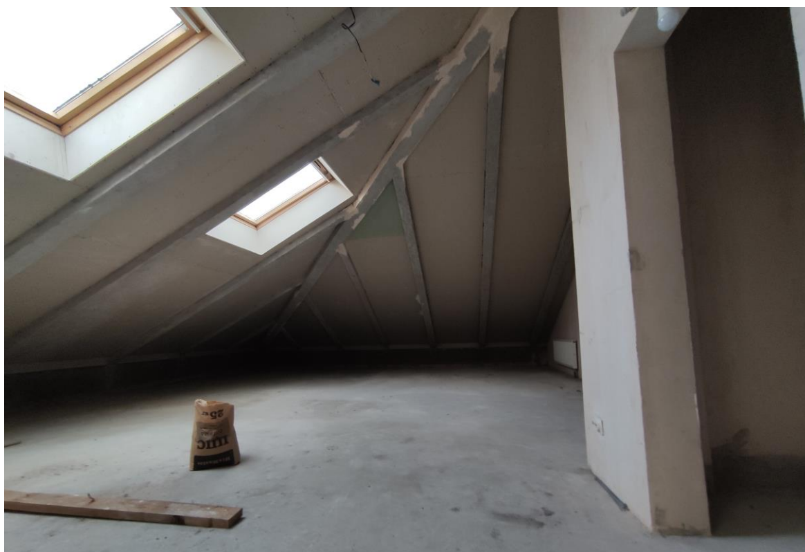
Фото 64. Объект культурного наследия регионального значения «Дачный дом», расположенный по адресу: г. Санкт-Петербург, проспект Энгельса, дом 4, корпус 2, литера А. Фрагмент вид пом. № 4-Н(20), мансарда.
