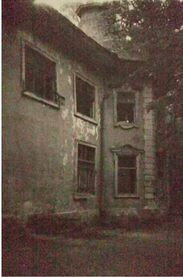
32. Западный фасад здания. 1990-е гг. (до пожара). Сектор хранения документированной информации Управления организационного обеспечения и контроля КГИОП.
