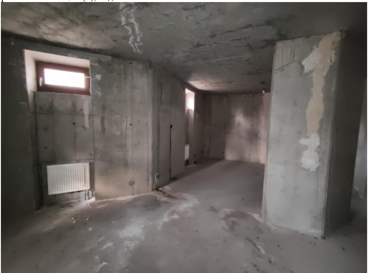
Фото 10. Объект культурного наследия регионального значения «Дачный дом», расположенный по адресу: г. Санкт-Петербург, проспект Энгельса, дом 4, корпус 2, литера А. Фрагмент пом. № 3-Н(5), подвал.
