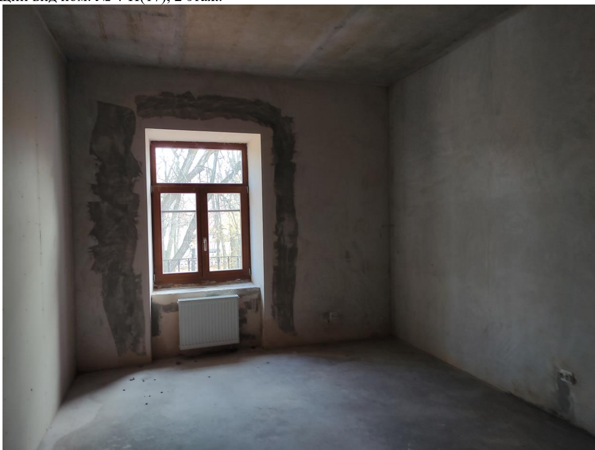
Фото 50. Объект культурного наследия регионального значения «Дачный дом», расположенный по адресу: г. Санкт-Петербург, проспект Энгельса, дом 4, корпус 2, литера А. Общий вид пом. № 4-Н(18), 2 этаж.
