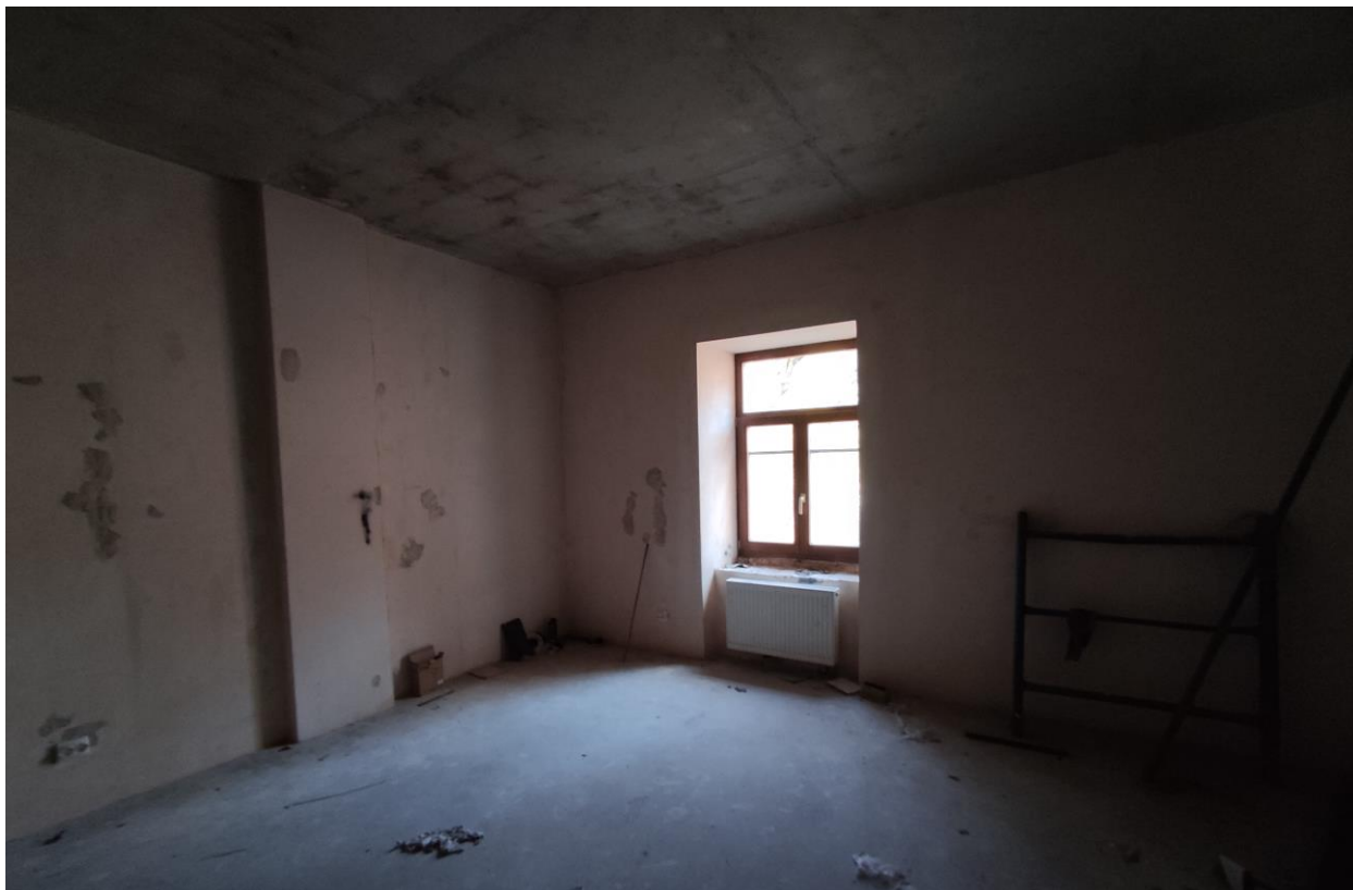
Фото 47. Объект культурного наследия регионального значения «Дачный дом», расположенный по адресу: г. Санкт-Петербург, проспект Энгельса, дом 4, корпус 2, литера А. Общий вид пом. № 2-Н(15), 2 этаж.
