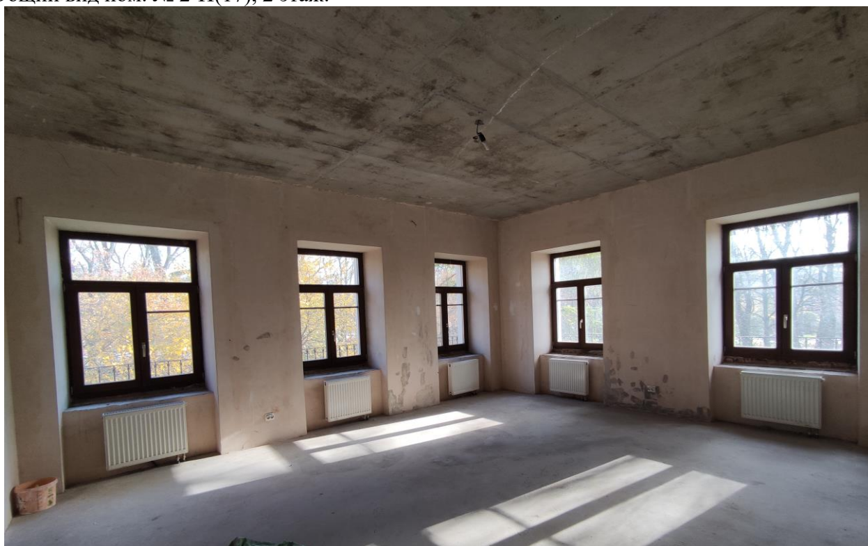
Фото 46. Объект культурного наследия регионального значения «Дачный дом», расположенный по адресу: г. Санкт-Петербург, проспект Энгельса, дом 4, корпус 2, литера А. Общий вид пом. № 2-Н(16), 2 этаж.
