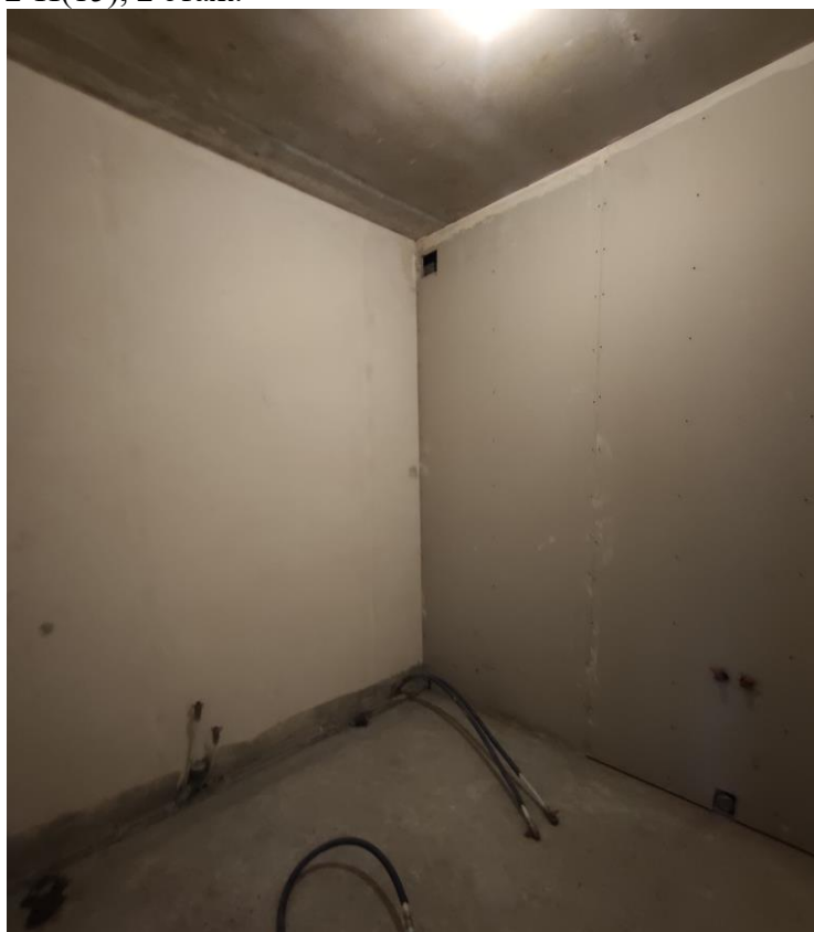
Фото 48. Объект культурного наследия регионального значения «Дачный дом», расположенный по адресу: г. Санкт-Петербург, проспект Энгельса, дом 4, корпус 2, литера А. Общий вид пом. № 2-Н(14), 2 этаж.
