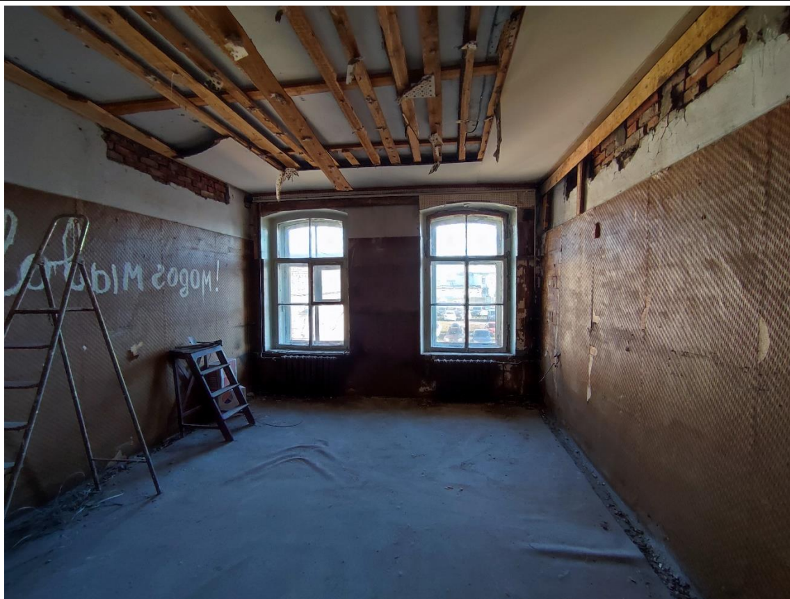
22. Общий вид пом. 5-Н (17) в уровне 2-го этажа.
