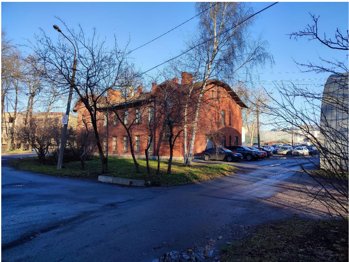
1. Общий вид объекта культурного наследия регионального значения «Жилой дом для персонала» с юго-запада.
