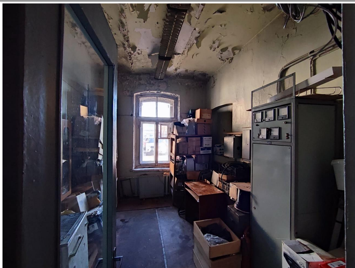
11. Общий вид пом. 1-Н (5) в уровне 1-го этажа.
