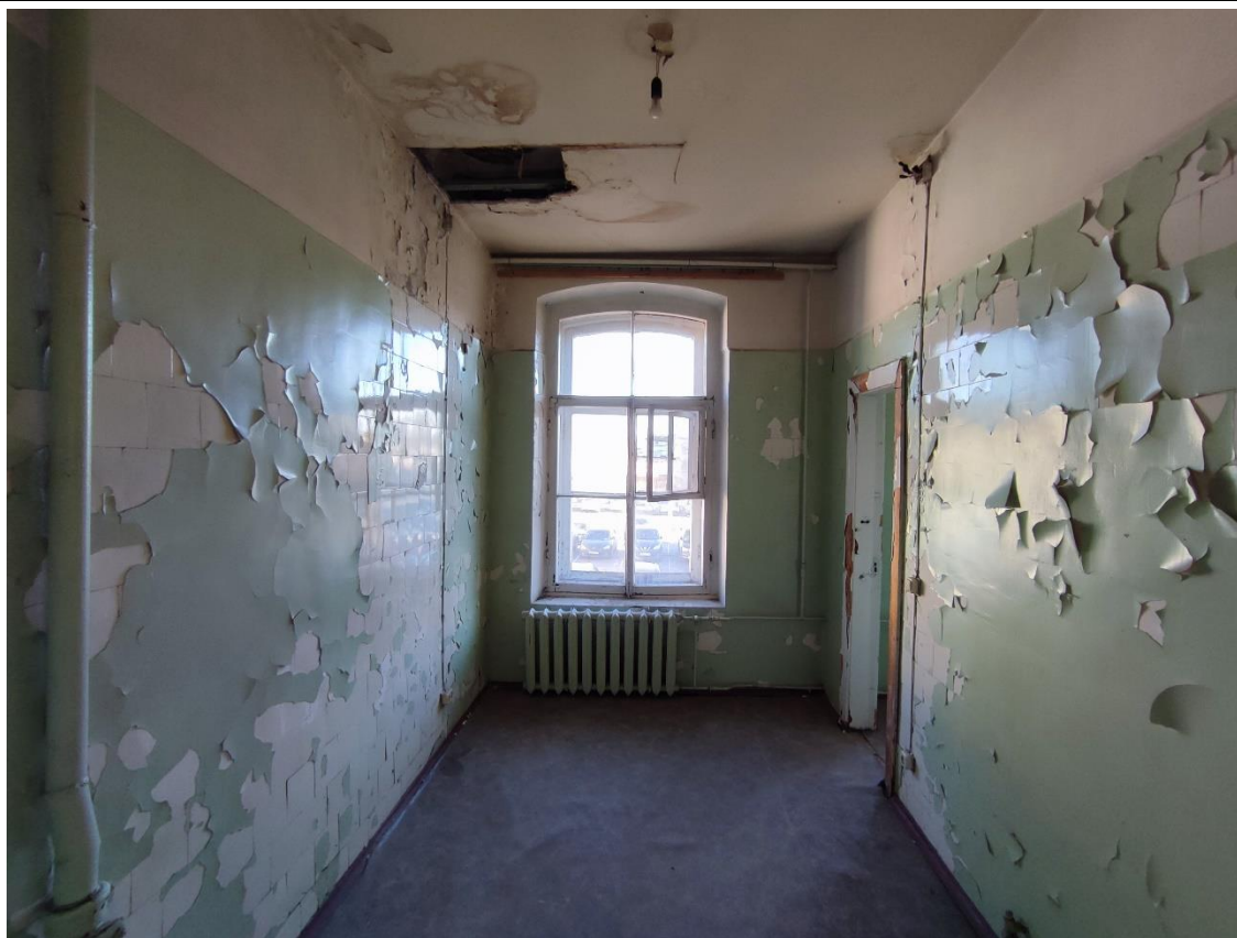
25. Фрагмент пом. 5-Н (4) в уровне 2-го этажа.
