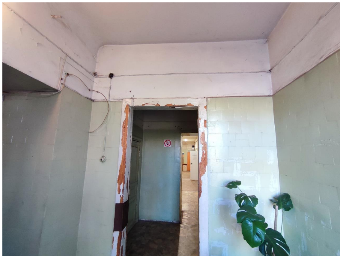
15. Общий вид пом. 5-Н (16) в уровне 2-го этажа.
