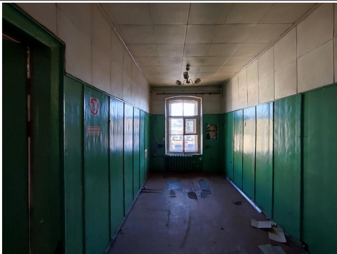
23. Общий вид пом. 5-Н (18) в уровне 2-го этажа.
