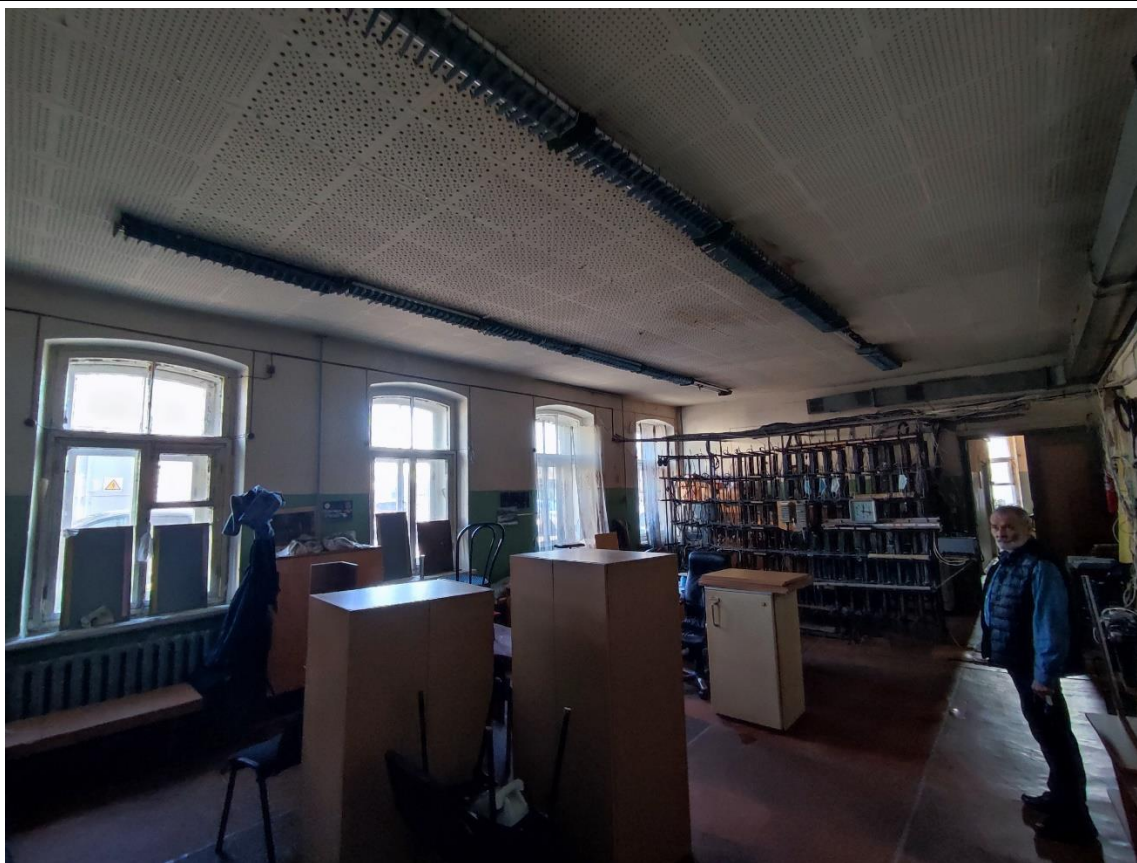
10. Общий вид пом. 1-Н (1, 2, 3, 4) в уровне 1-го этажа.
