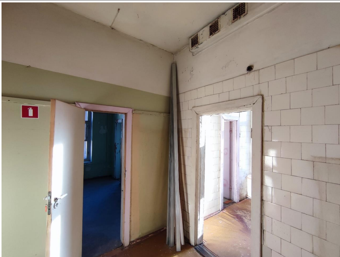
24. Фрагмент пом. 5-Н (4) в уровне 2-го этажа.
