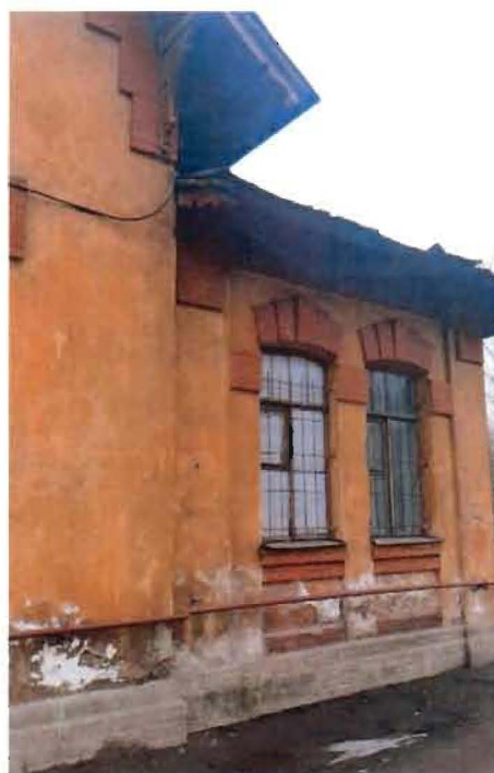
5. Фрагмент северного фасада
