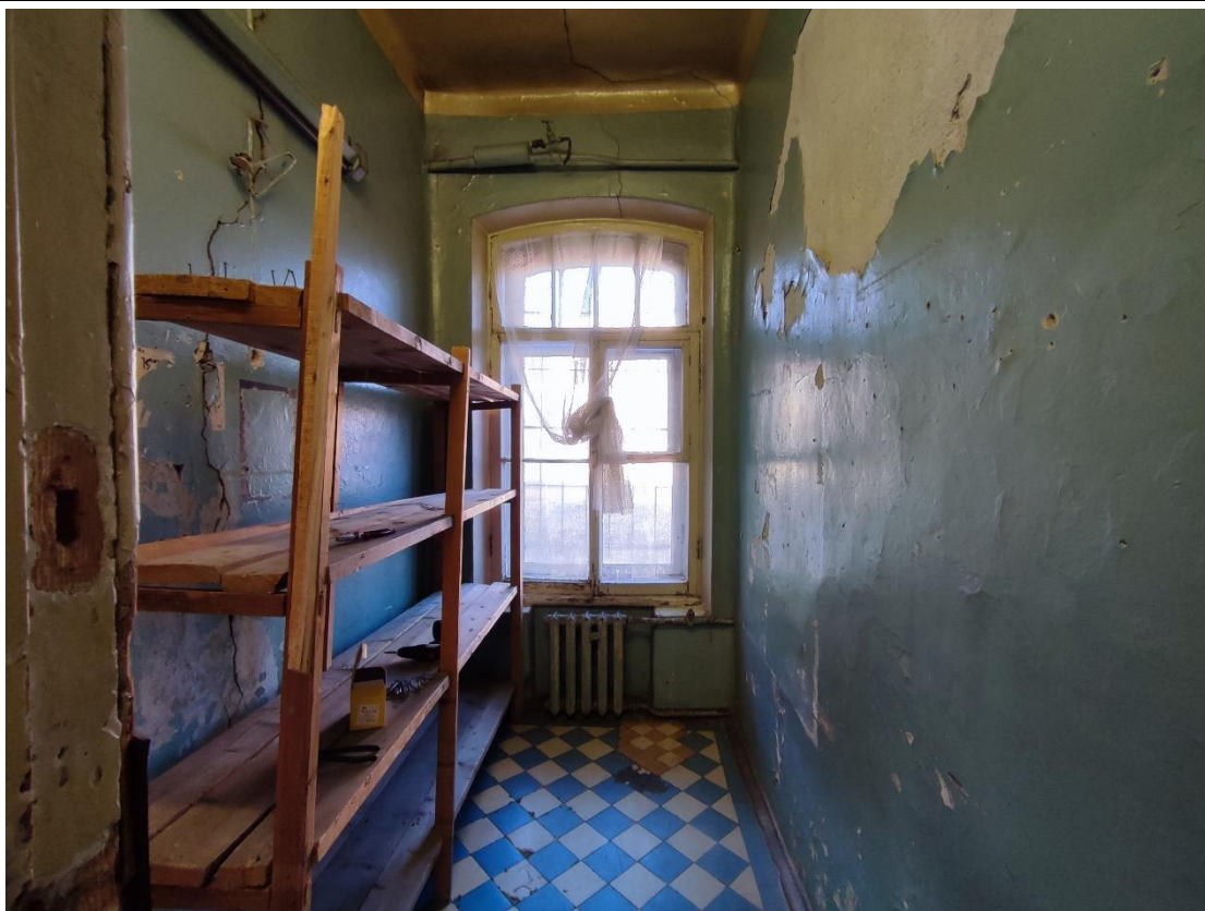
19. Общий вид помещения 1-Н (30) в уровне 1-го этажа.
