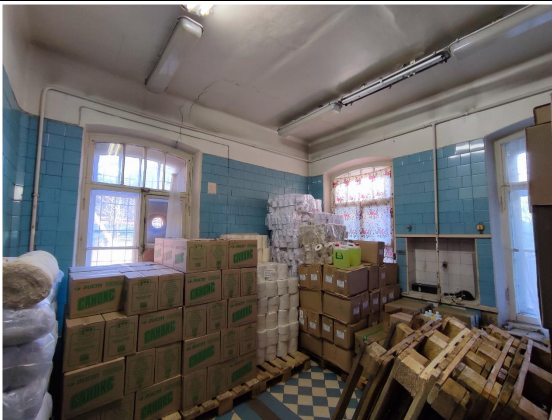
16. Общий вид помещения 1-Н (5) в уровне 1-го этажа.
