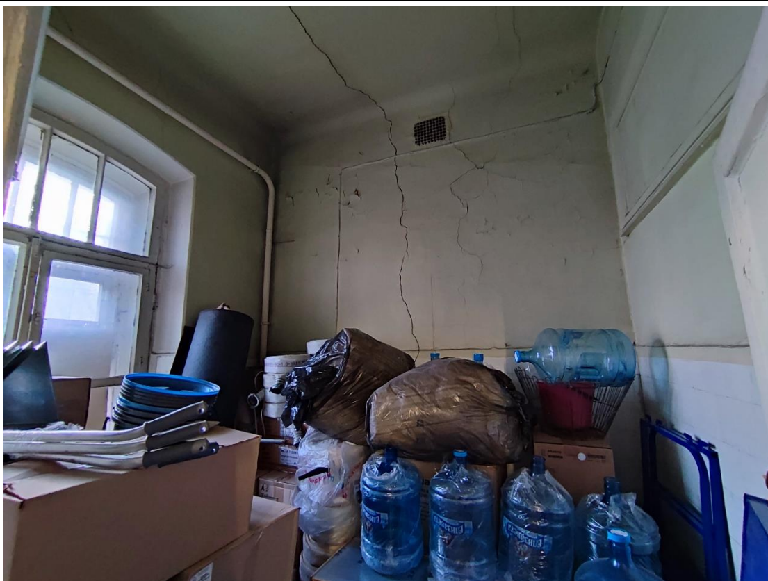
15. Общий вид помещения 1-Н (6) в уровне 1-го этажа.
