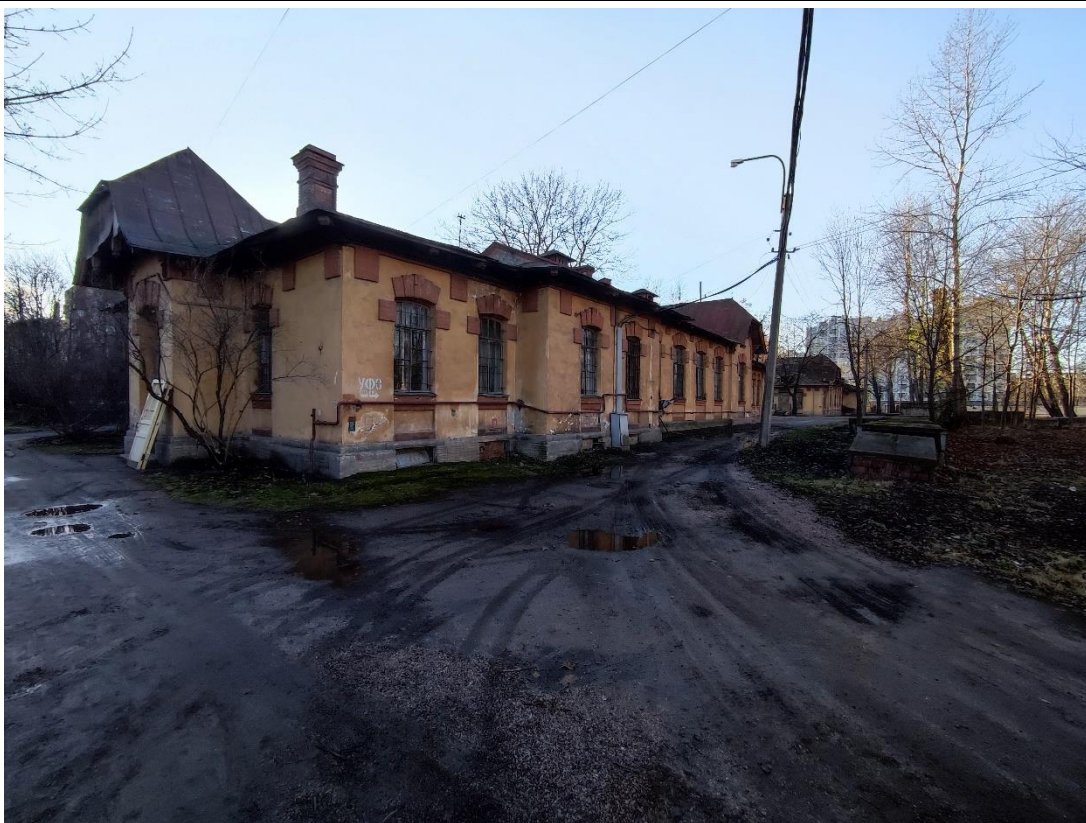
6. Общий вид объекта культурного наследия регионального значения «Одноэтажный лечебный корпус», расположенного по адресу: Санкт-Петербург, Миргородская улица, дом 3, литера У, с северо-востока.
