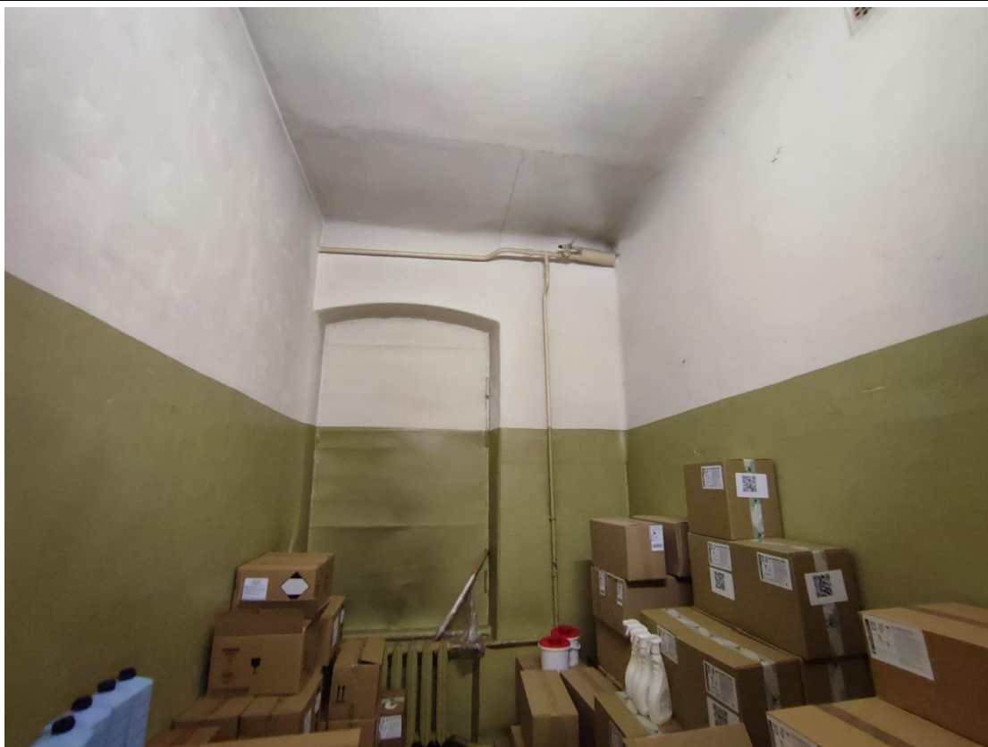
27. Общий вид помещения 1-Н (21) в уровне 1-го этажа.
