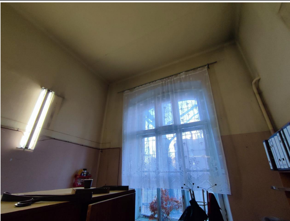
10. Общий вид помещения 1-Н (15) в уровне 1-го этажа.
