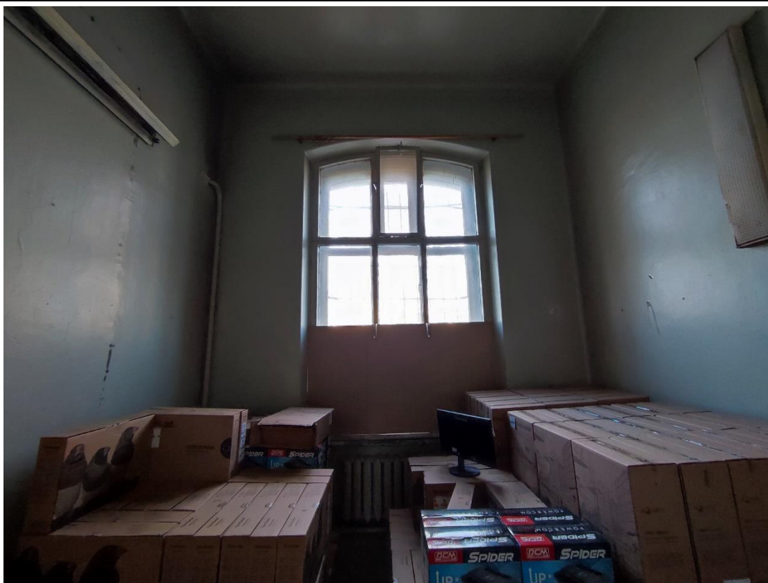
26. Общий вид помещения 1-Н (22) в уровне 1-го этажа.
