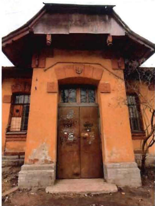
4. Фрагмент восточного фасада
