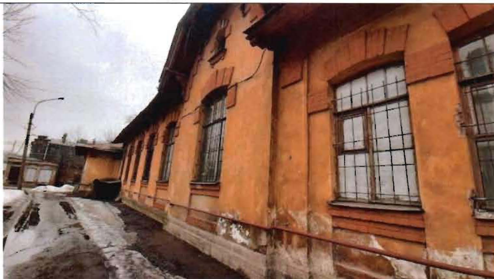
1. Фрагмент северного фасада
