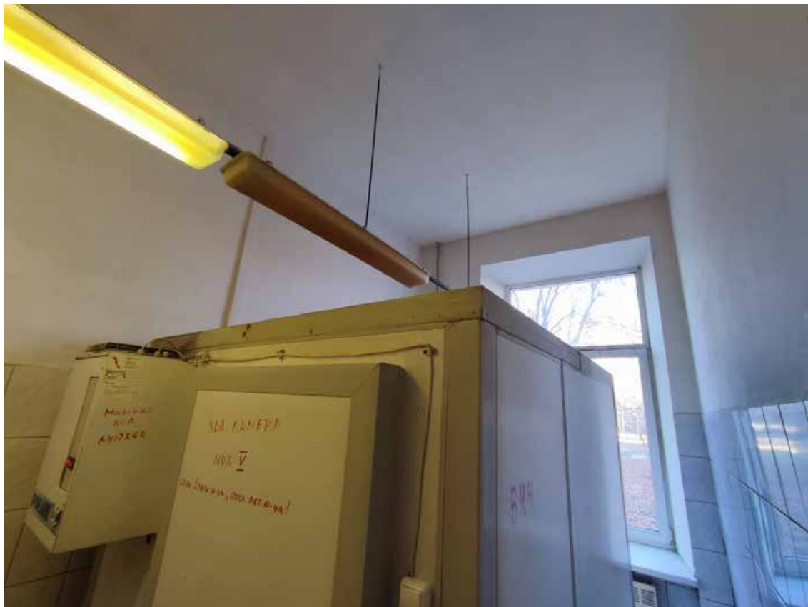
26. Фрагмент пом. 1-Н (74) в уровне 1-го этажа.
