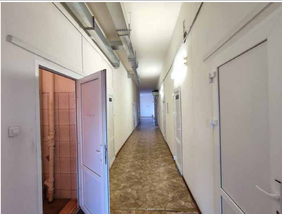
33. Фрагмент пом. 1-Н (86) в уровне 2-го этажа.
