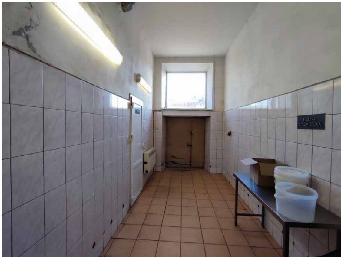
25. Общий вид пом. 1-Н (36) в уровне 1-го этажа.
