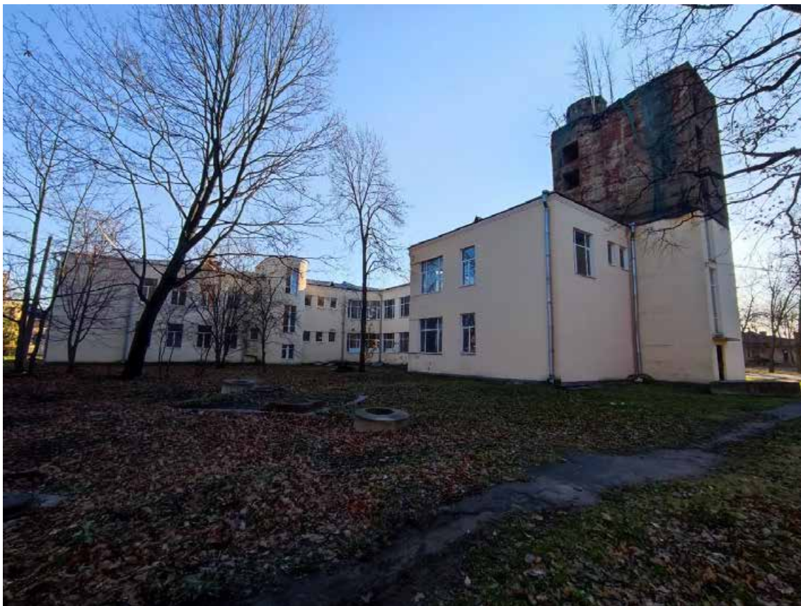
5. Общий вид северо-западного дворового фасада и северо-восточного торцевого фасада объекта культурного наследия регионального значения «Хирургический корпус».
