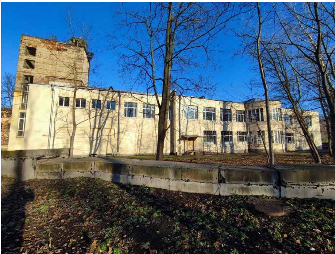
2. Общий вид юго-западного лицевого фасада объекта культурного наследия регионального значения «Хирургический корпус».
