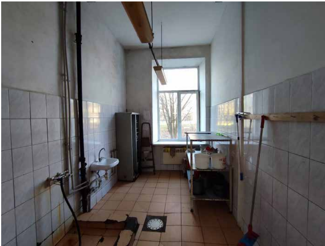
24. Общий вид пом. 1-Н (73) в уровне 1-го этажа.
