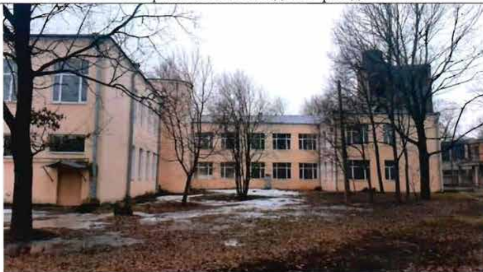
2. Фрагмент северо-восточного фасада
