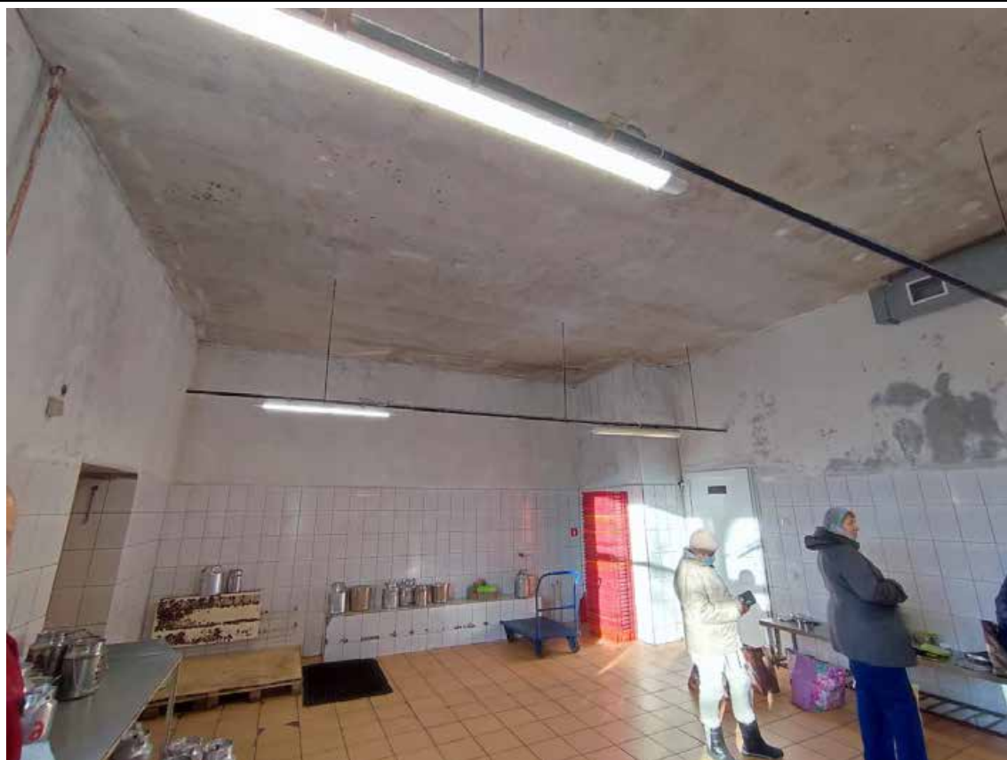
12. Общий вид пом. 1-Н (48, 49) в уровне 1-го этажа.
