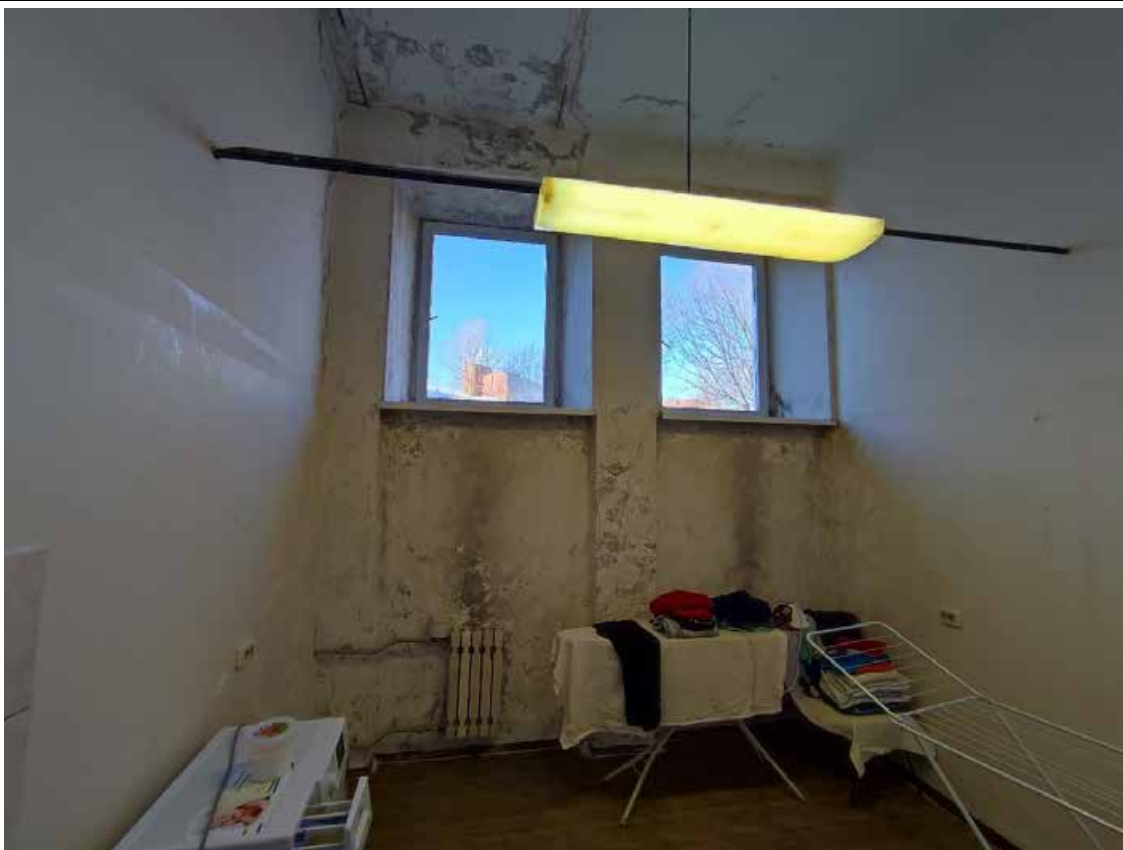
42. Общий вид пом. 1-Н (103, 104, 105) в уровне 2-го этажа.
