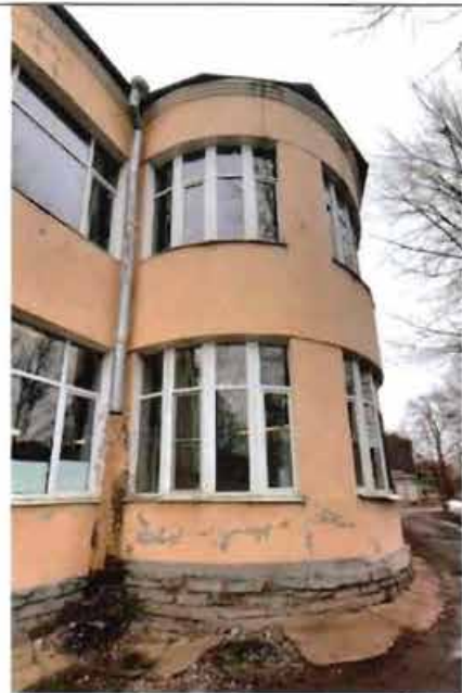
5. Фрагмент юго-западного фасада
