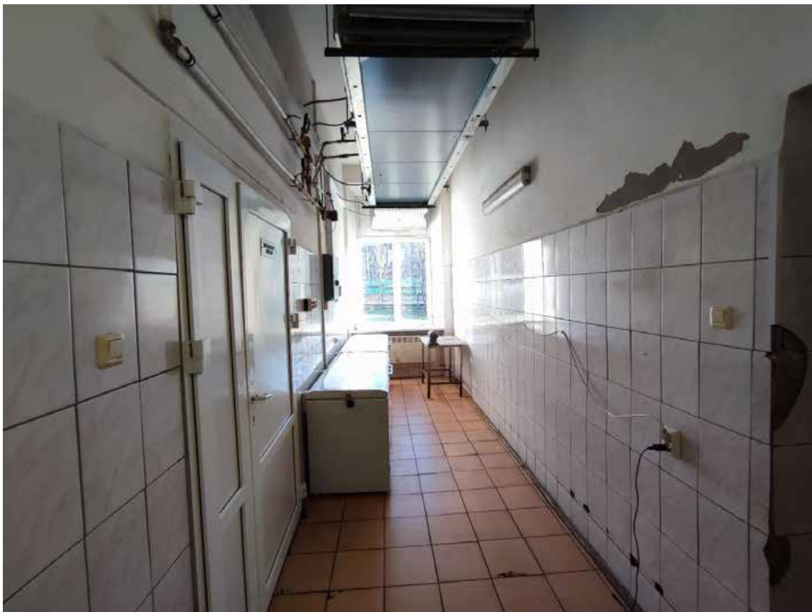
27. Фрагмент пом. 1-Н (34) в уровне 1-го этажа.
