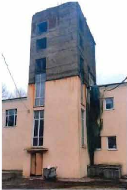
4. Фрагмент северо-западного фасада
