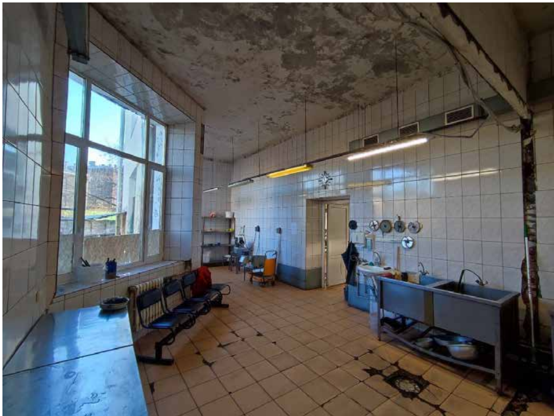
14. Фрагмент пом. 1-Н (43) в уровне 1-го этажа.
