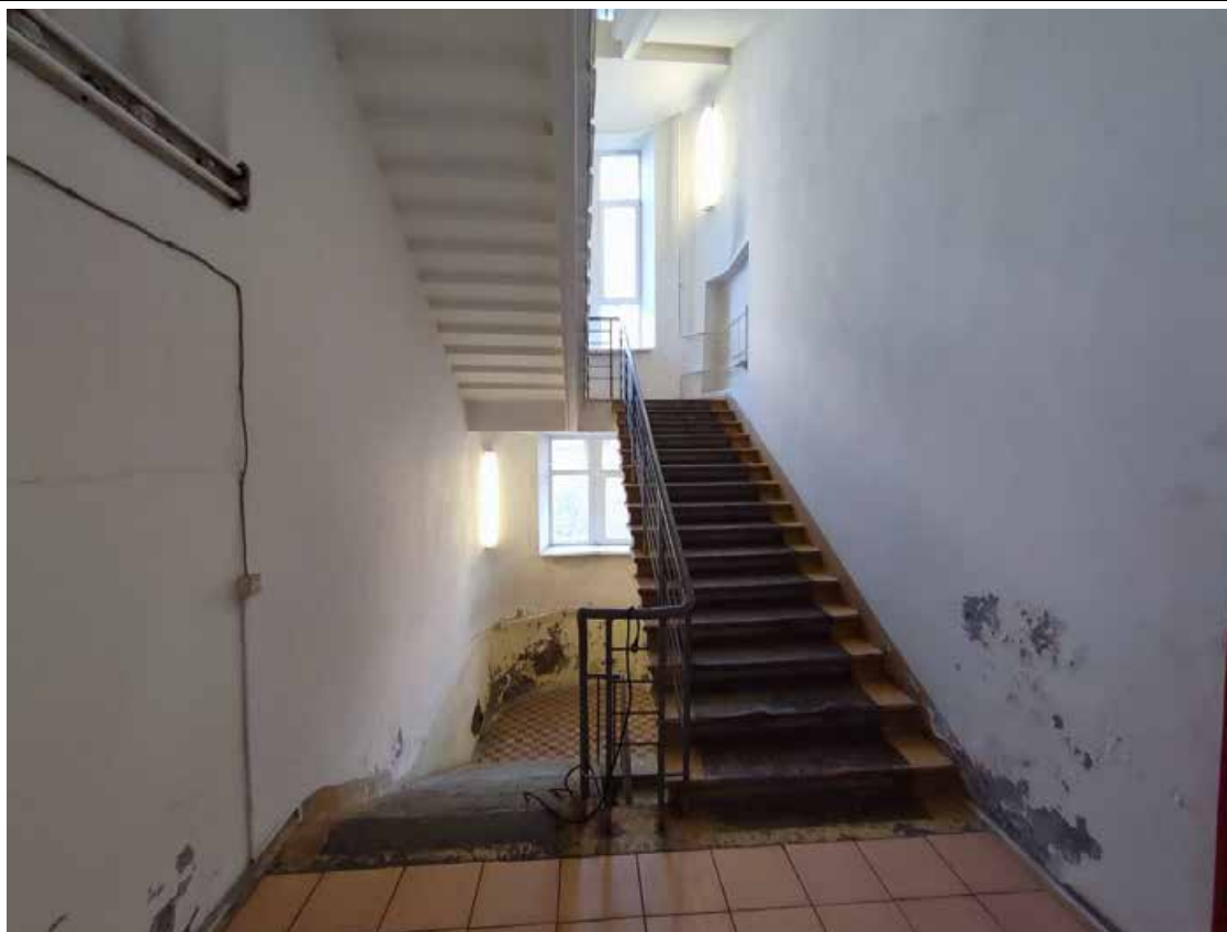
20. Вид на лестницу (фрагмент пом. 1-Н (68)) в уровне 1-го этажа.
