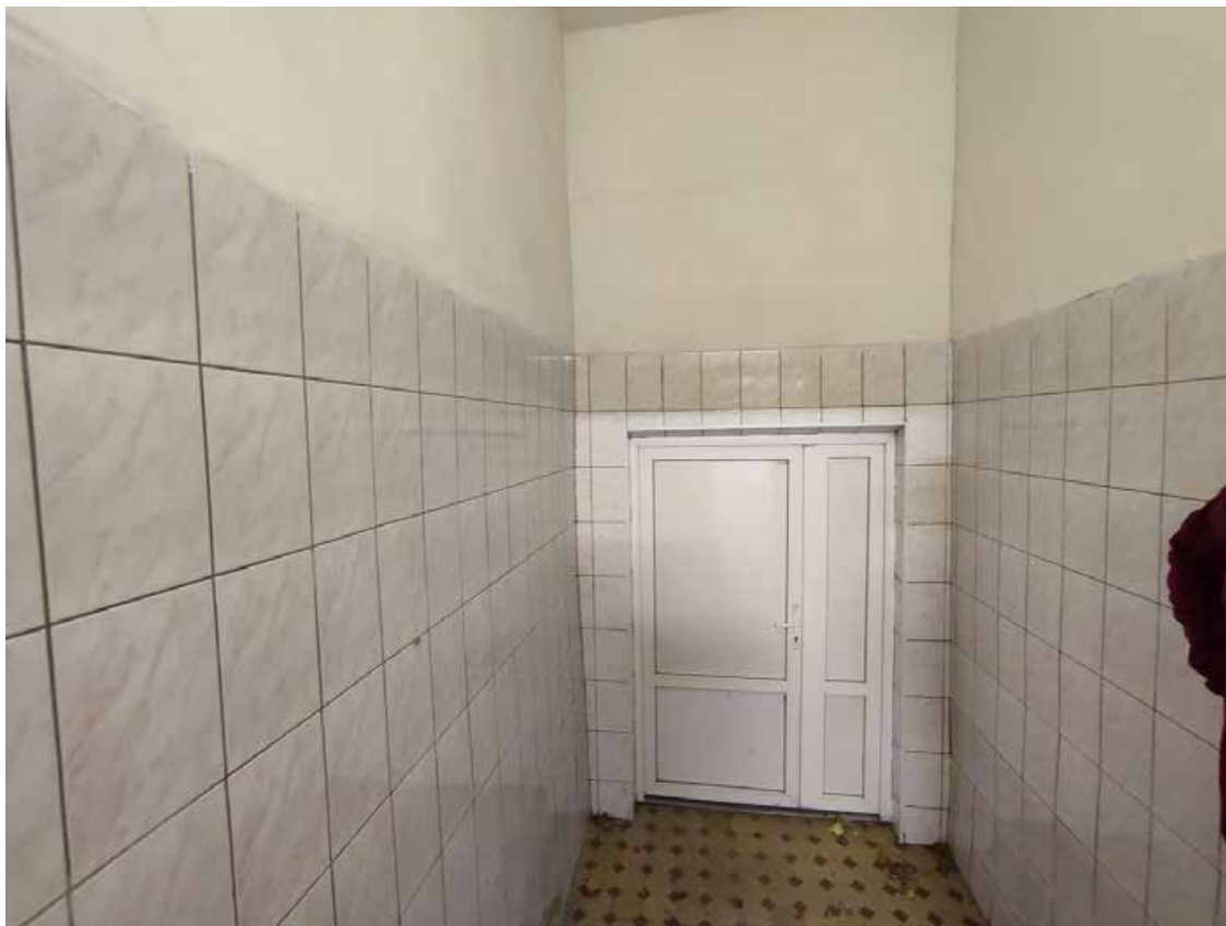
23. Общий вид пом. 1-Н (37) в уровне 1-го этажа.
