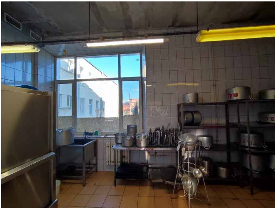
11. Фрагмент пом. 1-Н (44) в уровне 1-го этажа.
