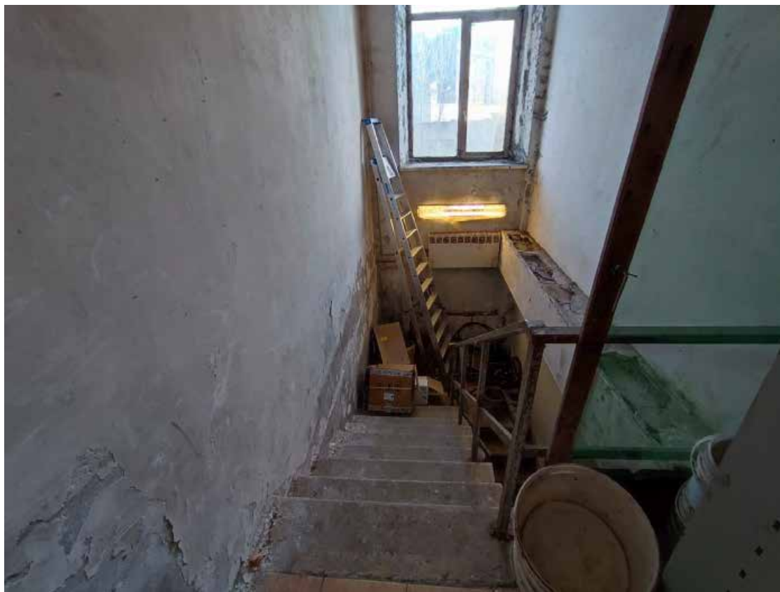
22. Вид на лестницу (фрагмент пом. 1-Н (68)) в уровне 1-го этажа.
