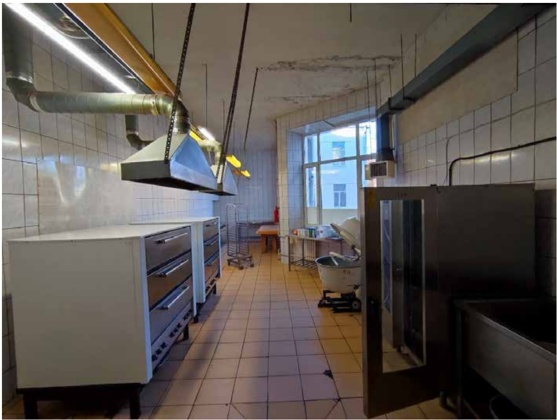
13. Фрагмент пом. 1-Н (43) в уровне 1-го этажа.
