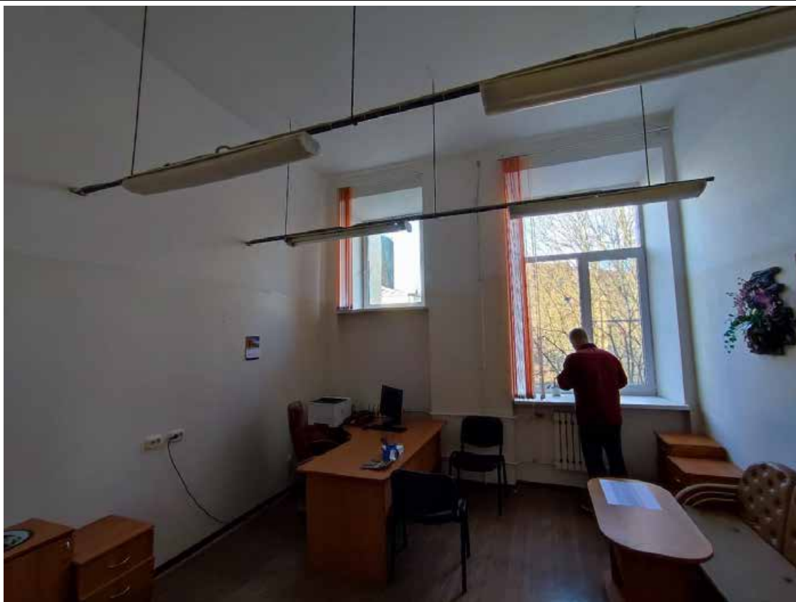
36. Общий вид пом. 1-Н (109, 110) в уровне 2-го этажа.
