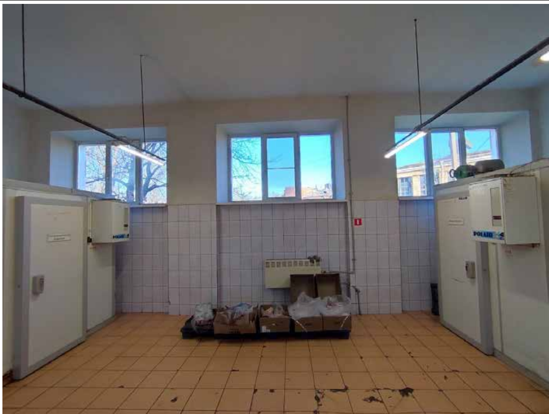
28. Фрагмент пом. 1-Н (34) в уровне 1-го этажа.
