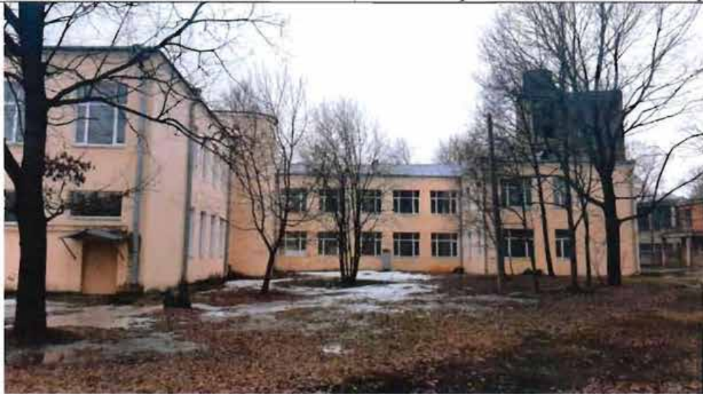
6. Фрагмент северо-восточного фасада
