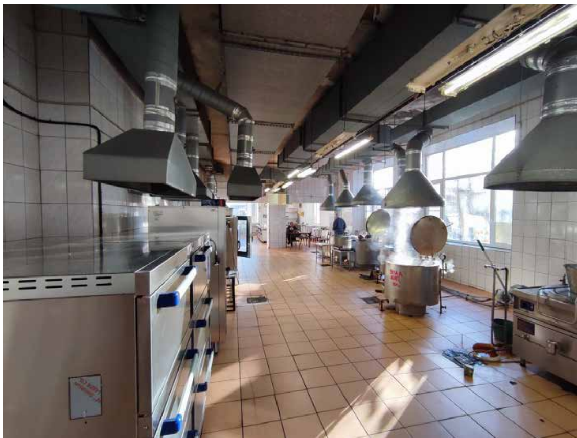
8. Общий вид пом. 1-Н (45, 46) в уровне 1-го этажа.
