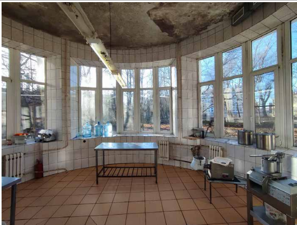
9. Фрагмент пом. 1-Н (46) в уровне 1-го этажа.
