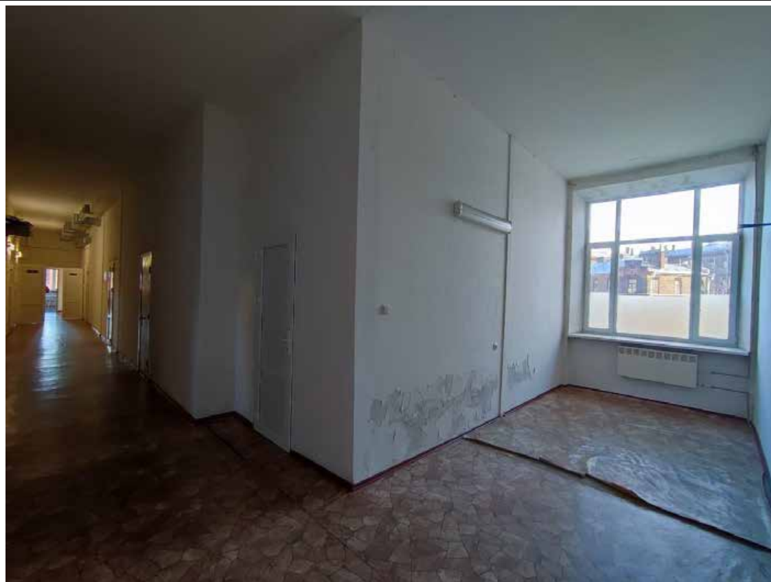
43. Общий вид пом. 1-Н (86) в уровне 2-го этажа.
