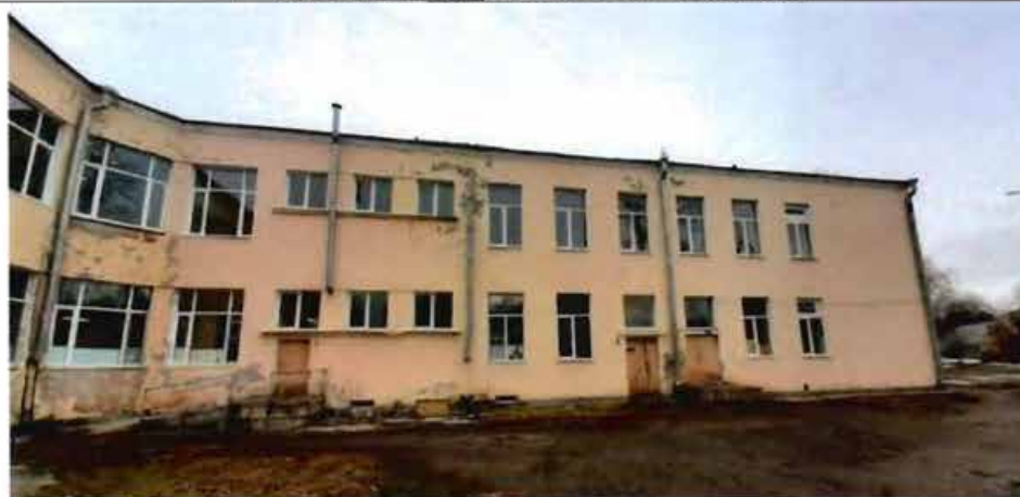
3. Фрагмент восточного фасада
