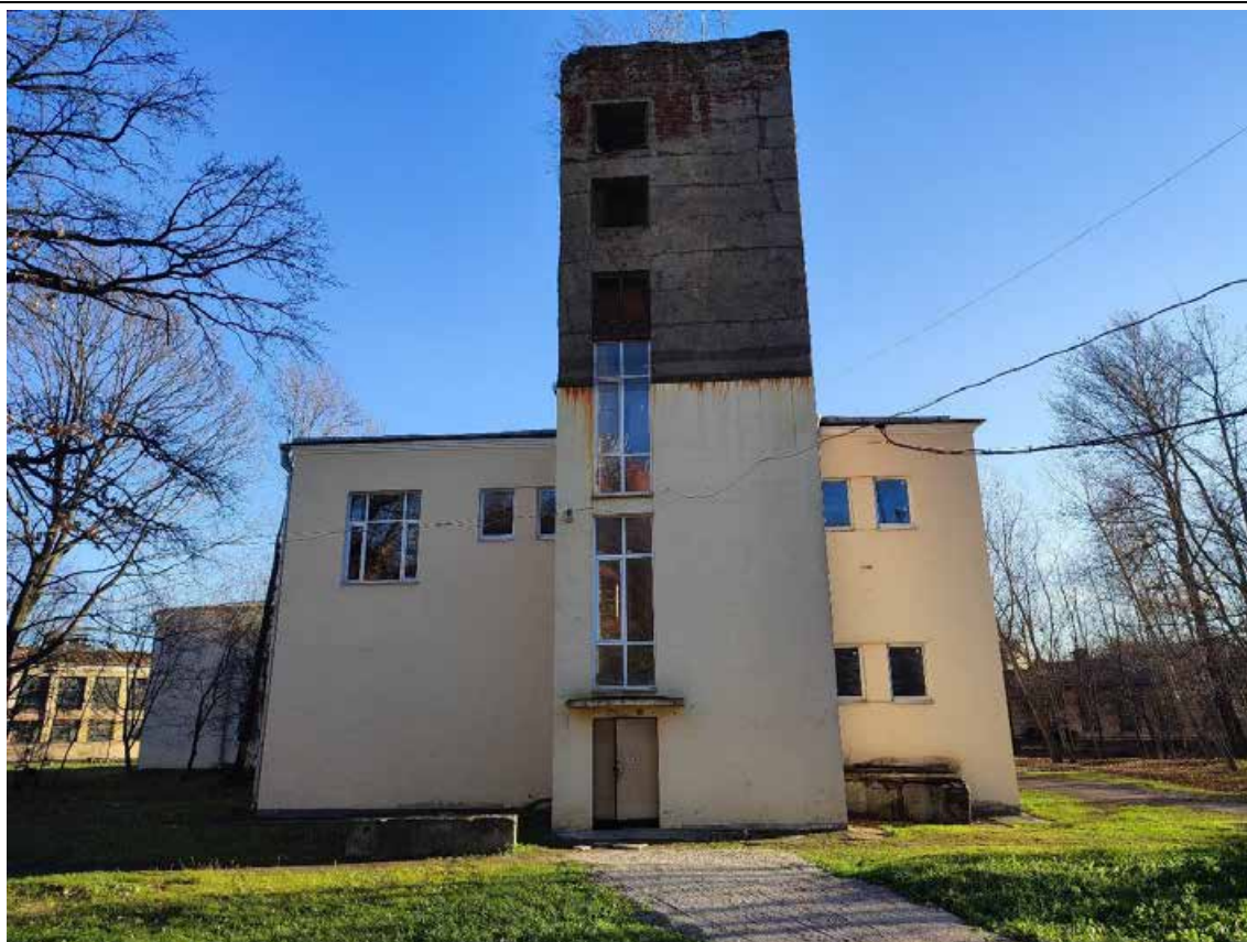
6. Общий вид пятиэтажного объема лестничной башни со стороны северо-западного торцевого фасада.
