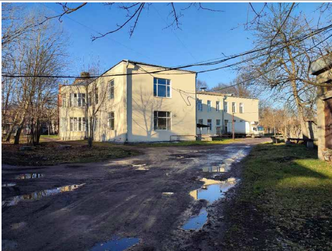
3. Общий вид юго-восточного торцевого фасада объекта культурного наследия регионального значения «Хирургический корпус».
