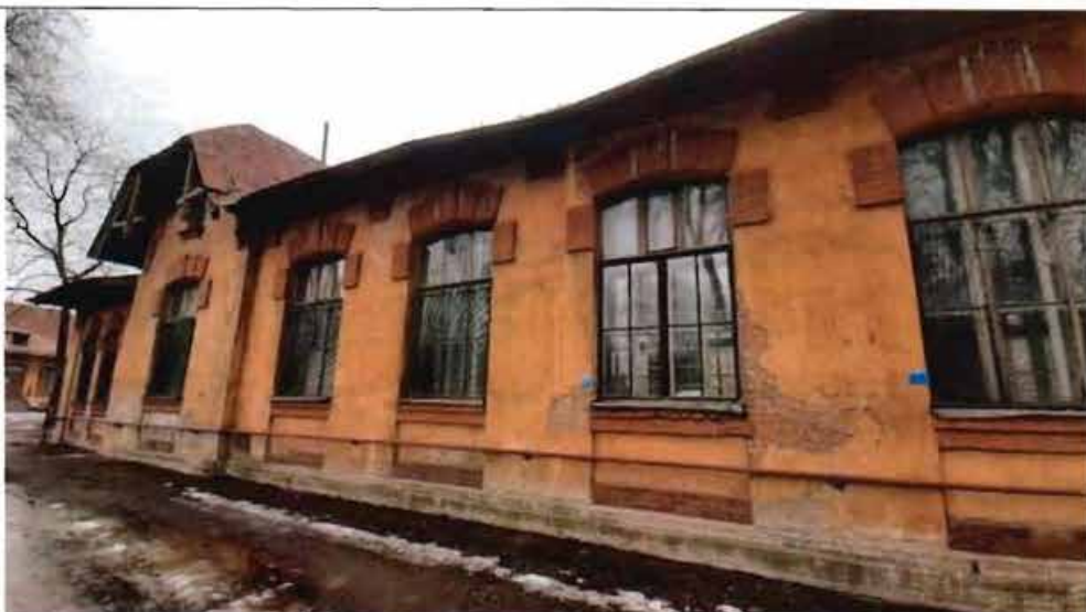
4. Фрагмент северного фасада
