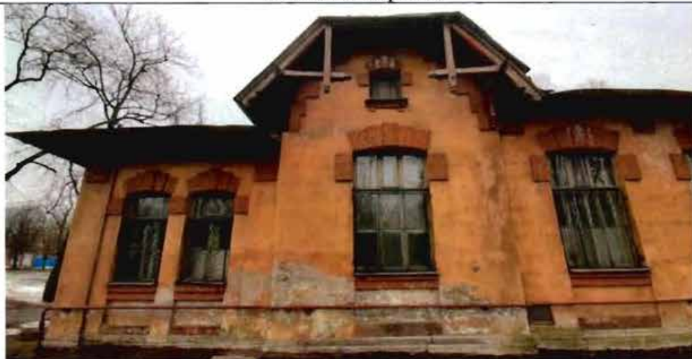
3. Фрагмент северного фасада
