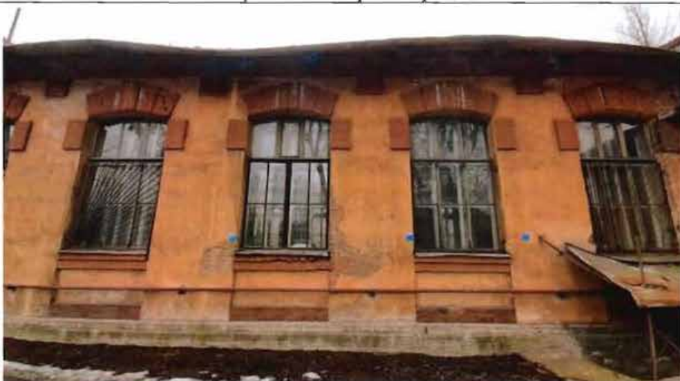
5. Фрагмент северного фасада
