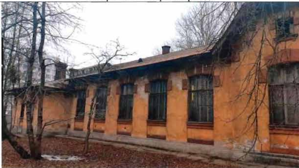
6. Фрагмент южного фасада
