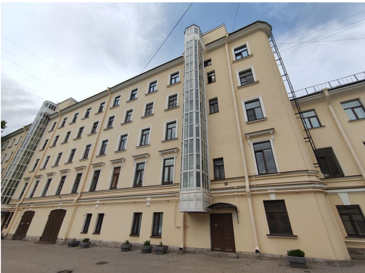
Фото 2. Общий вид на объект культурного наследия «Дом С.Д. Шереметева» со стороны внутреннего двора
