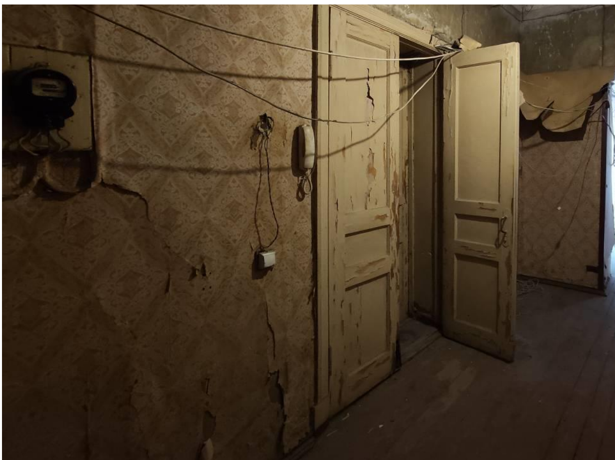
Фото 10. Интерьер квартиры, ч.п. 1. Вид на выход из квартиры и ч.п. 7
