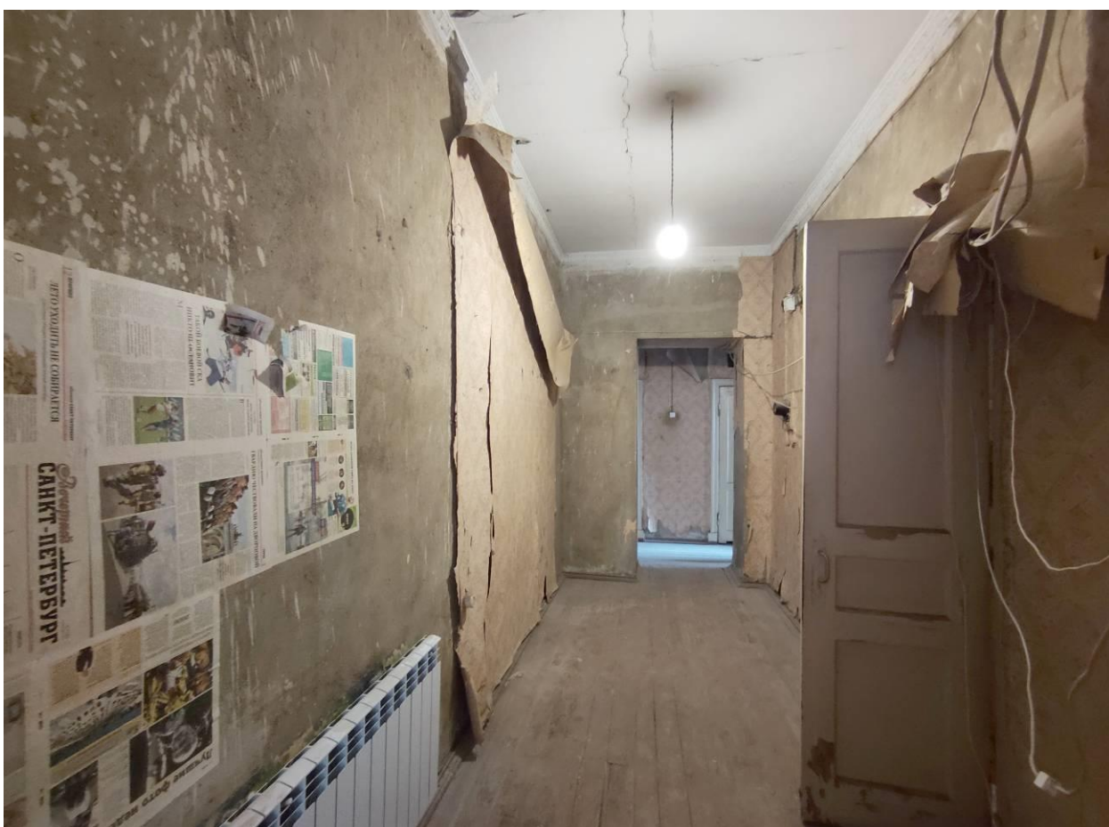
Фото 14. Интерьер квартиры, ч.п. 1. Вид на выход из квартиры и ч.п.19
