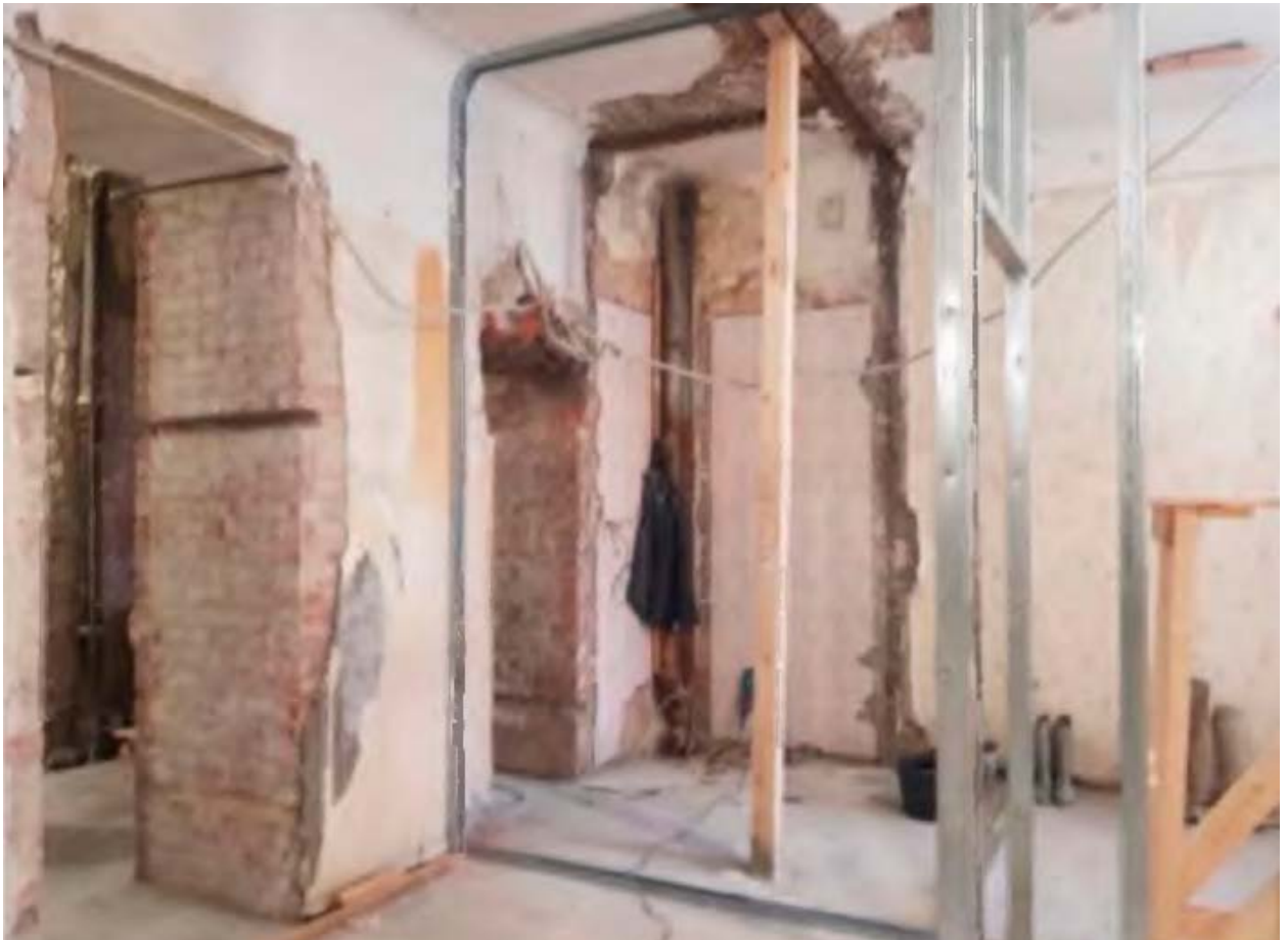
5. Помещение №6 квартиры №72 в уровне 2-го этажа объекта культурного наследия регионального значения «Дом, где в 1917 г. жил Джон Рид», расположенного по адресу: г. Санкт-Петербург, ул. Рубинштейна, д. 23, литера А. 10.09.2021.
