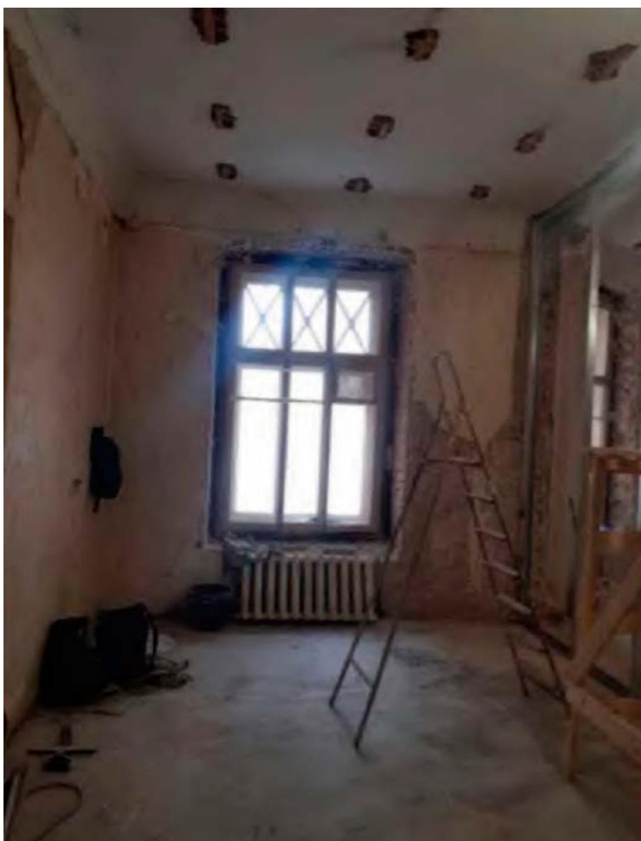
8. Помещение №5 квартиры №72 в уровне 2-го этажа объекта культурного наследия регионального значения «Дом, где в 1917 г. жил Джон Рид», расположенного по адресу: г. Санкт-Петербург, ул. Рубинштейна, д. 23, литера А. 10.09.2021.
