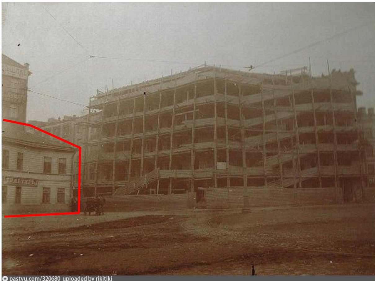
Илл. 13. Строительство дома №24 по Нарвскому проспекту. Фото 1912-1913 гг. Интернет-ресурс https://pastvu.com/320680 .
