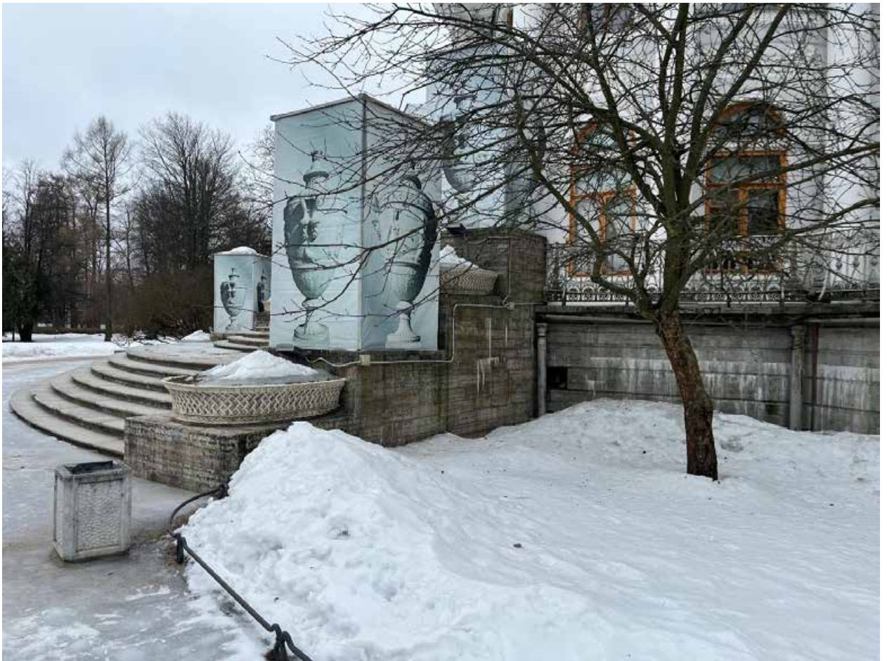
Фото №6. Восточный фасад, восточная лестница.
