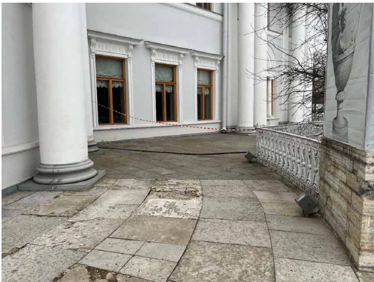
Фото №9. Восточный фасад, восточная лестница, площадка, покрытая, известняковыми плитами.
