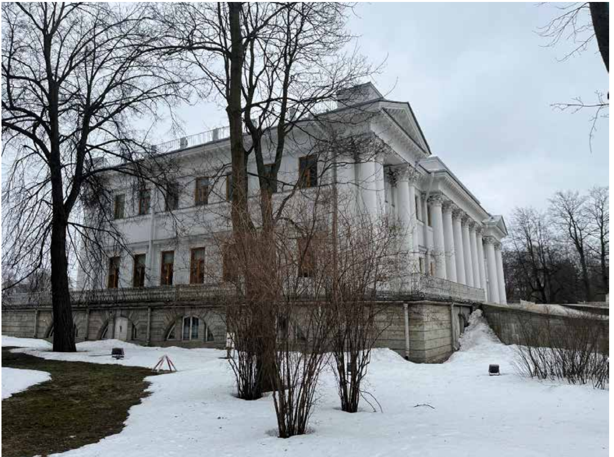
Фото №3. Общий вид здания, северный фасад.
