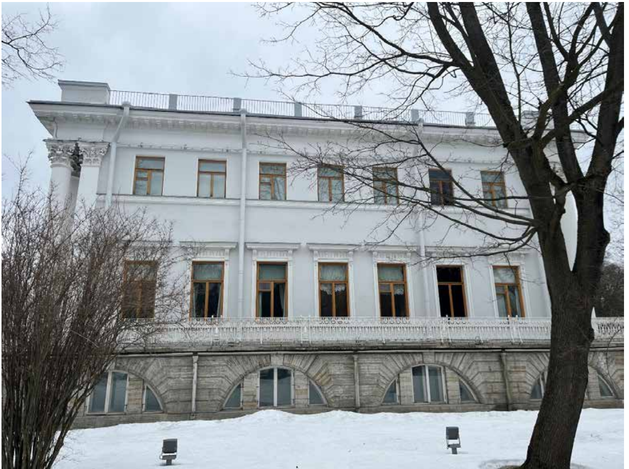
Фото №4. Общий вид здания, южный фасад.
