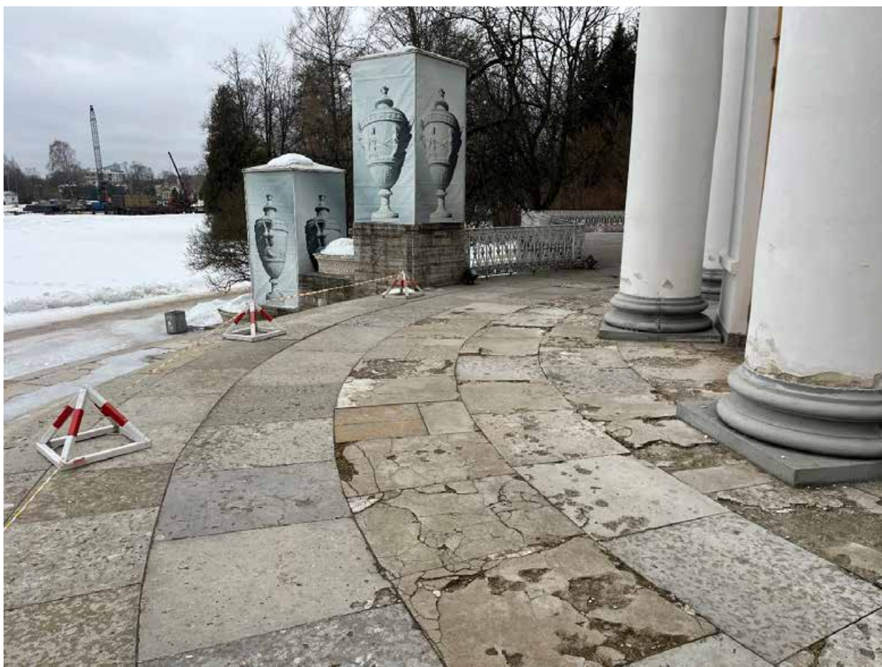
Фото №10. Восточный фасад, восточная лестница, площадка, покрытая, известняковыми плитами.
