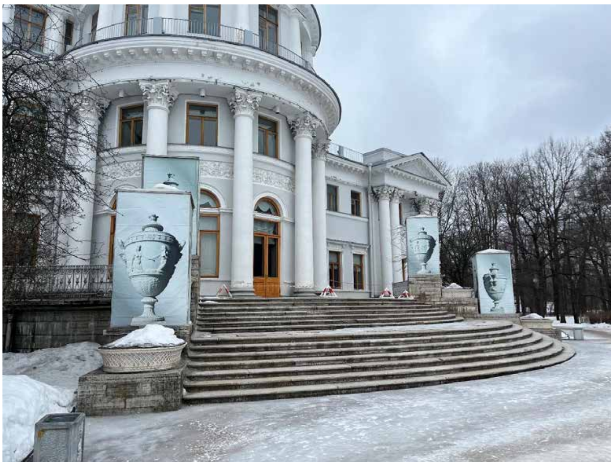
Фото №5. Восточный фасад, восточная лестница.
