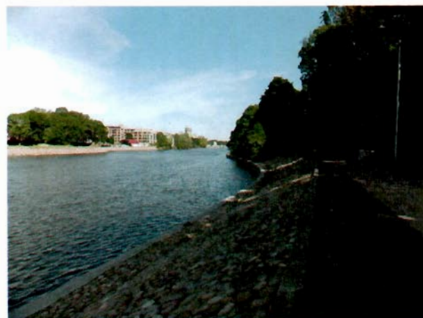
50. Береговой откос р. Большой Невки, облицованный булыжником.
