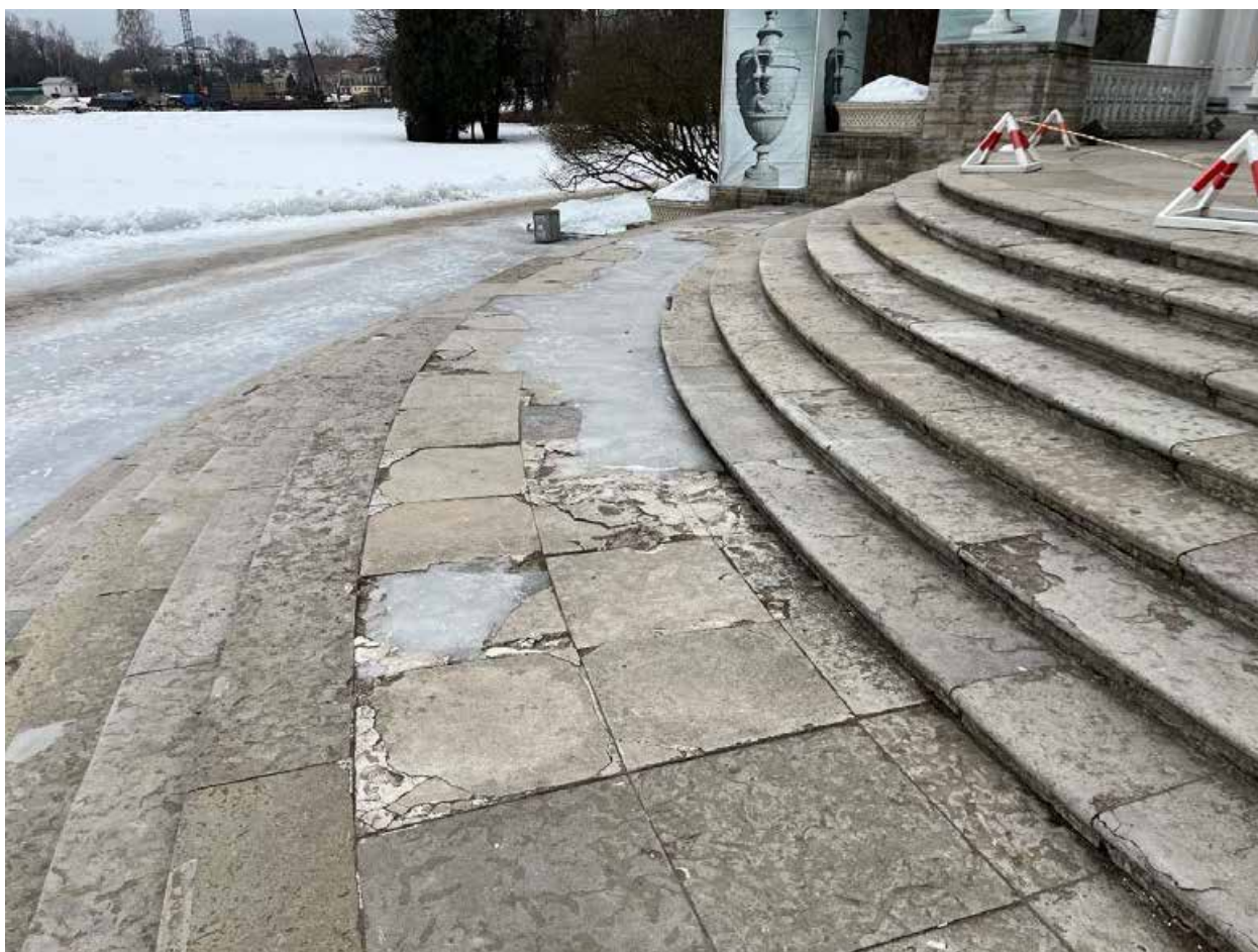
Фото №8. Восточный фасад, восточная лестница, известняковые ступени, площадка, покрытая, известняковыми плитами.
