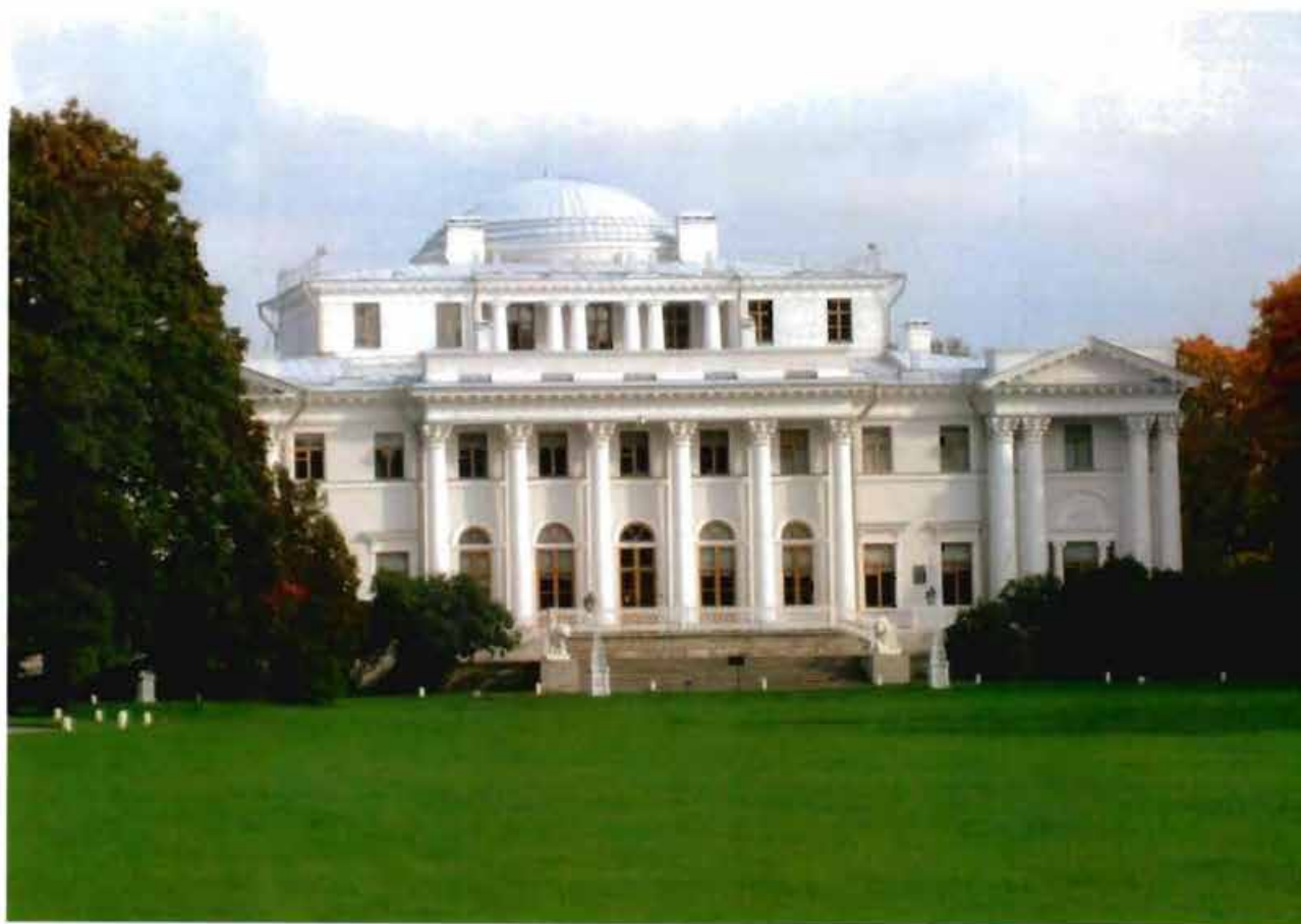
1. Объект культурного наследия. Главный фасад, вид с западной стороны.
