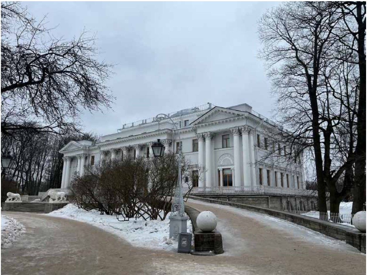
Фото №2. Общий вид здания, западный фасад.
