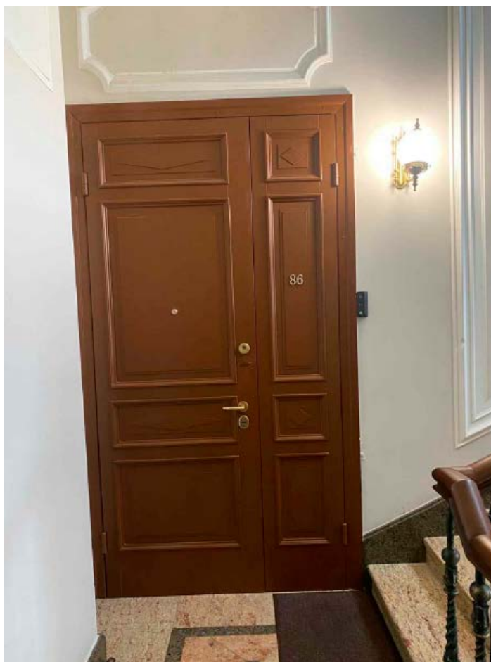
Фото 3 Входная дверь квартиры №86 выявленного объекта культурного наследия «Жилой дом» (в составе «Дома Немецкой лютеранской церкви св. Петра»), Санкт-Петербург, Невский пр., д. 22-24, лит. А. (корпус по Конюшенной Малой ул., 7)
