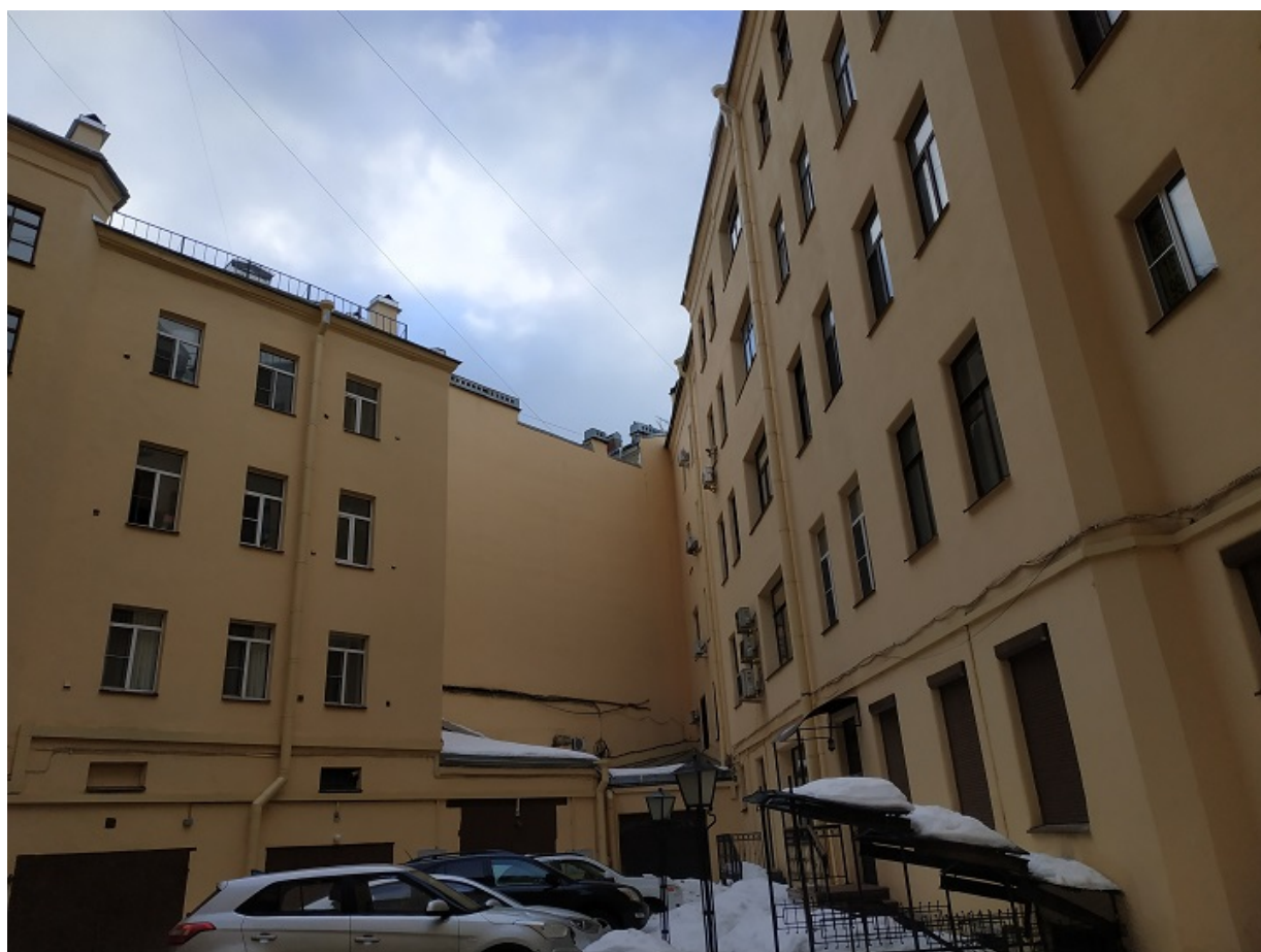
13. Здание по адресу: Санкт-Петербург, Каменноостровский проспект, д. 1-3. Фрагмент дворового фасада.
