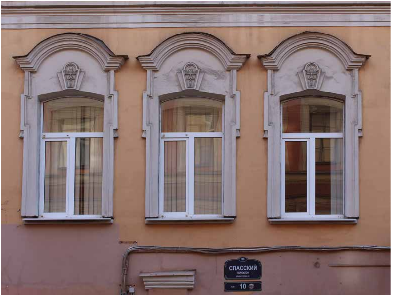
Илл. 73. Спасский пер., 10. Фрагмент лицевого фасада. 2018 г. Код URL: https://p2.citywalls.ru/photo_356-365034.jpg?mt=1539288577 . Дата обращения: 10 мая 2021 г.
