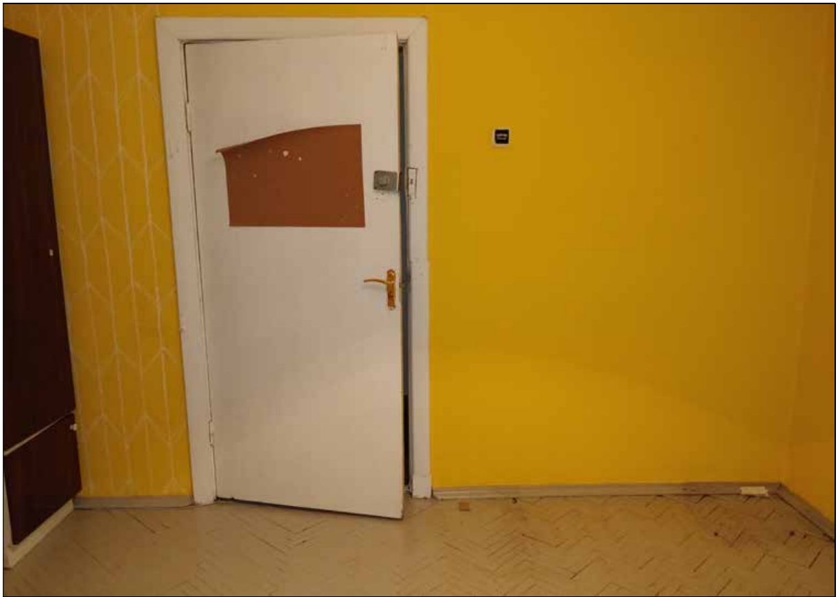
31. Выявленный объект культурного наследия «Дом Ц.А. Кавоса (А. И. Сулова)». Квартира № 5. Помещение № 9. Дверной проем в северной части помещения. 19.08.2021 г.
