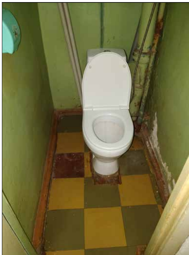
22.Выявленный объект культурного наследия «Дом Ц.А. Кавоса (А. И. Сулова)». Квартира № 5. Помещение № 5. 19.08.2021 г.
