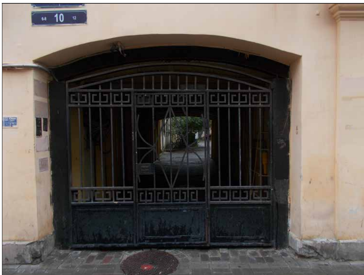
6. Выявленный объект культурного наследия «Дом Ц.А. Кавоса (А. И. Сулова)». Фрагмент лицевого фасада. Воротный проезд. 19.08.2021 г.
