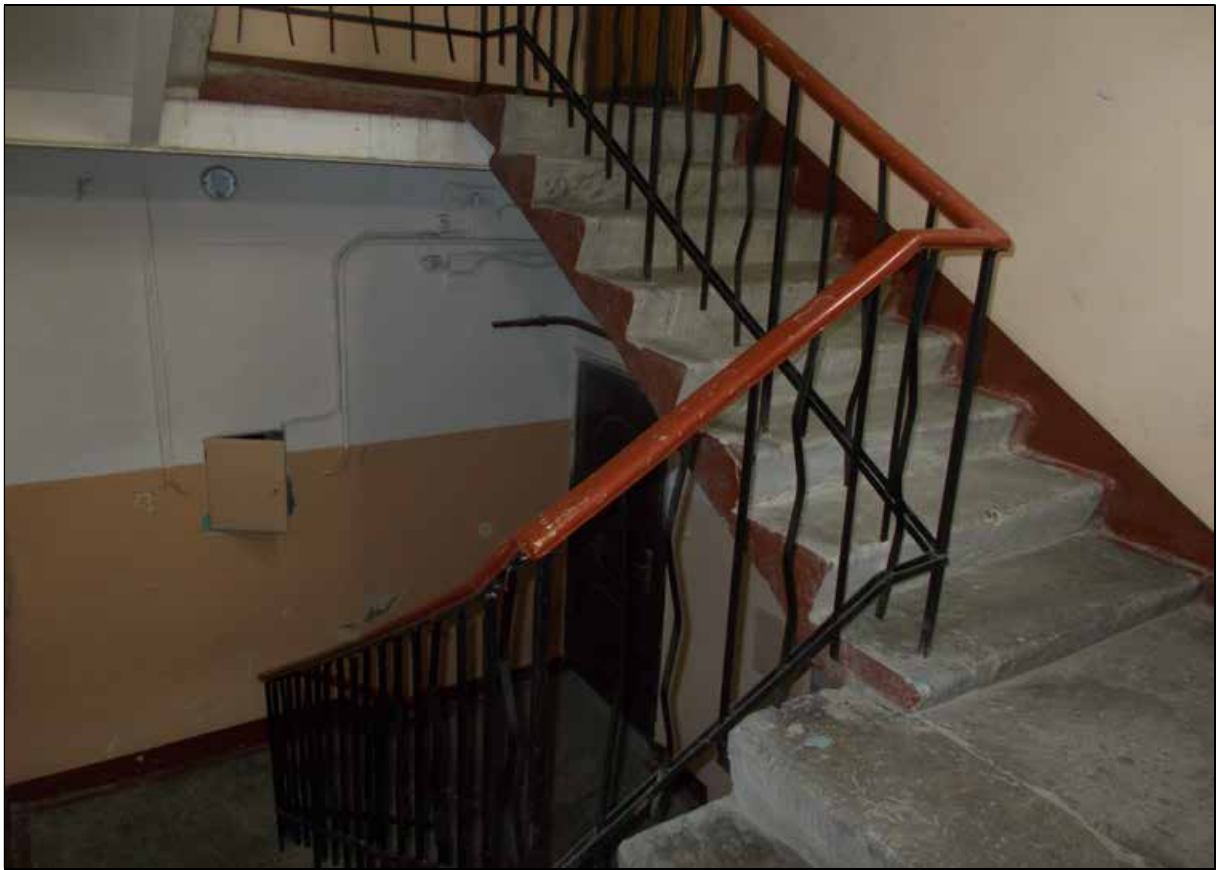
13. Выявленный объект культурного наследия «Дом Ц.А. Кавоса (А. И. Сулова)». Лестничный марш на 2-й этаж. Вид от лифта. 19.08.2021 г.
