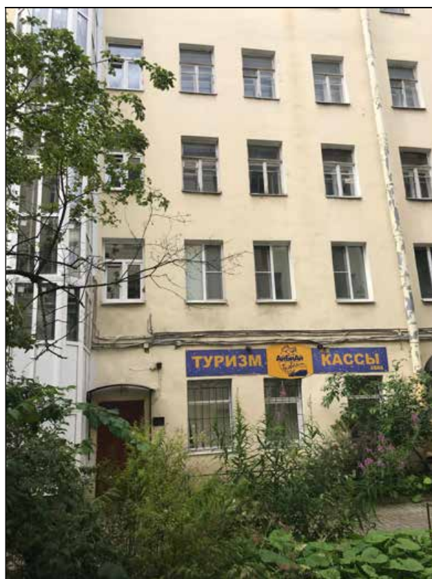
9. Выявленный объект культурного наследия «Дом Ц.А. Кавоса (А. И. Сулова)». Фрагмент северного дворового корпуса. 19.08.2021 г.
