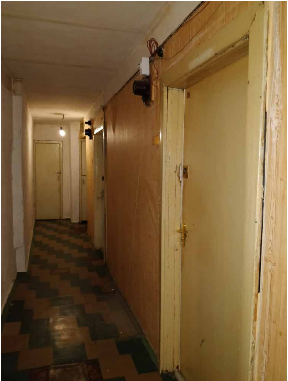
18. Выявленный объект культурного наследия «Дом Ц.А. Кавоса (А. И. Сулова)». Квартира № 5. Помещение № 1. Входы в помещения №№ 8 и 9. Вид от входа в помещение № 9. 19.08.2021 г.
