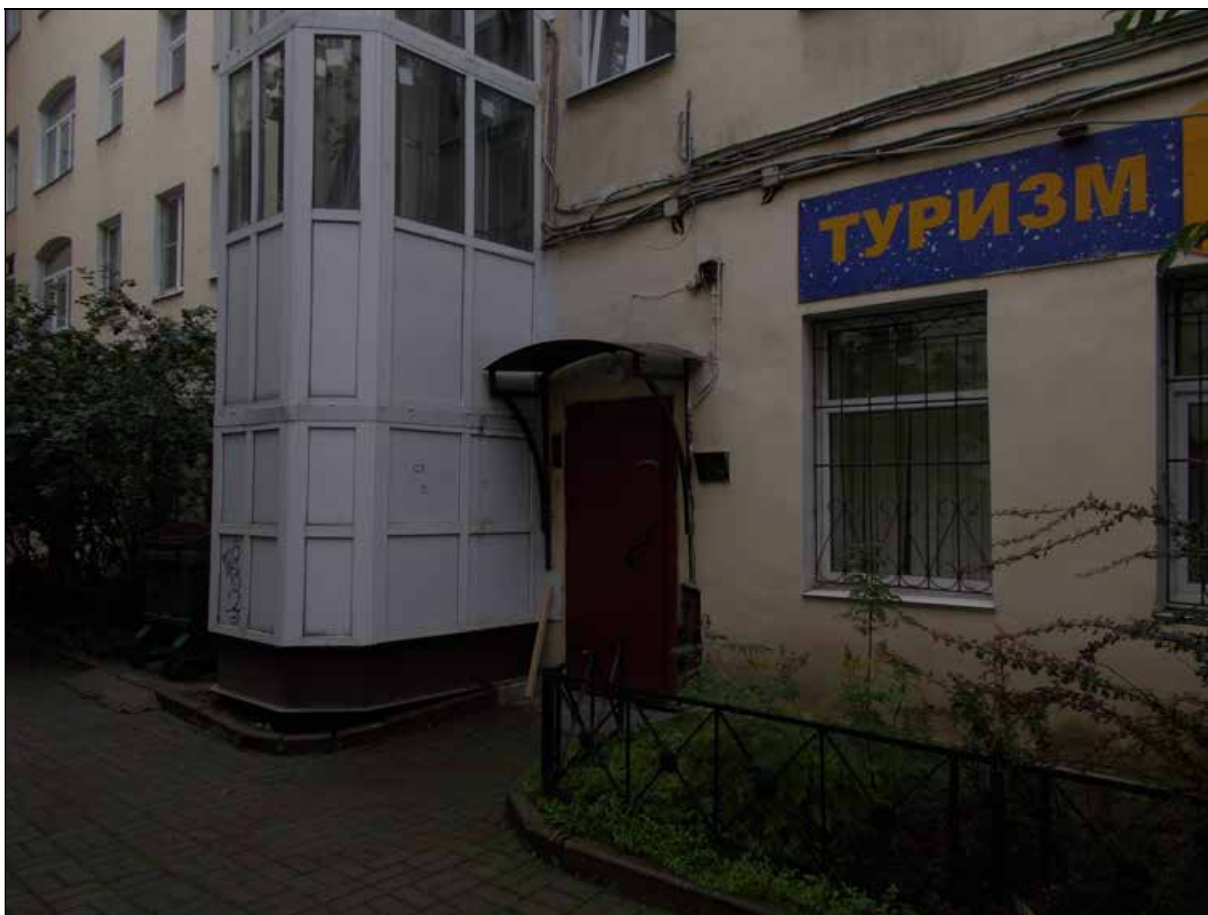
10. Выявленный объект культурного наследия «Дом Ц.А. Кавоса (А. И. Сулова)». Фрагмент северного дворового корпуса. Вход на лестницу. 19.08.2021 г.
