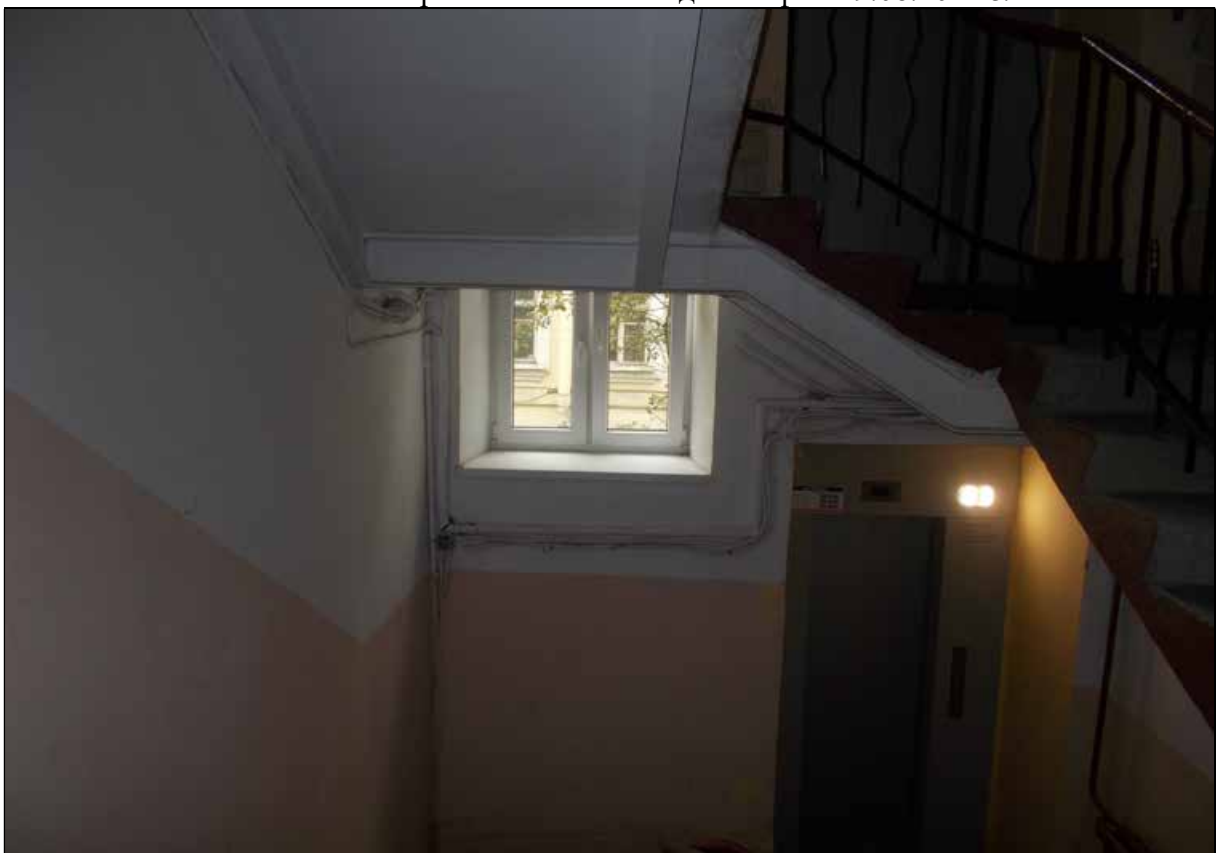
14. Выявленный объект культурного наследия «Дом Ц.А. Кавоса (А. И. Сулова)». Лифт и оконный проем. Вид с лестничной площадки 2-го этажа. 19.08.2021 г.
