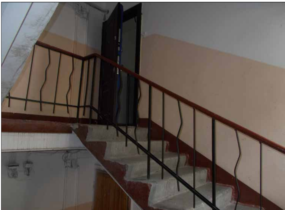
15. Выявленный объект культурного наследия «Дом Ц.А. Кавоса (А. И. Сулова)». Лестничный марш на 3-й этаж. Вход в квартиру № 5. 19.08.2021 г.
