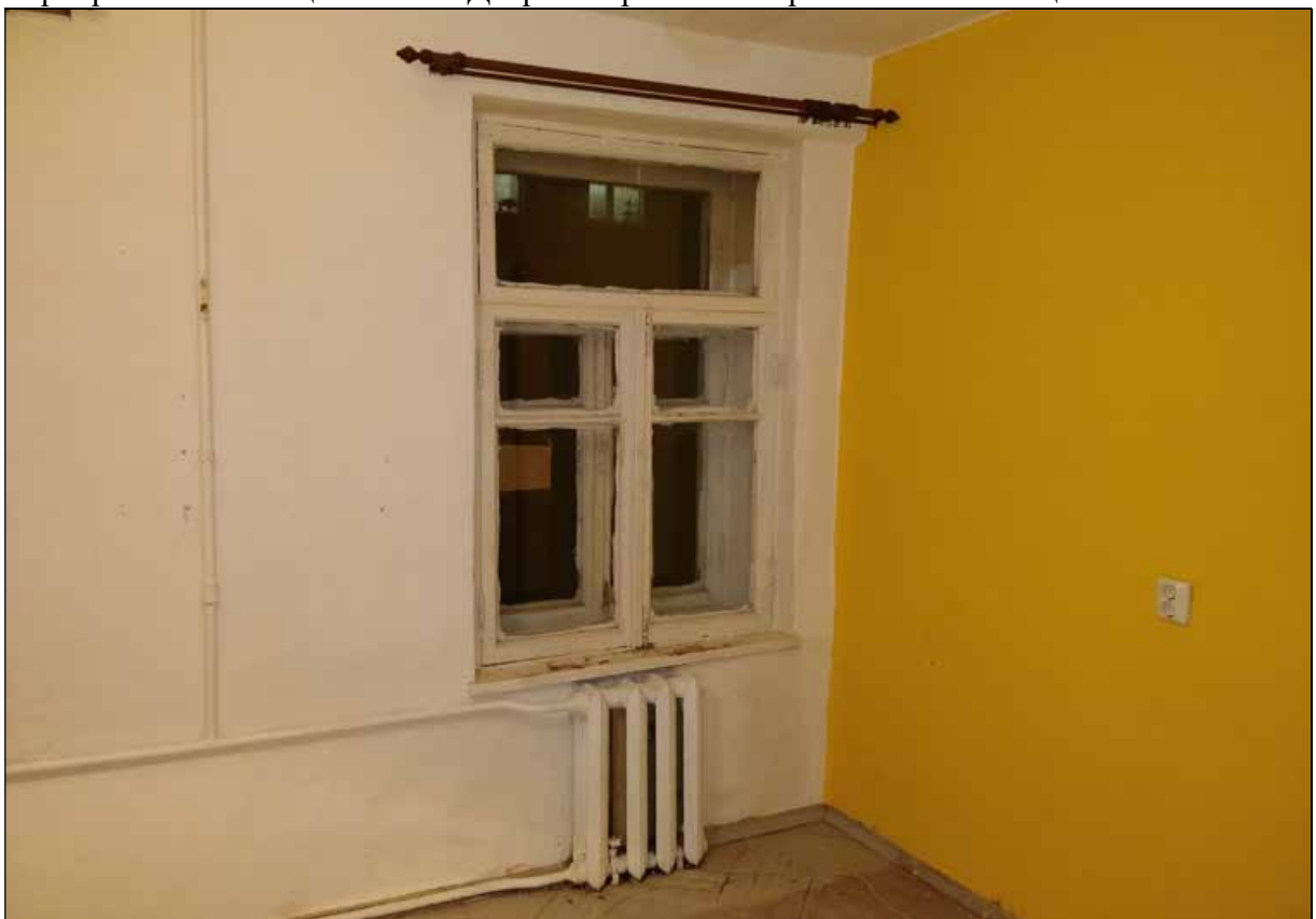
32. Выявленный объект культурного наследия «Дом Ц.А. Кавоса (А. И. Сулова)». Квартира № 5. Помещение № 9. Оконный проем в юго-западной части помещения. 19.08.2021 г.
