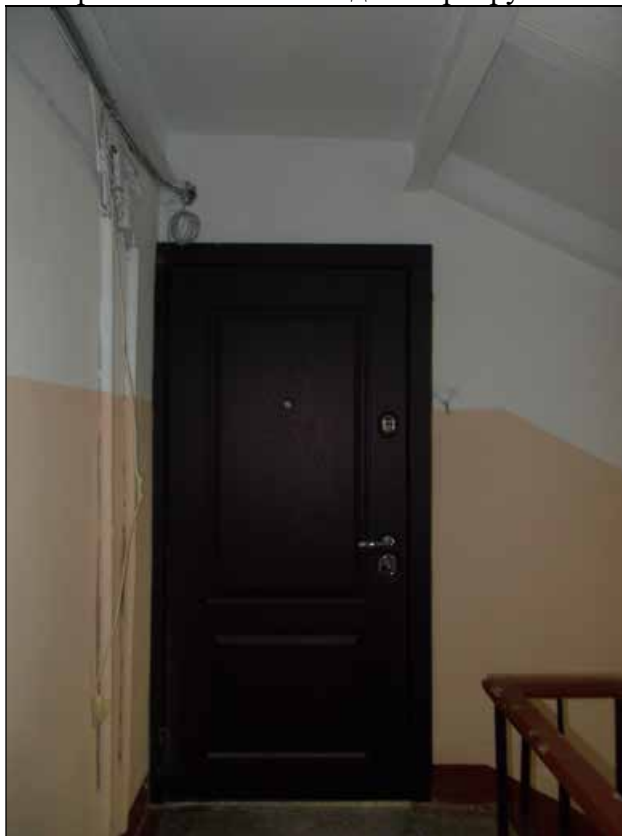
16. Выявленный объект культурного наследия «Дом Ц.А. Кавоса (А. И. Сулова)». Лестничная площадка 3-го этажа. Вход в квартиру № 5. 19.08.2021 г.
