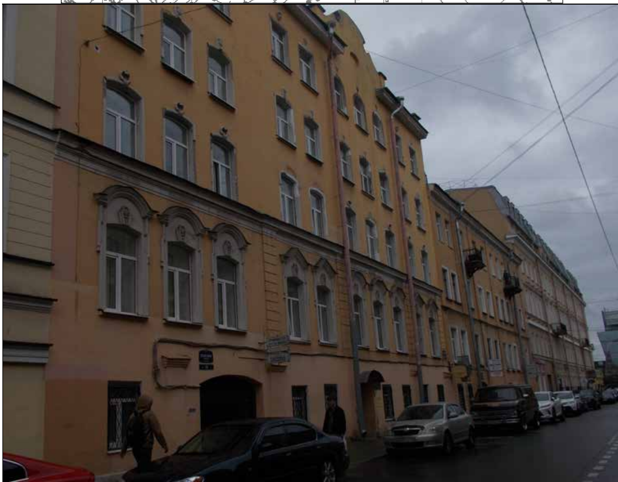
2. Выявленный объект культурного наследия «Дом Ц.А. Кавоса (А. И. Сулова)». Фрагмент лицевого фасада. Вид на юго-восток. 19.08.2021 г.
