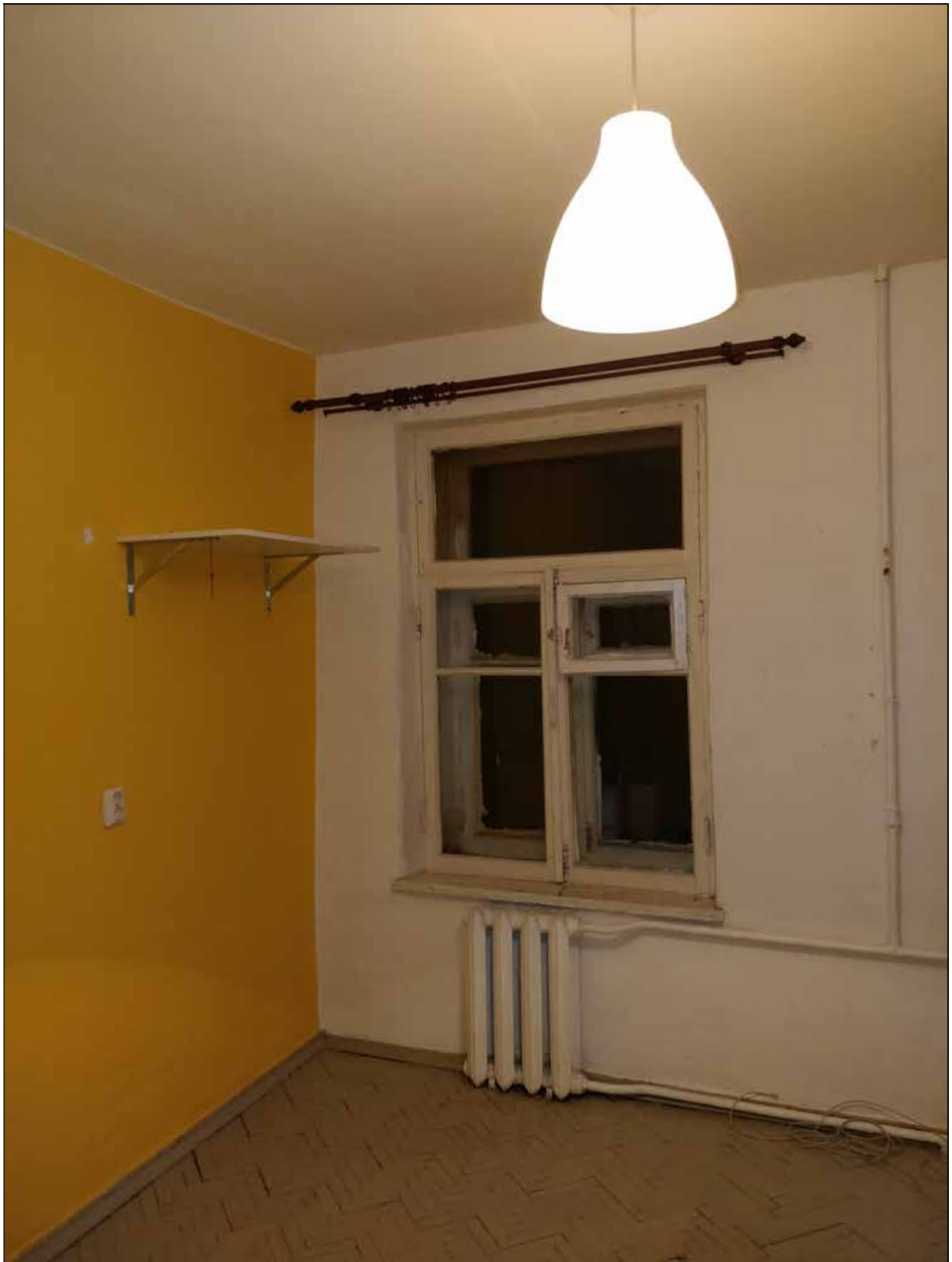
33. Выявленный объект культурного наследия «Дом Ц.А. Кавоса (А. И. Сулова)». Квартира № 5. Помещение № 9. Оконный проем в юго-восточной части помещения. 19.08.2021 г.
