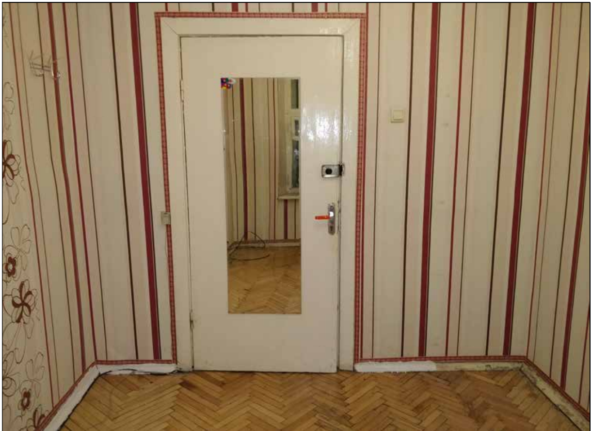
28. Выявленный объект культурного наследия «Дом Ц.А. Кавоса (А. И. Сулова)». Квартира № 5. Помещение № 8. Дверной проем в северной части помещения. 19.08.2021 г.
