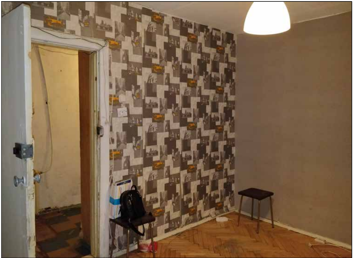
34. Выявленный объект культурного наследия «Дом Ц.А. Кавоса (А. И. Сулова)». Квартира № 5. Помещение № 10. Дверной проем в северной части помещения. 19.08.2021 г.
