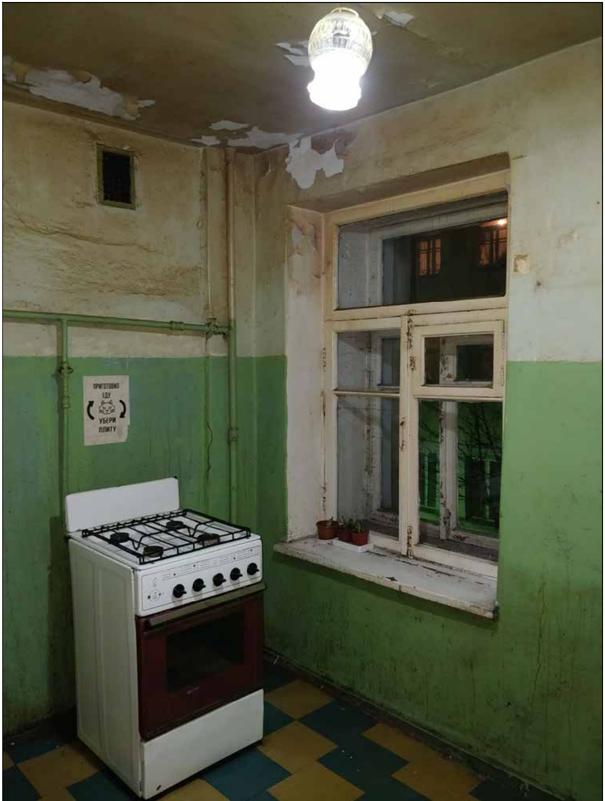
26. Выявленный объект культурного наследия «Дом Ц.А. Кавоса (А. И. Сулова)». Квартира № 5. Помещение № 7. Оконный проем в юго-восточной части помещения. 19.08.2021 г.
