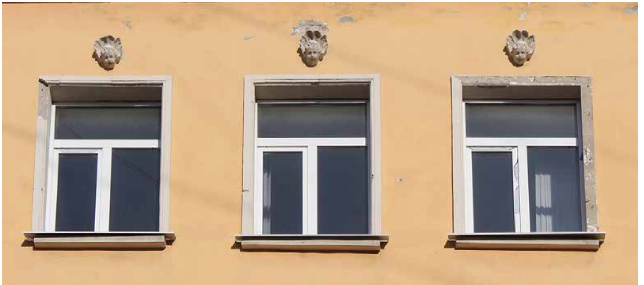
Илл. 75. Спасский пер., 10. Фрагмент лицевого фасада. 2018 г. Код URL: https://p0.citywalls.ru/photo_356-365036.jpg?mt=1539288577 . Дата обращения: 10 мая 2021 г.
