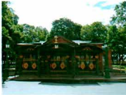
10). Северный лицевой фасад
