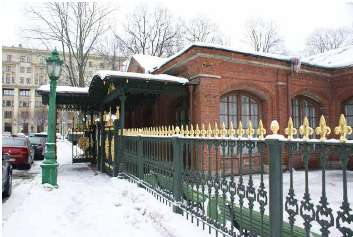
Фото 1. Объект культурного наследия «Домик Петра I». Северо-западный фрагмент фасада. Съемка 24.01.2022 г. Трушковский В.Э.
