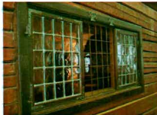
4). Фрагмент западного лицевого фасада
