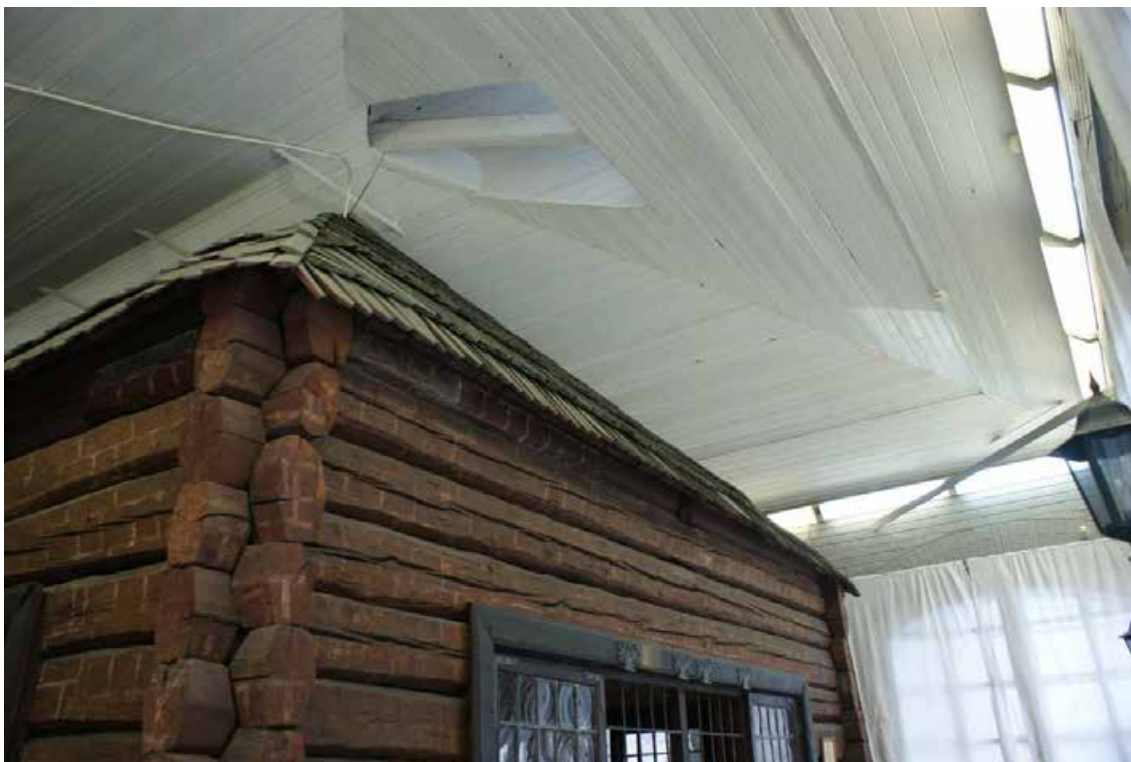
Фото 25. Объект культурного наследия «Футляр домика». Помещение 2/93,7. Съемка 24.01.2022 г. Трушковский В.Э.
