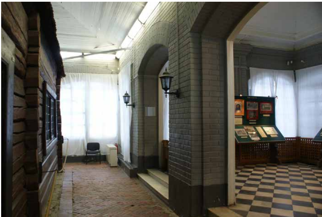
Фото 3. Объект культурного наследия «Футляр домика». Помещение 2/93,7. Съемка 24.01.2022 г. Трушковский В.Э.
