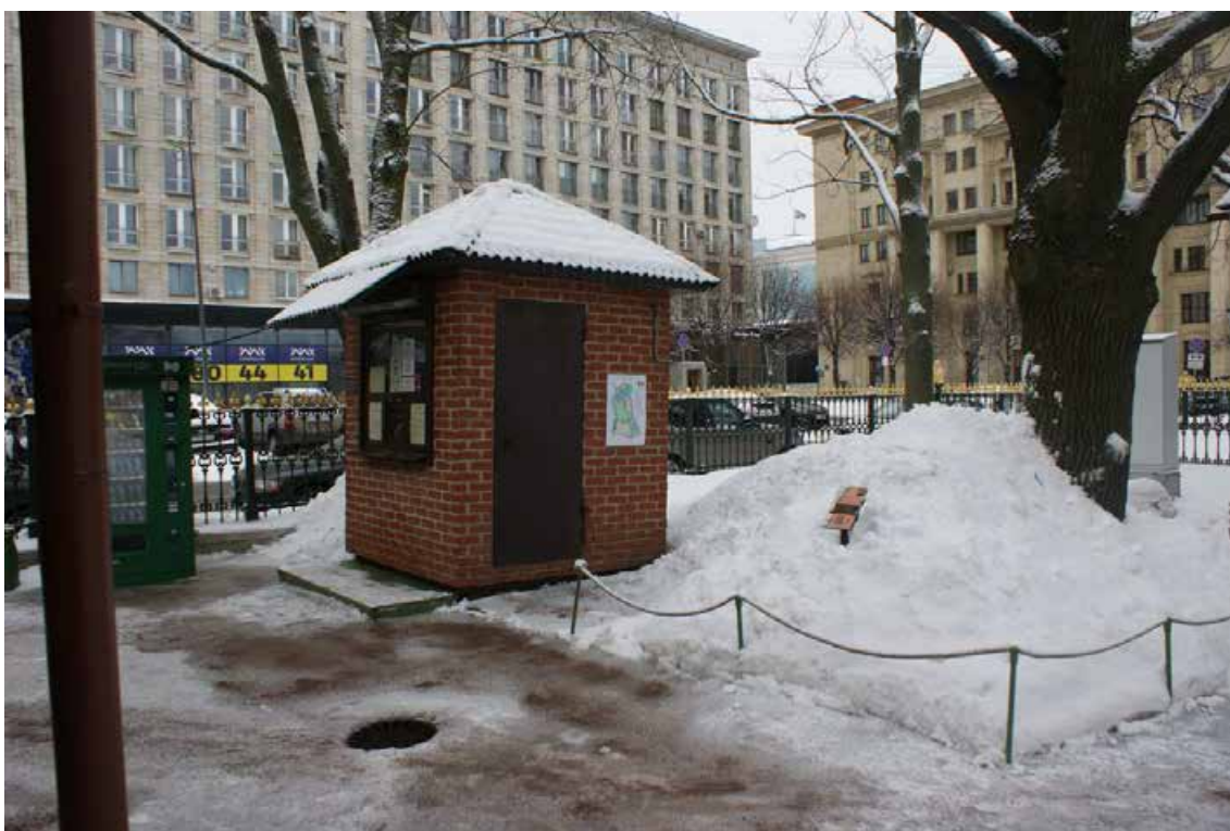
Фото 40. Территория объекта культурного наследия «Домик Петра I». Юго-западный фасад здания кассы. Съемка 24.01.2022 г. Трушковский В.Э.
