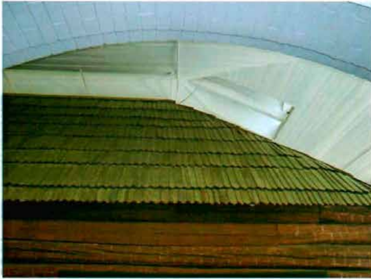
5). Фрагмент кровли домика (колотые сосновые клиновидные дощечки)
