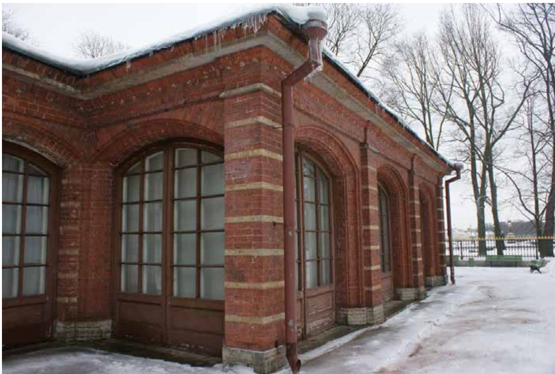
Фото 27. Объект культурного наследия «Футляр домика». Северо-западный фрагмент фасада. Съемка 24.01.2022 г. Трушковский В.Э.
