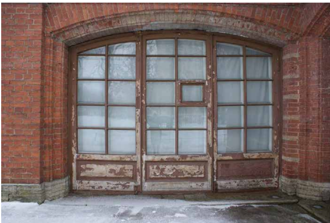
Фото 22. Объект культурного наследия «Футляр домика». Юго-восточный фрагмент фасада. Съемка 24.01.2022 г. Трушковский В.Э.
