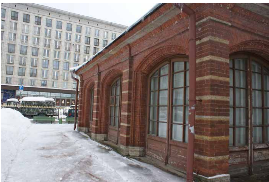
Фото 26. Объект культурного наследия «Футляр домика». Юго-западный фрагмент фасада. Съемка 24.01.2022 г. Трушковский В.Э.
