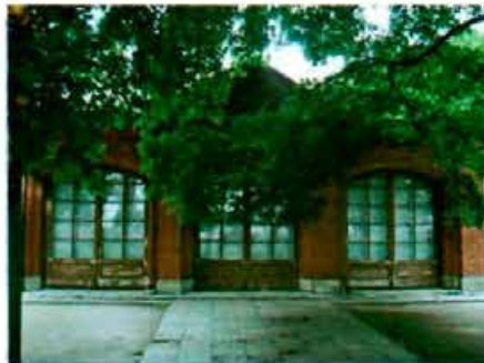
12). Южный дворовый фасад
