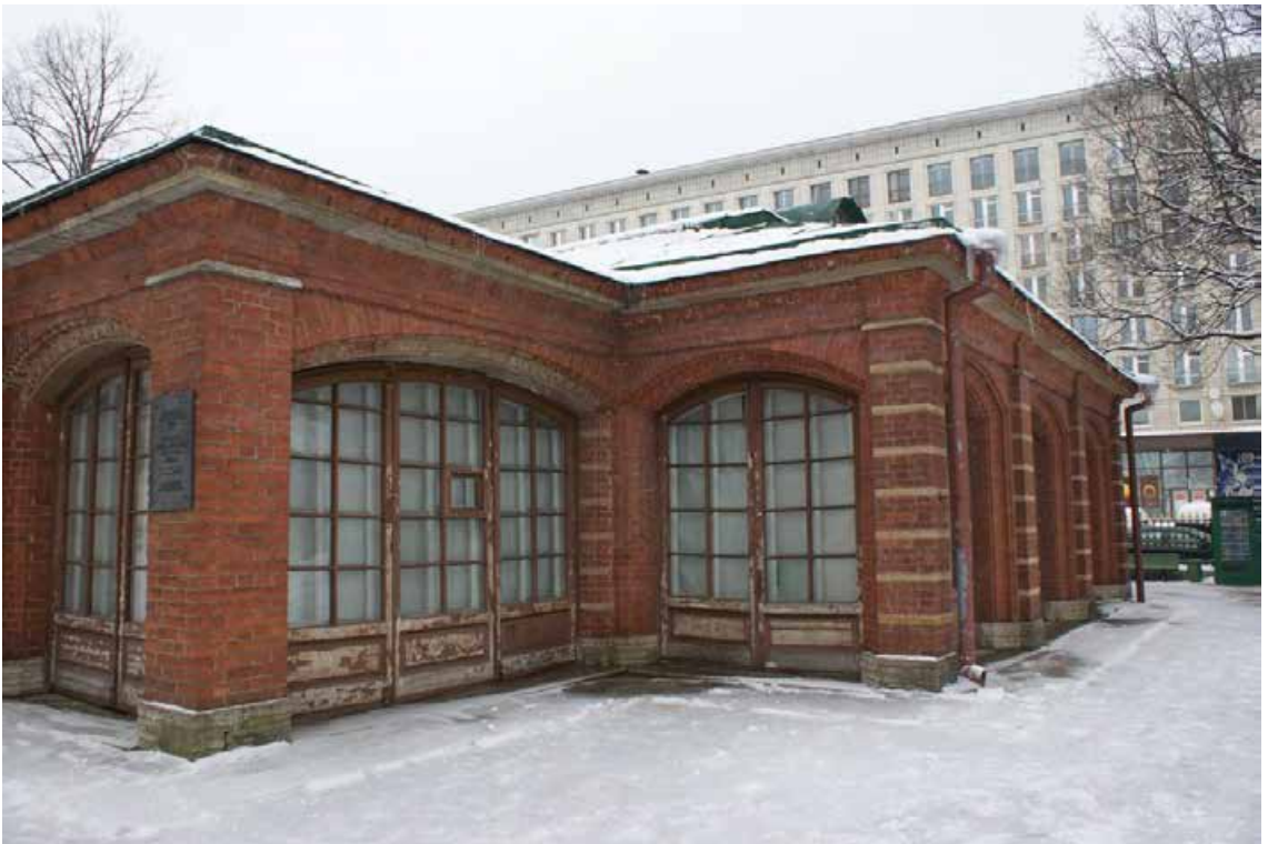
Фото 20. Объект культурного наследия «Футляр домика». Юго-восточный фрагмент фасада. Съемка 24.01.2022 г. Трушковский В.Э.
