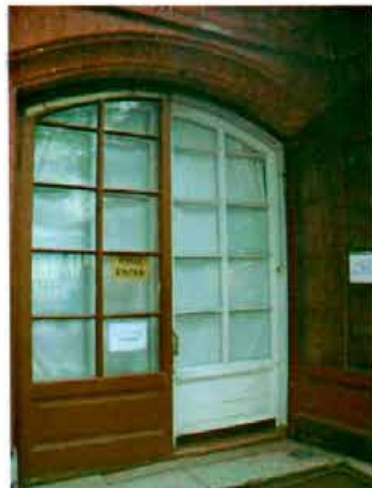
14). Дверной проем северный лицевой фасад
