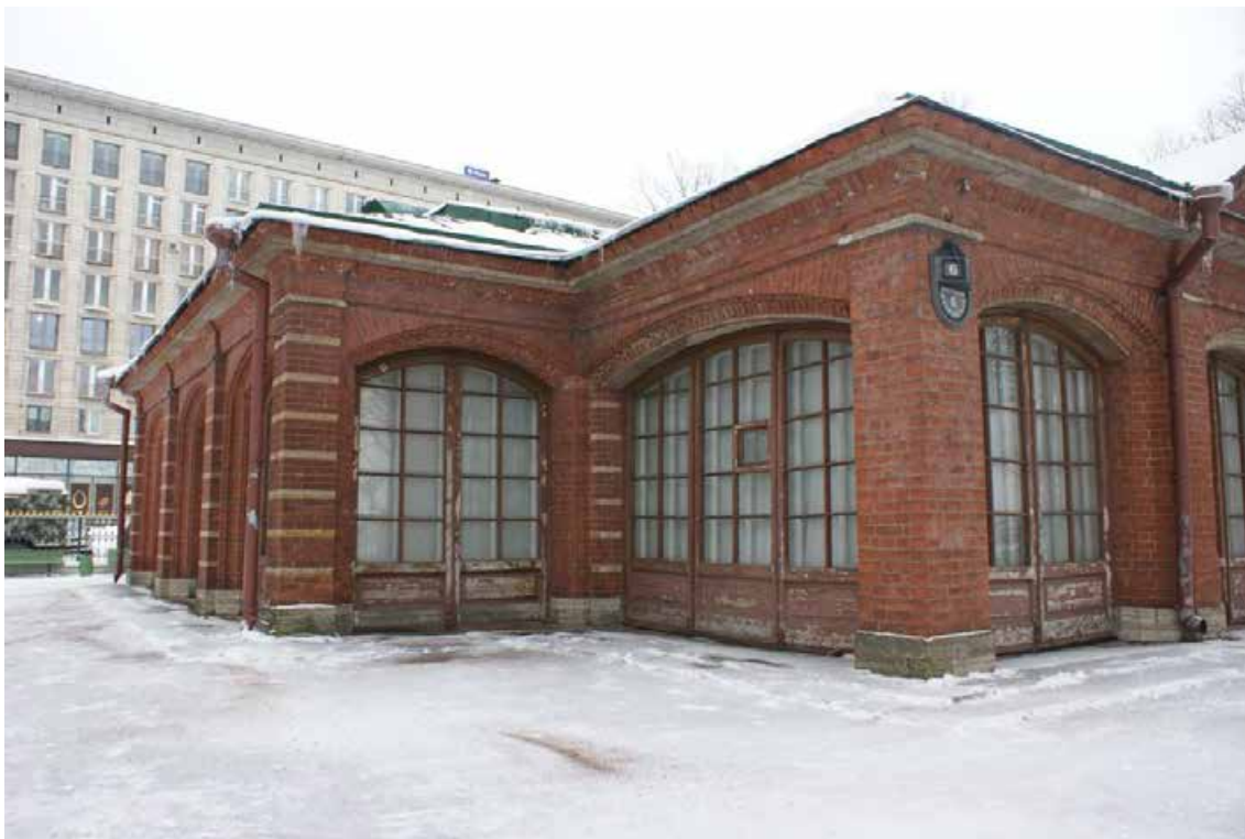
Фото 25. Объект культурного наследия «Футляр домика». Юго-западный фрагмент фасада. Съемка 24.01.2022 г. Трушковский В.Э.
