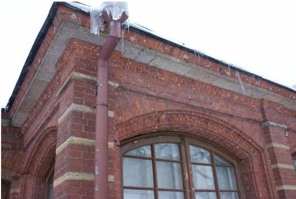
Фото 21. Объект культурного наследия «Футляр домика». Юго-восточный фрагмент фасада. Съемка 24.01.2022 г. Трушковский В.Э.
