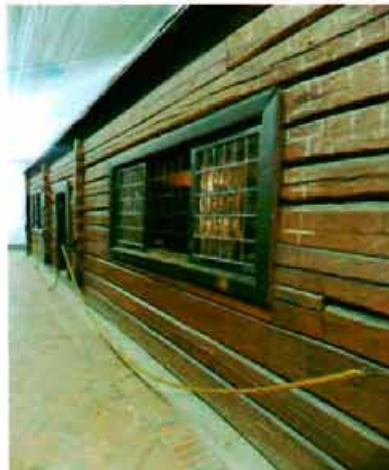
3). Фрагмент восточного лицевого фасада
