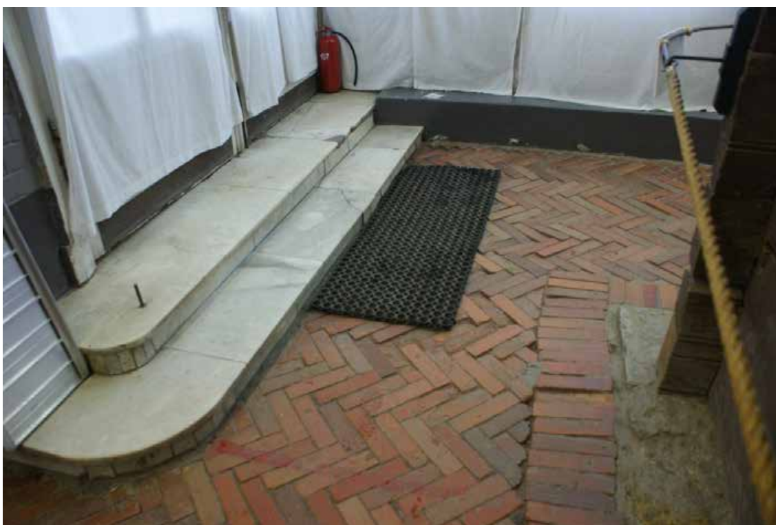
Фото 2. Объект культурного наследия «Футляр домика». Помещение 2/93,7. Съемка 24.01.2022 г. Трушковский В.Э.
