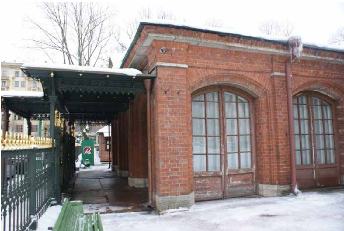
Фото 29. Объект культурного наследия «Футляр домика». Северо-западный фрагмент фасада. Съемка 24.01.2022 г. Трушковский В.Э.
