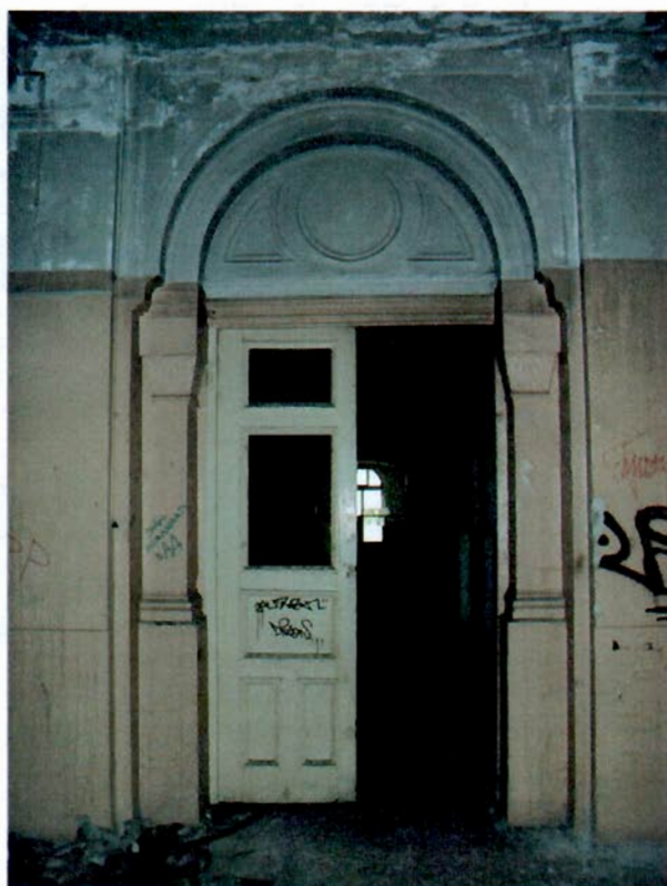
Фото 19. Помещения 2-го этажа. Фрагмент. Полупилоны с кубическими капителями.
