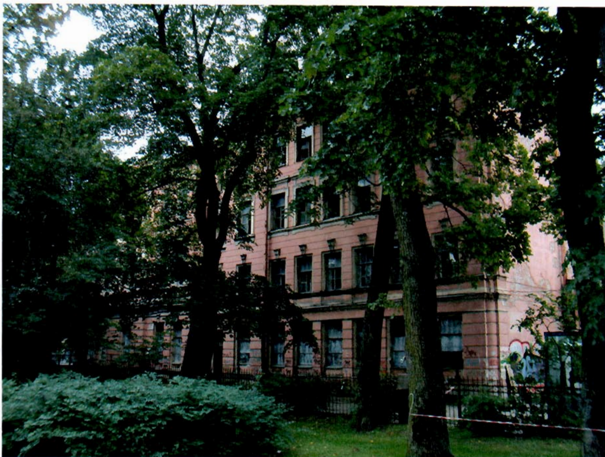
Фото 5. Северо-западный фасад. Фрагмент.
