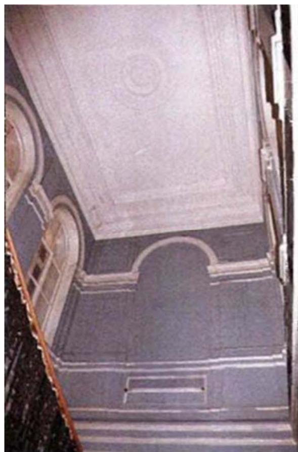
47. Фотография перекрытия 3-го этажа над парадной лестницей, 2000.
