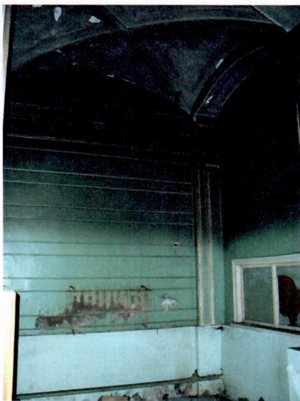
Фото 18. Парадный вестибюль. Фрагмент. Ленточный руст.
