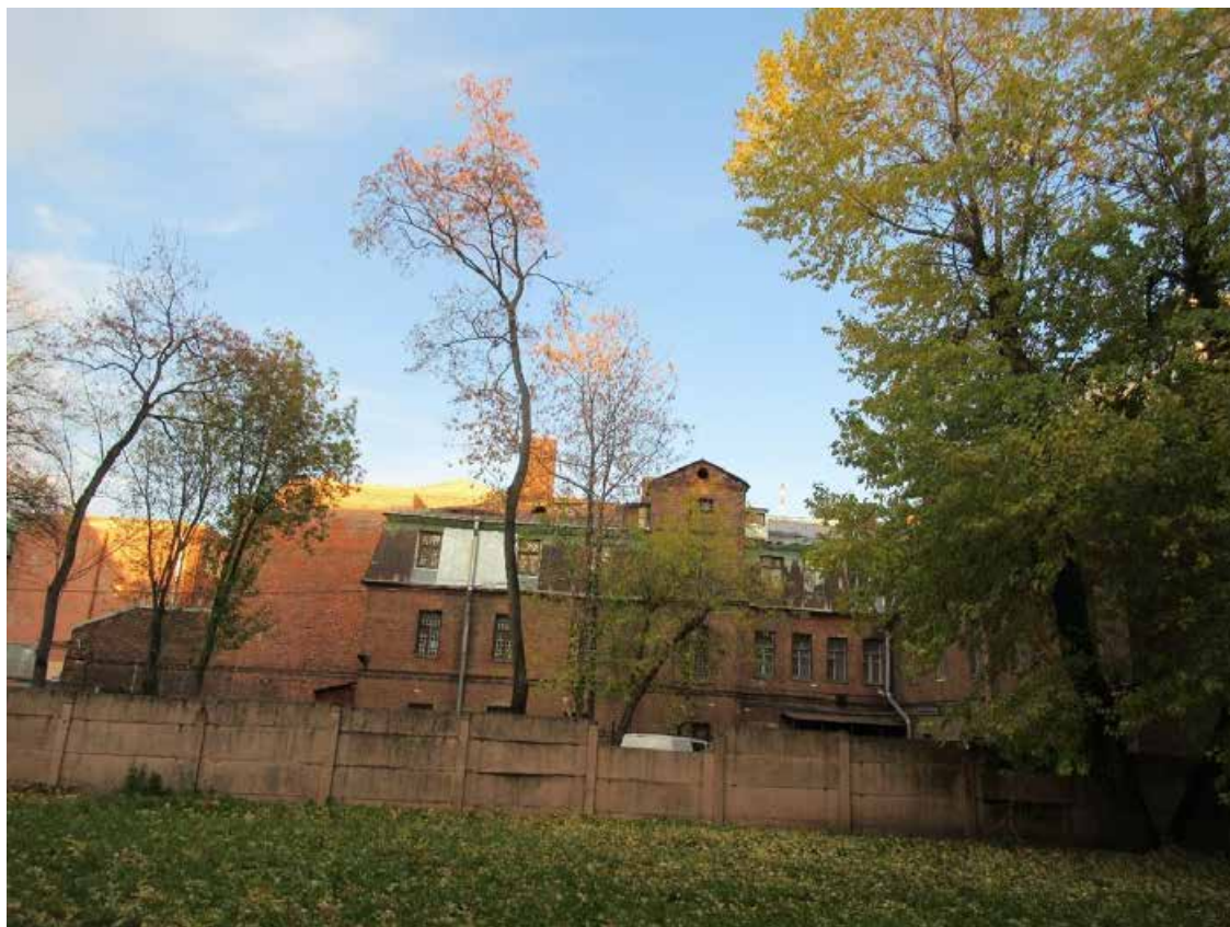
9. ОКН «Здание богадельни и школы Ф.М. Садовникова и С.Г. Герасимова», расположенный по адресу: г. Санкт-Петербург, Каменноостровский проспект, дом 66, лит. А. Западный фасад прямоугольной пристройки. Дата фотофиксации: 15.10.2021.
