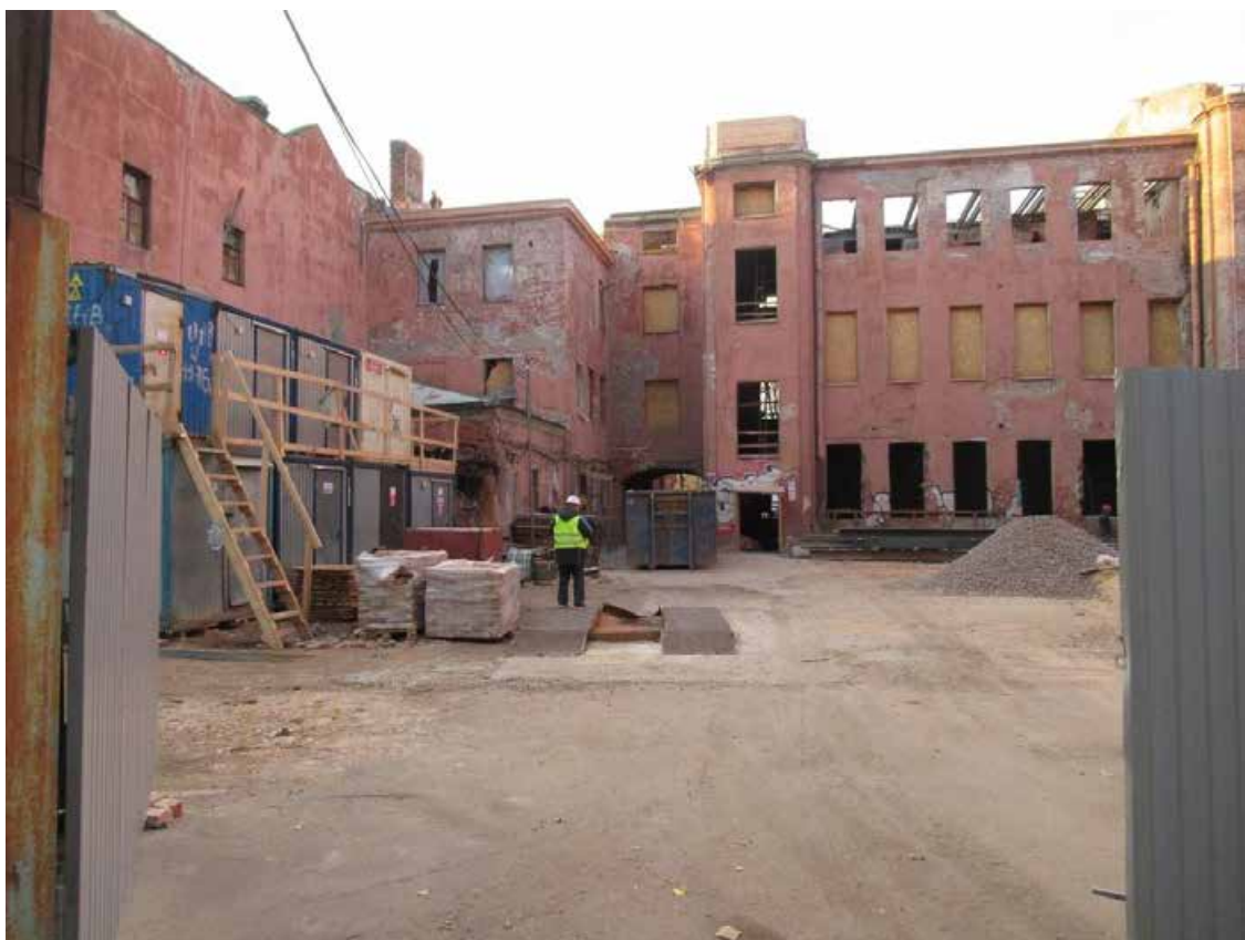
6. ОКН «Здание богадельни и школы Ф.М. Садовникова и С.Г. Герасимова», расположенный по адресу: г. Санкт-Петербург, Каменноостровский проспект, дом 66, лит. А. Дворовый фасад. Дата фотофиксации: 15.10.2021.
