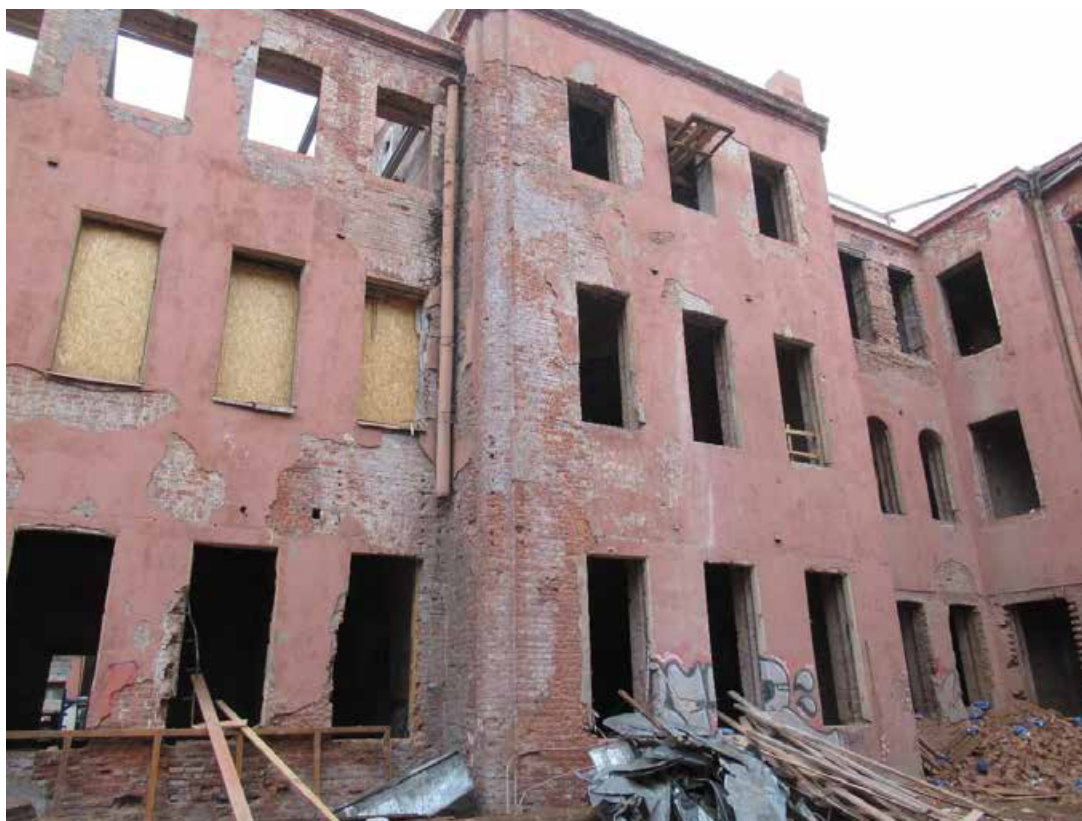
20. ОКН «Здание богадельни и школы Ф.М. Садовникова и С.Г. Герасимова», расположенный по адресу: г. Санкт-Петербург, Каменноостровский проспект, дом 66, лит. А. Дворовый фасад. Дата фотофиксации: 15.10.2021.
