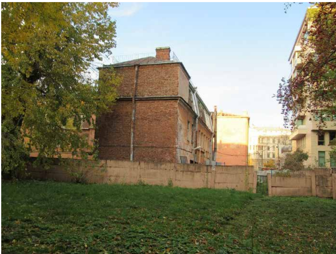
8. ОКН «Здание богадельни и школы Ф.М. Садовникова и С.Г. Герасимова», расположенный по адресу: г. Санкт-Петербург, Каменноостровский проспект, дом 66, лит. А. Западный фасад прямоугольной пристройки. Дата фотофиксации: 15.10.2021.
