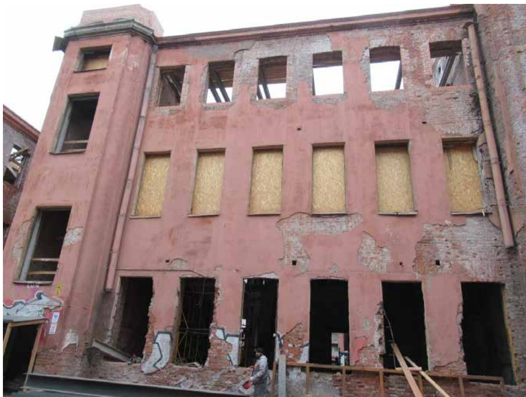
19. ОКН «Здание богадельни и школы Ф.М. Садовникова и С.Г. Герасимова», расположенный по адресу: г. Санкт-Петербург, Каменноостровский проспект, дом 66, лит. А. Дворовый фасад. Дата фотофиксации: 15.10.2021.
