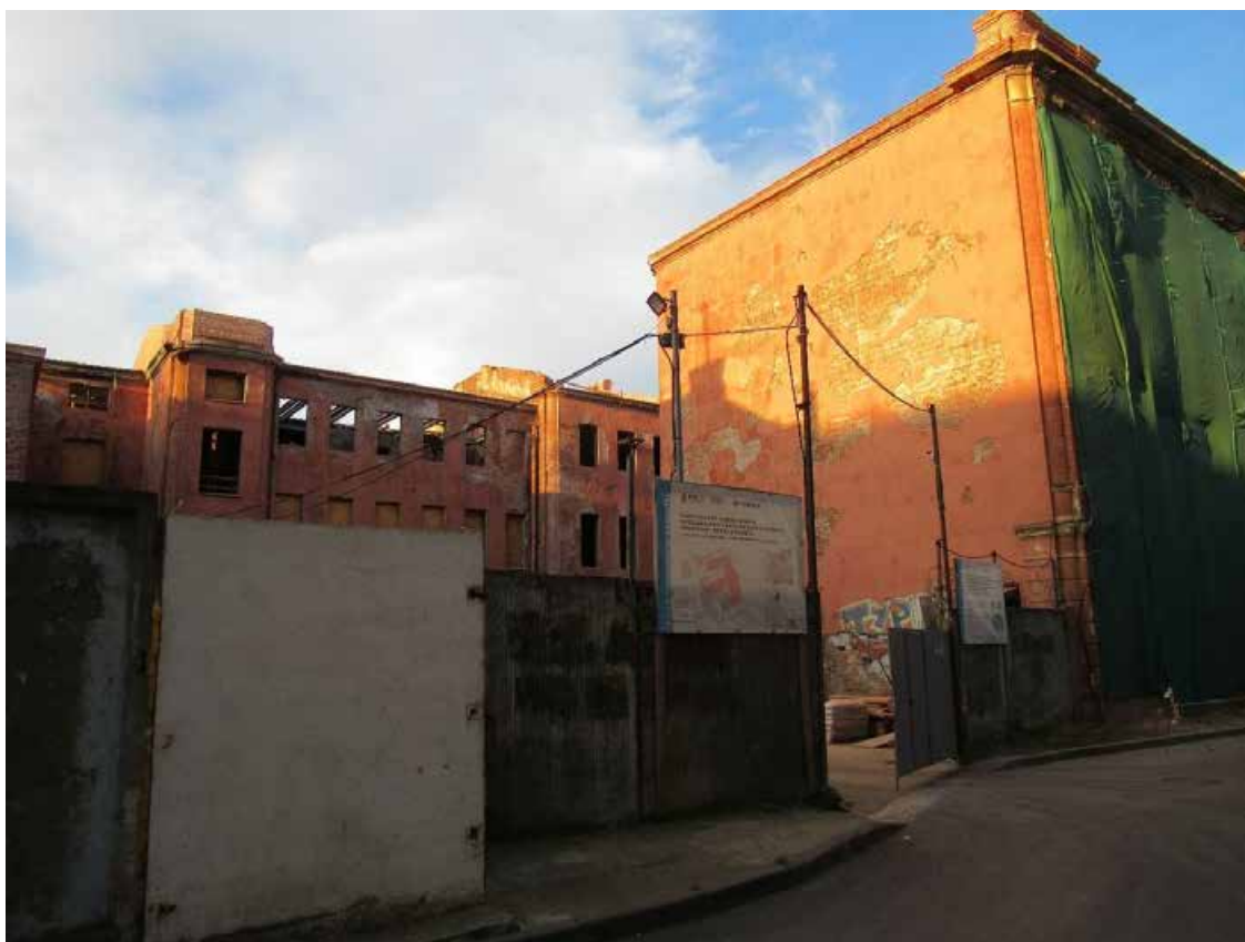
4. ОКН «Здание богадельни и школы Ф.М. Садовникова и С.Г. Герасимова», расположенный по адресу: г. Санкт-Петербург, Каменноостровский проспект, дом 66, лит. А. Юго-западный фасад. Дата фотофиксации: 15.10.2021.
