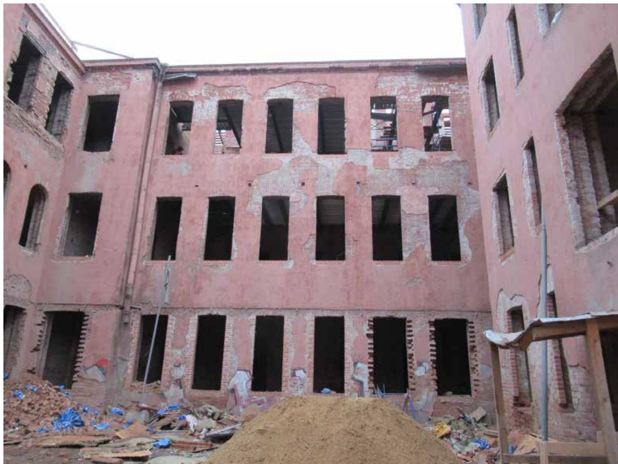
21. ОКН «Здание богадельни и школы Ф.М. Садовникова и С.Г. Герасимова», расположенный по адресу: г. Санкт-Петербург, Каменноостровский проспект, дом 66, лит. А. Дворовый фасад. Дата фотофиксации: 15.10.2021.
