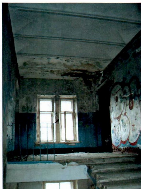
Фото 15. Служебная лестница. Фрагмент. Прусские своды.
