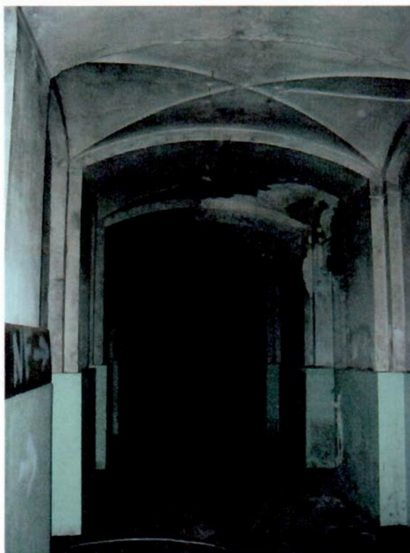
Фото 16. Коридорная система крестовых сводов. Фрагмент.
