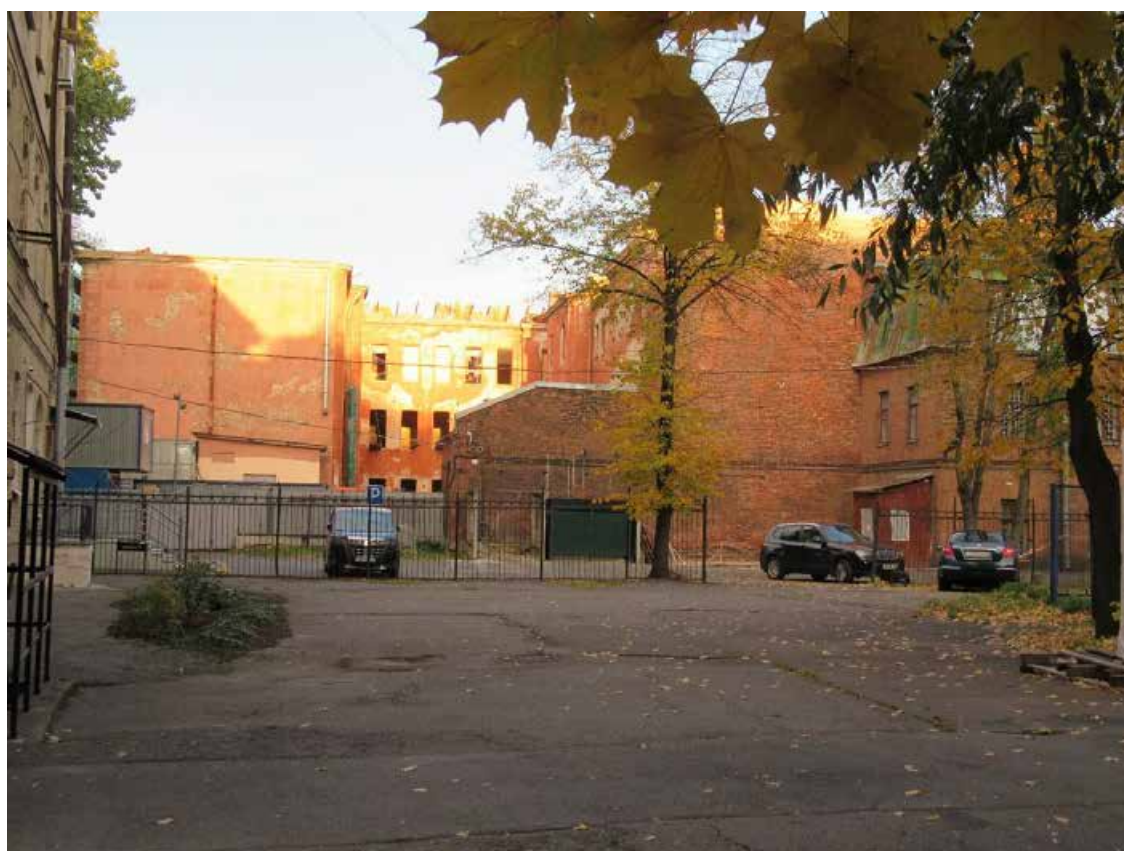
10. ОКН «Здание богадельни и школы Ф.М. Садовникова и С.Г. Герасимова», расположенный по адресу: г. Санкт-Петербург, Каменноостровский проспект, дом 66, лит. А. Западный фасад. Дата фотофиксации: 15.10.2021.
