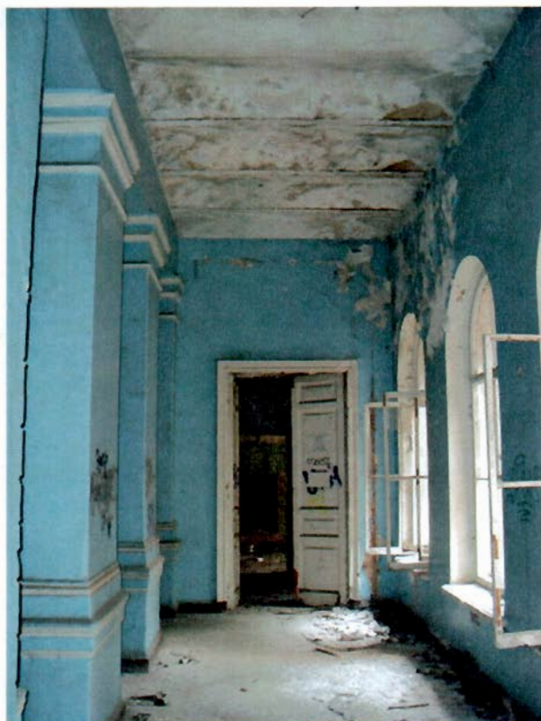
Фото 17. Галерея в уровне 2-го этажа. Прусские своды. Пилоны.
