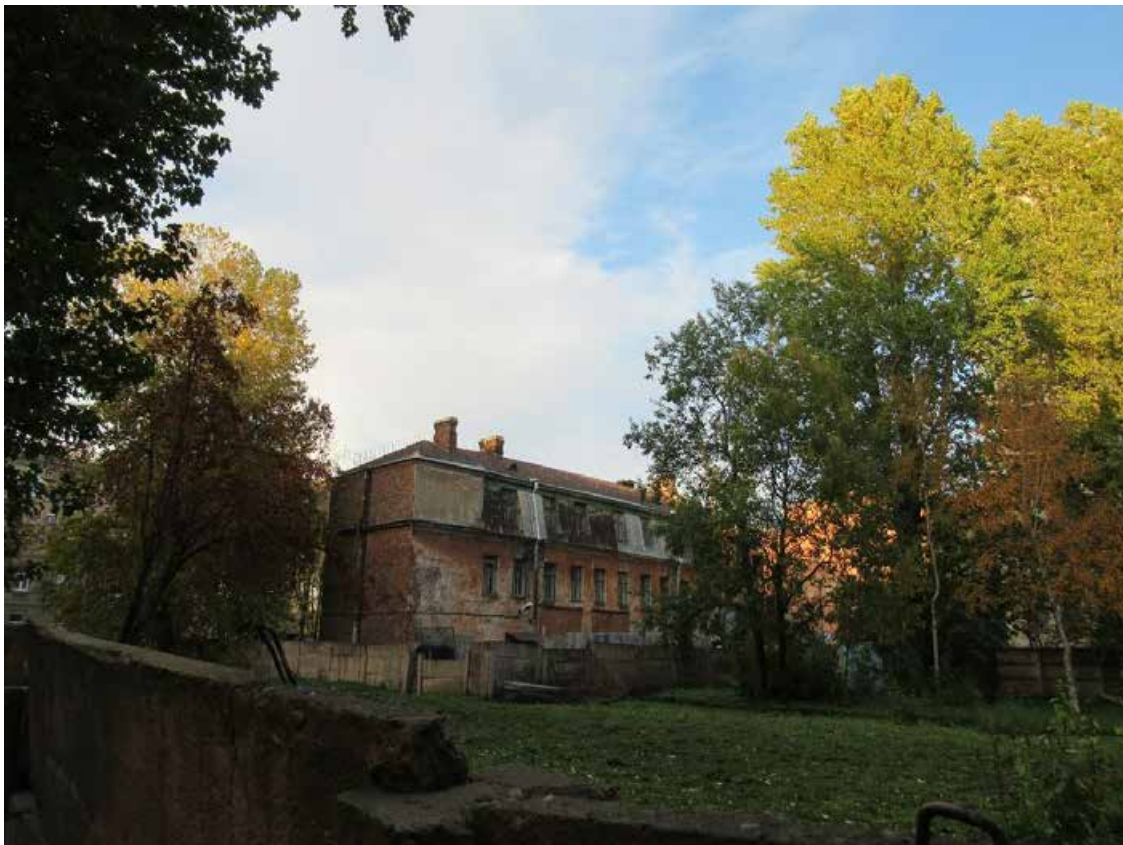
7. ОКН «Здание богадельни и школы Ф.М. Садовникова и С.Г. Герасимова», расположенный по адресу: г. Санкт-Петербург, Каменноостровский проспект, дом 66, лит. А. Южный фасад прямоугольной пристройки. Дата фотофиксации: 15.10.2021.
