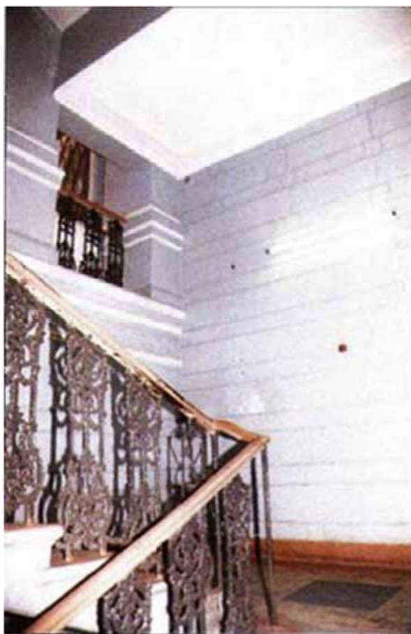
46. Фотография площадки парадной лестницы между 1-м и 2-м этажами, 2000.
