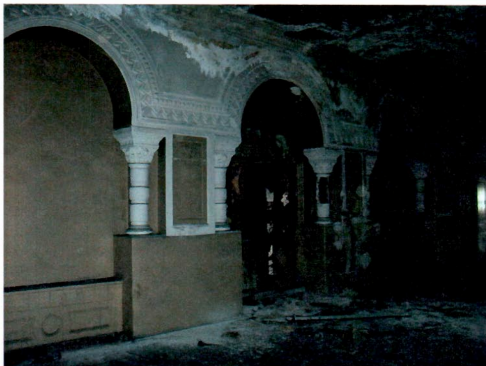
Фото 20. Помещения 3-го этажа. Фрагмент. Глубокие ниши. Колонны.
