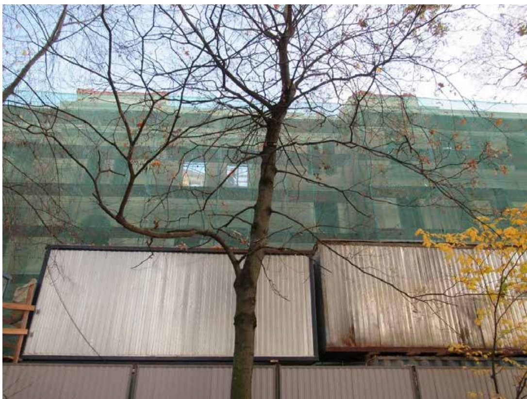
14. ОКН «Здание богадельни и школы Ф.М. Садовникова и С.Г. Герасимова», расположенный по адресу: г. Санкт-Петербург, Каменноостровский проспект, дом 66, лит. А. Северный фасад. Дата фотофиксации: 15.10.2021.
