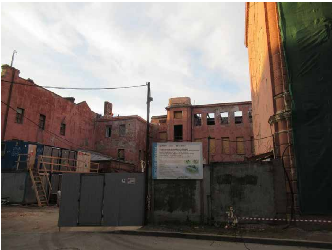
3. ОКН «Здание богадельни и школы Ф.М. Садовникова и С.Г. Герасимова», расположенный по адресу: г. Санкт-Петербург, Каменноостровский проспект, дом 66, лит. А. Дворовый фасад. Дата фотофиксации: 15.10.2021.
