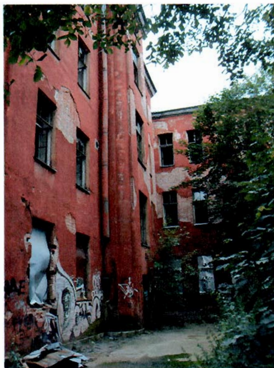
Фото 9. Северо-восточный и юго-западный (дворовые) фасады.
