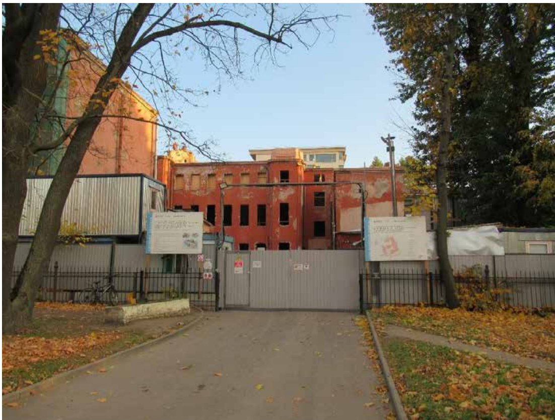
15. ОКН «Здание богадельни и школы Ф.М. Садовникова и С.Г. Герасимова», расположенный по адресу: г. Санкт-Петербург, Каменноостровский проспект, дом 66, лит. А. Северо-западный фасад. Дата фотофиксации: 15.10.2021.
