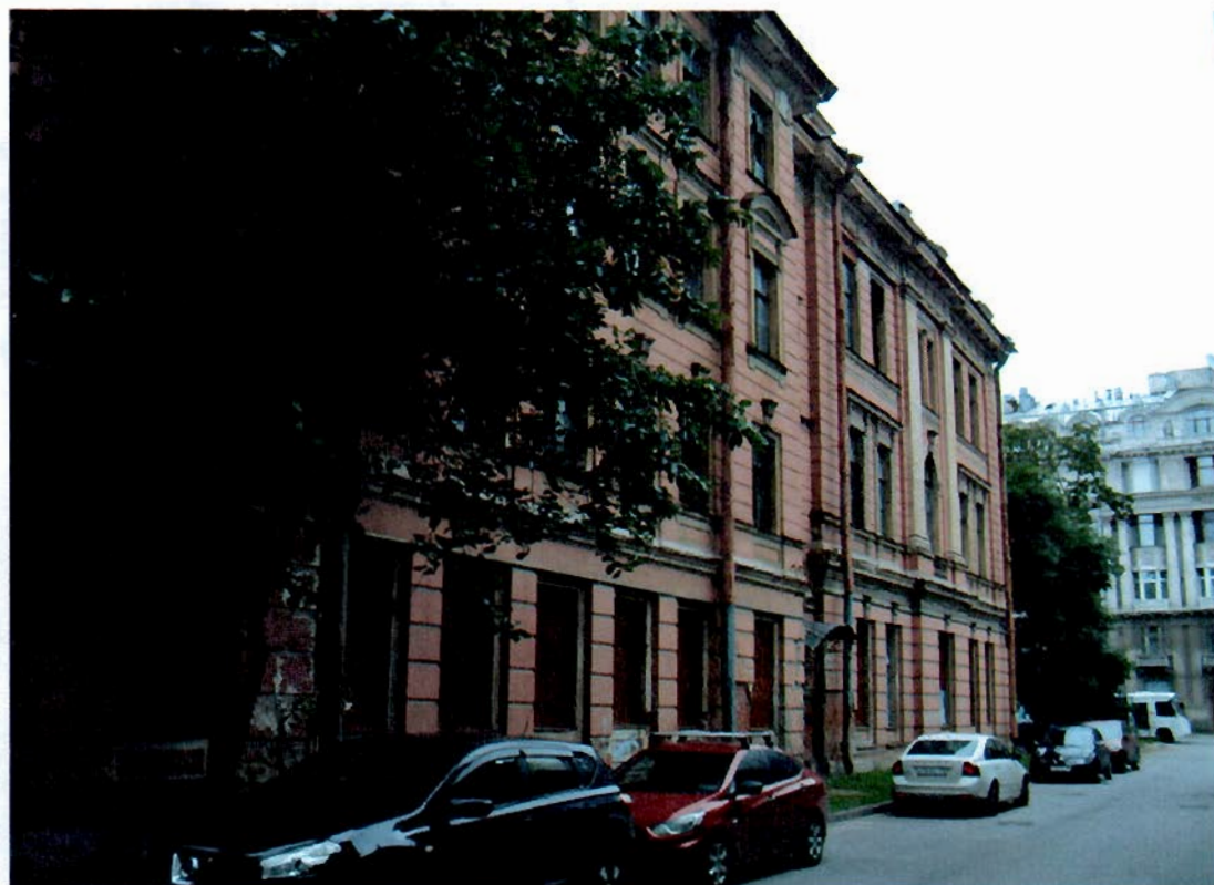
Фото 4. Юго-восточный фасад. Фрагмент.
