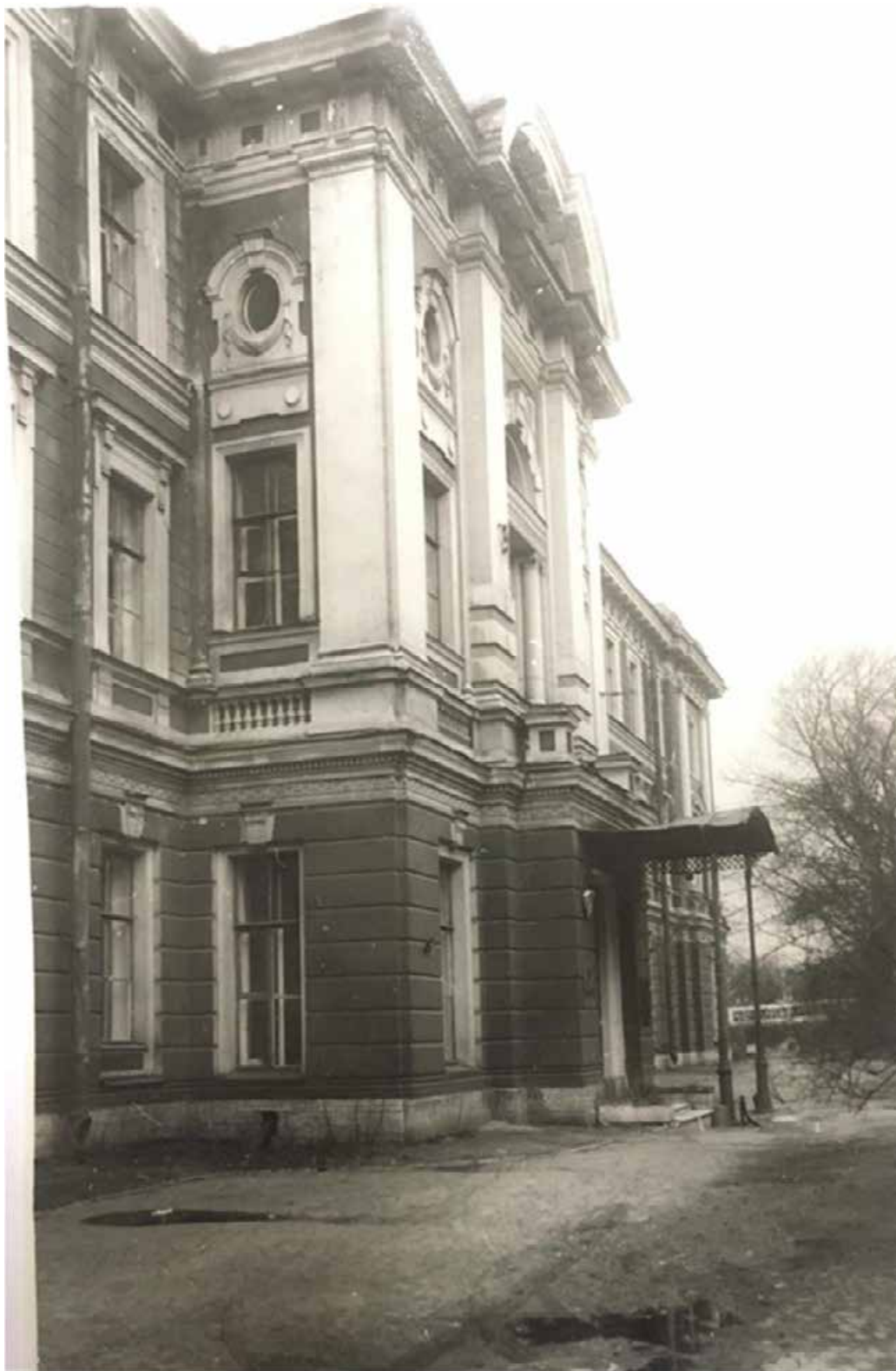
39. Фотография «Вид части фасада с главным входом дома № 66/2 по Кировскому проспекту (бывшая богадельня и школа Ф.М. Садовникова и С.Г. Герасимова, архитекторы Ф.С. Харламов, В.И. Токарев, 1881–1883 гг.)», 1975.
