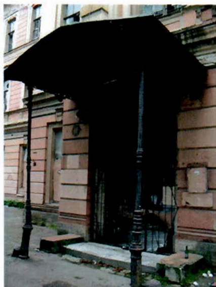
Фото 12. Северо-восточный фасад. Крыльцо парадного входа.
