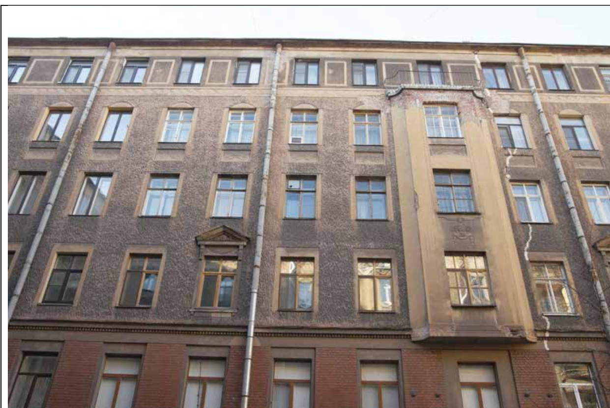
Фото 6. Фрагмент северо-восточного дворового фасада с окнами квартиры № 653 (6 (верхний) этаж).
