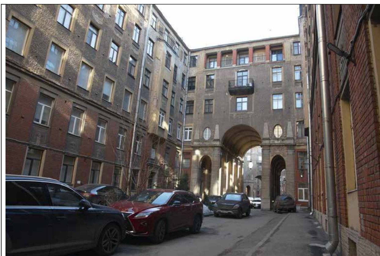
Фото 2. Общий вид внутреннего двора, расположенного ближе к наб. реки Фонтанки.
