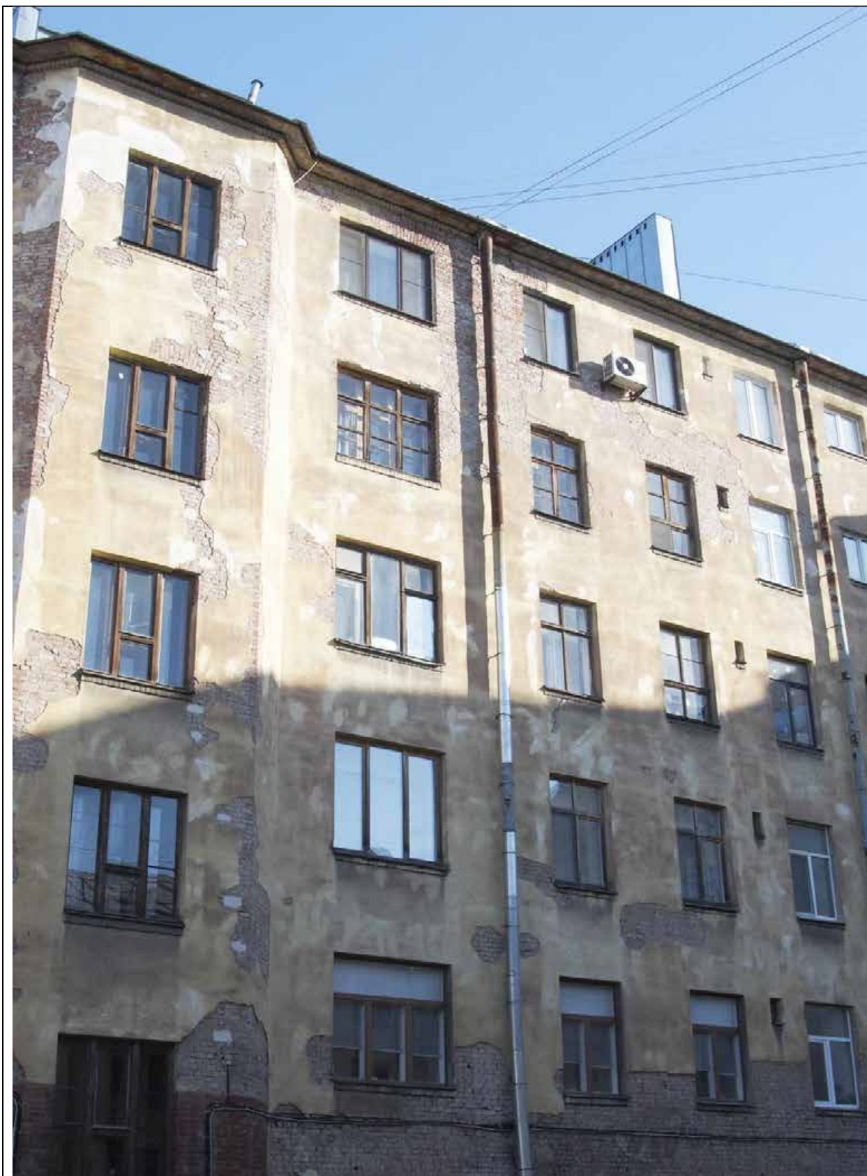
Фото 8. Фрагмент юго-западного дворового фасада с окнами квартиры № 653 (6 (верхний) эт.).
