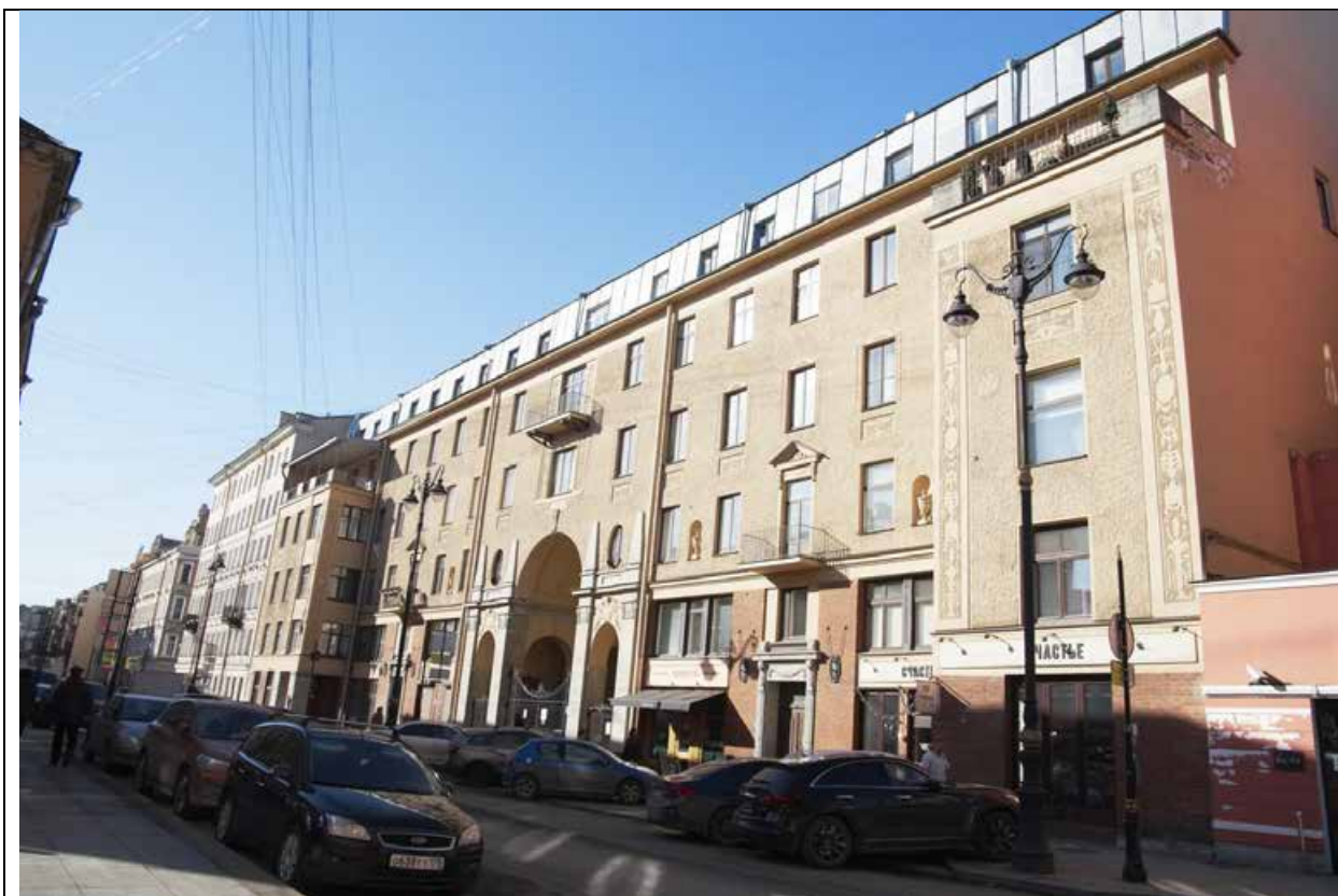
Фото 9. Лицевой фасад по улице Рубинштейна.
