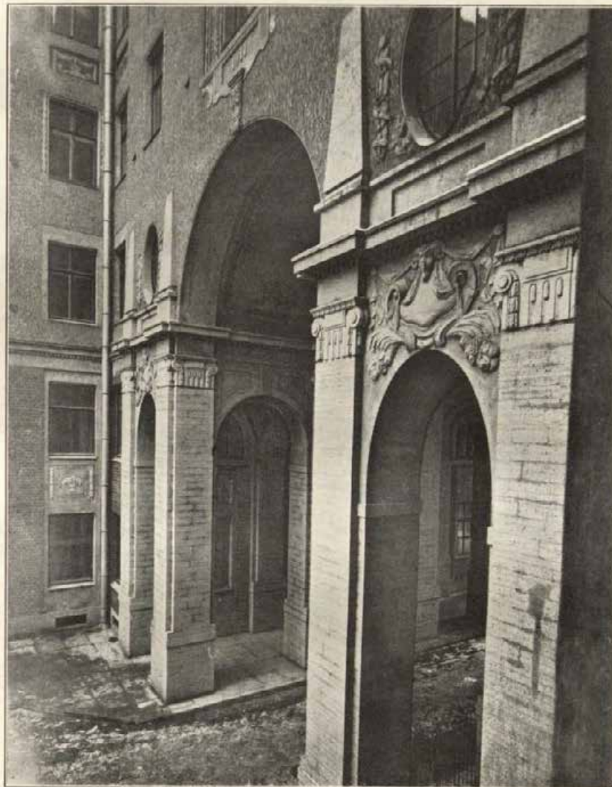
Доходный домъ. С.-Петербургъ, Фонтанка, 52-54. Проект. и стр. Ф. И. ЛИНДВАЛЬ, академ. архит. С.П.Бурга.
