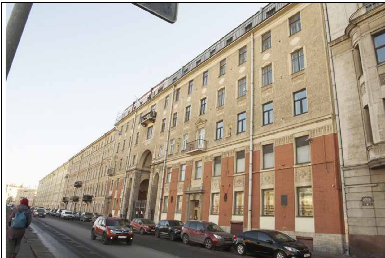
Фото 1. Лицевой фасад по набережной реки Фонтанки.
