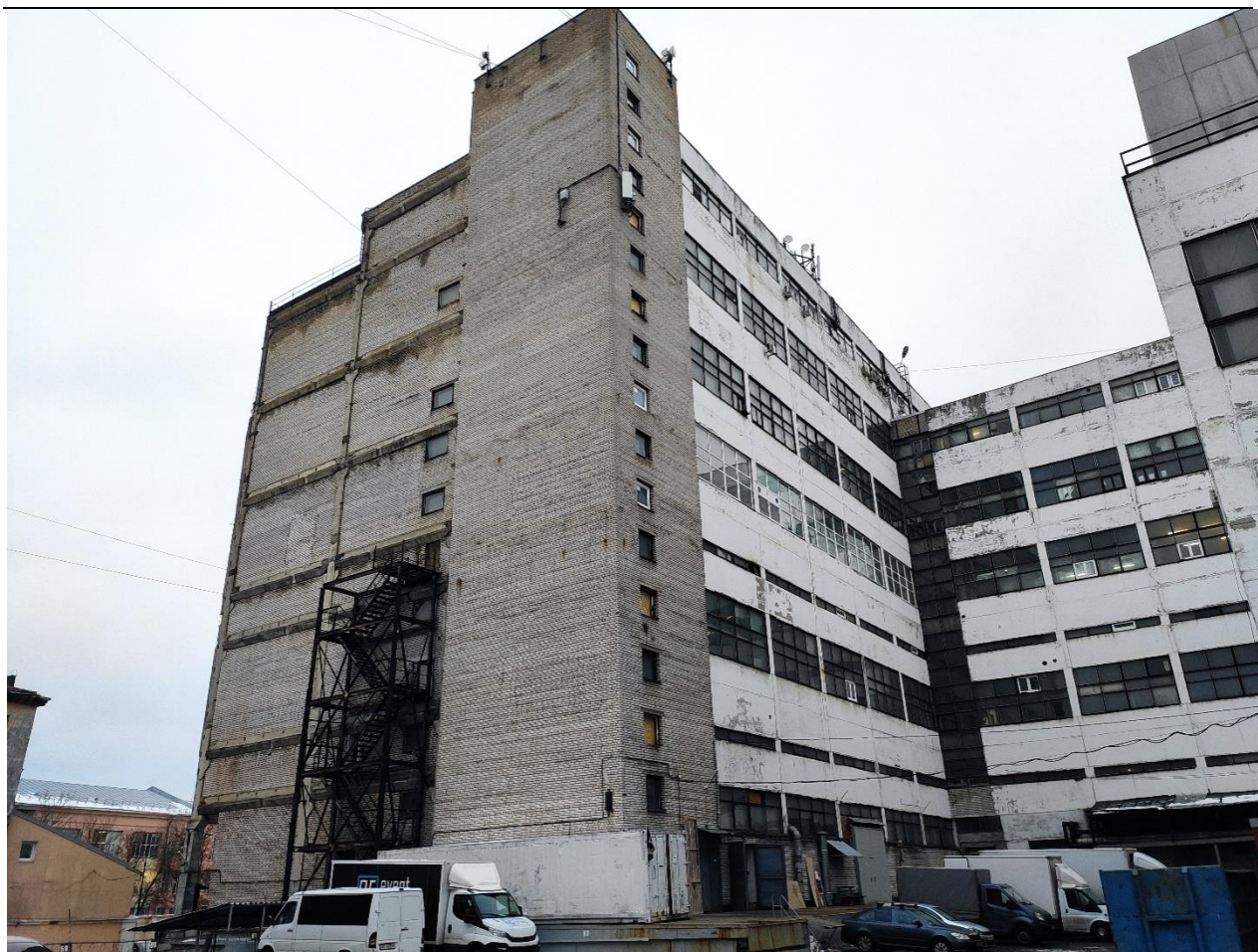
Фото 2 Вид части здания, под которым расположены помещения бывшего убежища
