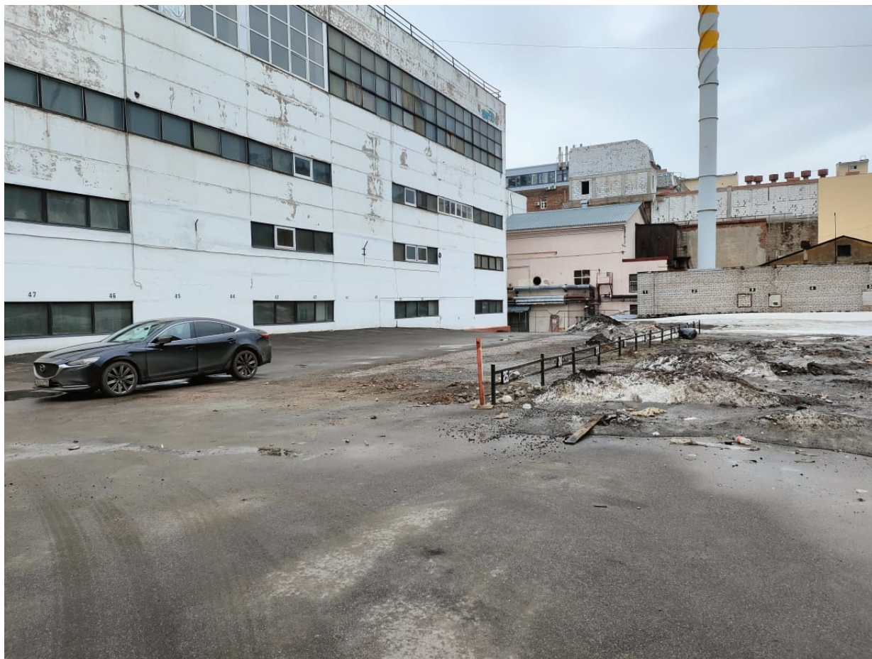
Точка фотофиксации 3. Юго-западная часть участка обследования. Слева - фасад здания, расположенного по адресу: 7-я линия В.О., 82 к. 2. Вид с С.
