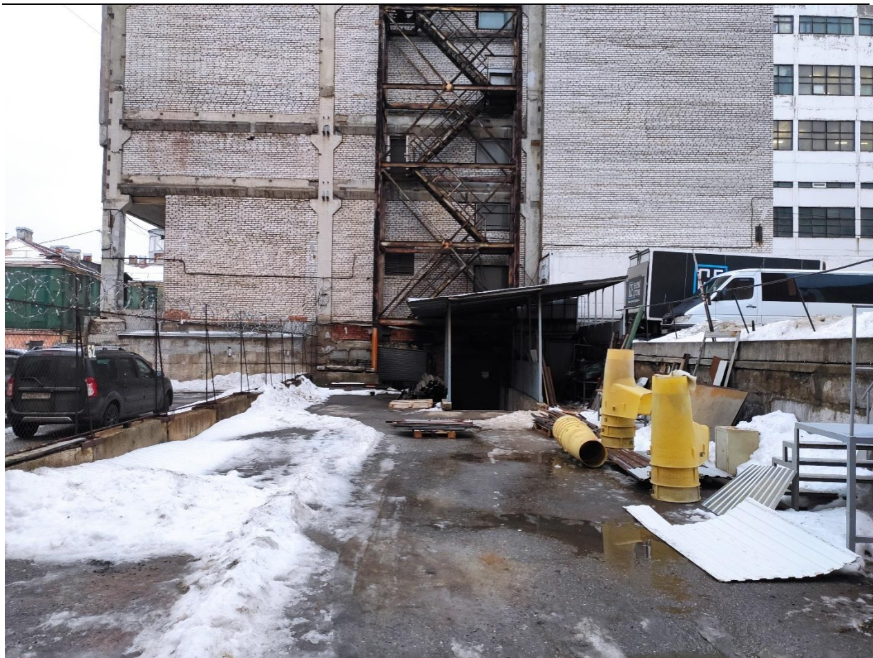
Фото 3 Вид спуска в помещения цокольного этажа
