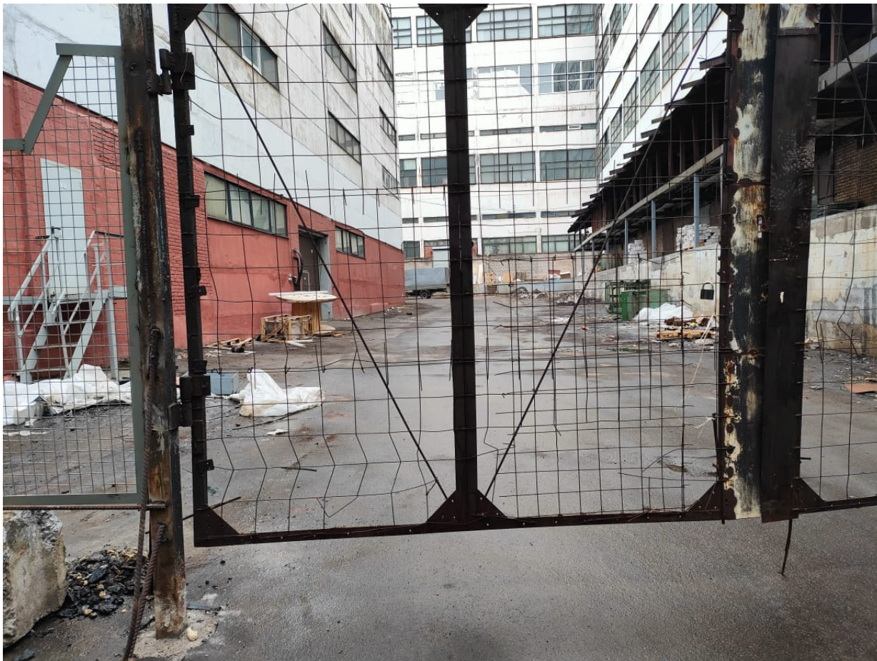
Точка фотофиксации 6. Восточная часть участка обследования. Территория между корпусами, на дальнем плане фрагмент здания, расположенного по адресу: 7-я линия В.О., д. 84, лит. А. Вид с Ю.
