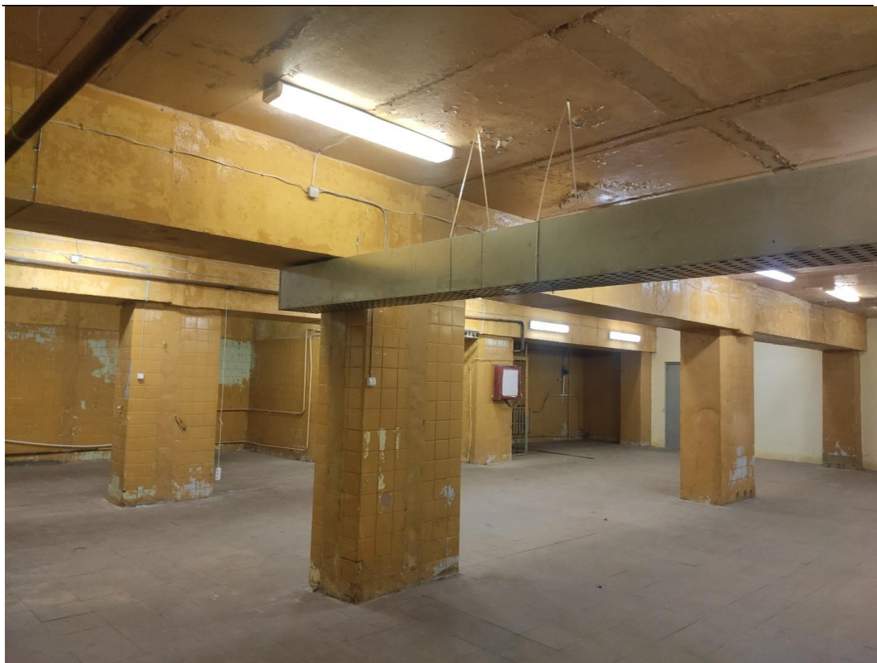
Фото 4 Вид колонн, ригелей и плит перекрытия
