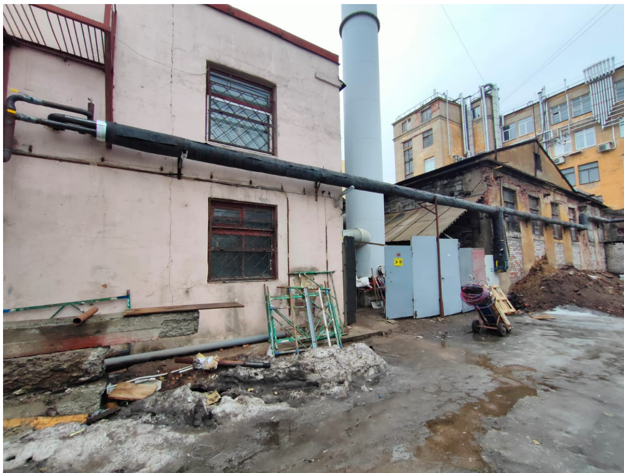
Точка фотофиксации 5. Южная часть участка обследования. Территория вдоль корпусов, расположенных по адресу: 7-я линия В.О., 82, корп. 3 и 83, корп. 2. Вид с С.
