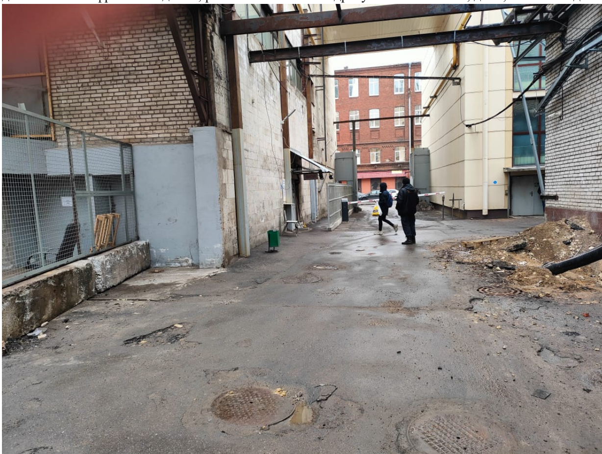
Точка фотофиксации 6. Южная граница участка обследования. Территория между корпусами, выезд с территории на 7-ю линию В.О. Вид с З.
