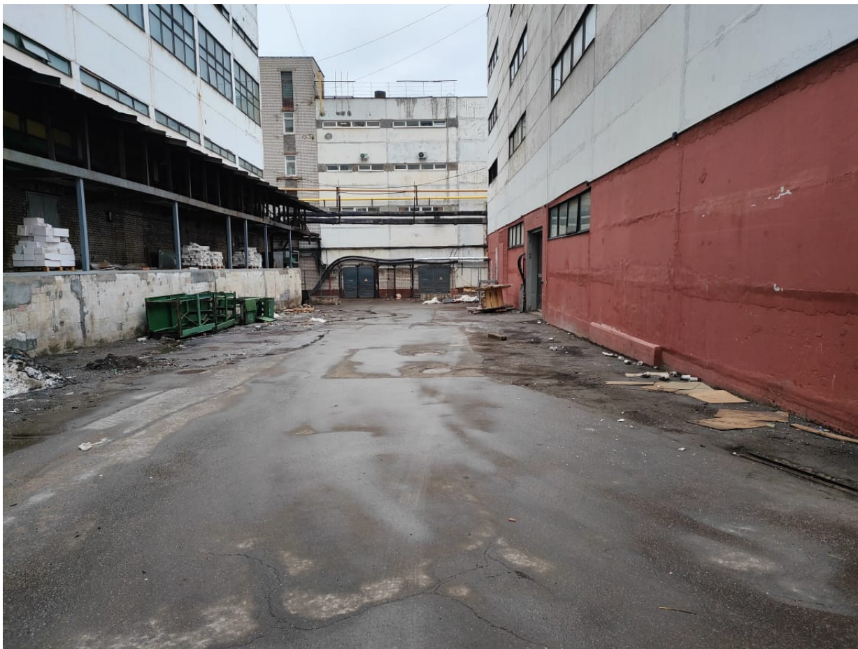
Точка фотофиксации 4. Восточная часть участка обследования. Проезд между корпусами, расположенными по адресам: 7-я линия В.О., 82, к. 2 и 84, лит. А. На дальнем плане - фрагмент здания, расположенного по адресу: 7-я линия В.О., 82, к. 1. Вид с С.
