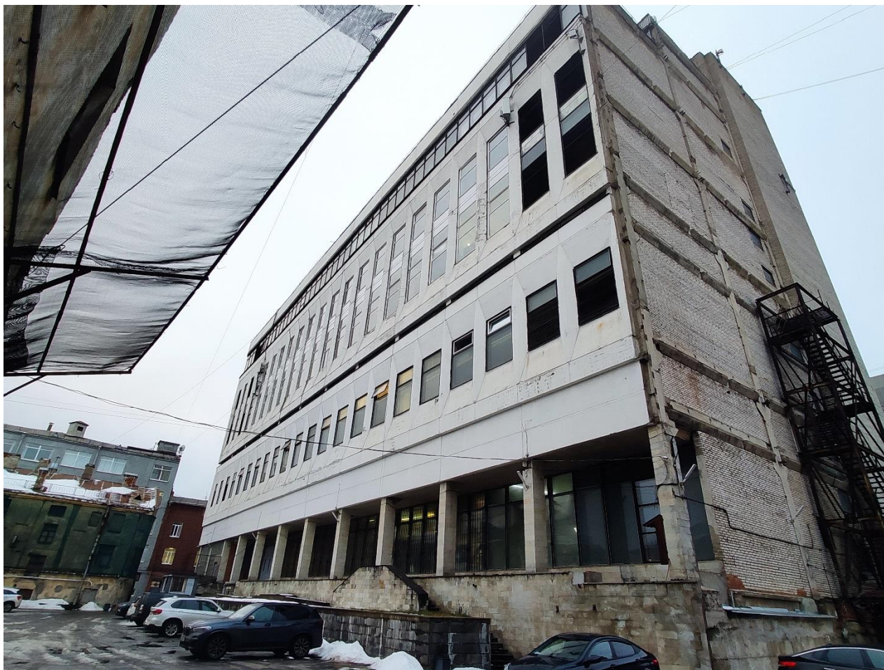
Фото 1 Вид части здания, под которым расположены помещения бывшего убежища
