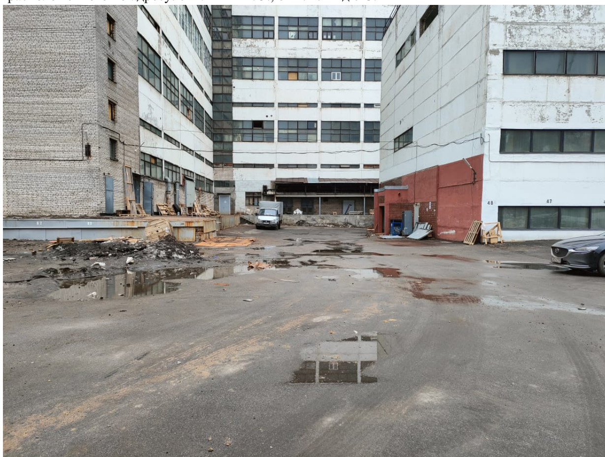
Точка фотофиксации 3. Центральная часть участка обследования. Проезд между корпусами, расположенными по адресам: 7-я линия В.О., 82, к. 2 и 84, лит. А. Вид с З.
