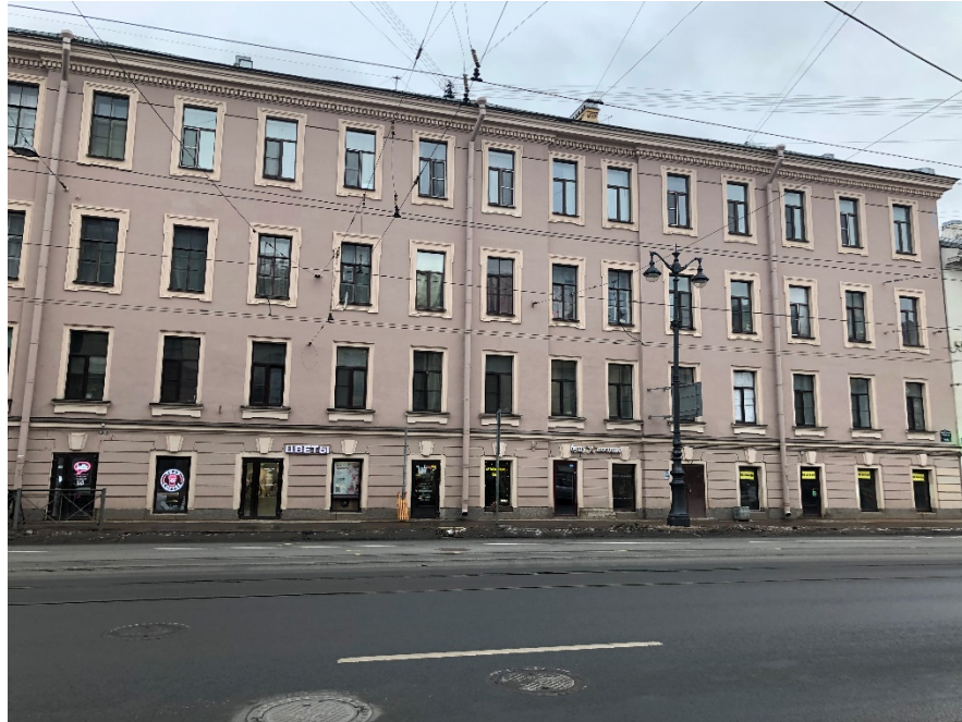
1. Вид на главный фасад;
