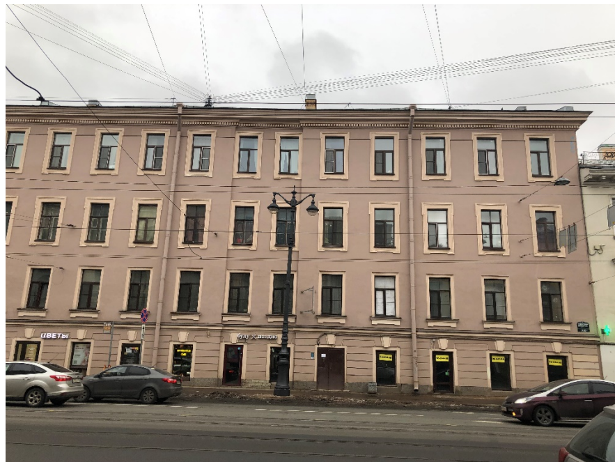
2. Вид на главный фасад;
