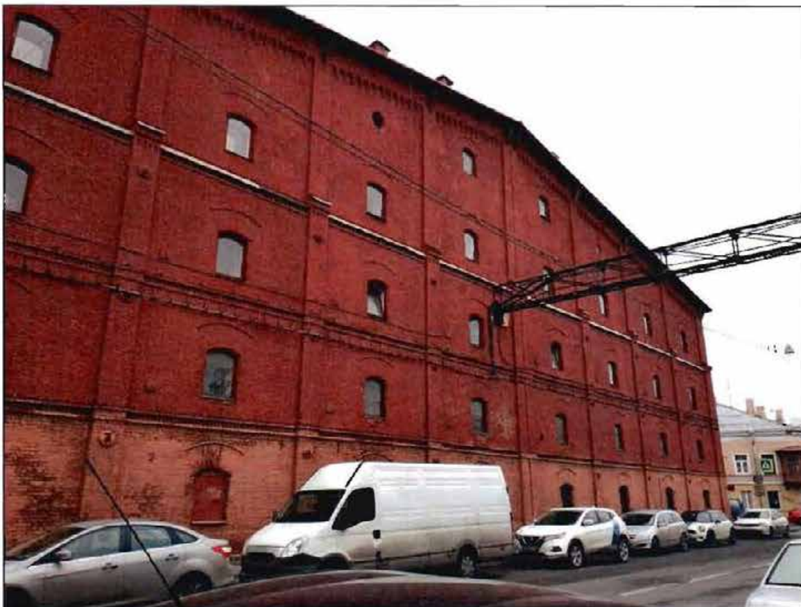
4. Вид на западный фасад.
