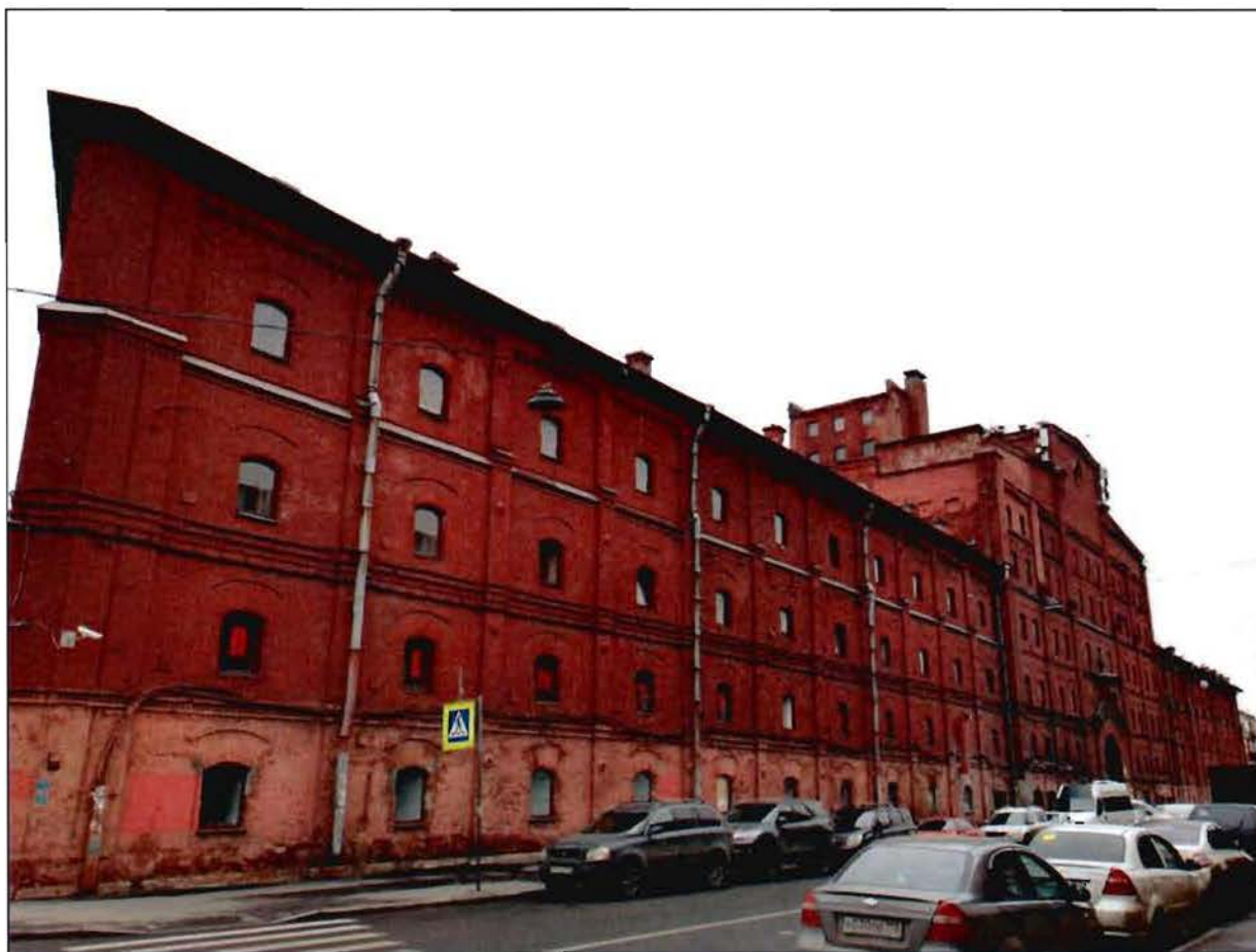
1.Общий вид на южный фасад.
