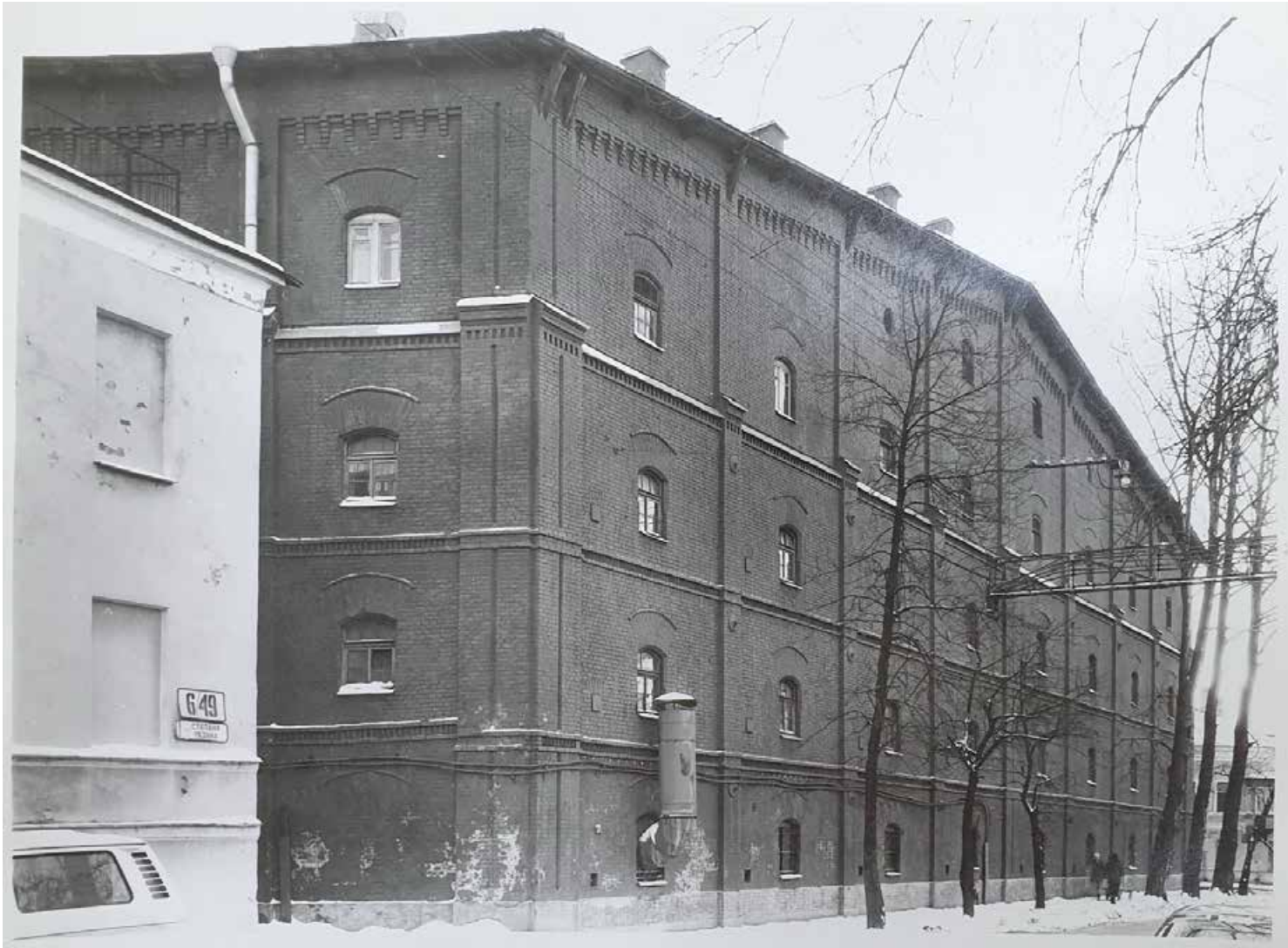
75. Завод им. Степана Разина (быв. Калининский пивоваренный з-д). Солодовня (западный фасад). 1997 г. // Архив КГИОП.
