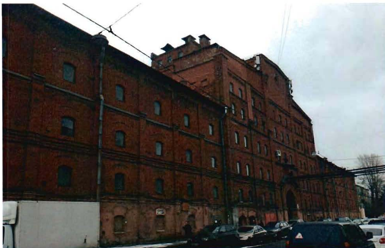
3. Фасад по Курляндской улице. Общий вид.
