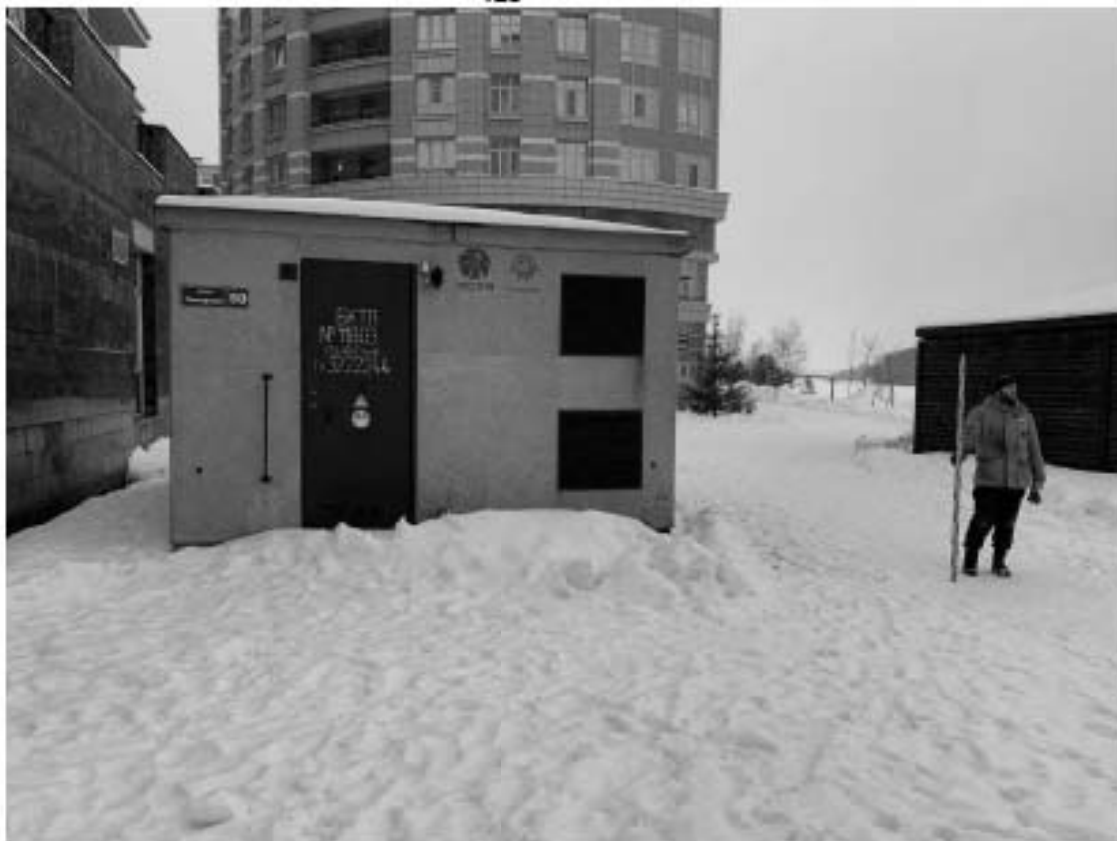
Рис. 60. Санкт-Петербург, Петроградский район, Пионерская ул., Гдовская ул., Новолодожская ул. Точка съемки 12. Общий вид участка обследования. Вид с В.
