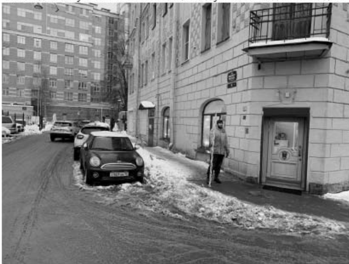
Рис. 35. Санкт-Петербург, Петроградский район, Пионерская ул., Гдовская ул., Новоладожская ул. Точка съемки 3. Общий вид участка обследования. Вид с ЮЮВ.
