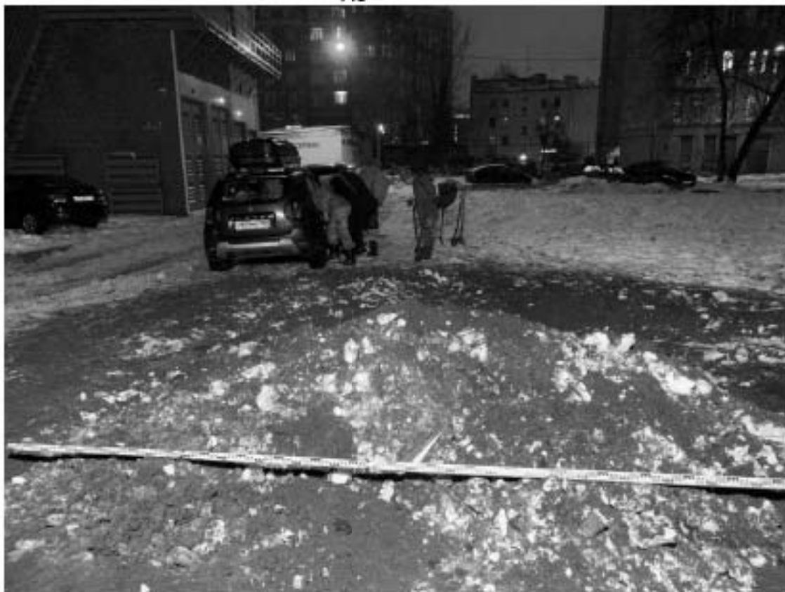
Рис. 93. Санкт-Петербург, Петроградский район, Пионерская ул., Гдовская ул., Новолодожская ул. Шурф 1. Месторасположение Шурфа 1. После рекультивации. Вид с ЮВ.
