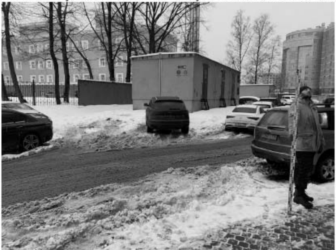
Рис. 43. Санкт-Петербург, Петроградский район, Пионерская ул., Гдовская ул., Новолодожская ул. Точка съемки 6. Общий вид участка обследования. Вид с С.
