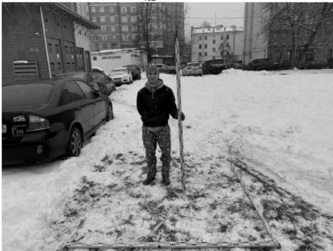
Рис. 67. Санкт-Петербург, Петроградский район, Пионерская ул., Гдовская ул., Новолadoжская ул. Месторасположение Шурфа 1. До начала работ. Вид с ЮВ.
