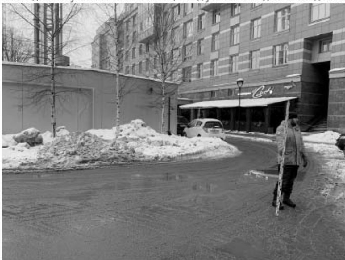
Рис. 39. Санкт-Петербург, Петроградский район, Пионерская ул., Гдовская ул., Новолadoжская ул. Точка съемки 4. Общий вид участка обследования. Вид с В.
