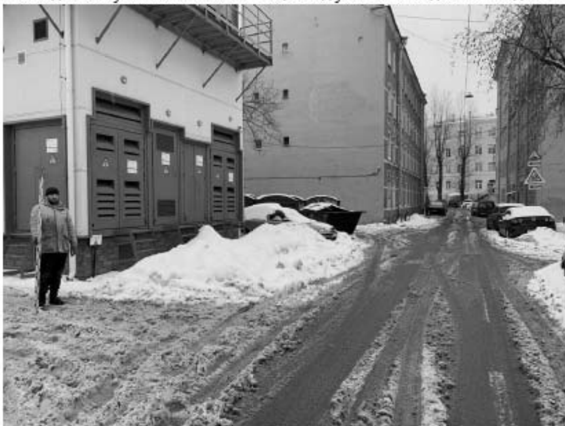
Рис. 33. Санкт-Петербург, Петроградский район, Пионерская ул., Гдовская ул., Новолодожская ул. Точка съемки 2. Общий вид участка обследования. Вид с С.
