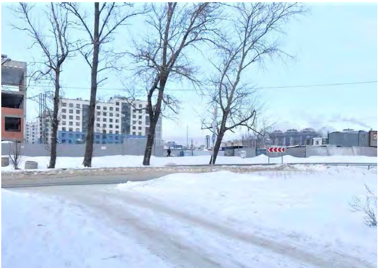
7. Земельный участок проектирования линейного объекта, по адресу: г. Санкт-Петербург, Малая Митрофаньевская ул. от Парфеновской ул. в направлении Измайловского бульвара. Вид с юга. Дата съемки: 10.01.2022г.
