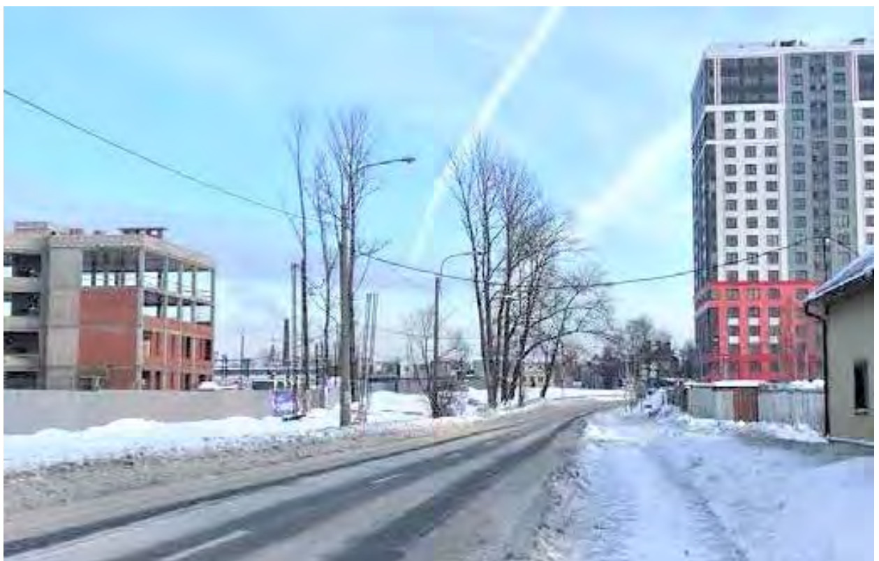
21. Земельный участок проектирования линейного объекта, по адресу: г. Санкт-Петербург, Малая Митрофаньевская ул. от Парфеновской ул. в направлении Измайловского бульвара. Вид с запада. Дата съемки: 10.01.2022г.
