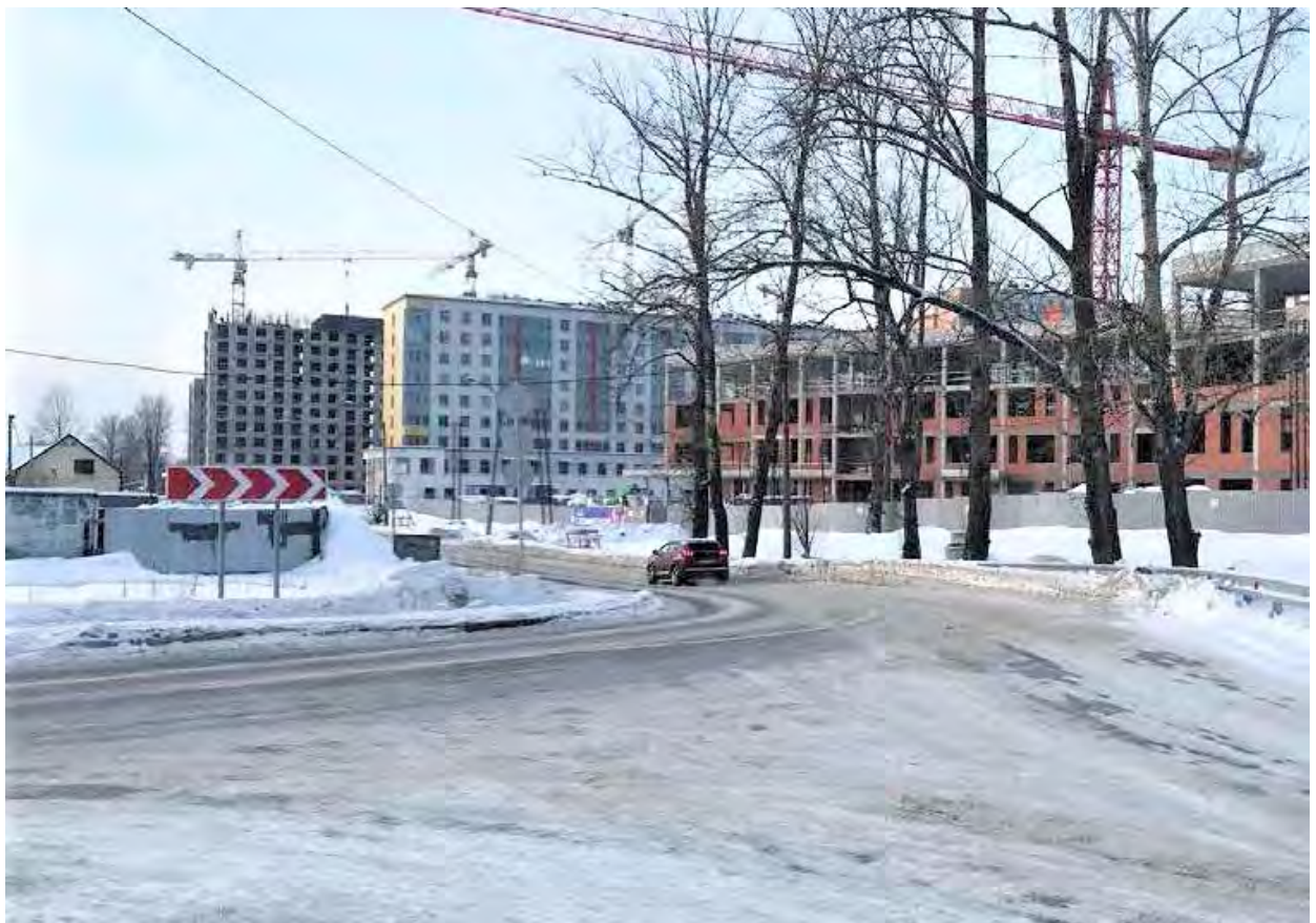
4. Земельный участок проектирования линейного объекта, по адресу: г. Санкт-Петербург, Малая Митрофаньевская ул. от Парфеновской ул. в направлении Измайловского бульвара. Вид с юго-востока. Дата съемки: 10.01.2022г.
