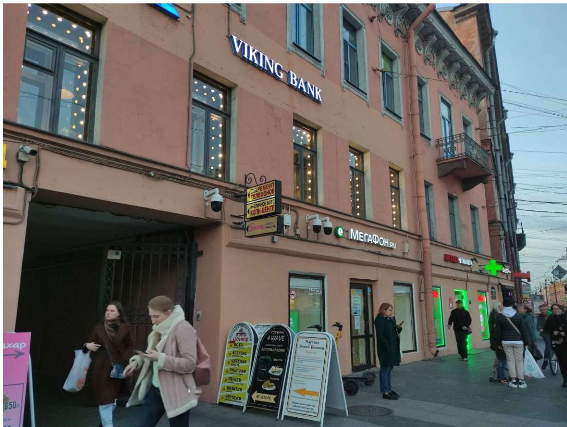
Фото 3. Фрагмент лицевого фасада объекта культурного наследия регионального значения «Дом Общества Санкт-Петербургского частного ломбарда»
