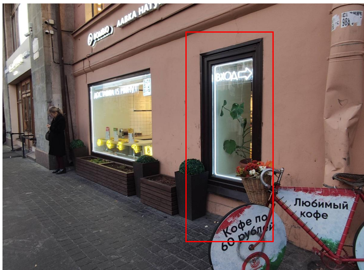
Фото 4. Фрагмент лицевого фасада объекта культурного наследия регионального значения «Дом Общества Санкт-Петербургского частного ломбарда»
