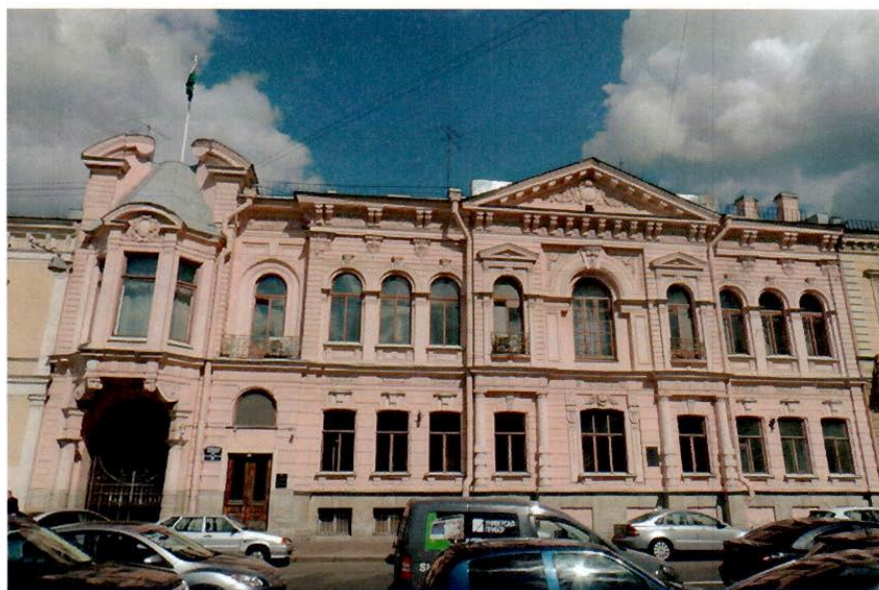
Фото 1. Лицевой фасад по Большой Морской улице.
