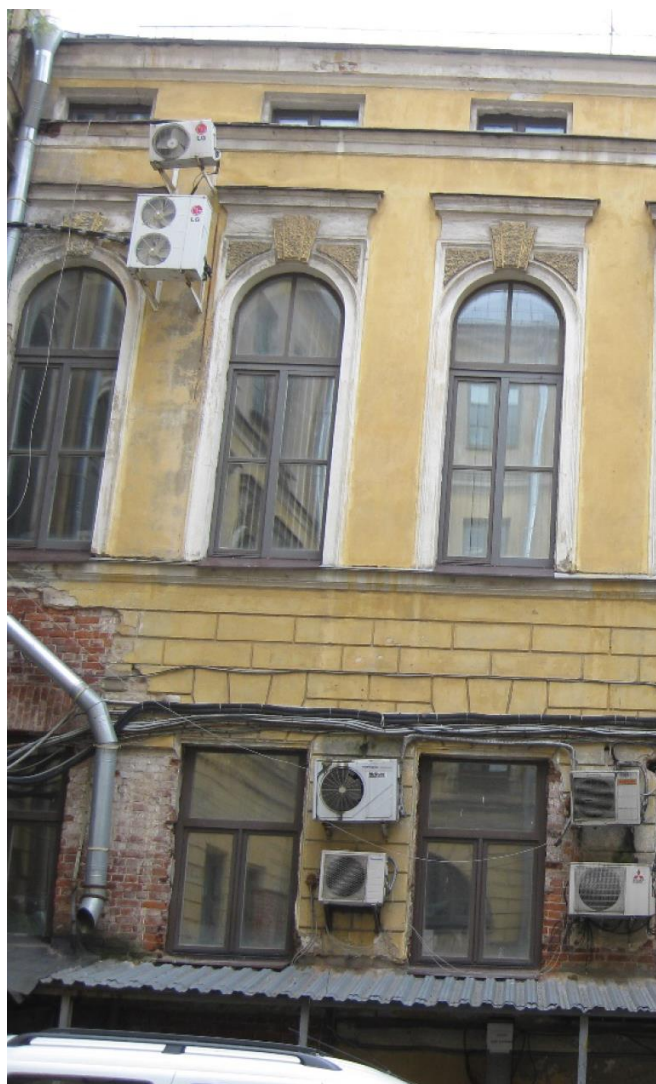
9. Объект культурного наследия регионального значения «Особняк Т.П. Митусова (Э.Ф. Юнкера)» по адресу: г. Санкт-Петербург, Большая Морская ул., д. 59, лит. А. Южный дворовый фасад. Фрагмент.
