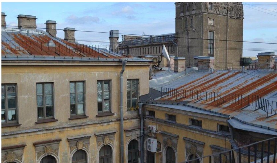
14. Объект культурного наследия регионального значения «Особняк Т.П. Митусова (Э.Ф. Юнкера)» по адресу: г. Санкт-Петербург, Большая Морская ул., д. 59, лит. А. Крыша здания. Общий вид.
