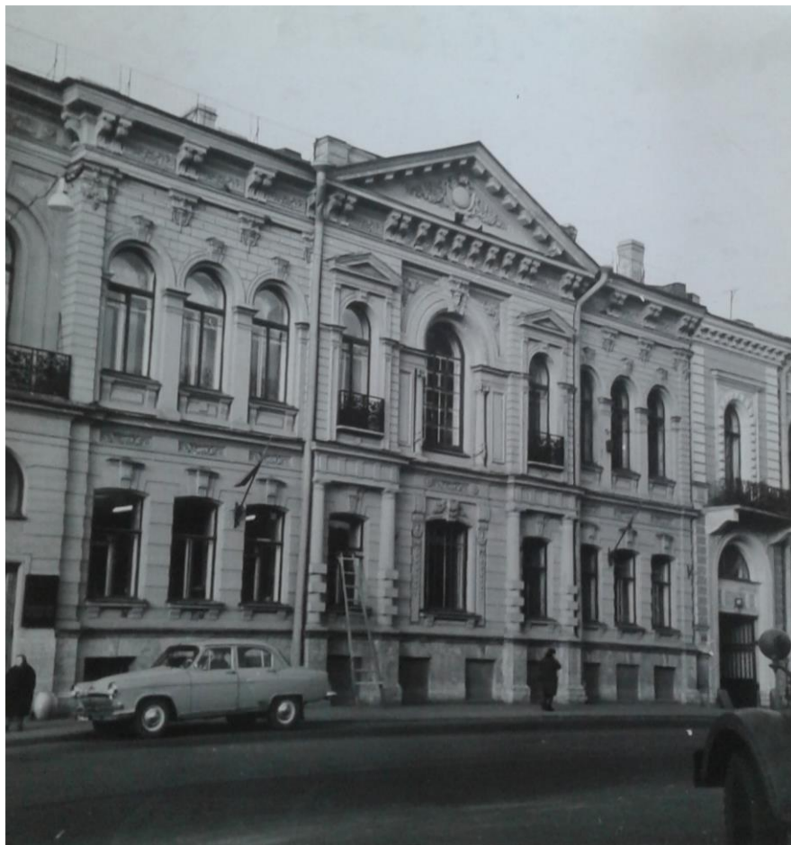
42. Особняк Г.П. Митусова (Э.Ф. Юнкера) на Большой Морской улице. Главный (лицевой) фасад. Фотография. 1969 г. Автор съемки К.А. Зайцев. Архив КГИОП.
