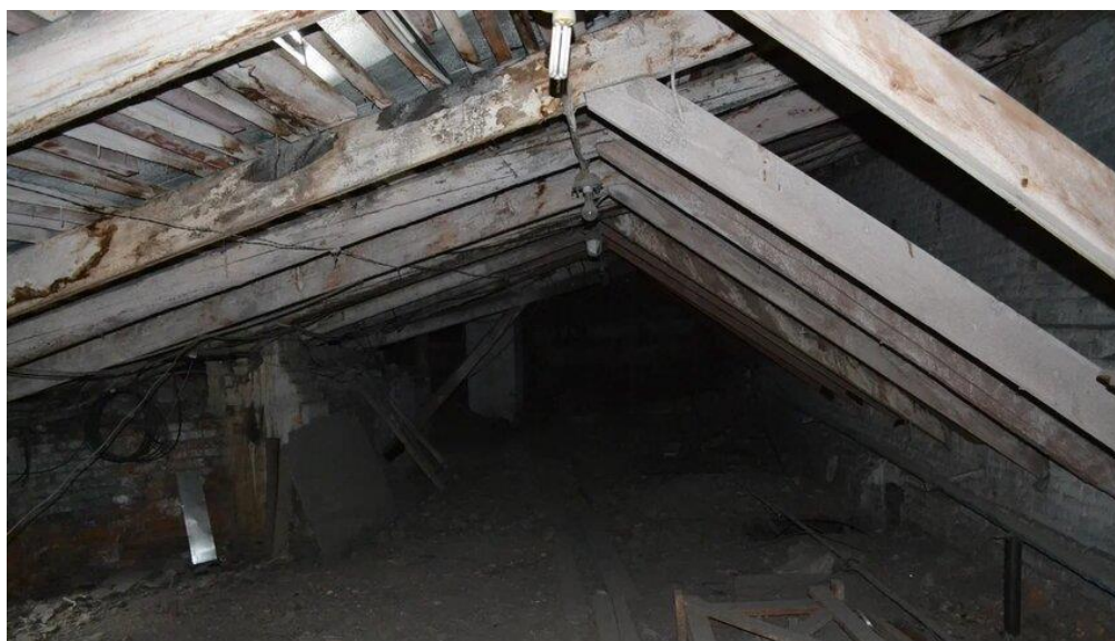
17. Объект культурного наследия регионального значения «Особняк Т.П. Митусова (Э.Ф. Юнкера)» по адресу: г. Санкт-Петербург, Большая Морская ул., д. 59, лит. А. Чердак. Фрагмент интерьера.
