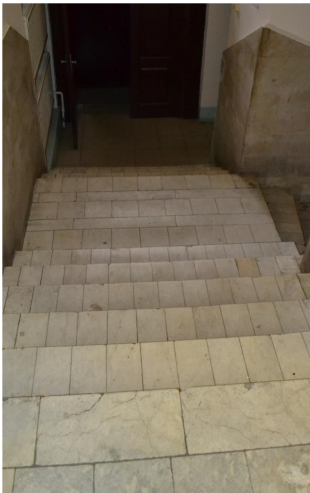
103. Объект культурного наследия регионального значения «Обошняк Т.П. Митусова (Э.Ф. Юнкера)» по адресу: г. Санкт-Петербург, Большая Морская ул., д. 59, лит. А. Вид на лестницу Л-4.
