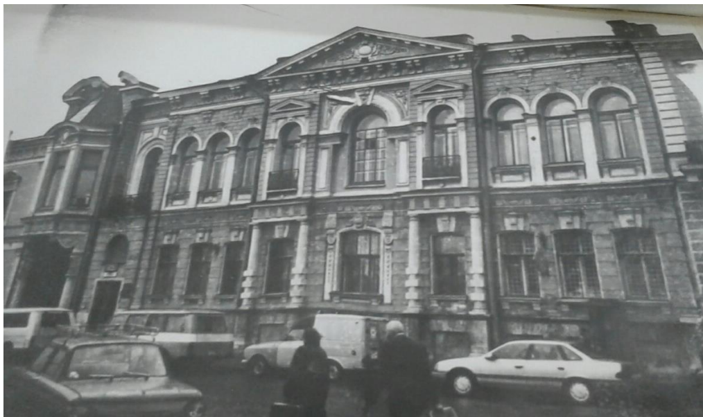
44. Особняк Г.П. Митусова (Э.Ф. Юнкера) на Большой Морской улице. Главный (лицевой) фасад. Фотография. 1994 г. Архив КГИОП.
