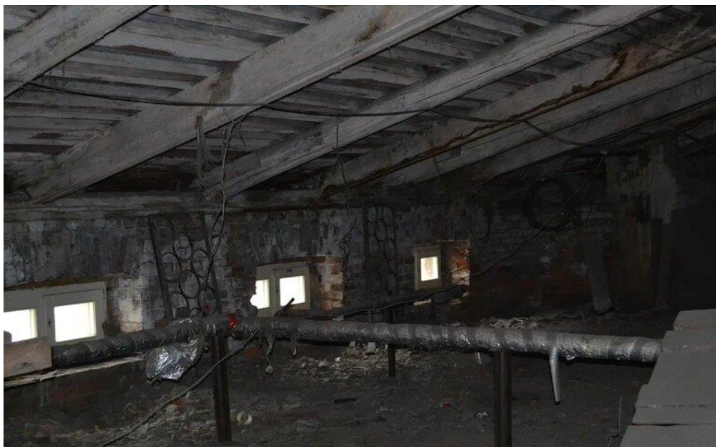
18. Объект культурного наследия регионального значения «Особняк Т.П. Митусова (Э.Ф. Юнкера)» по адресу: г. Санкт-Петербург, Большая Морская ул., д. 59, лит. А. Чердак. Фрагмент интерьера.
