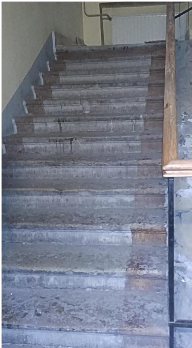
106. Объект культурного наследия регионального значения «Особняк Т.П. Митусова (Э.Ф. Юнкера)» по адресу: г. Санкт-Петербург, Большая Морская ул., д. 59, лит. А. Лестница Л-6. Фрагмент.
