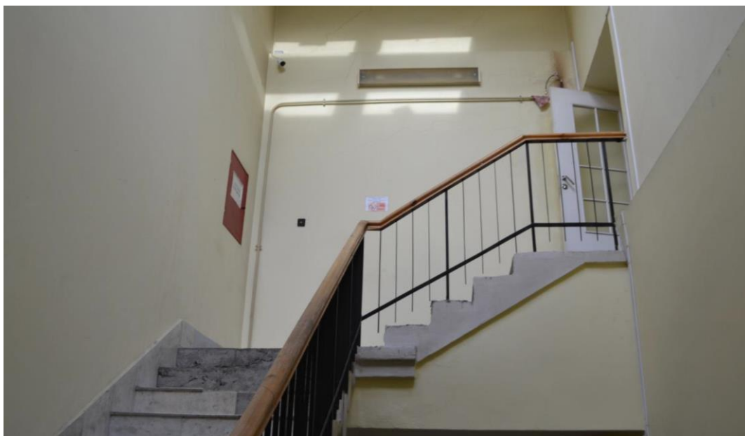
110. Объект культурного наследия регионального значения «Особняк Т.П. Митусова (Э.Ф. Юнкера)» по адресу: г. Санкт-Петербург, Большая Морская ул., д. 59, лит. А. Лестница Л-7. Фрагмент.
