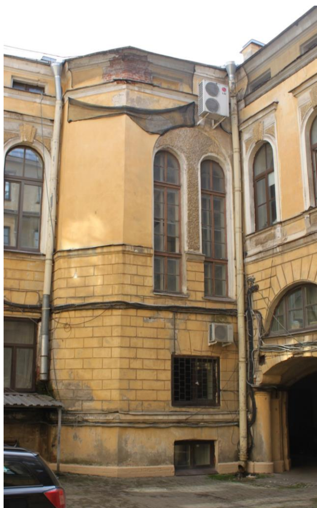
8. Объект культурного наследия регионального значения «Особняк Т.П. Митусова (Э.Ф. Юнкера)» по адресу: г. Санкт-Петербург, Большая Морская ул., д. 59, лит. А. Дворовые фасады. Вид на боковой ризалит и проездную арку.
