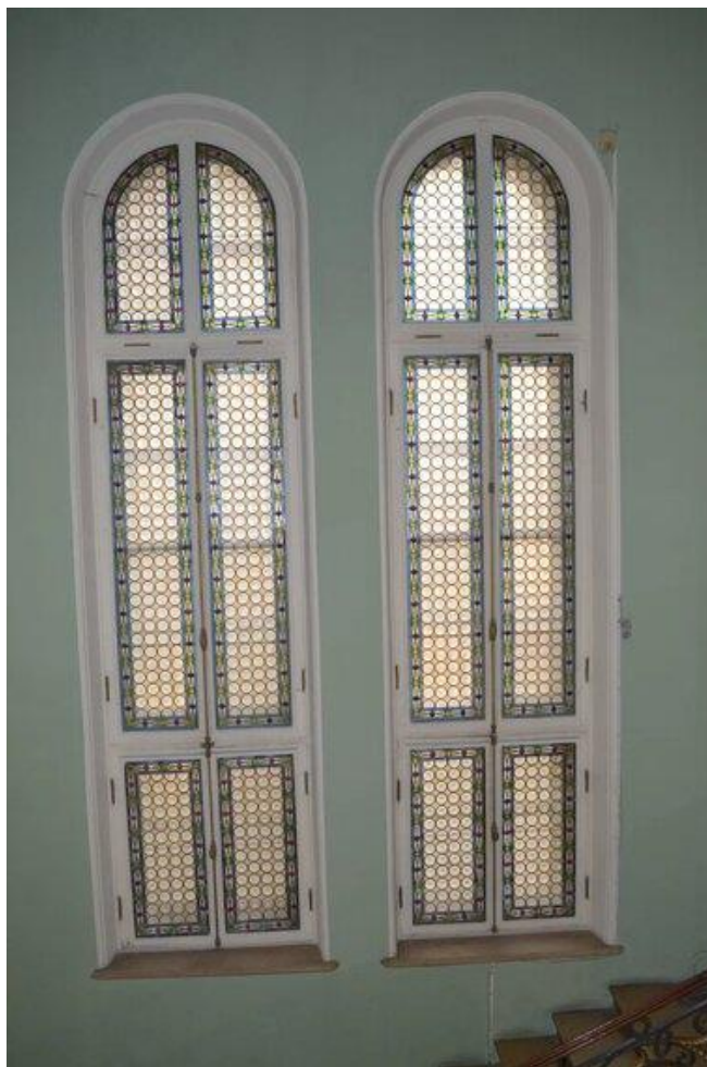
26. Объект культурного наследия регионального значения «Особняк Т.П. Митусова (Э.Ф. Юнкера)» по адресу: г. Санкт-Петербург, Большая Морская ул., д. 59, лит. А. Парадная лестница. Оконные заполнения (окна-витражи с полуциркульным завершением).
