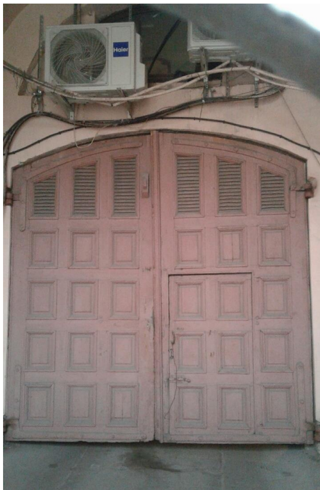
5. Объект культурного наследия регионального значения «Особняк Т.П. Митусова (Э.Ф. Юнкера)» по адресу: г. Санкт-Петербург, Большая Морская ул., д. 59, лит. А. Воротное заполнение проездной арки (дерево).
