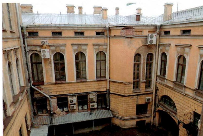
2. Южный фасад внутреннего двора.
