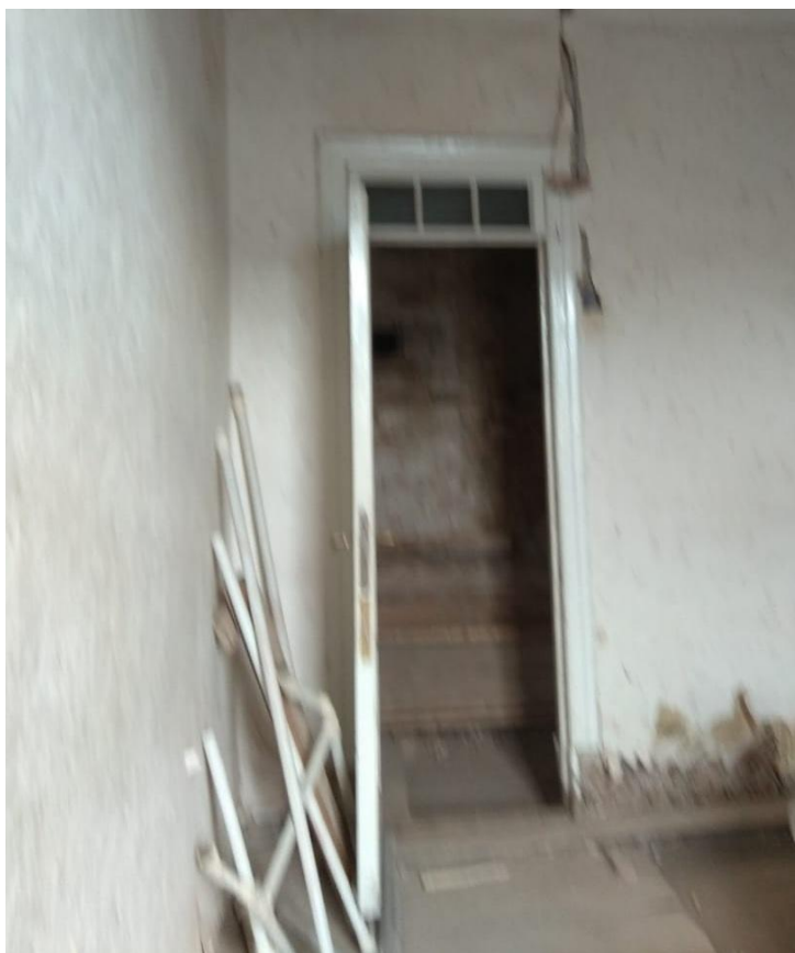
Фото 9. Помещение 4 (комната). Общий вид от окна.
