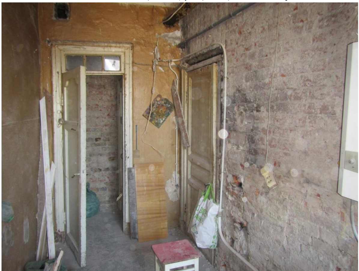
Фото 2. Помещение 9 (кухня). Общий вид от окна.
