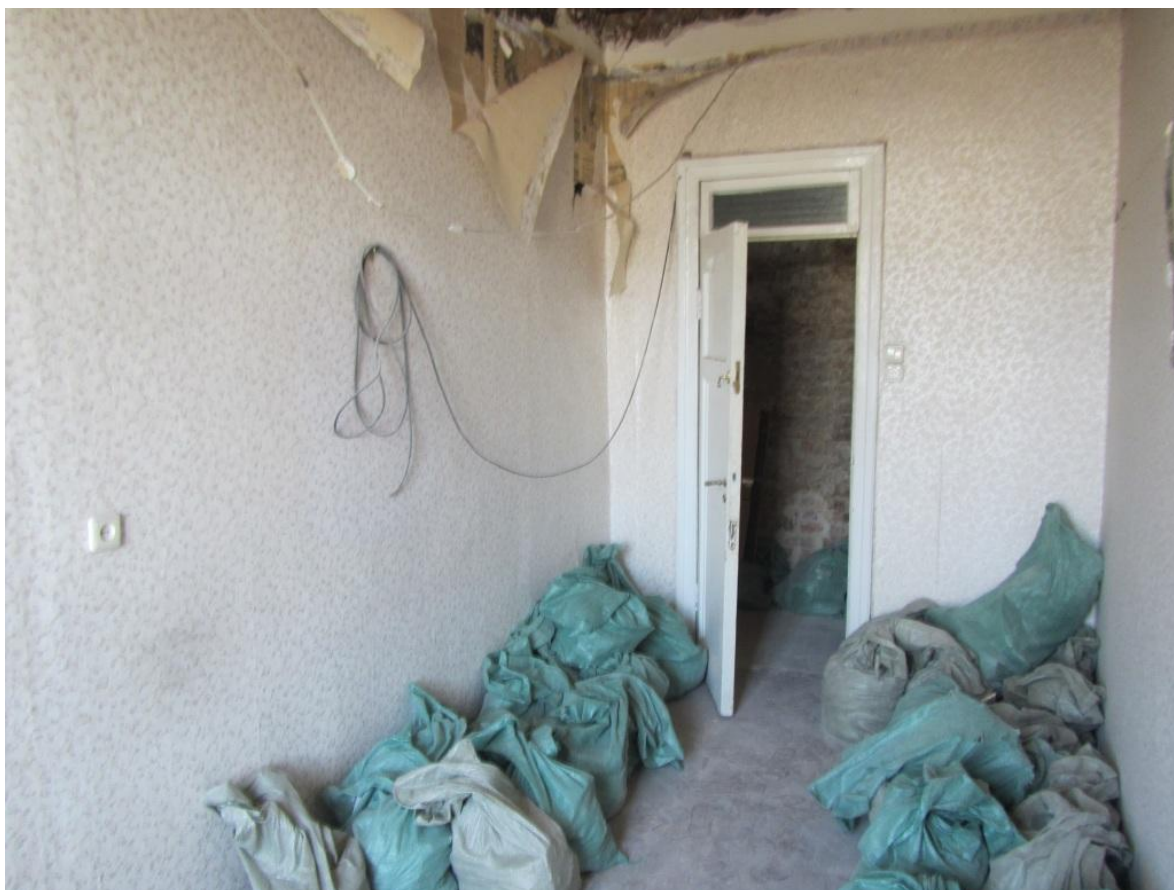
Фото 5. Помещение 6 (комната). Общий вид от окна.
