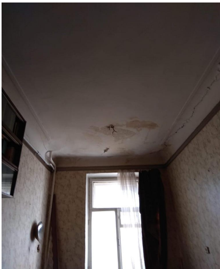
Фото 11. Помещение 2 (комната). Общий вид от двери.
