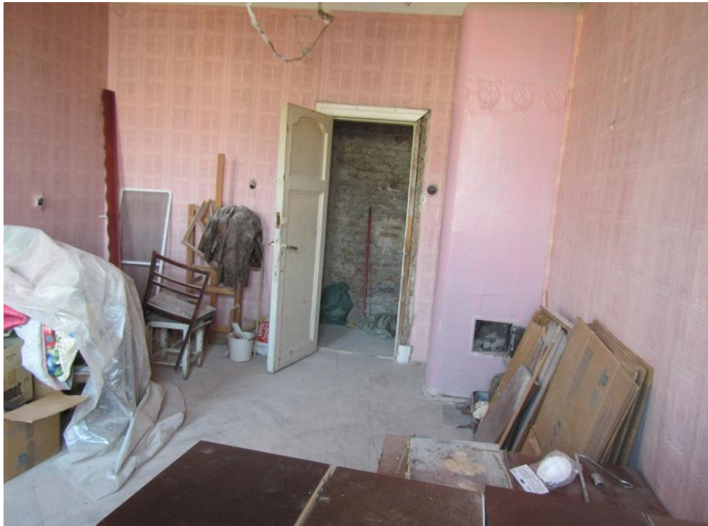
Фото 7. Помещение 5 (комната). Общий вид от окна.
