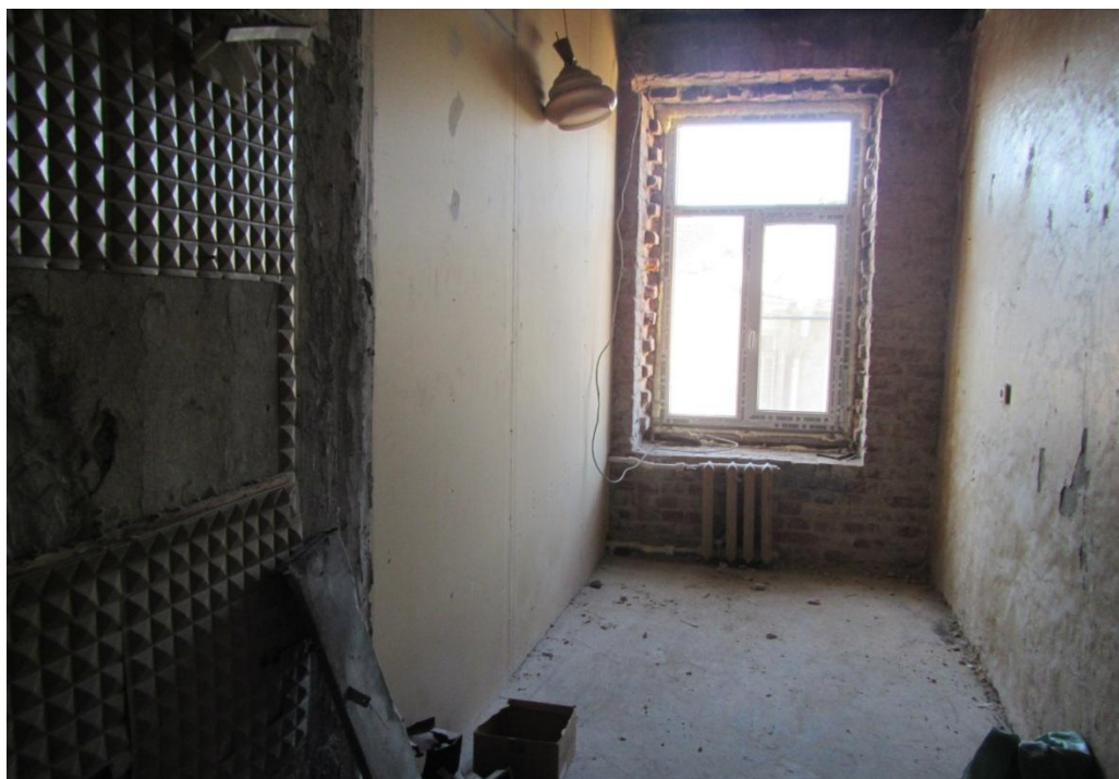
Фото 3. Помещение 7 (кладовая). Общий вид от двери.
