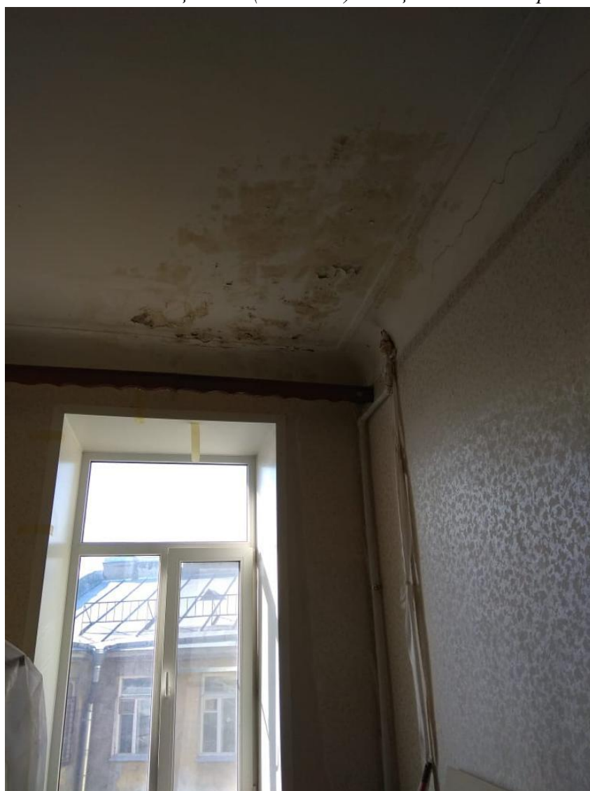
Фото 4. Помещение 6 (комната). Общий вид от двери.
