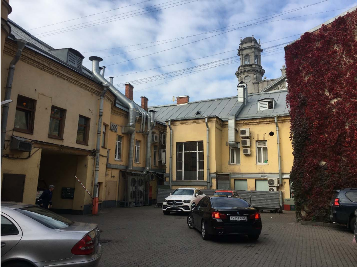
Фото №18. Юго-восточный и северо-восточный дворовые фасады.
