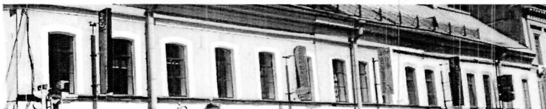
Оконные проемы со стороны Развезжей улице. Съёмка 20.06.2012. Т.И. Соколова.
