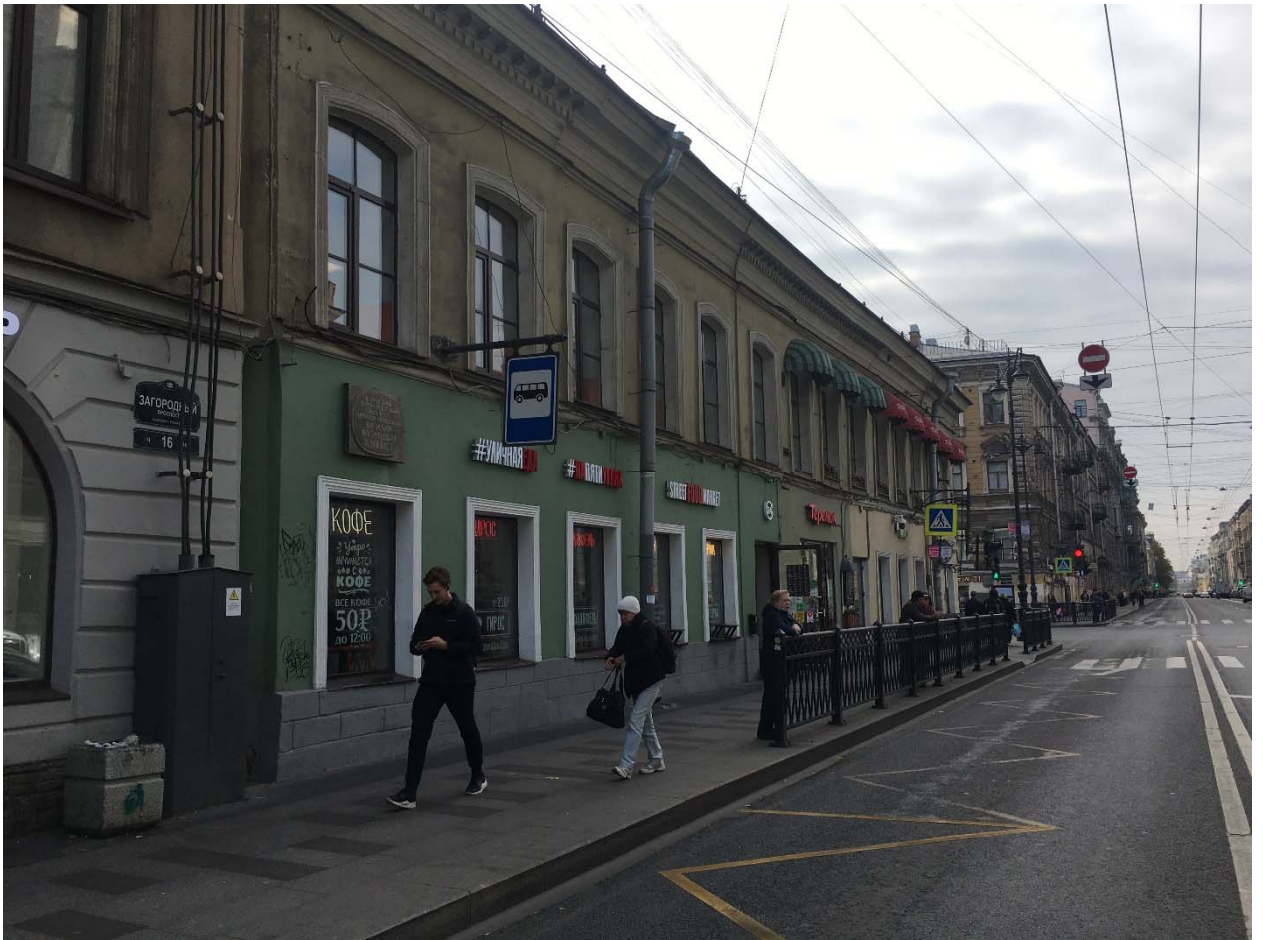
Фото №10. Северо-западный фасад по Разъезжей улице.
