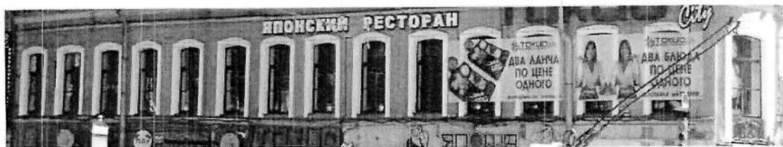
Оконные проемы со стороны Загородного проспекта. Съёмка 20.06.2012. Т.И. Соколова.
