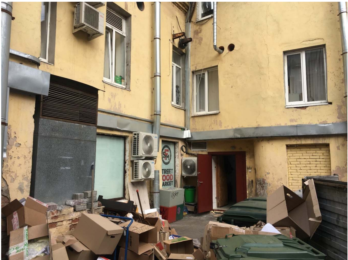
Фото №16. Юго-восточный и юго-западный дворовые фасады, инженерное оборудование.
