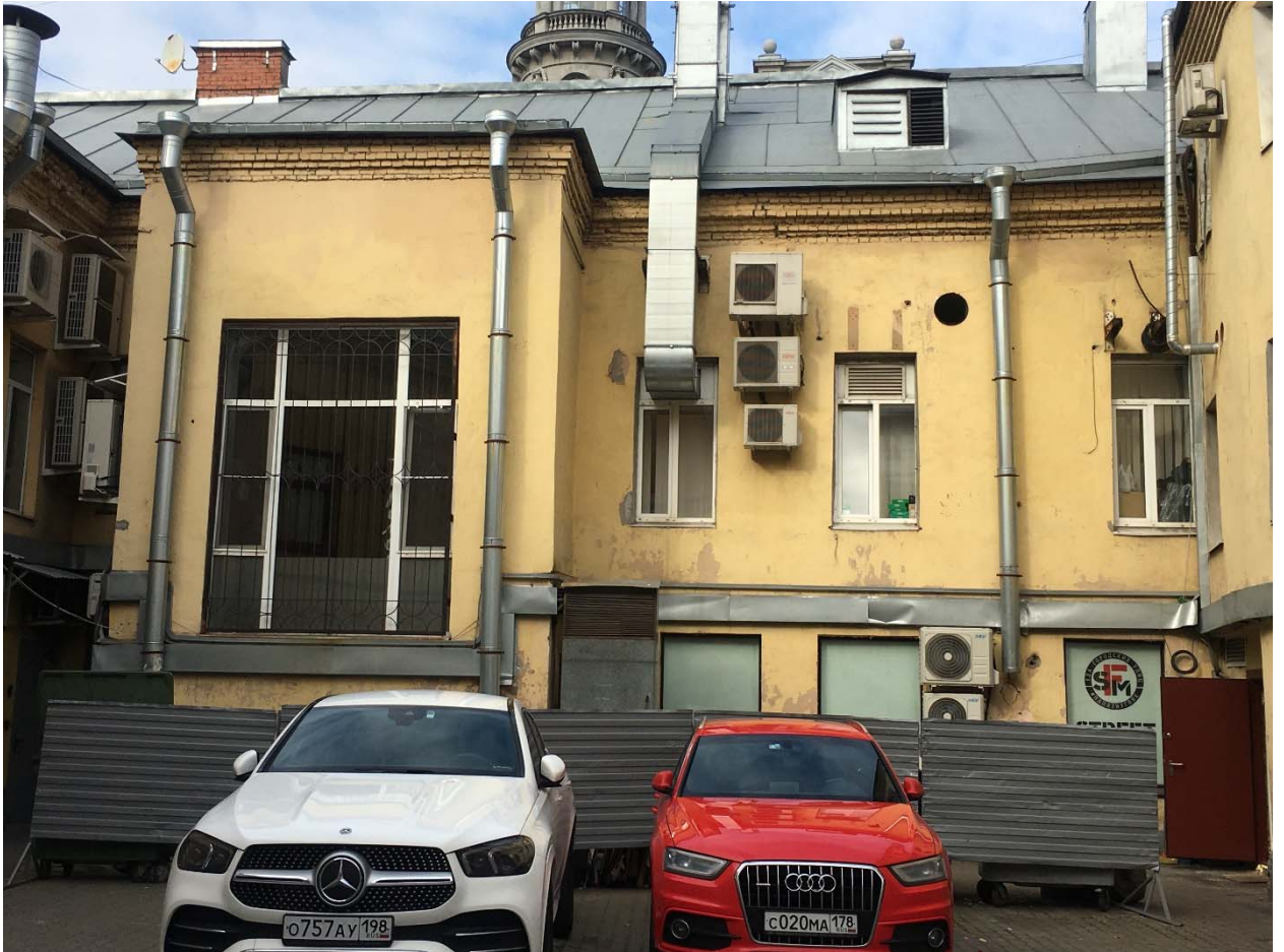
Фото №13. Юго-восточный дворовый фасад.
