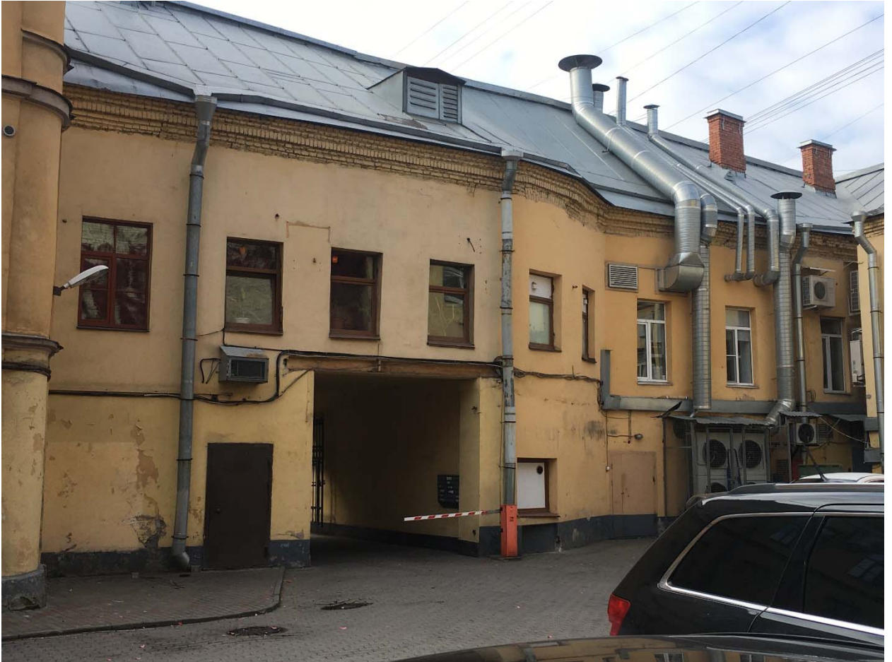
Фото №12. Северо-восточный дворовый фасад.
