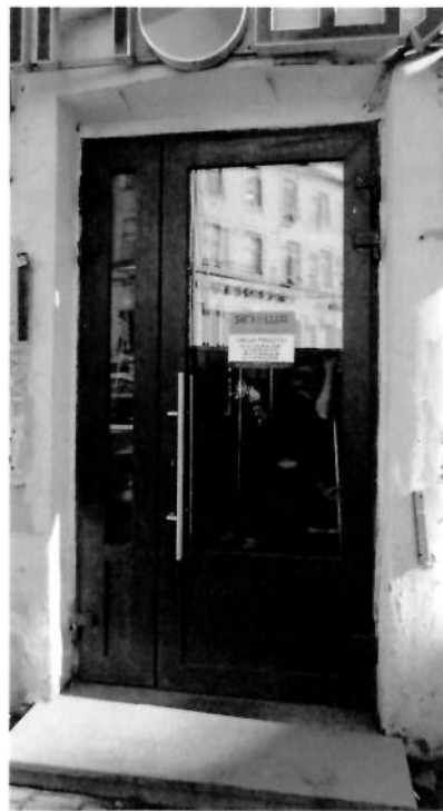
Исторический дверной проем в помещении 12-Н. Съёмка 21.03.2012. Л.С. Гуменюк.
