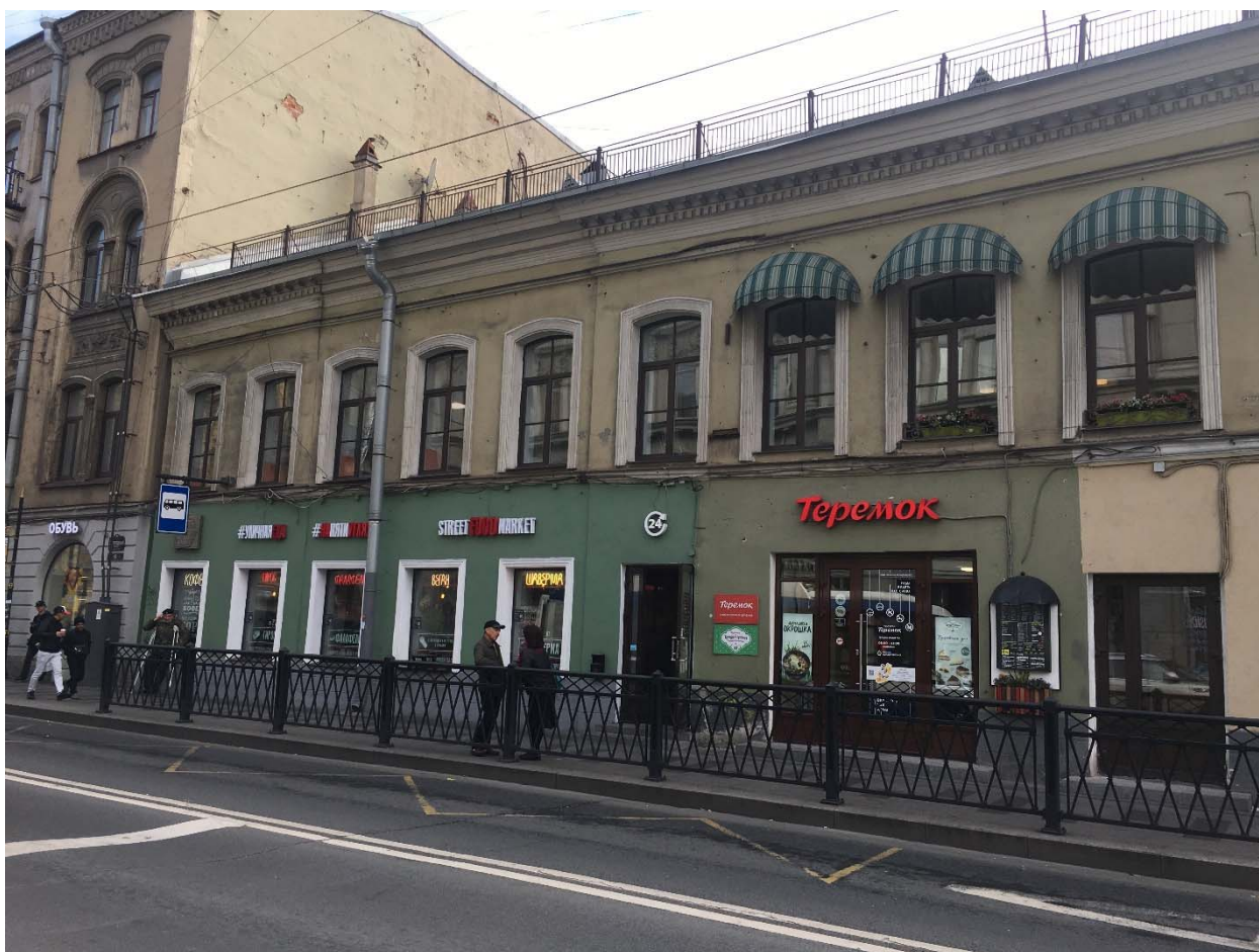
Фото №7. Северо-западный фасад по Разъезжей улице.
