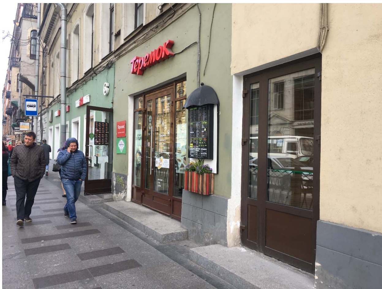
Фото №8. Северо-западный фасад по Разъезжей улице.
