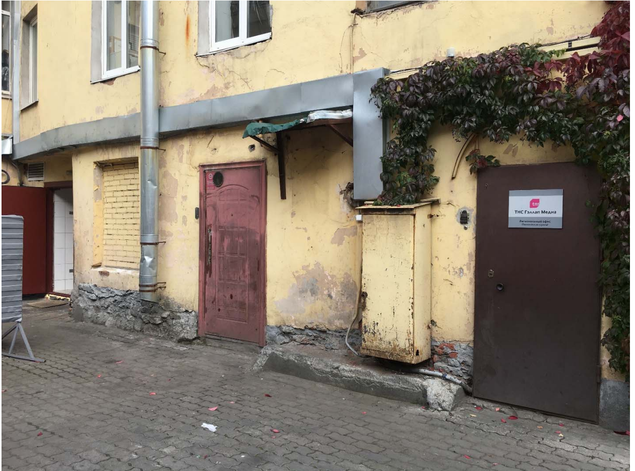
Фото №17. Юго-западный дворовый фасад.
