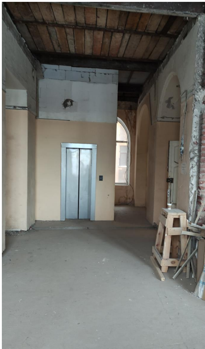
12. Объект культурного наследия регионального значения «Особняк и доходный дом И.Е. Ритинга» по адресу: г. Санкт-Петербург, пр. Добролюбова, д. 1/79, лит. Б. Третий этаж. Помещение 9-Н. Общий вид в зоне восстановления исторической лестничной клетки.
