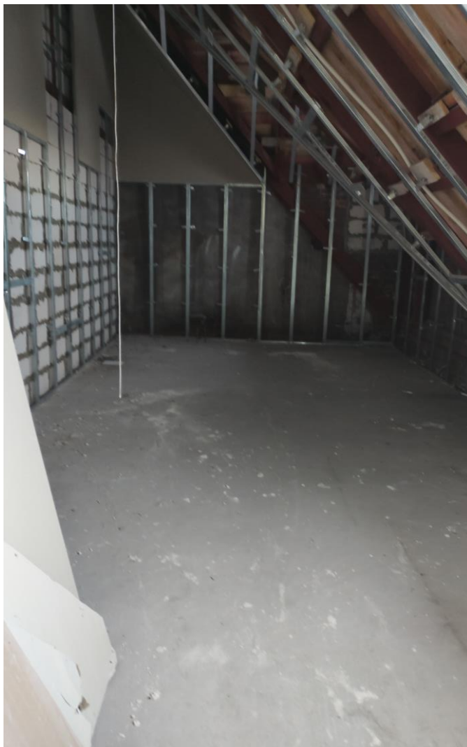
18. Объект культурного наследия регионального значения «Особняк и доходный дом И.Е. Ритинга» по адресу: г. Санкт-Петербург, пр. Добролюбова, д. 1/79, лит. Б. Пятый этаж (мансарда). Квартира №58. Фрагмент интерьера (в зоне восстановления утраченной лестничной клетки в исторических границах).
