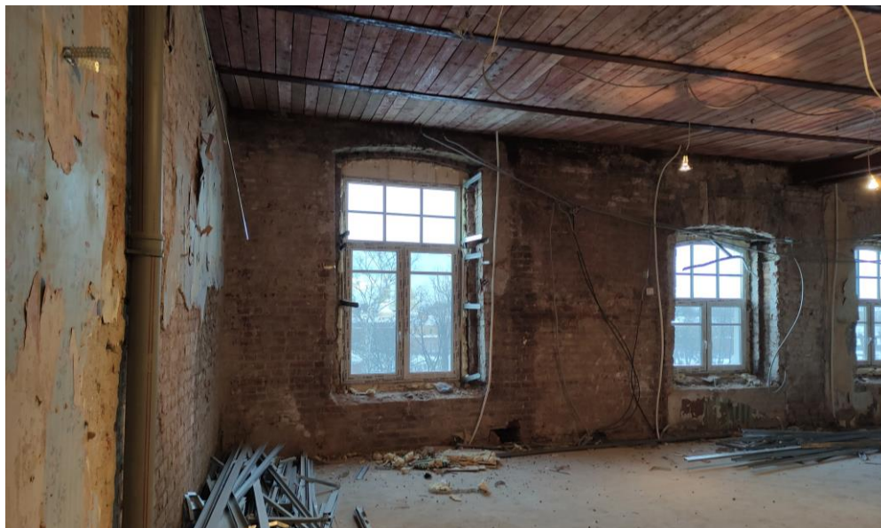
14. Объект культурного наследия регионального значения «Особняк и доходный дом И.Е. Ритинга» по адресу: г. Санкт-Петербург, пр. Добролюбова, д. 1/79, лит. Б. Четвертый этаж. Квартира №53. Фрагмент интерьера (в зоне восстановления утраченной лестничной клетки).
