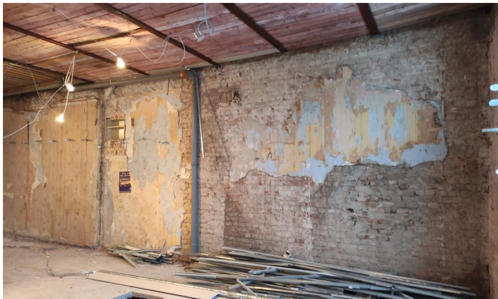
16. Объект культурного наследия регионального значения «Особняк и доходный дом И.Е. Ритинга» по адресу: г. Санкт-Петербург, пр. Добролюбова, д. 1/79, лит. Б. Четвертый этаж. Квартира №53. Фрагмент интерьера (в зоне восстановления утраченной лестничной клетки).
