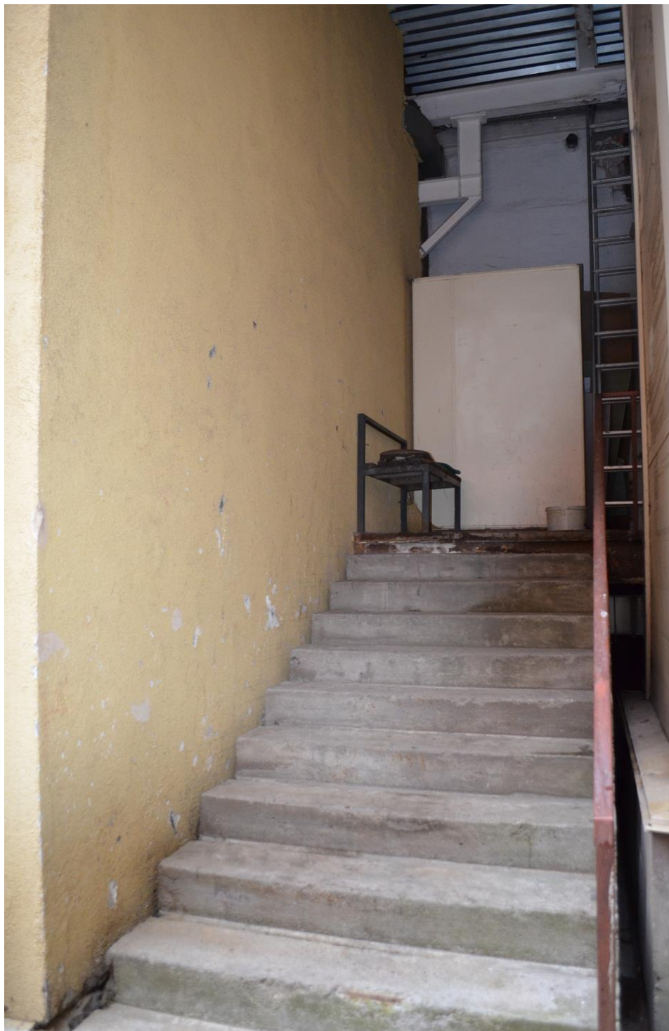
Фото 18. ОКН регионального значения «Городской училищный дом в память 19 февраля 1861 года» (22-я линия В.О., дом 7, литера А). Северо-западный дворовый фасад. Фрагмент. Съёмка 10.02.2022 г.
