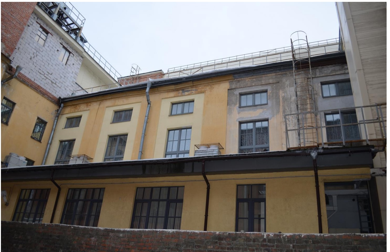
Фото 13. ОКН регионального значения «Городской училищный дом в память 19 февраля 1861 года» (22-я линия В.О., дом 7, литера А). Северо-западный дворовый фасад. Фрагмент. Съёмка 10.02.2022 г.
