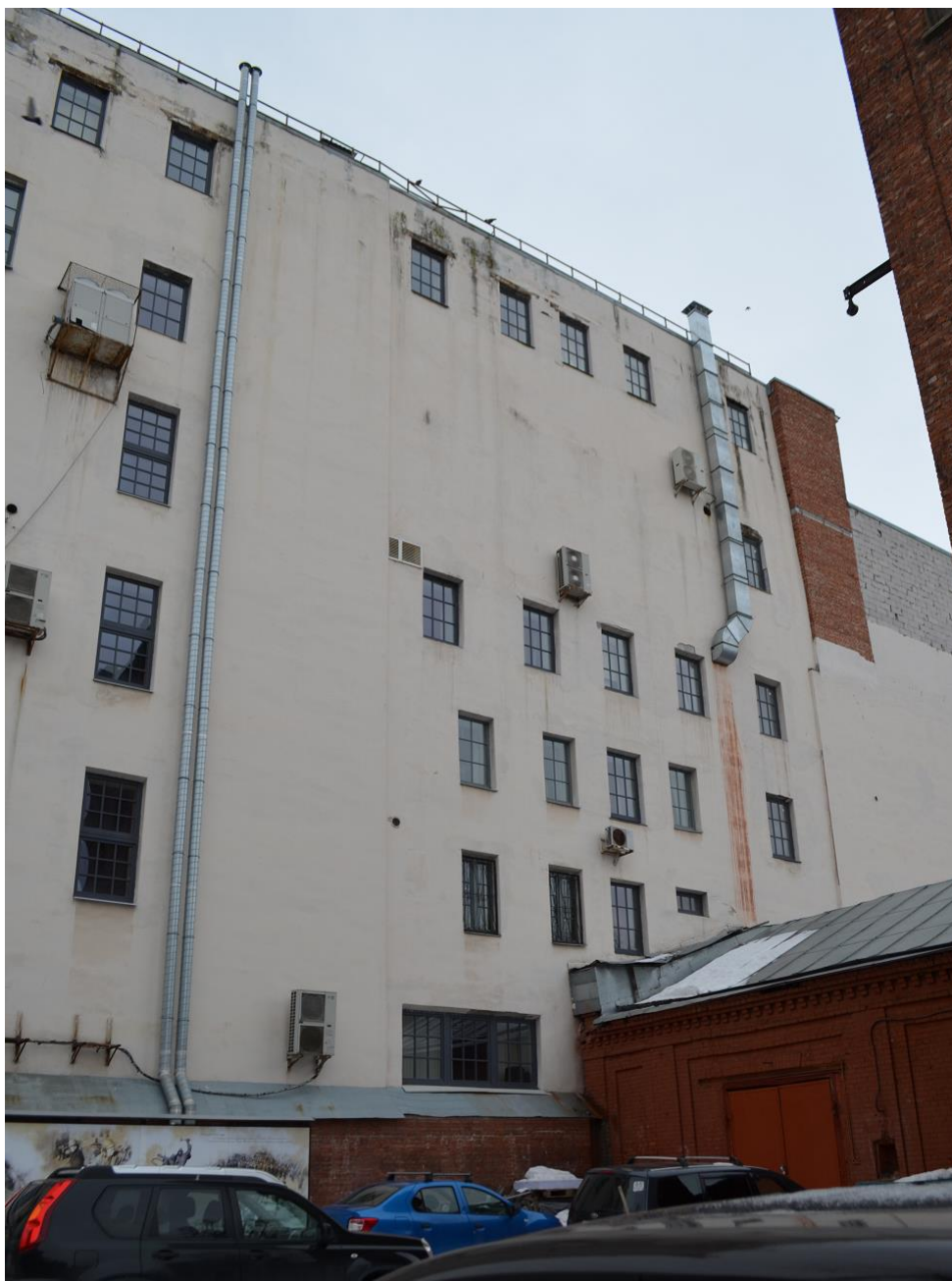
Фото 04. ОКН регионального значения «Городской училищный дом в память 19 февраля 1861 года» (22-я линия В.О., дом 7, литера А). Северо-восточный дворовый фасад. Фрагмент. Съёмка 10.02.2022 г.
