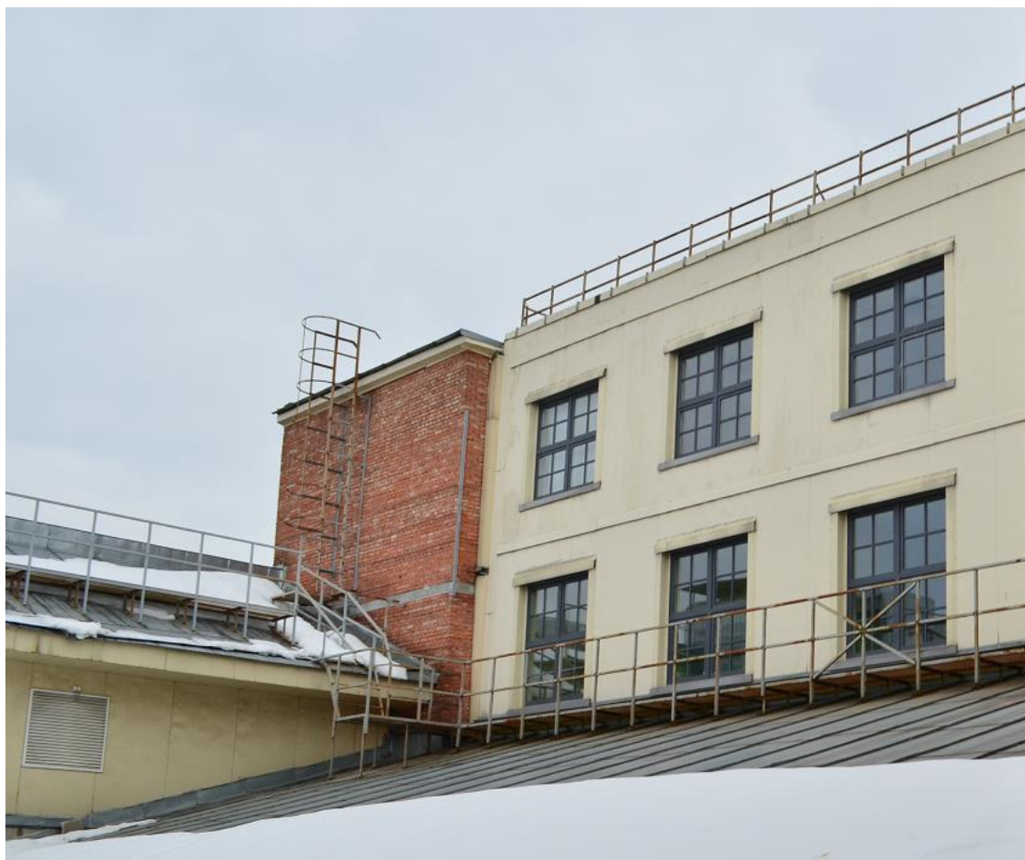
Фото 15. ОКН регионального значения «Городской училищный дом в память 19 февраля 1861 года» (22-я линия В.О., дом 7, литера А). Северо-западный дворовый фасад. Фрагмент. Съёмка 10.02.2022 г.
