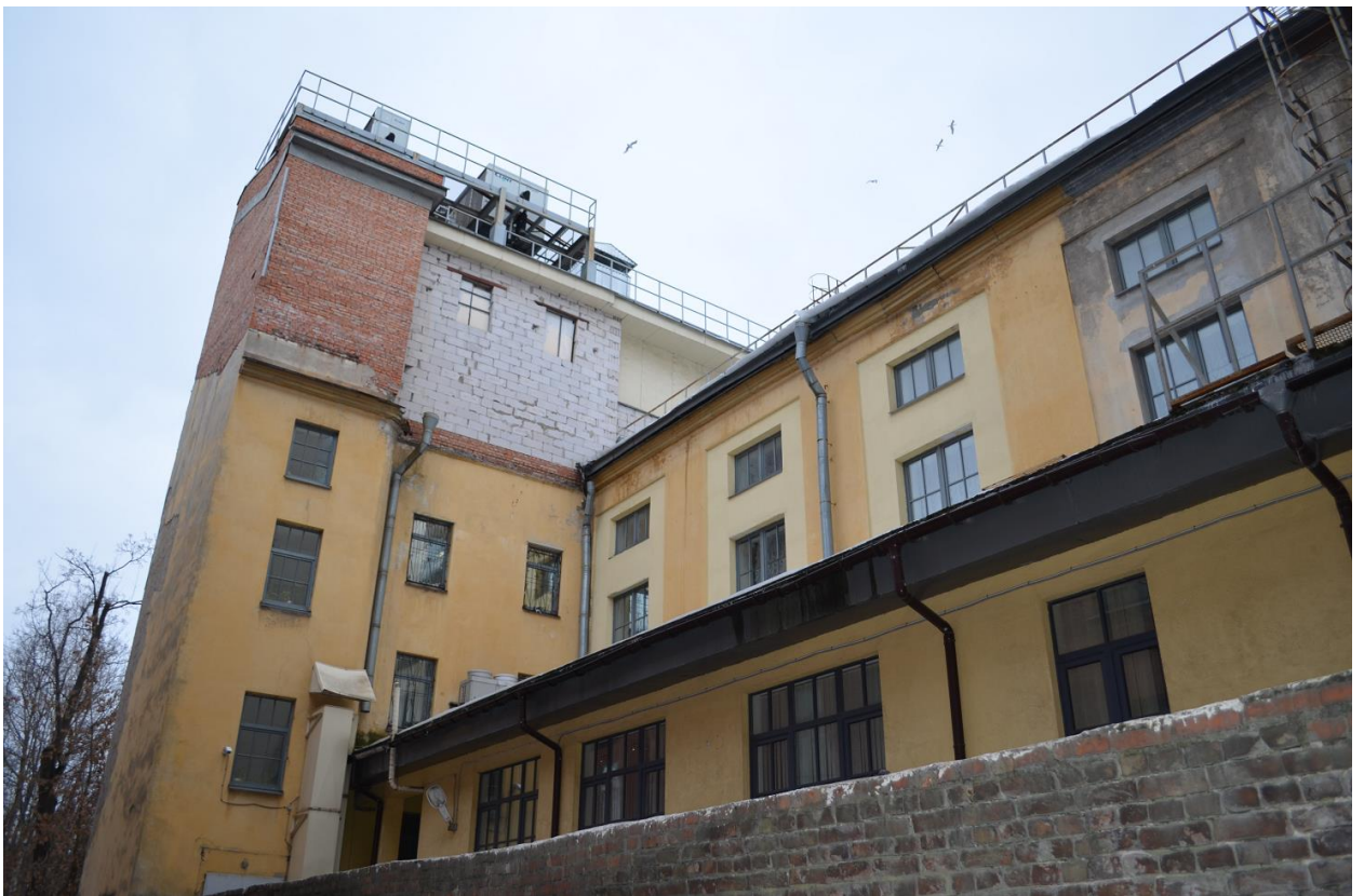
Фото 12. ОКН регионального значения «Городской училищный дом в память 19 февраля 1861 года» (22-я линия В.О., дом 7, литера А). Северо-западный дворовый фасад. Фрагмент. Съёмка 10.02.2022 г.
