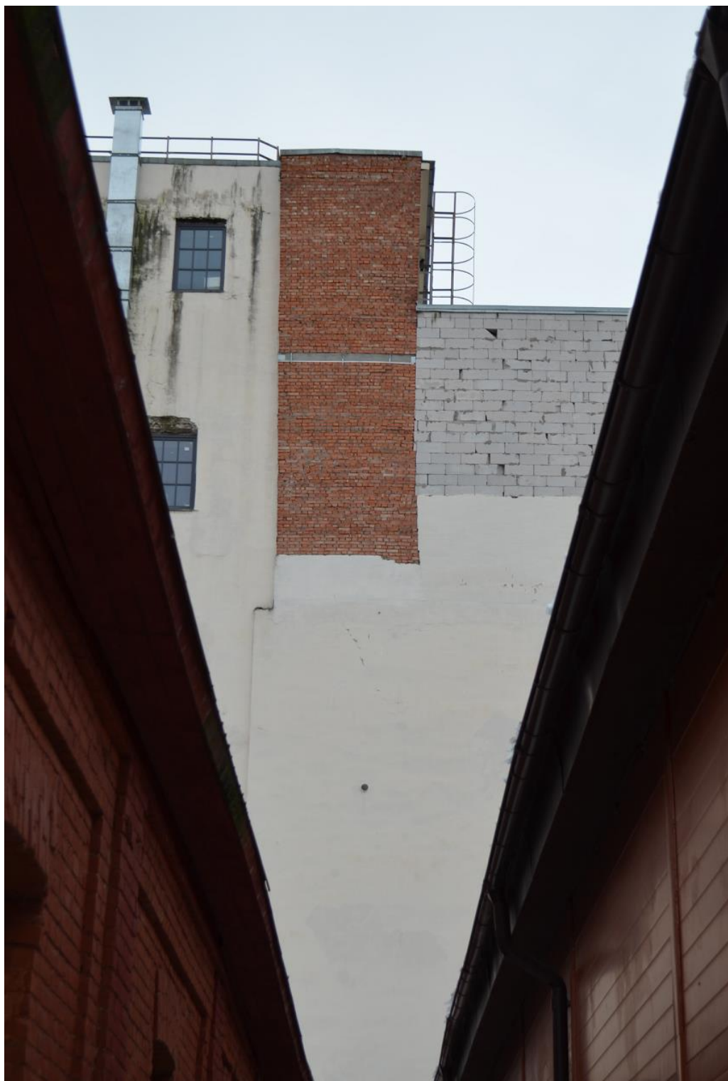
Фото 08. ОКН регионального значения «Городской училищный дом в память 19 февраля 1861 года» (22-я линия В.О., дом 7, литера А). Северо-восточный дворовый фасад. Фрагмент. Съёмка 10.02.2022 г.
