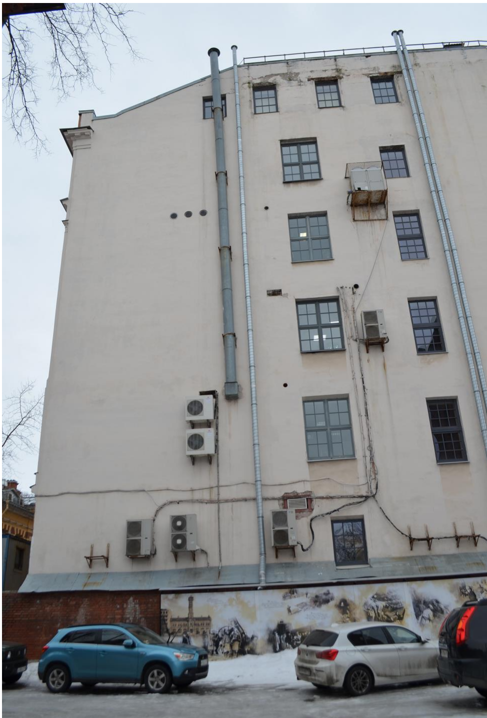
Фото 01. ОКН регионального значения «Городской училищный дом в память 19 февраля 1861 года» (22-я линия В.О., дом 7, литера А). Северо-восточный дворовый фасад. Фрагмент. Съёмка 10.02.2022 г.
