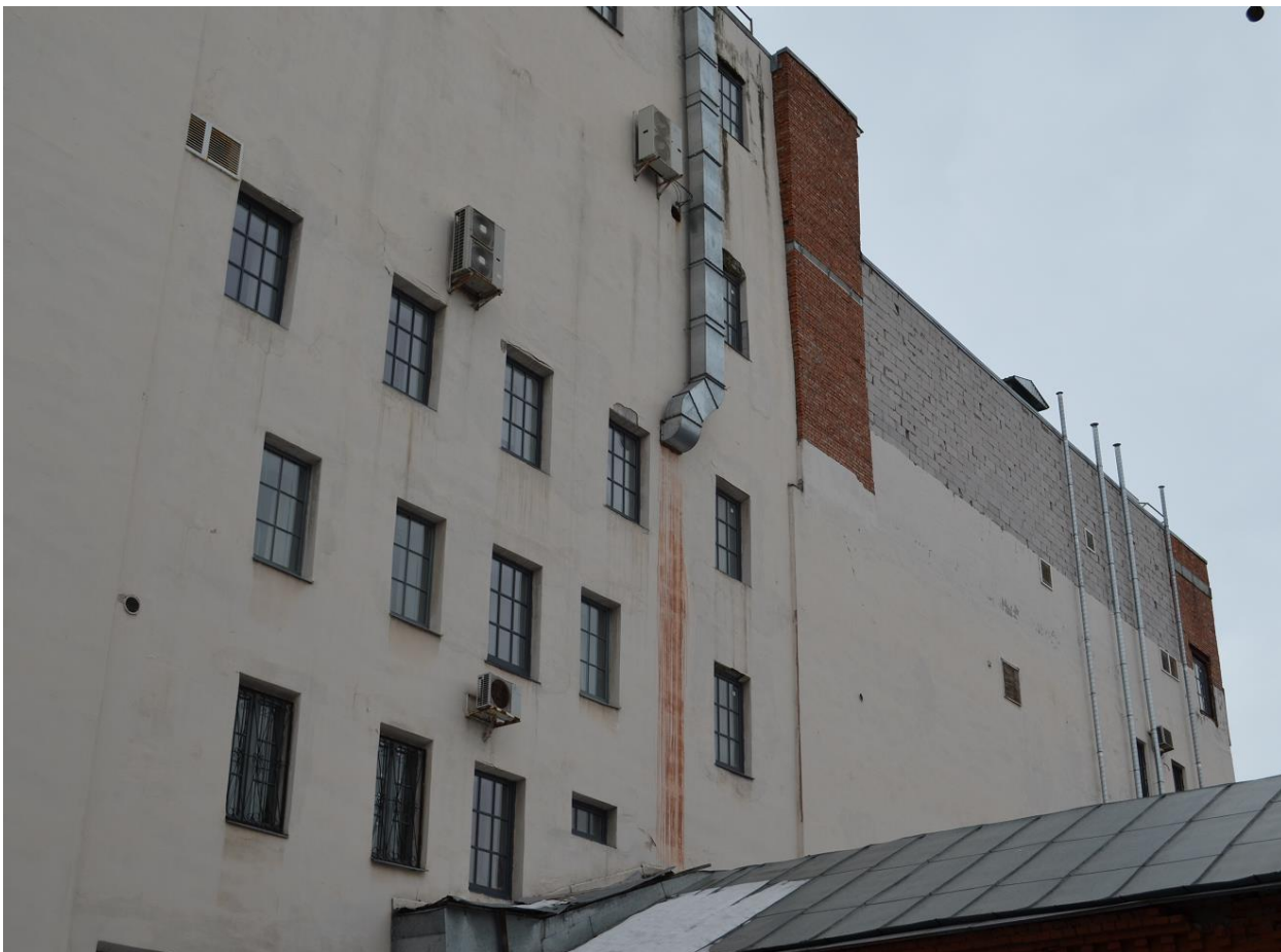
Фото 06. ОКН регионального значения «Городской училищный дом в память 19 февраля 1861 года» (22-я линия В.О., дом 7, литера А). Северо-восточный дворовый фасад. Фрагмент. Съёмка 10.02.2022 г.
