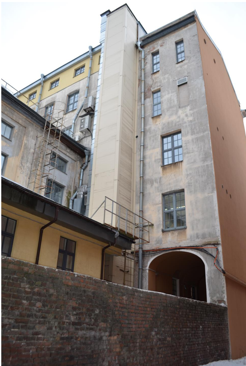
Фото 14. ОКН регионального значения «Городской училищный дом в память 19 февраля 1861 года» (22-я линия В.О., дом 7, литера А). Северо-западный дворовый фасад. Фрагмент. Съёмка 10.02.2022 г.
