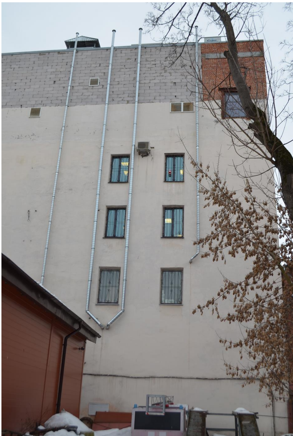
Фото 09. ОКН регионального значения «Городской училищный дом в память 19 февраля 1861 года» (22-я линия В.О., дом 7, литера А). Северо-восточный дворовый фасад. Фрагмент. Съёмка 10.02.2022 г.
