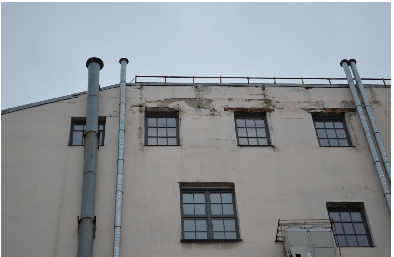
Фото 03. ОКН регионального значения «Городской училищный дом в память 19 февраля 1861 года» (22-я линия В.О., дом 7, литера А). Северо-восточный дворовый фасад. Фрагмент. Съёмка 10.02.2022 г.
