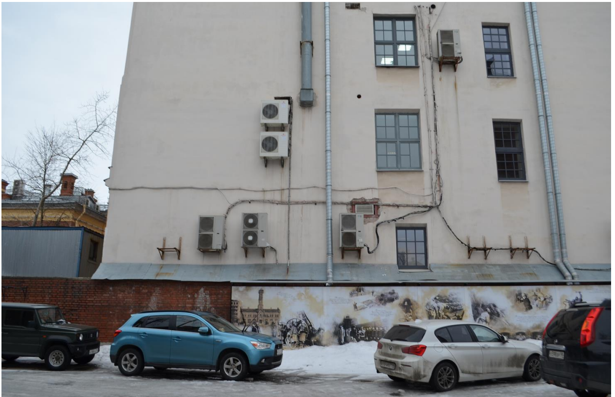
Фото 02. ОКН регионального значения «Городской училищный дом в память 19 февраля 1861 года» (22-я линия В.О., дом 7, литера А). Северо-восточный дворовый фасад. Фрагмент. Съёмка 10.02.2022 г.
