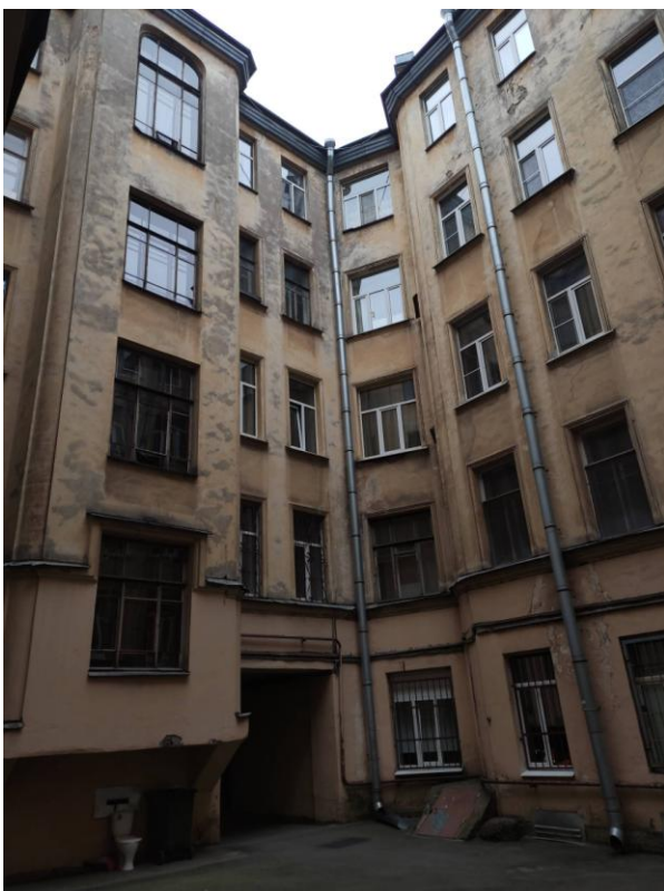
Фото 5. Фрагмент дворового фасада выявленного объекта культурного наследия «Дом А.Г.Романова»
