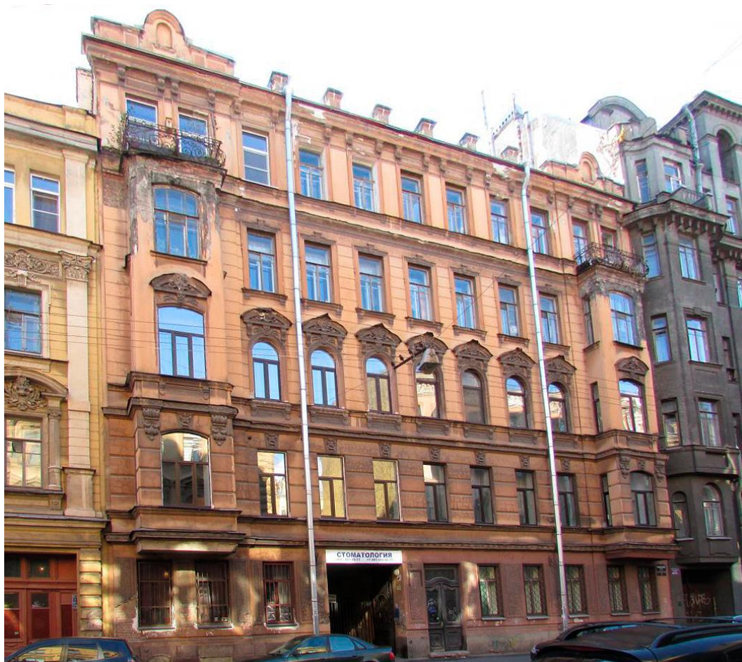
10. Лицевой фасад дома. 2013 г. — Доходный дом А. Г. Романова // Citywalls.ru — архитектурный сайт Петербурга [Электронный ресурс]. URL: https://www.citywalls.ru/house1735.html .
