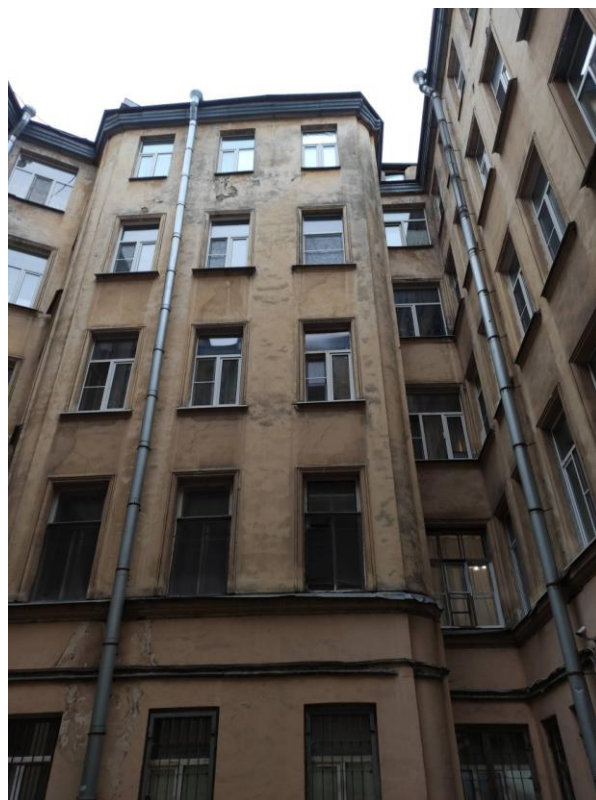
Фото 6. Фрагмент дворового фасада выявленного объекта культурного наследия «Дом А.Г.Романова»
