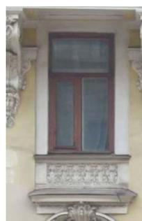
балкон – количество (один), габариты, конфигурация (прямоугольный), местоположение (в уровне 2-го этажа, по центрально оси); ограждение – конструкция (глухие опорные столбы и решетка), материал (металл), техника исполнения (ковка), рисунок (орнамент в виде завитков аканта); кронштейны – материал (оштукатурены), оформление (листья аканта, розетты, рокайли, маскароны);
