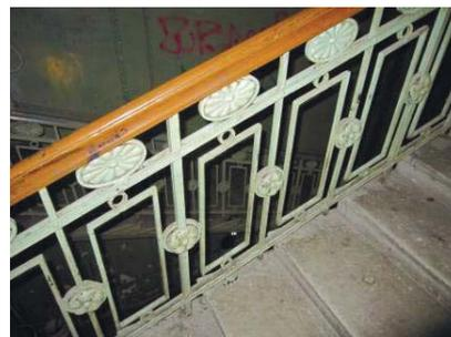
лестницы – количество (три), местоположение (лицевой и дворовый корпус), тип (двухмаршевые), вид материала ступеней (плиты из известняка), ограждение – вид материала (металл), техника исполнения (литье), рисунок (вертикальные стойки);
