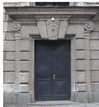
историческое заполнение дверных проемов – количество (два), конструкция (двухстворчатые, прямоугольные), оформление (профилированное обрамление с прорезкой растительного орнамента, профилированные филенки, в том числе алмазная грань), вид материала (дерево), покрытие (окраска);
