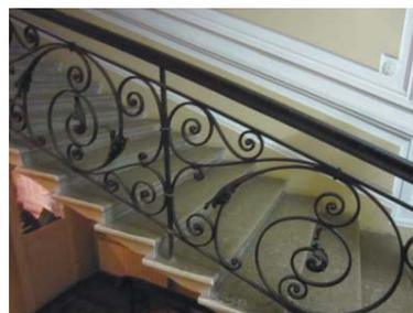
лестница – местоположение (дворовый северный корпус), тип (двухмаршевая), конструкция (по металлическим косоурам), вид материала ступеней (плиты из известняка), ограждение – вид материала (металл), техника исполнения (литье), рисунок (вертикальные стойки с розетками);
